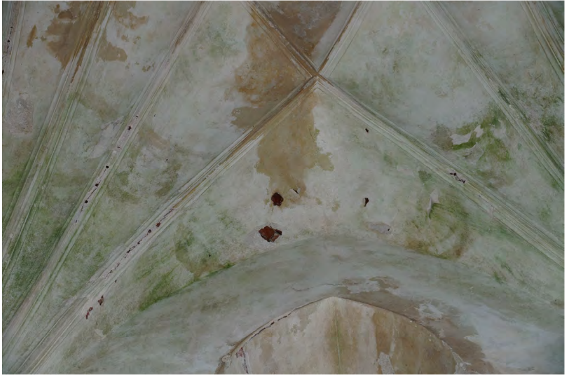
Abb. 337 Schadstellen am Gewölbe oberhalb des Fensters der Innenwandfläche B.
