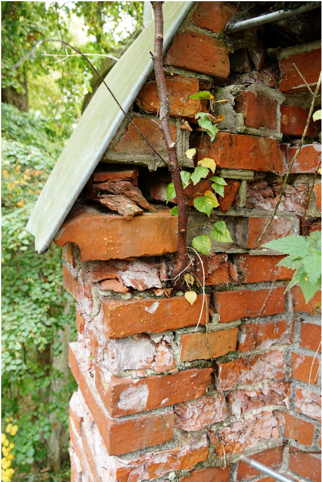
Abb. 77 Der Dachanschluss der Achse 02 a.
