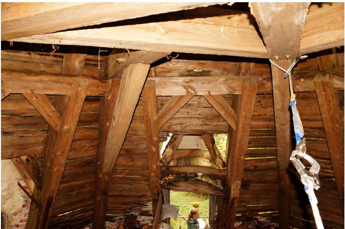
Abb. 383 Der obere Teil der Innenwandfläche A im Dachraum.
