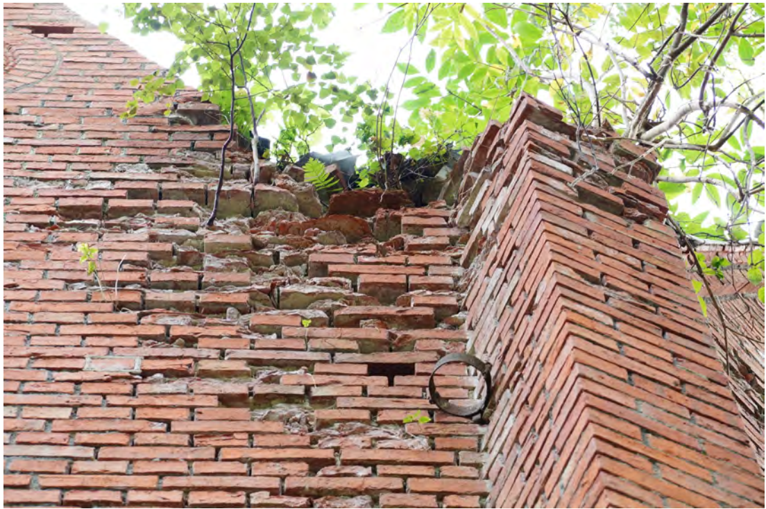
Abb. 198 Der Dachanschluss der Achse 08 c.
