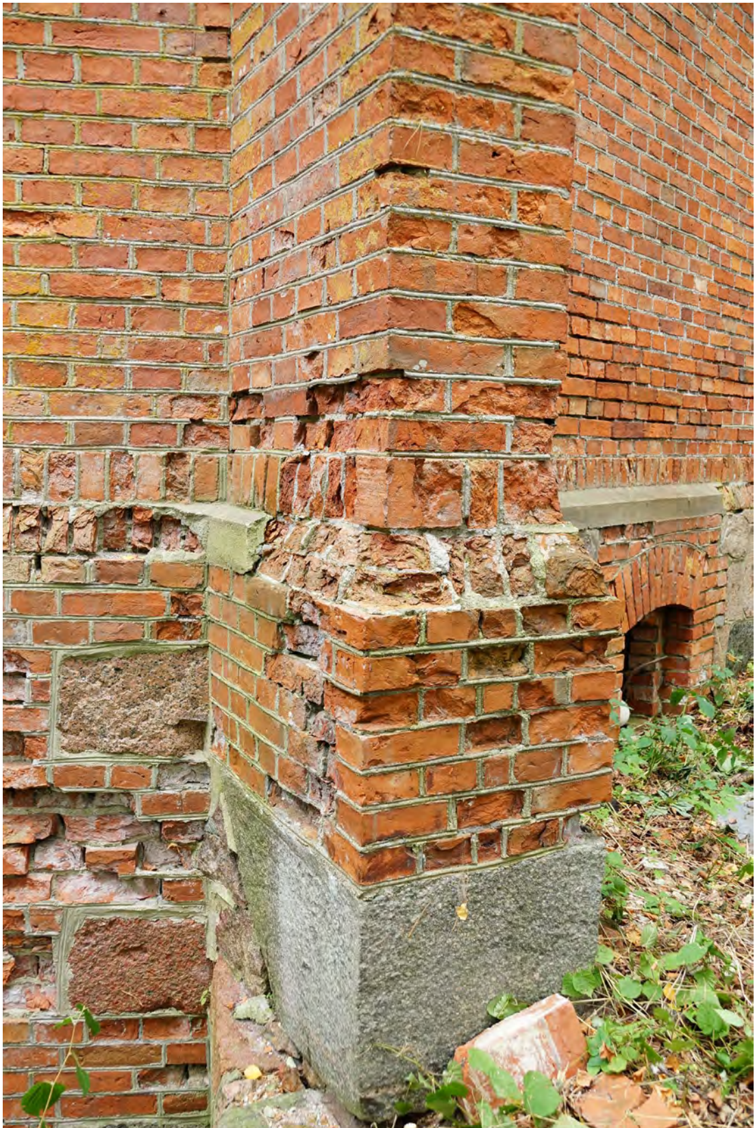
Abb. 126 Der Sockelbereich der Achse 05 b/c.
