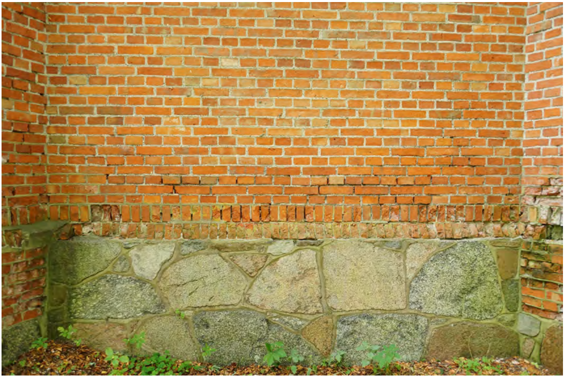
Abb. 99 Der Sockelbereich der Außenwandfläche C.
