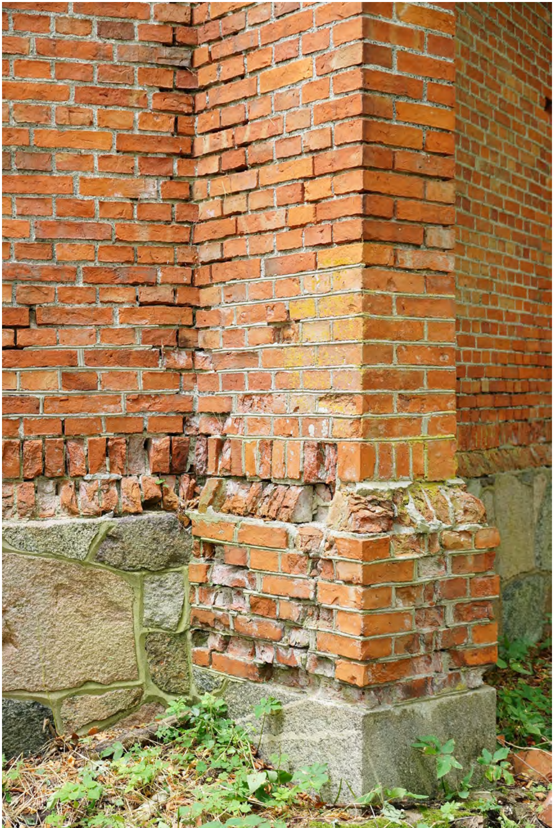
Abb. 109 Der Sockelbereich der Achse 04 c.
