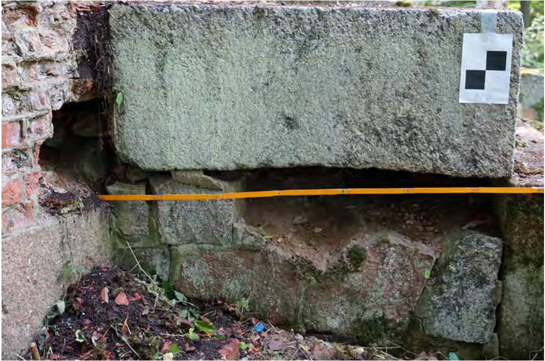
Abb. 61 Die Tiefe der oberen Felsblöcke (hier: linke Treppenwange).
