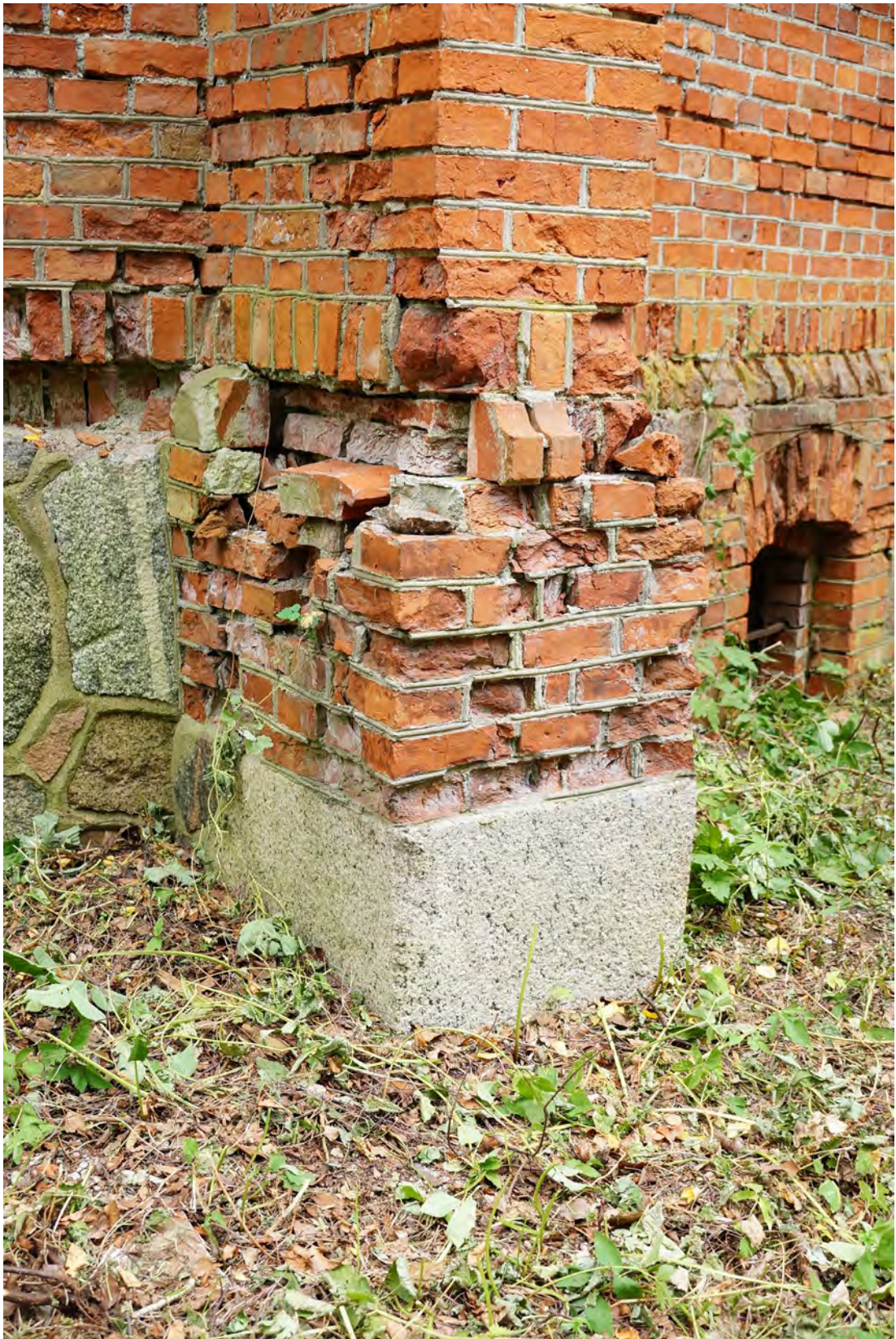
Abb. 175 Der Sockelbereich der Achse 07 c.
