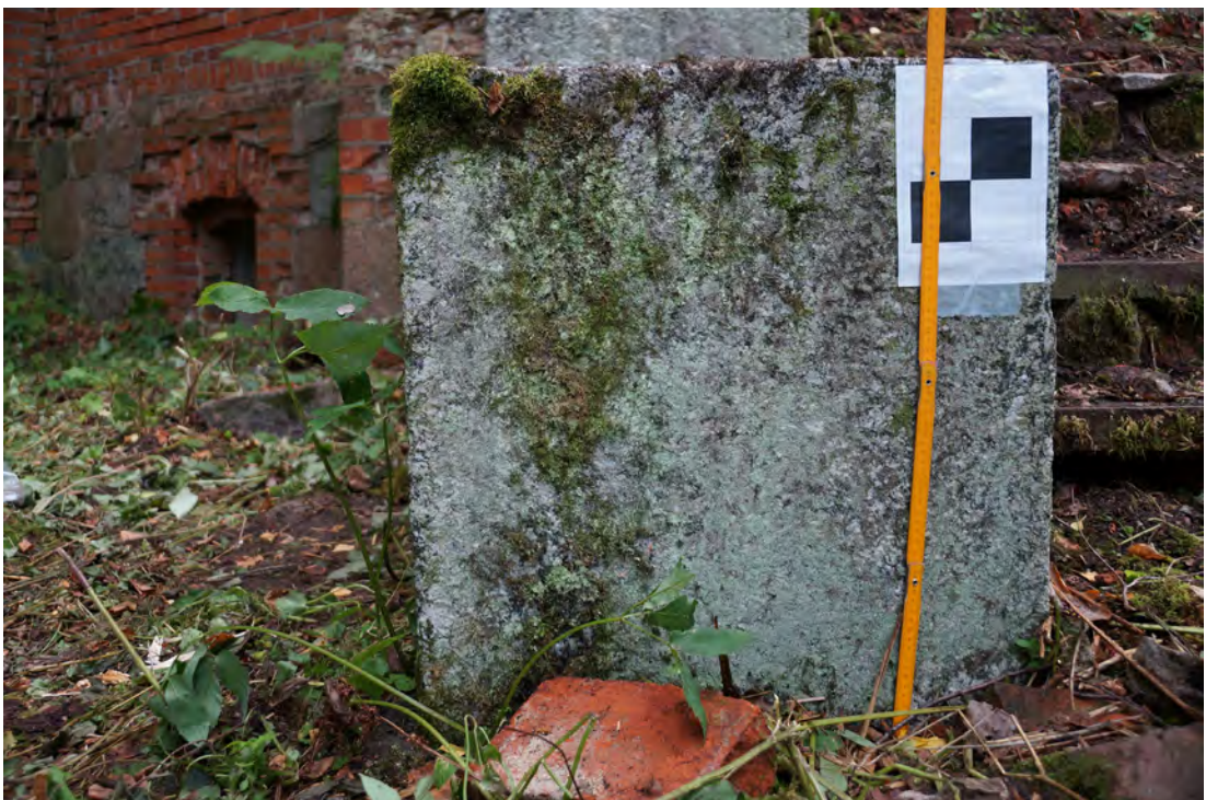
Abb. 64 Die Höhe der unteren Felsblöcke (hier: linke Treppenwange).
