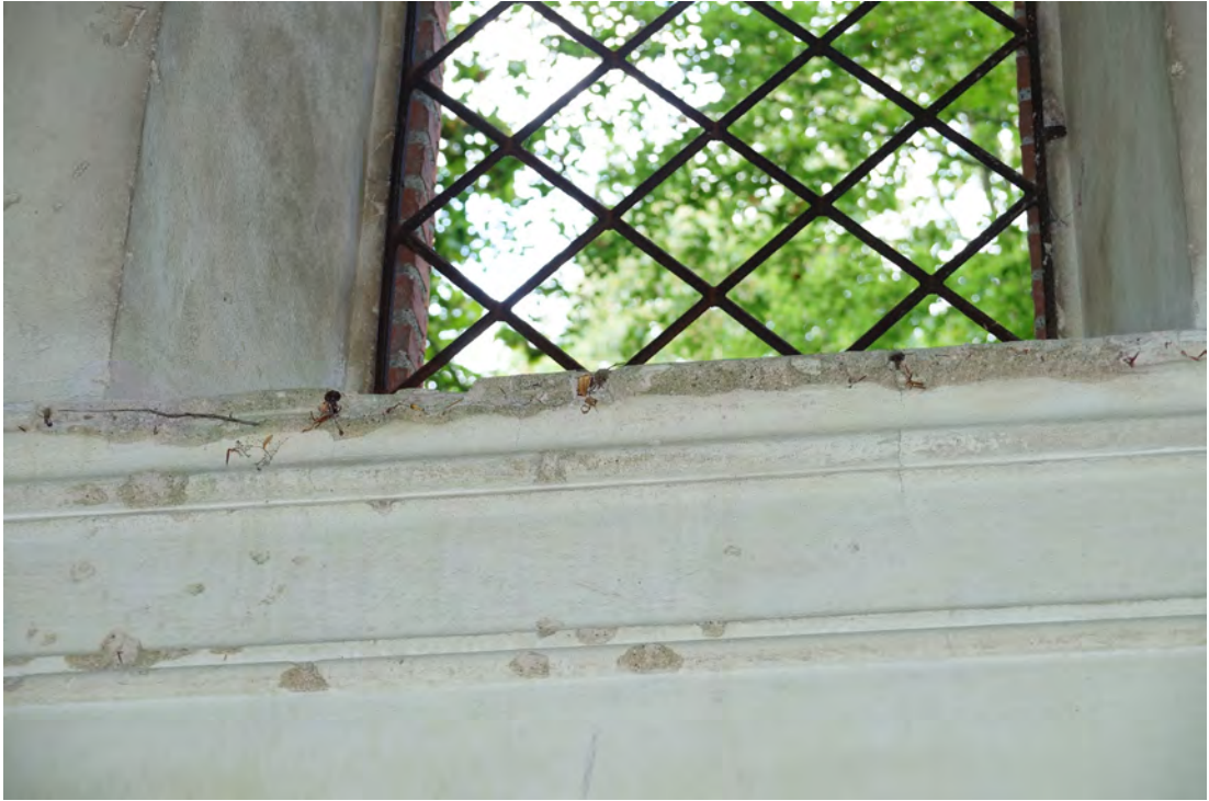
Abb. 349 Das Fensterbrett des Fensters der Innenwandfläche D.
