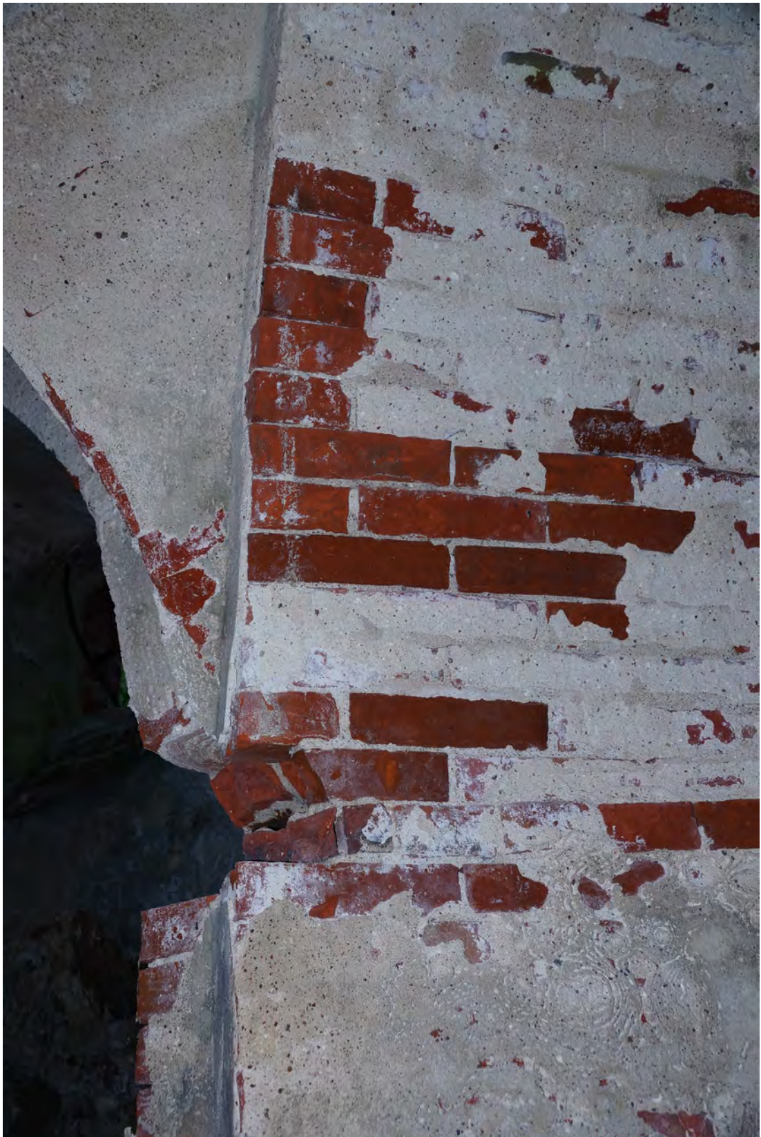
Abb. 269 Schäden am Mauerwerk des Widerlagers der Achse 05 c.
