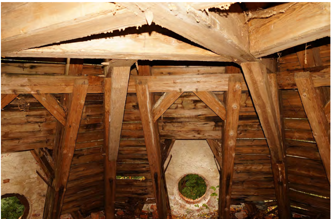
Abb. 395 Der obere Teil der Innenwandfläche G im Dachraum.
