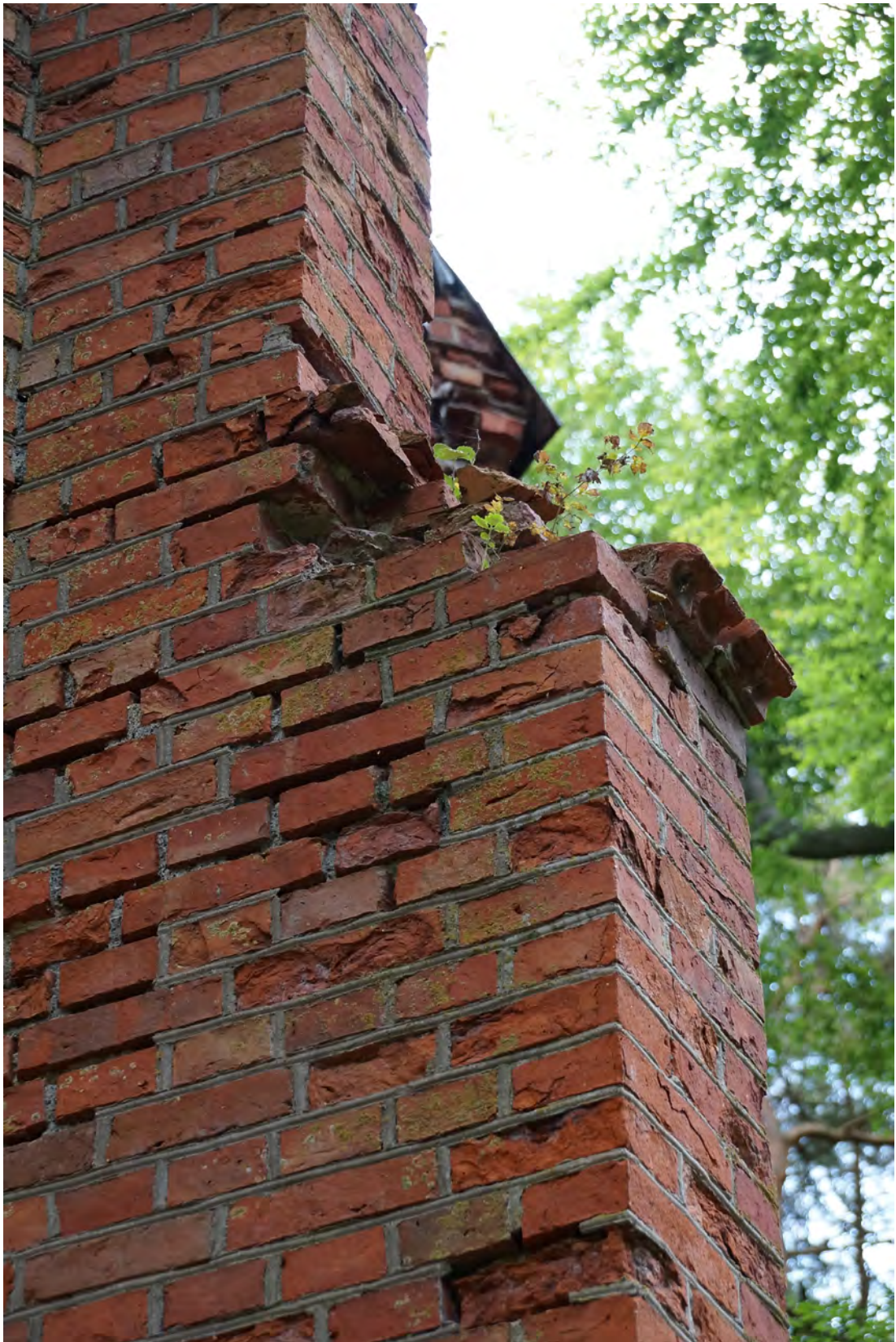
Abb. 179 Der Mauerwerksvorsprung der Achse 07 c.
