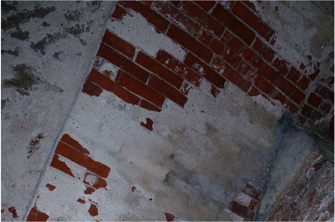
Abb. 231 Schäden an der linken Innenseite des Spitzbogens der Innenwandfläche B.
