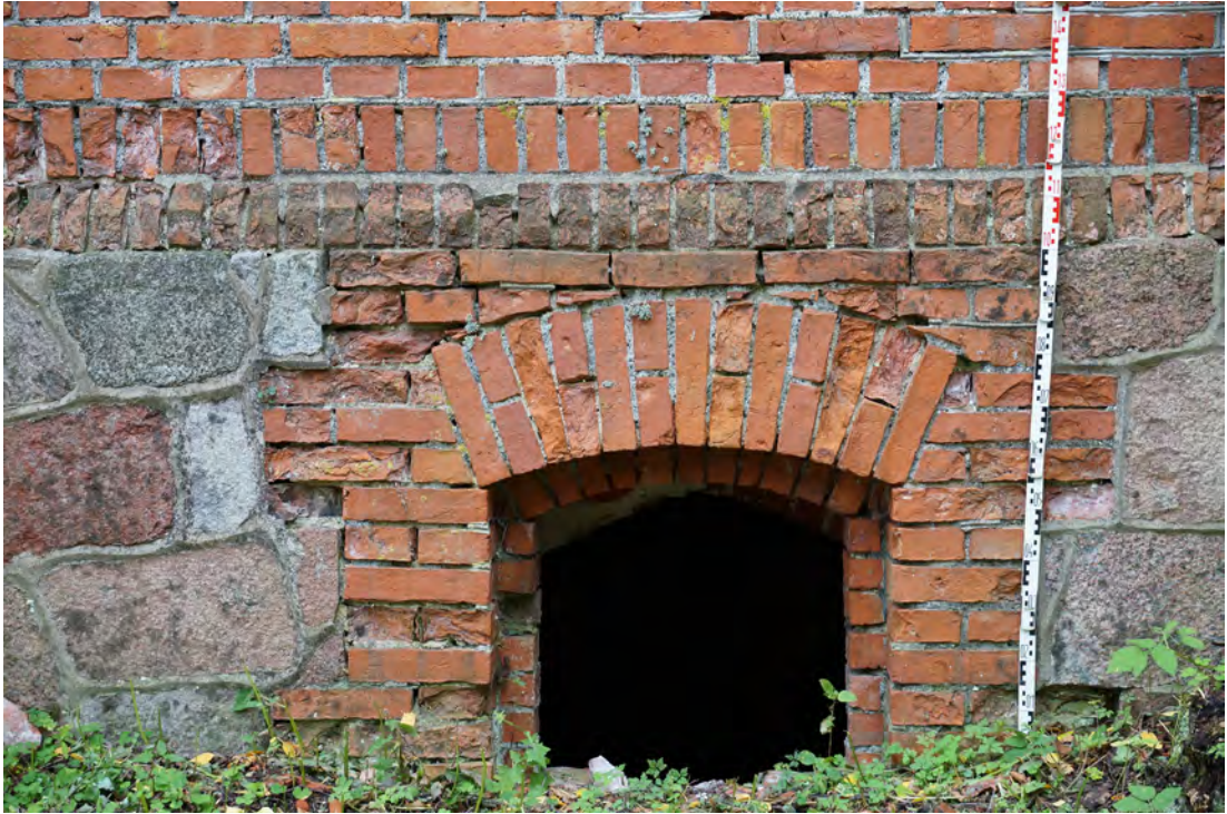
Abb. 200 Das untere Fenster im Sockelbereich der Außenwandfläche H.
