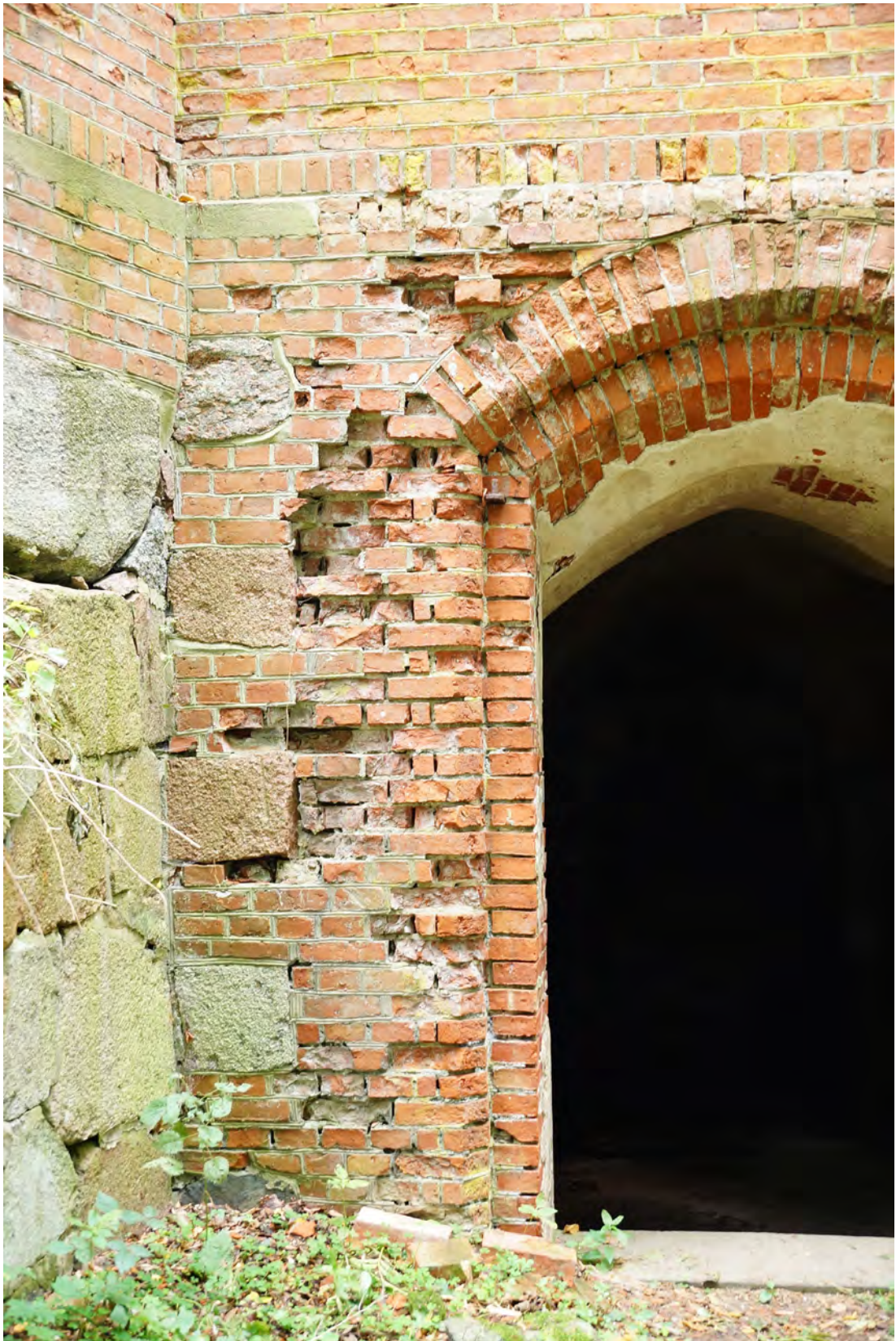
Abb. 138 Bereich links neben der Tür in der Außenwandfläche E.
