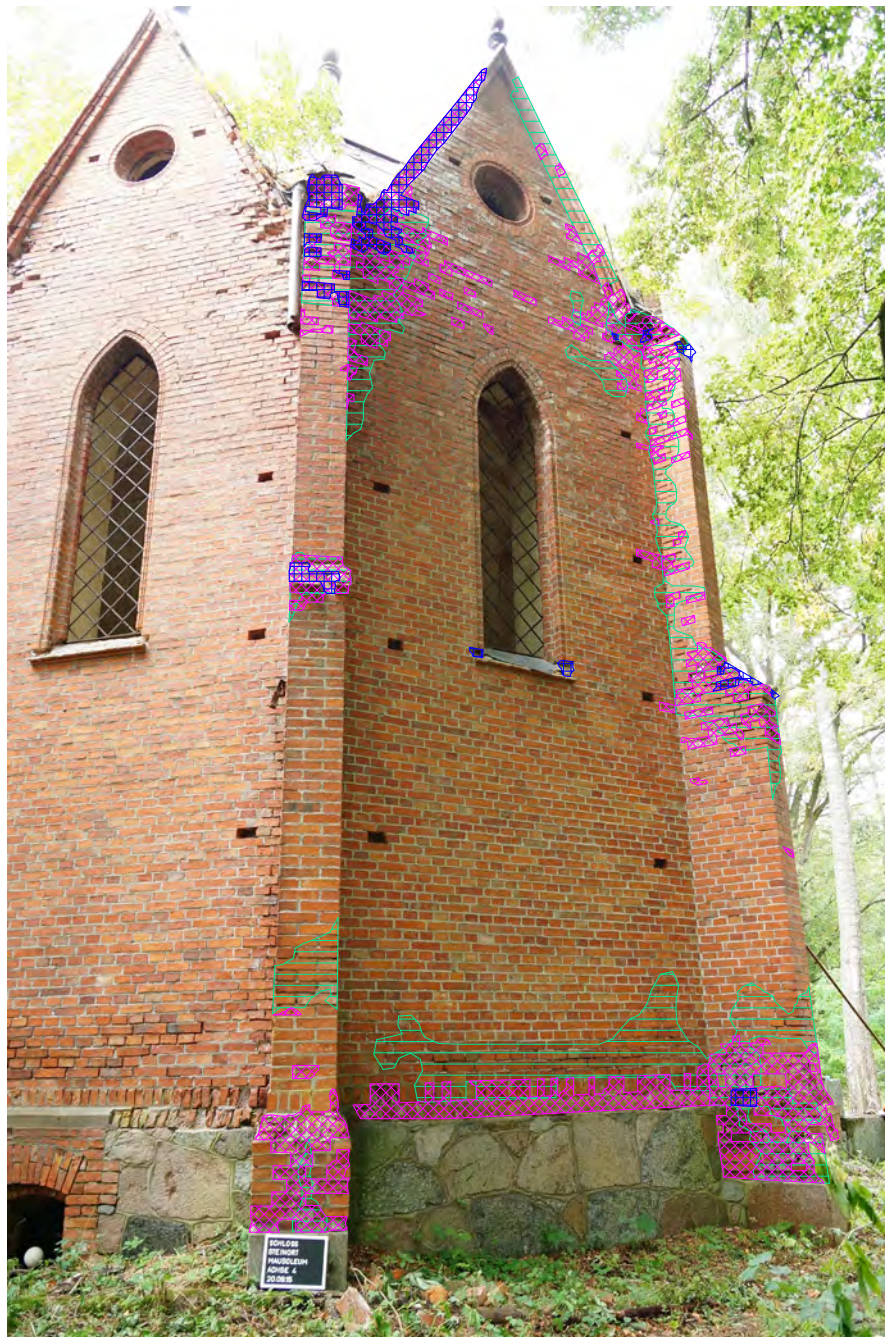
Abb. 448 Schadenskartierung der Außenwandfläche C.
