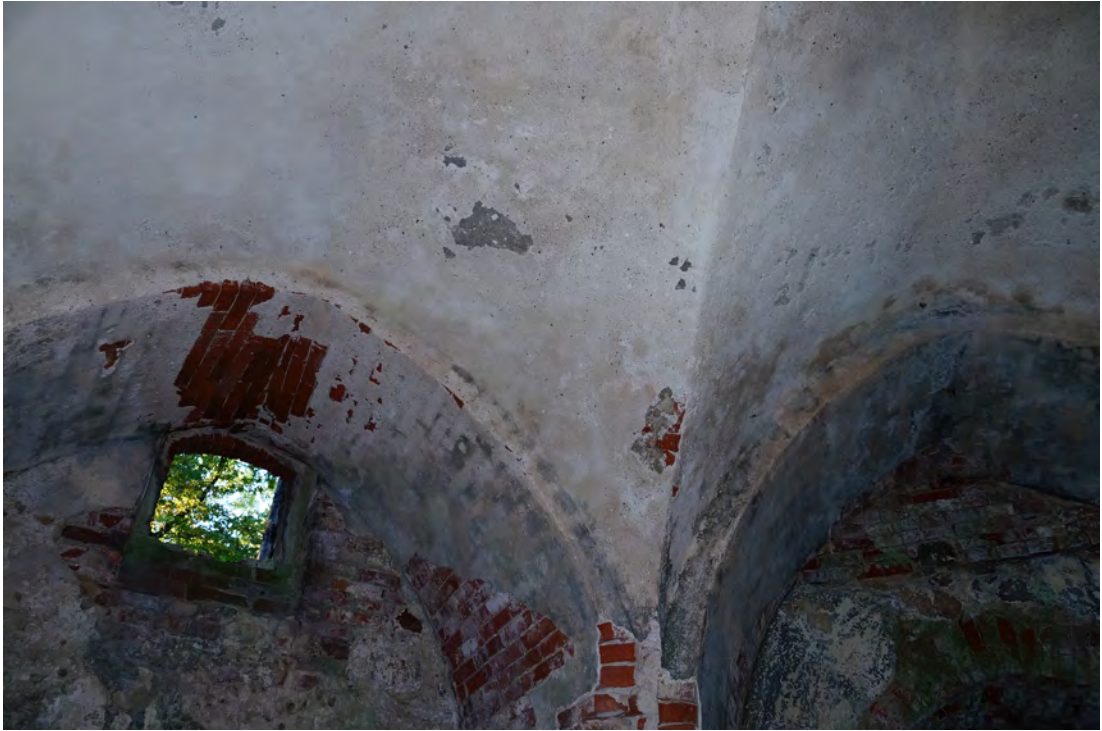
Abb. 215 Schäden am Gewölbe oberhalb der Achse 01 b.
