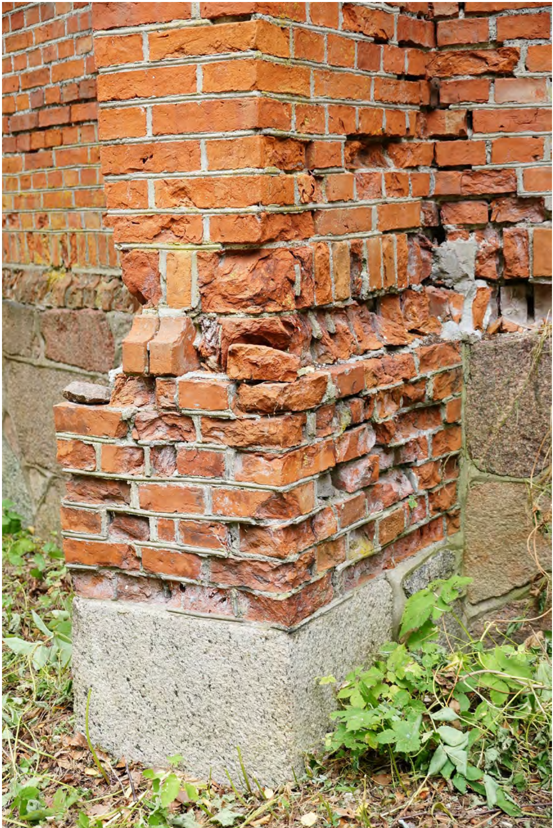
Abb. 174 Der Sockelbereich der Achse 07 a.
