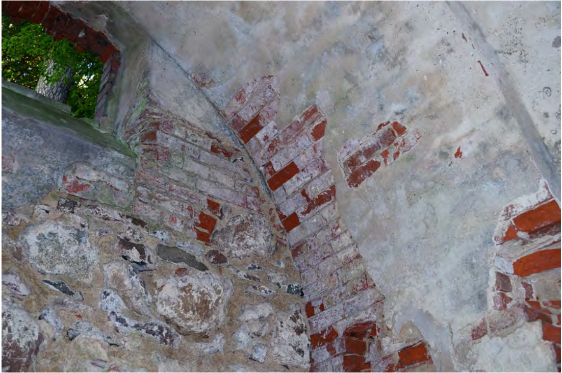
Abb. 233 Schäden an der rechten Innenseite des Bogens.
