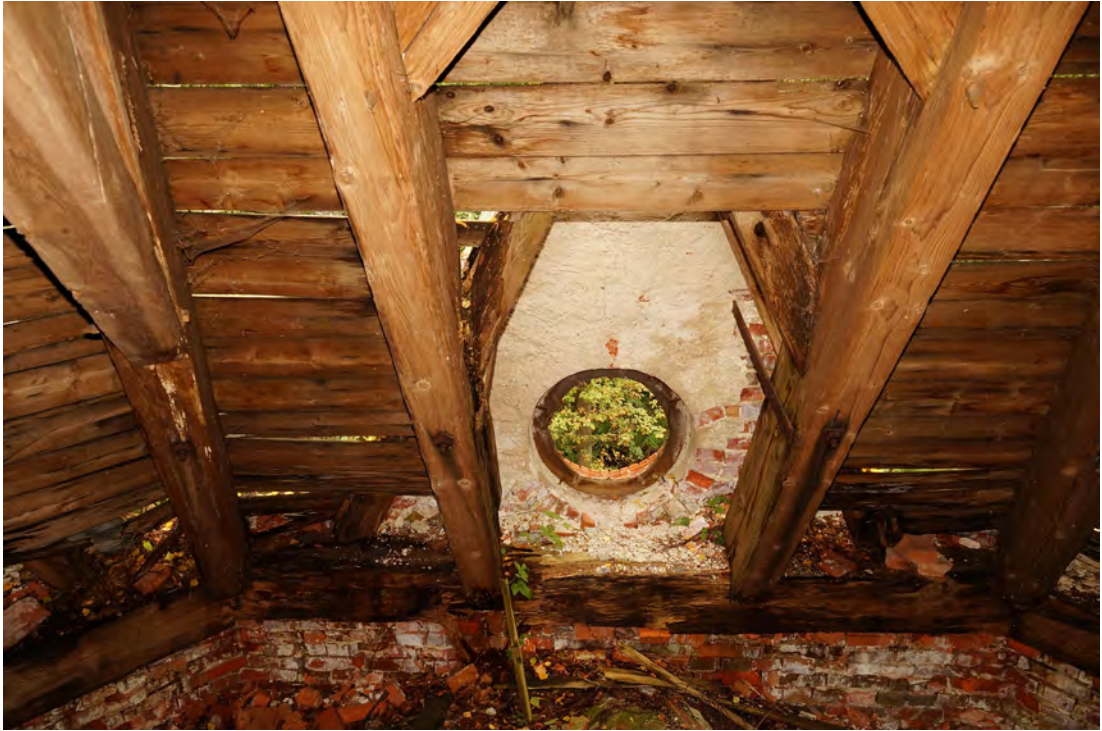
Abb. 396 Der untere Teil der Innenwandfläche H im Dachraum.
