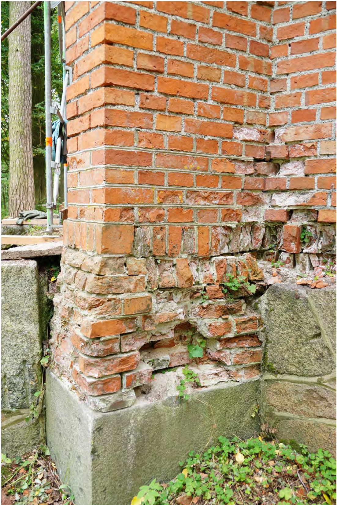
Abb. 31 Sockelbereich der Achse 01 a.
