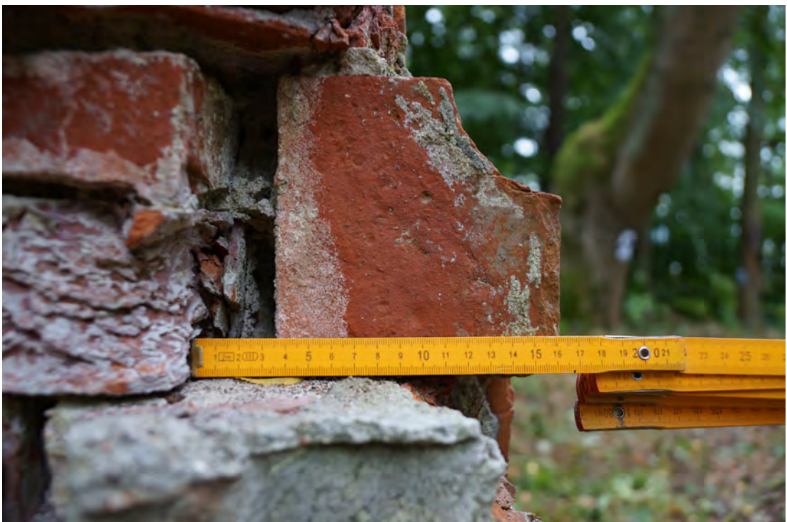
Abb. 418 Die Tiefe der Fuge hinter dem Formstein des Typs S4 (I).
