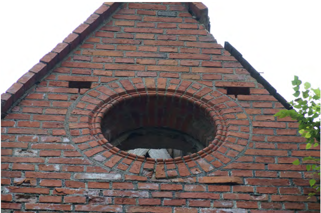
Abb. 204 Das Dachfenster der Außenwandfläche H.
