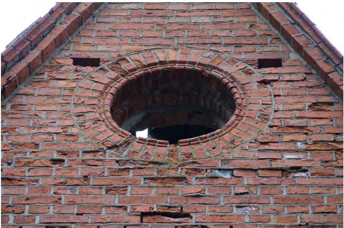
Abb. 167 Das Dachfenster der Außenwandfläche F.
