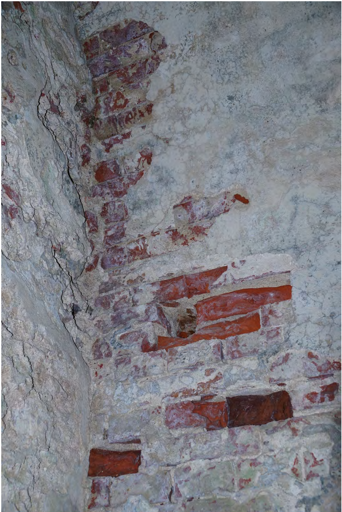
Abb. 309 Schäden am Mauerwerk im oberen, hinteren Bereich der Achse 08 a.
