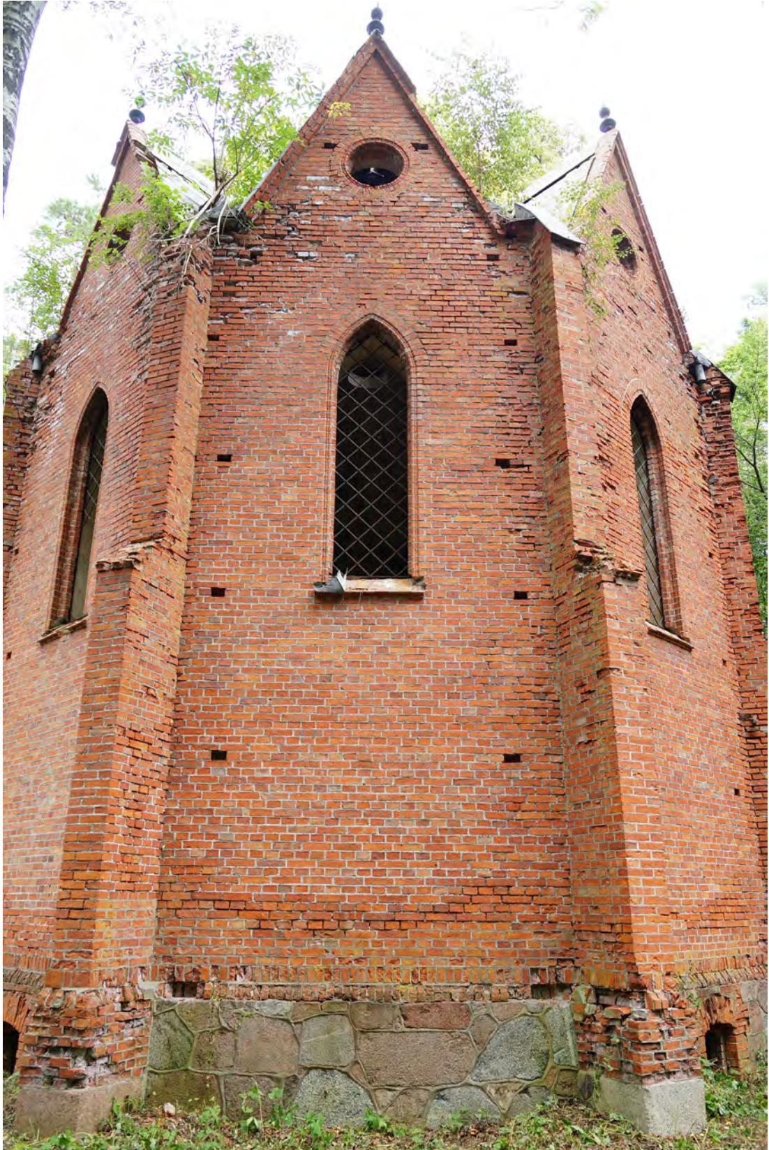
Abb. 182 Übersichtsfoto der Außenwandfläche G.
