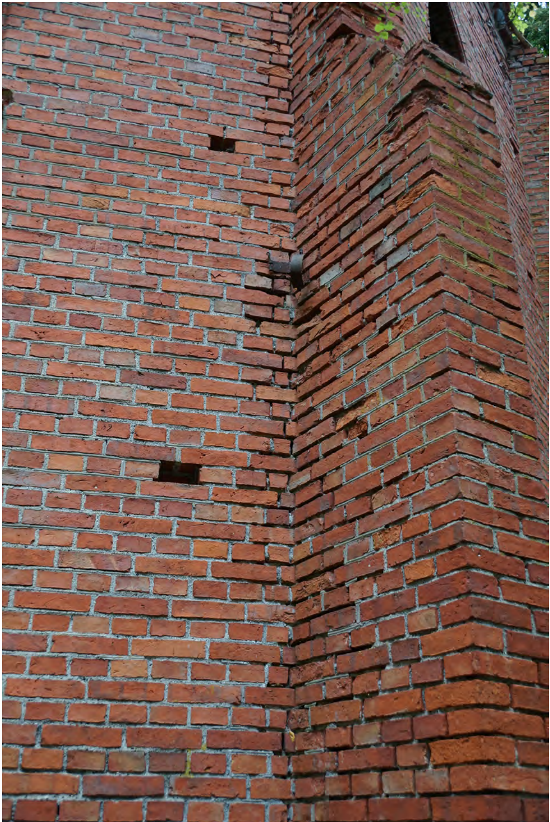
Abb. 157 Fugenauswaschungen im unteren Bereich der Achse 06 c.
