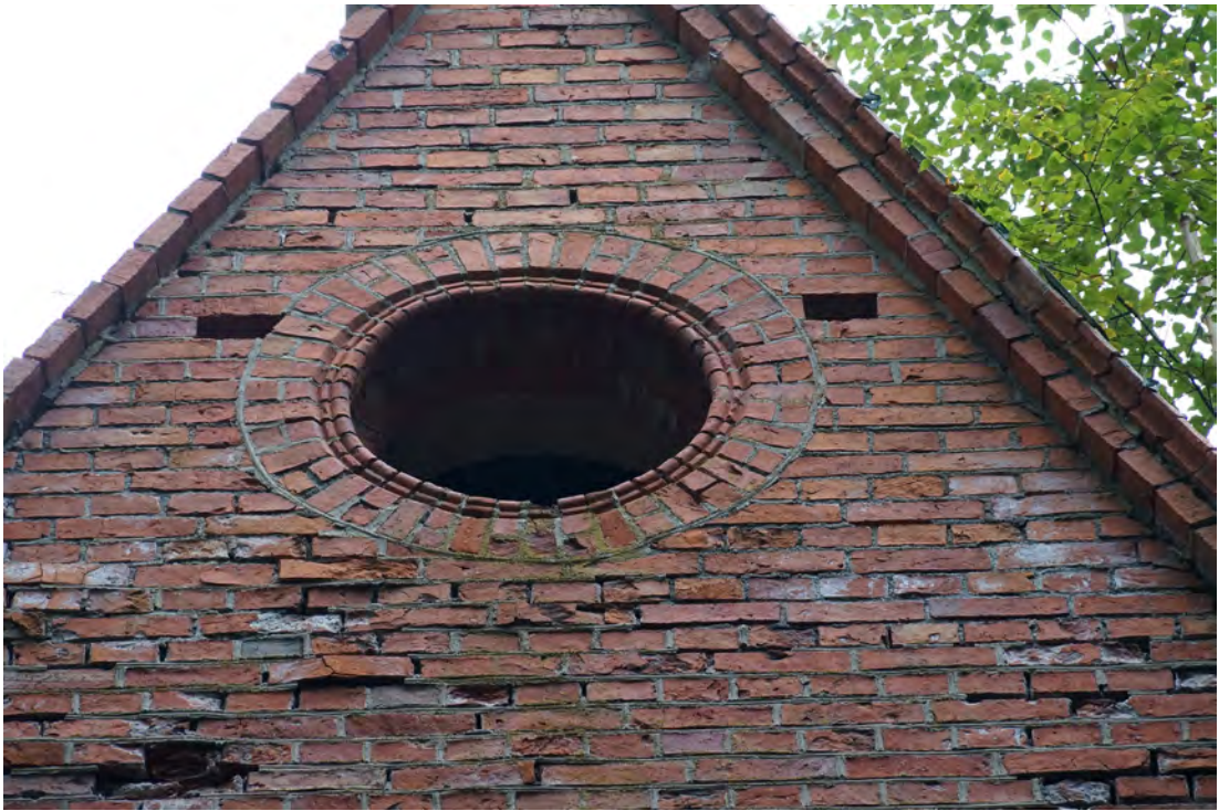
Abb. 143 Das Dachfenster der Außenwandfläche E.
