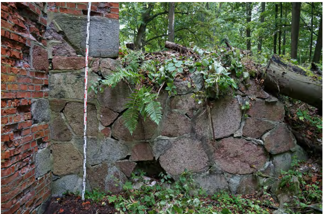
Abb. 150 Höhe der Mauer rechts der Außenwandfläche E.
