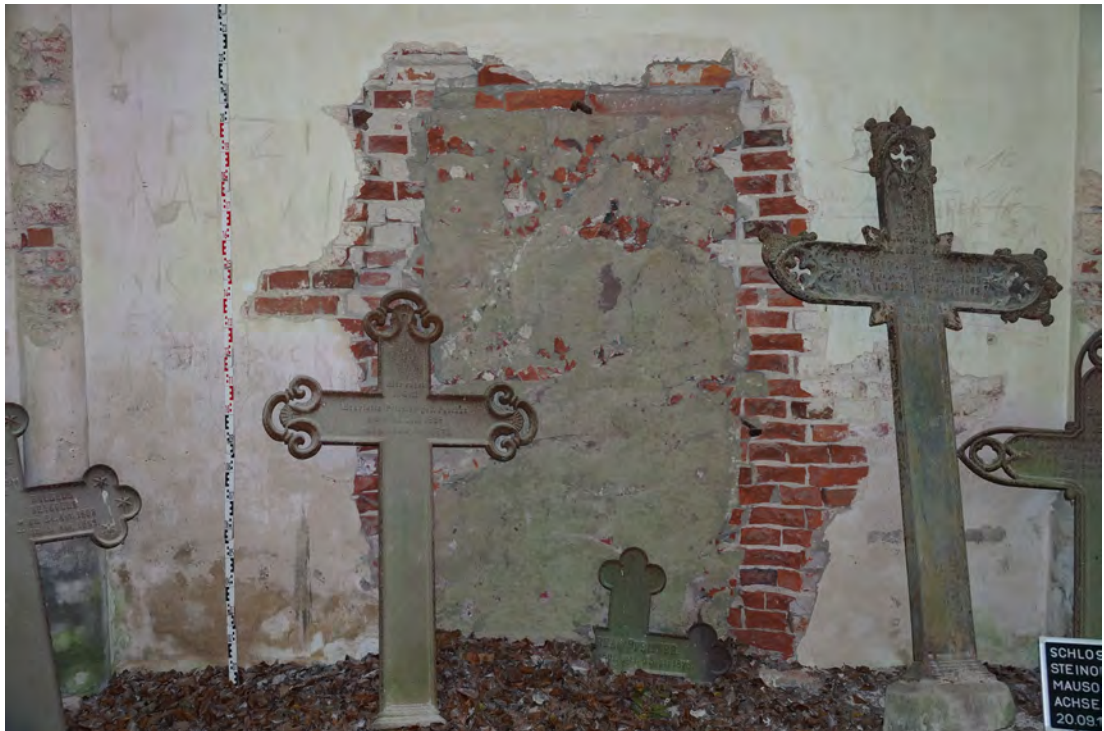
Abb. 368 Die große Schadstelle in der Mitte der unteren Hälfte der Innenwandfläche G.
