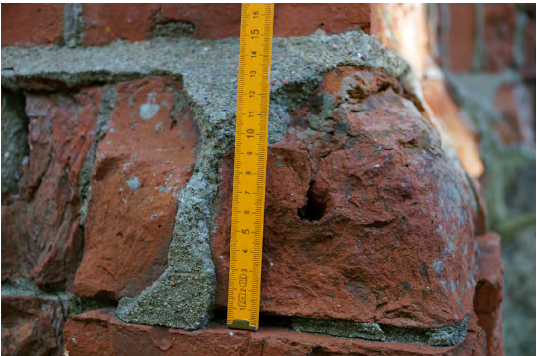
Abb. 412 Die Höhe des Formsteines des Typs S3.
