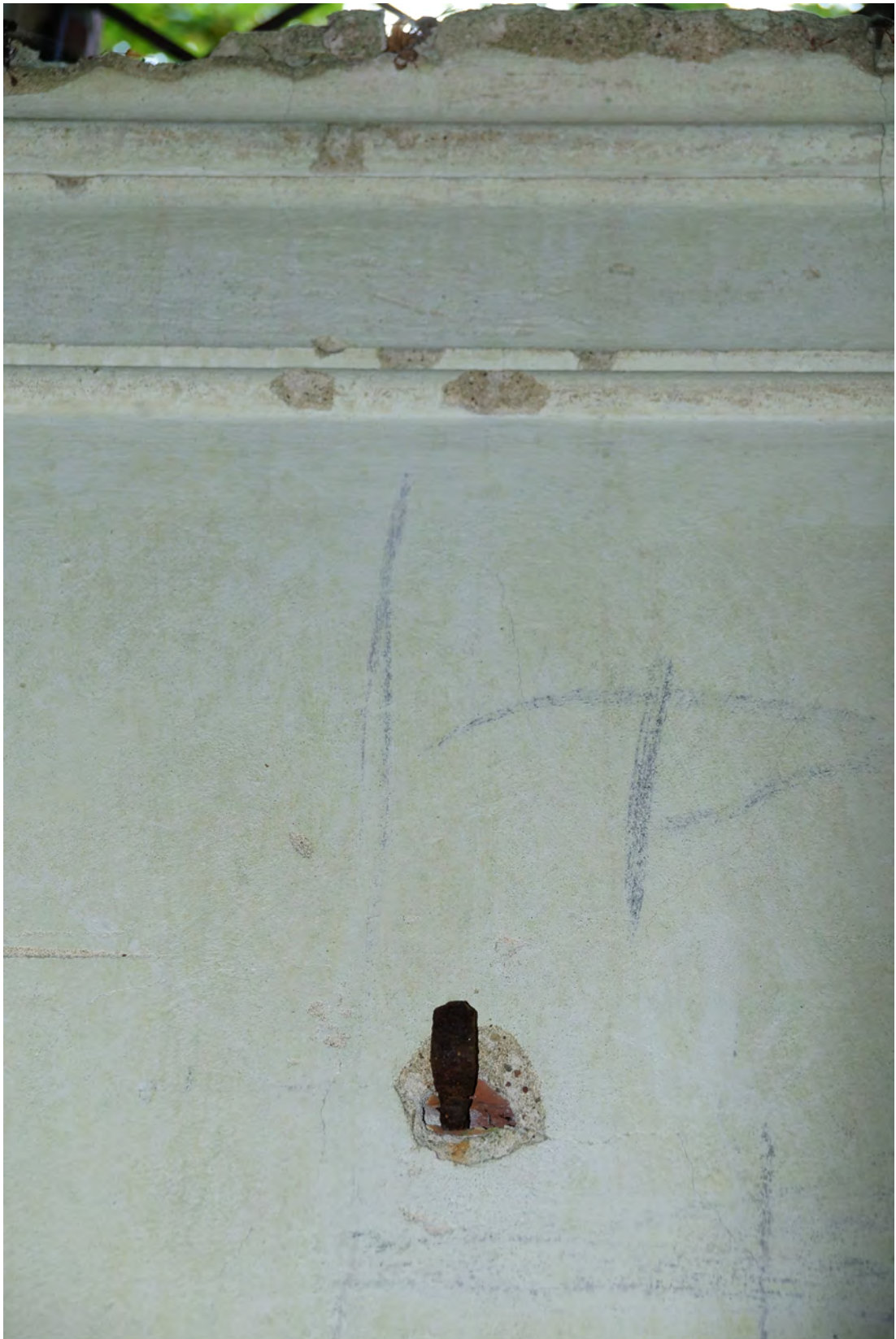
Abb. 348 Metallbauteil unterhalb des Fensters der Innenwandfläche D.
