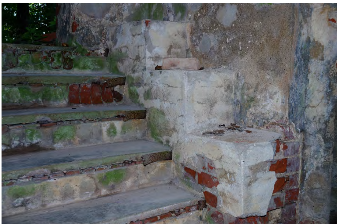
Abb. 275 Die rechte Treppenwange der Treppe der Innenwandfläche E.
