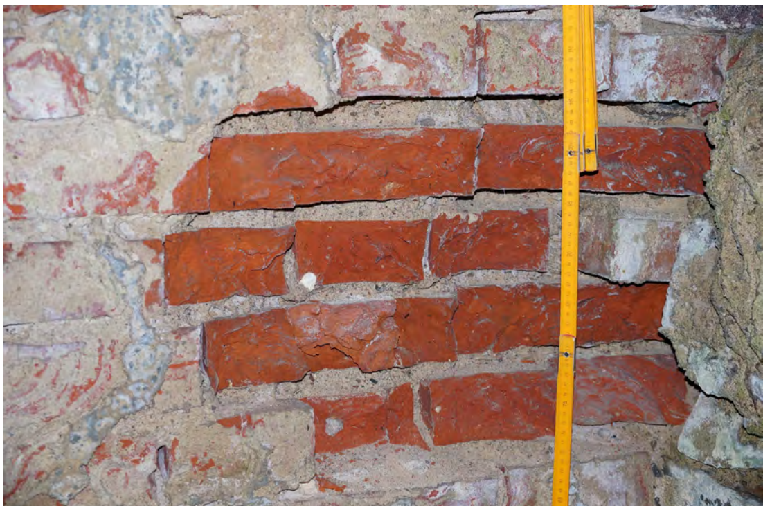
Abb. 210 Schäden am Mauerwerk in der Mitte der Achse 01 c.
