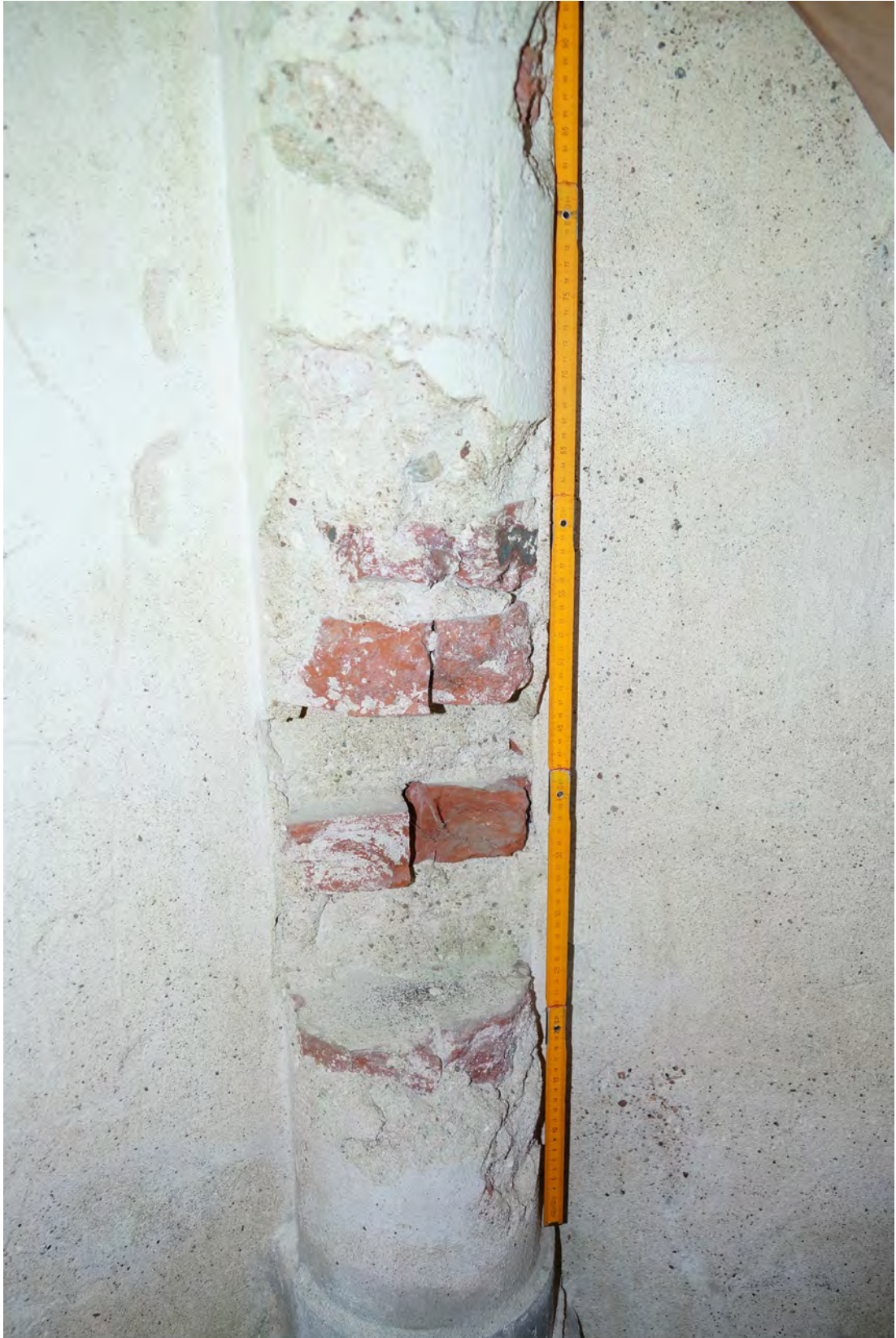
Abb. 345 Schäden im unteren Bereich des Pilasters der Achse 04.
