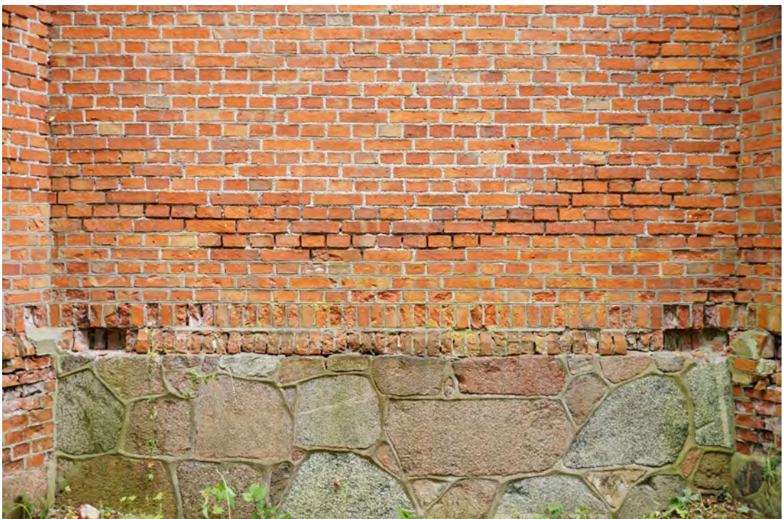
Abb. 184 Der Sockelbereich und die Fugenauswaschungen darüber.
