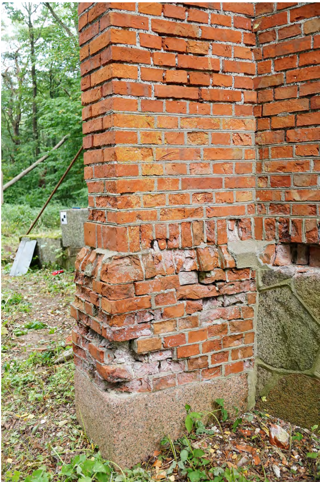
Abb. 192 Der Sockelbereich der Achse 08 a.
