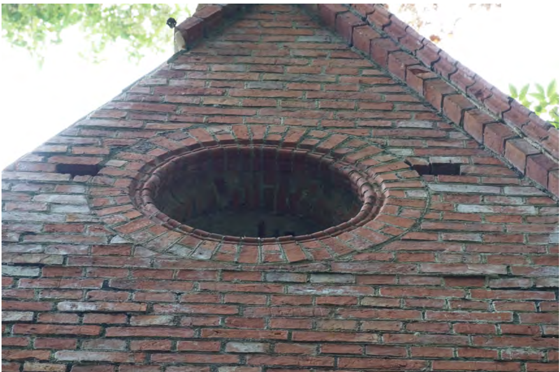
Abb. 103 Das Dachfenster der Außenwandfläche C.
