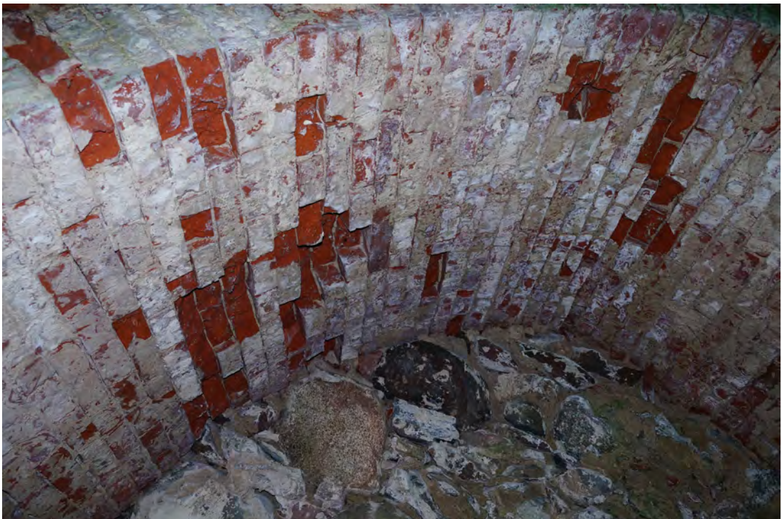
Abb. 219 Schäden an der linken Innenseite des inneren Spitzbogens.
