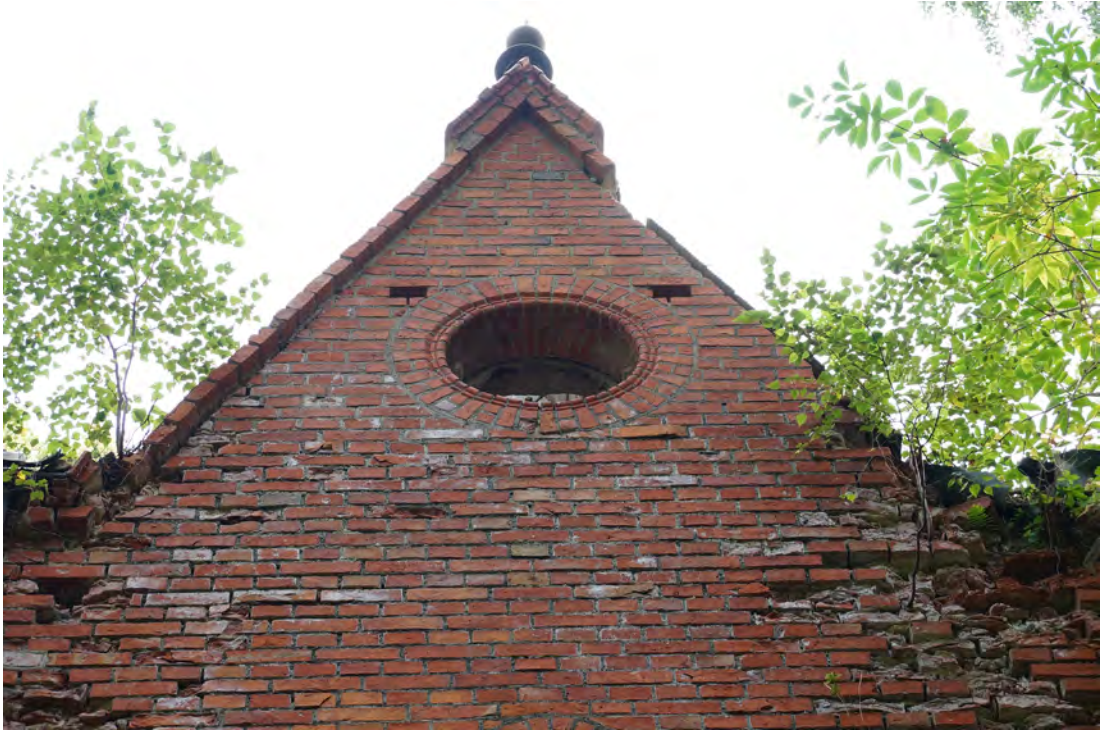
Abb. 205 Der Dachanschluss mit Dachfenster der Außenwandfläche H.
