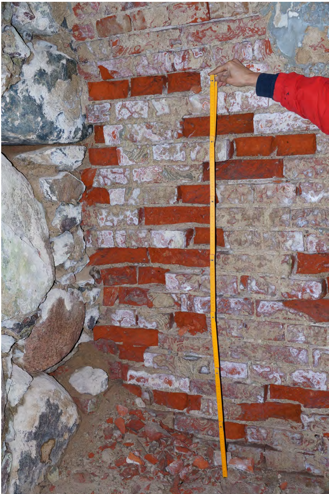
Abb. 225 Schäden am Mauerwerk im hinteren, unteren Bereich der Achse 02 a.
