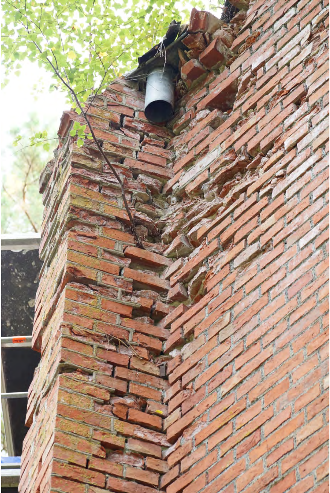
Abb. 39 Dachanschluss der Achse 01 a.
