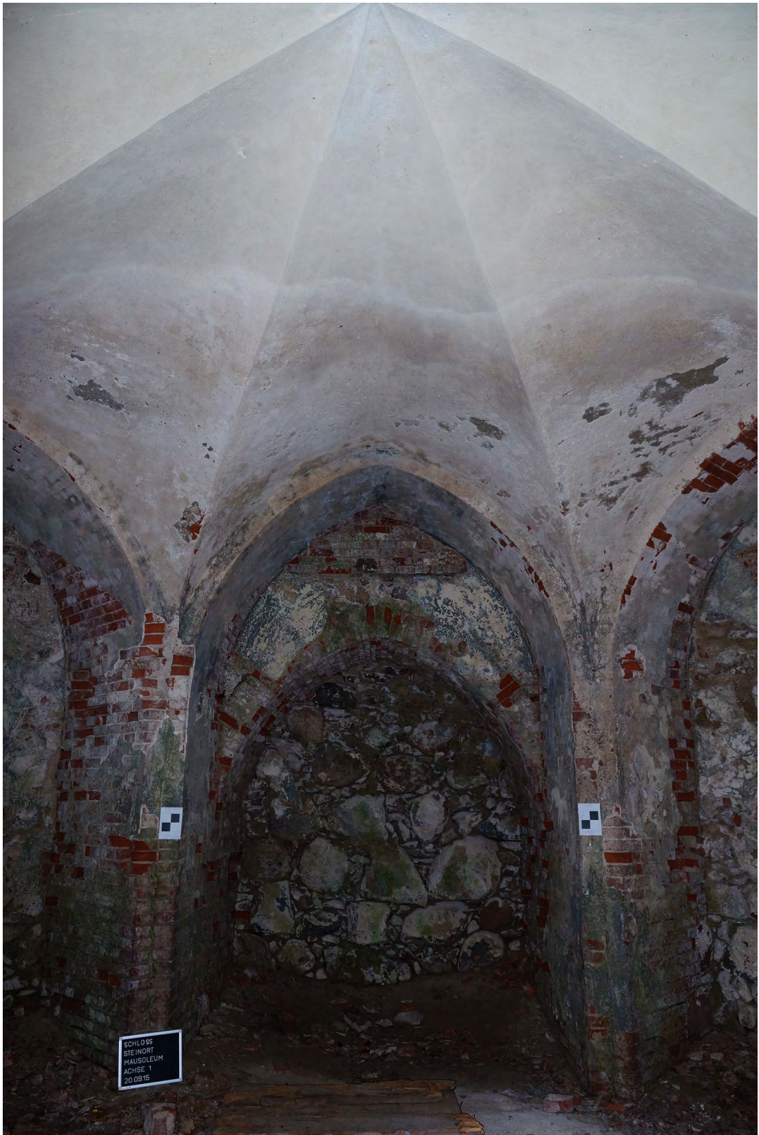
Abb. 216 Übersichtsfoto der Innenwandfläche A mit Gewölbe.
