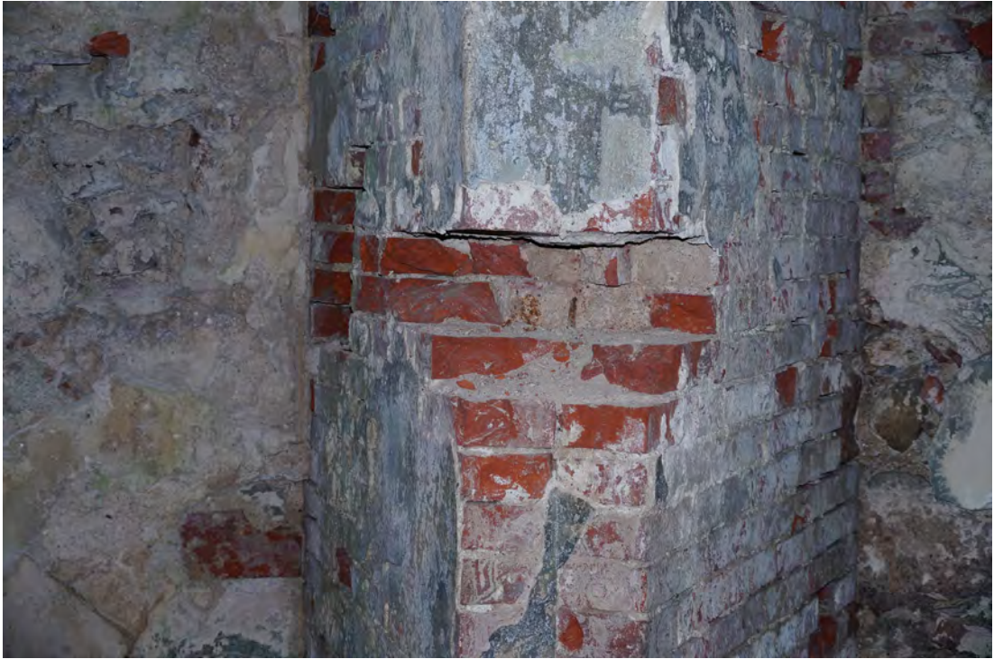
Abb. 312 Schäden am Mauerwerk im mittleren Bereich der Achse 08 b.
