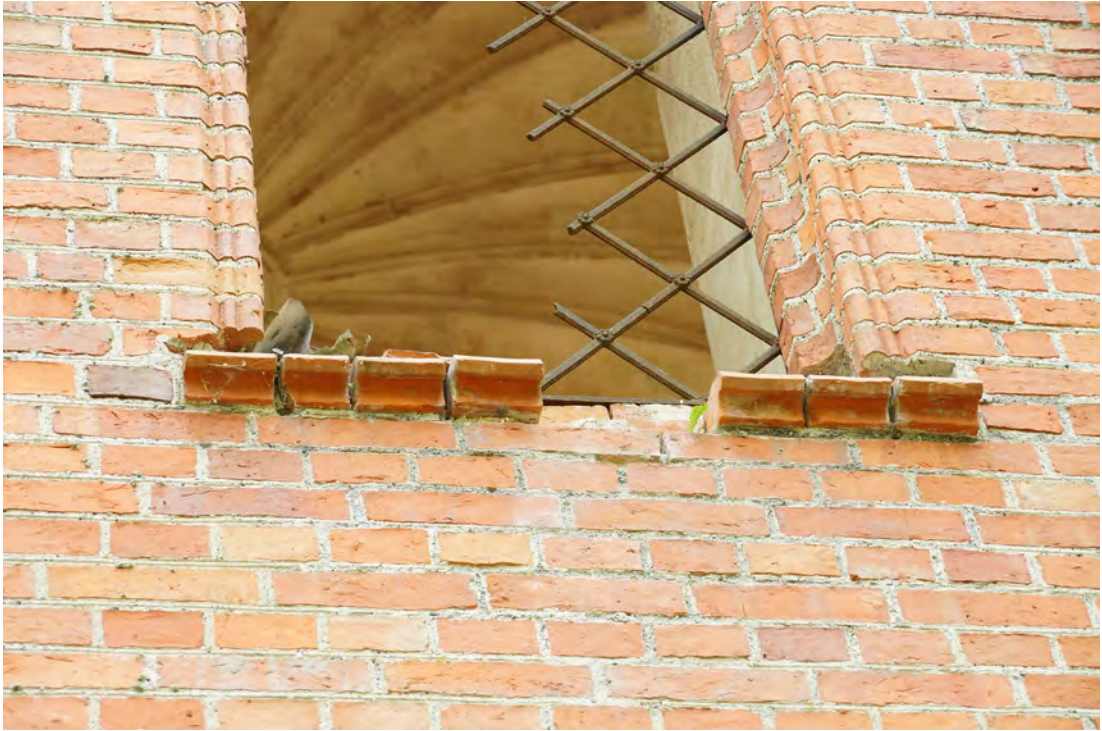
Abb. 203 Das Fensterbrett des großen Fensters in der Mitte der Außenwandfläche H.
