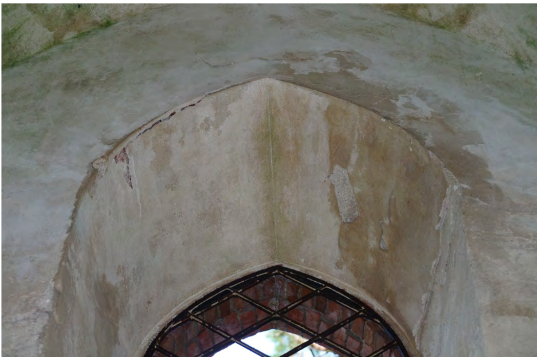
Abb. 336 Der Spitzbogen des Fensters der Innenwandfläche B.
