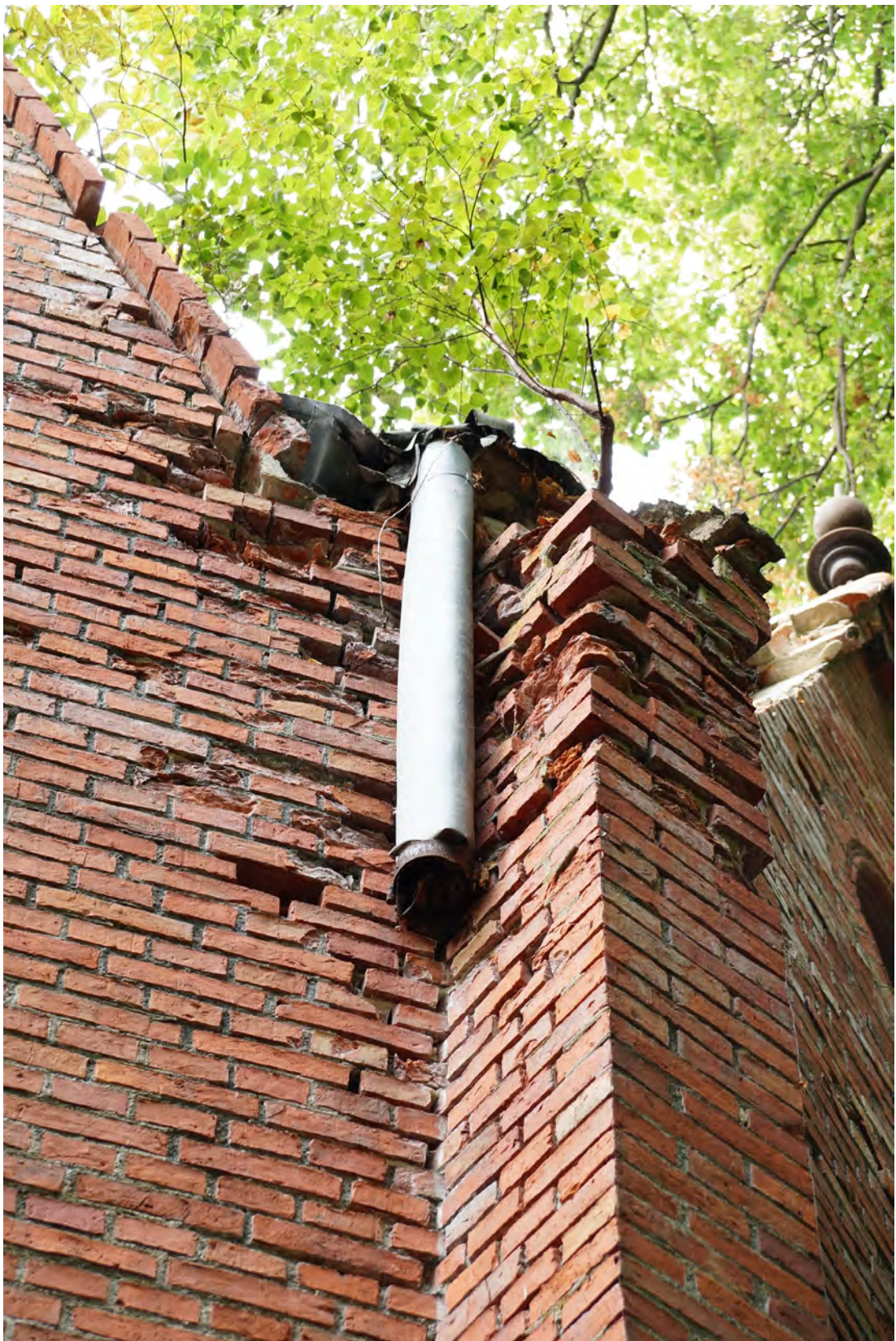
Abb. 113 Der Dachanschluss der Achse 04 c.
