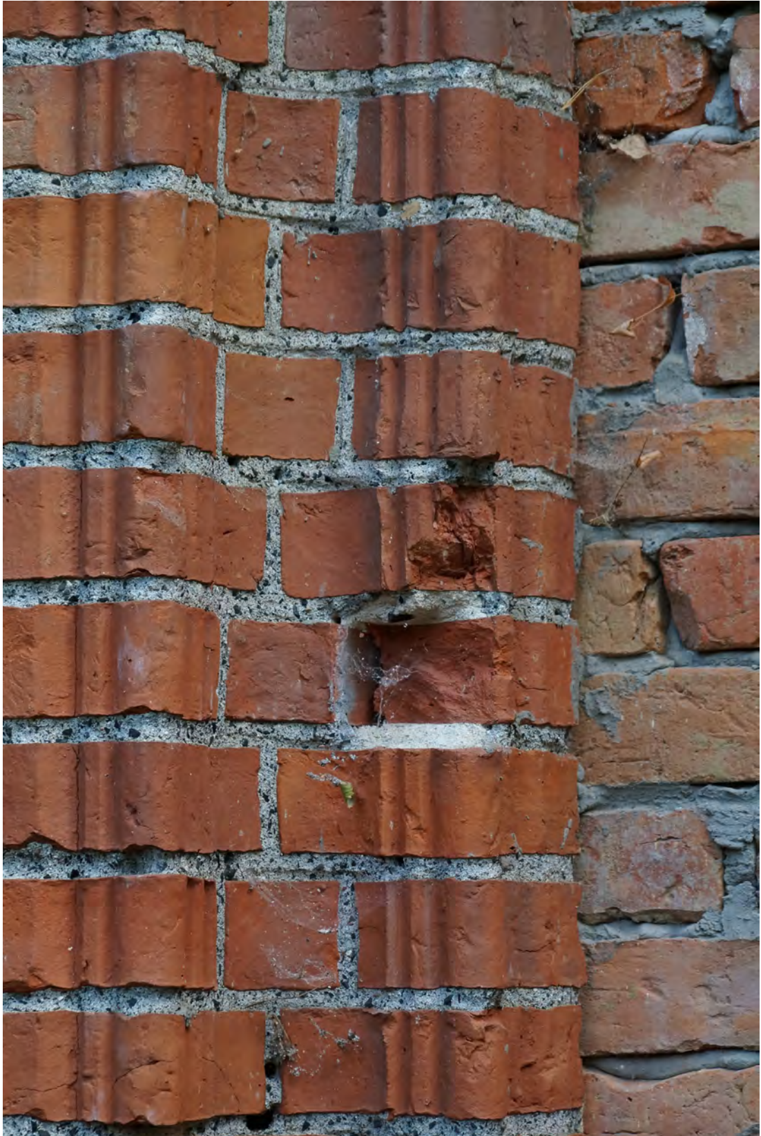
Abb. 42 Abgeplatze Formziegel am linken Teil der Türleibung (Typ S8 u. 9).
