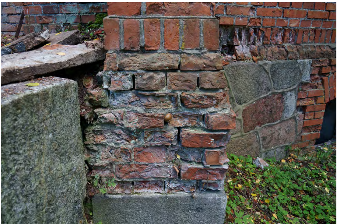
Abb. 33 Sockelbereich der Achse 01 b.
