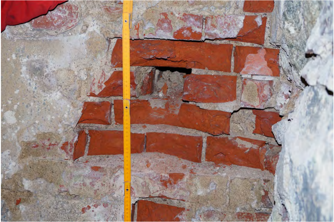
Abb. 245 Höhe der Schäden am Mauerwerk und des Loches im hinteren, mittleren Bereich der Achse 03 c.
