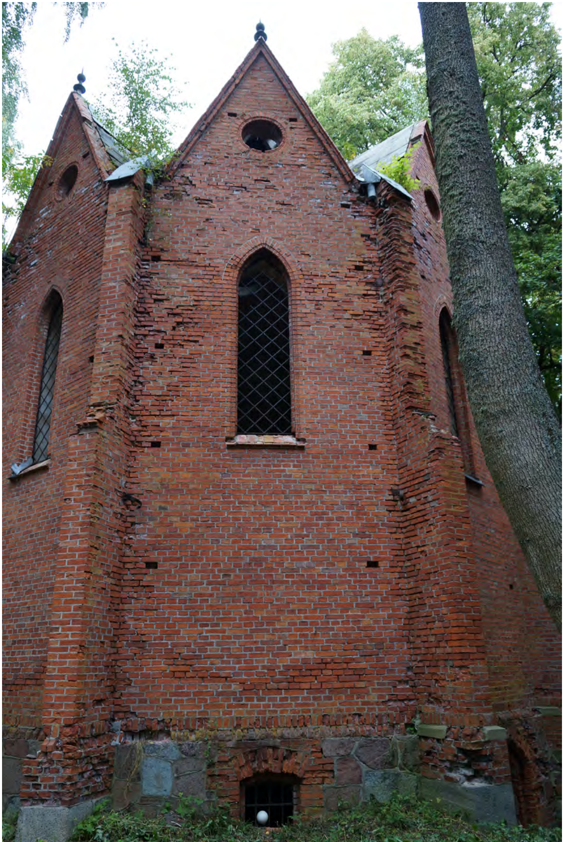
Abb. 162 Übersichtsfoto der Außenwandfläche F.
