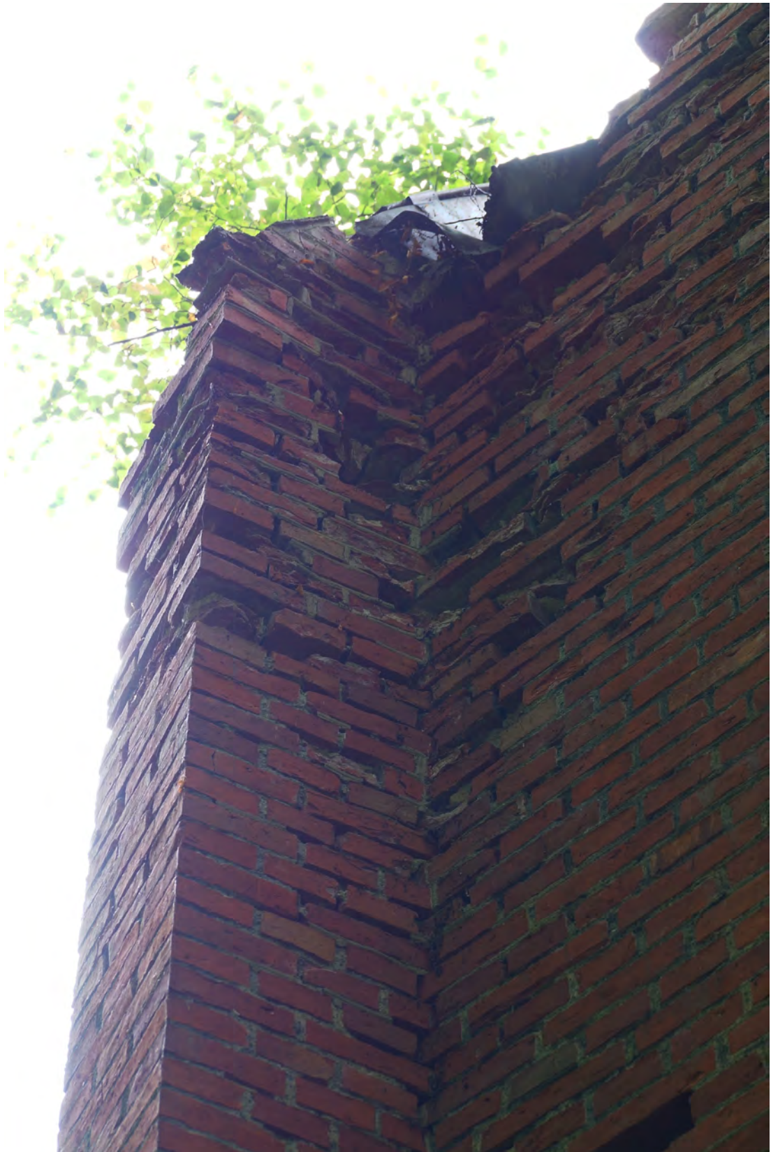
Abb. 112 Der Dachanschluss der Achse 04 a.
