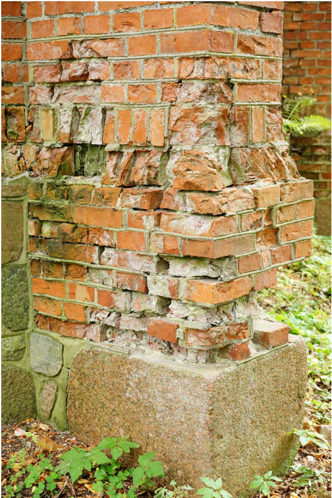
Abb. 92 Der Sockelbereich der Achse 03 c.
