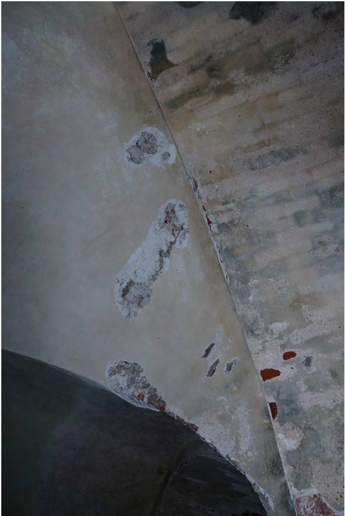
Abb. 286 Schäden am Übergang zum Gewölbe der Achse 06 c.
