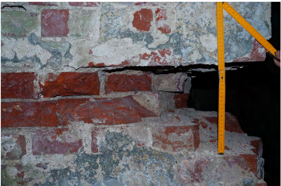
Abb. 310 Die Höhe der Schäden im mittleren Bereich der Achse 08 a.
