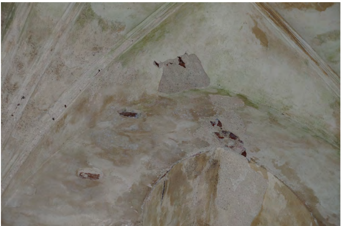
Abb. 376 Die Schäden am Spitzbogen des Fensters und am Gewölbe darüber.
