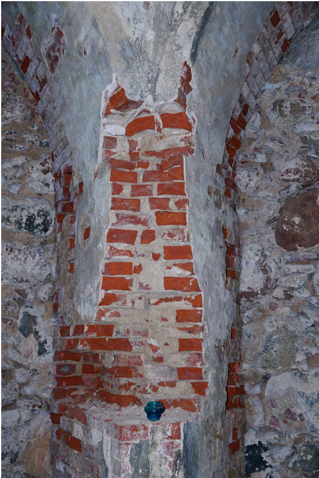
Abb. 240 Schäden im mittleren, oberen Bereich der Achse 03 b.
