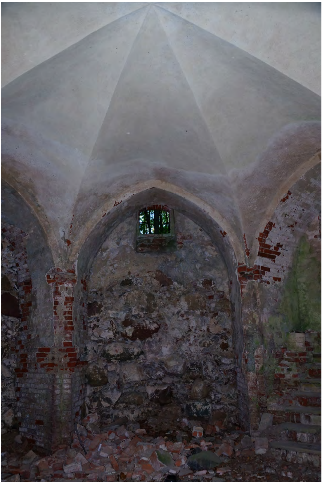
Abb. 260 Übersichtsfoto der Innenwandfläche D mit Gewölbe.
