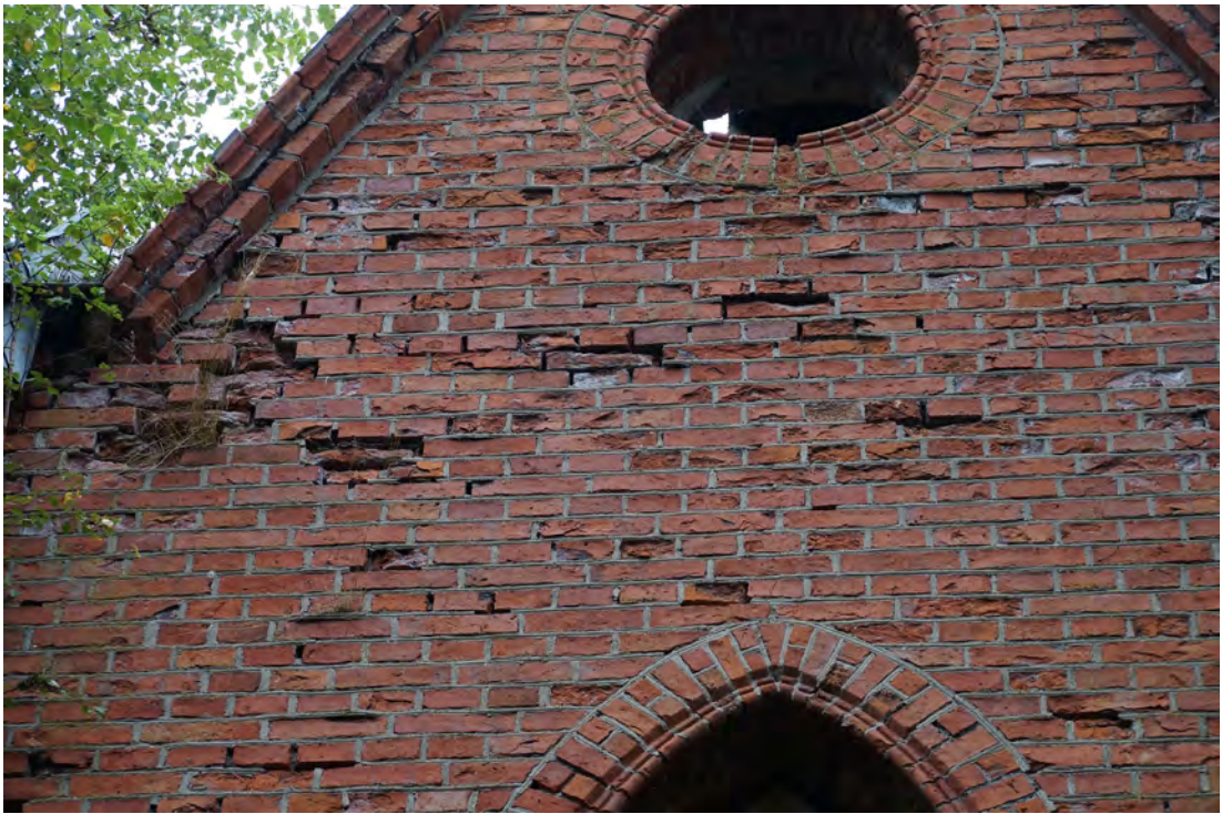
Abb. 168 Schadstellen im Mauerwerk unterhalb des Dachfensters der Außenwandfläche F.
