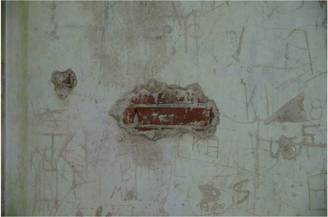
Abb. 332 Schadstelle im unteren Bereich der Innenwandfläche B.
