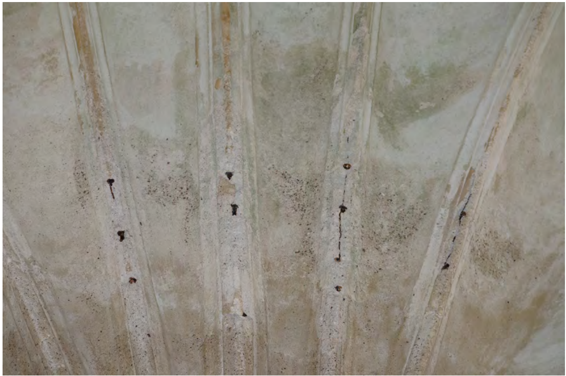
Abb. 367 Metallbauteile an den unteren Gewölberippen der Achse 07.
