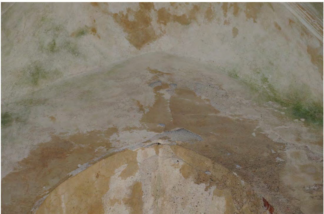
Abb. 362 Die Schäden am Spitzbogen des Fensters der Innenwandfläche F.
