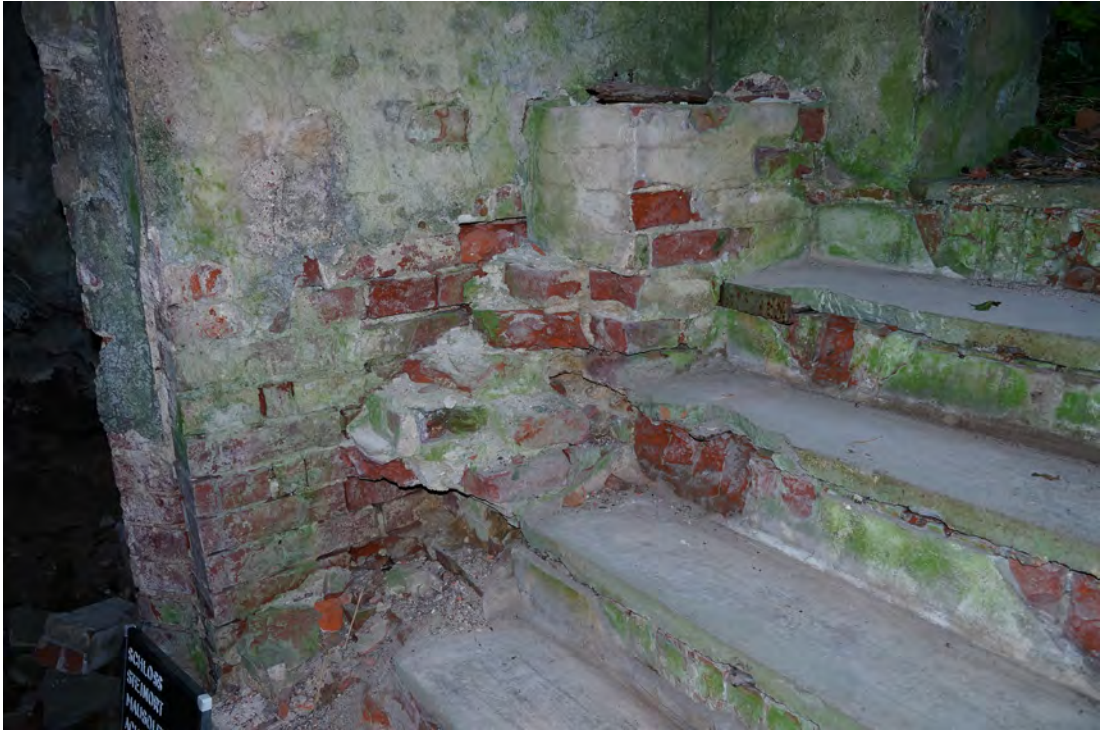
Abb. 276 Die linke Treppenwange der Treppe der Innenwandfläche E.
