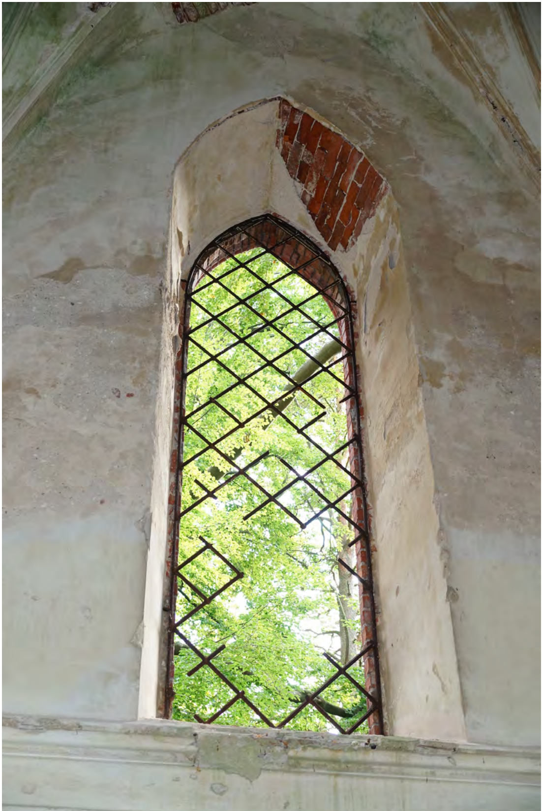
Abb. 354 Das Fenster der Innenwandfläche E.
