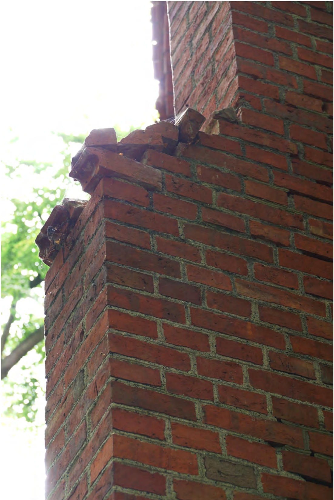
Abb. 110 Der Mauerwerksvorsprung der Achse 04 a.
