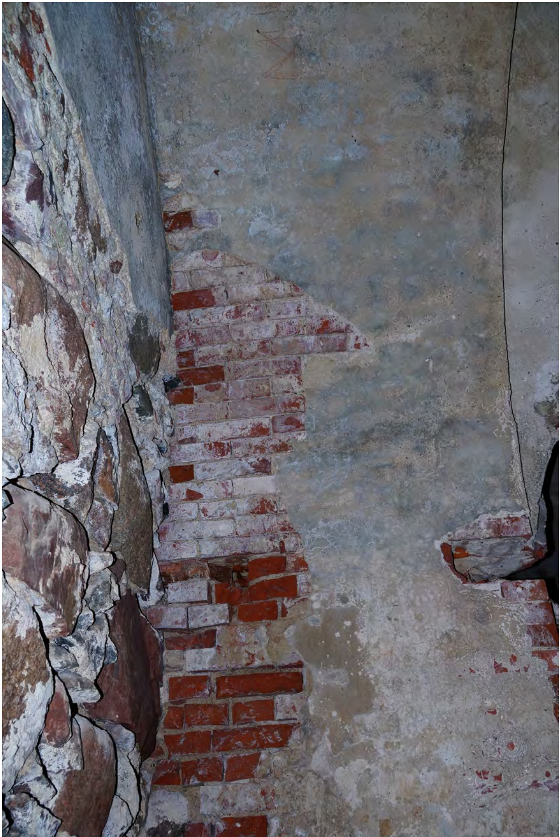
Abb. 252 Schäden am Mauerwerk im hinteren, unteren Bereich der Achse 04 a.
