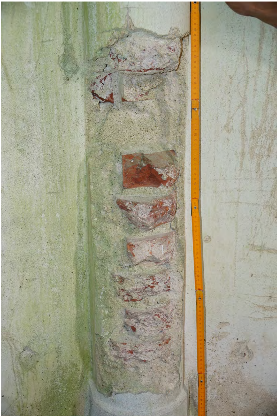
Abb. 339 Schäden im unteren Bereich des Pilasters der Achse 03.
