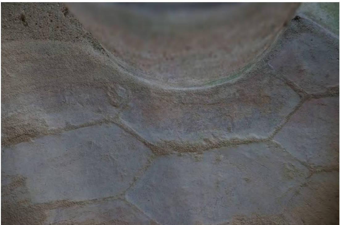
Abb. 379 Fußbodenanschluss an den Pilaster der Achse 04.
