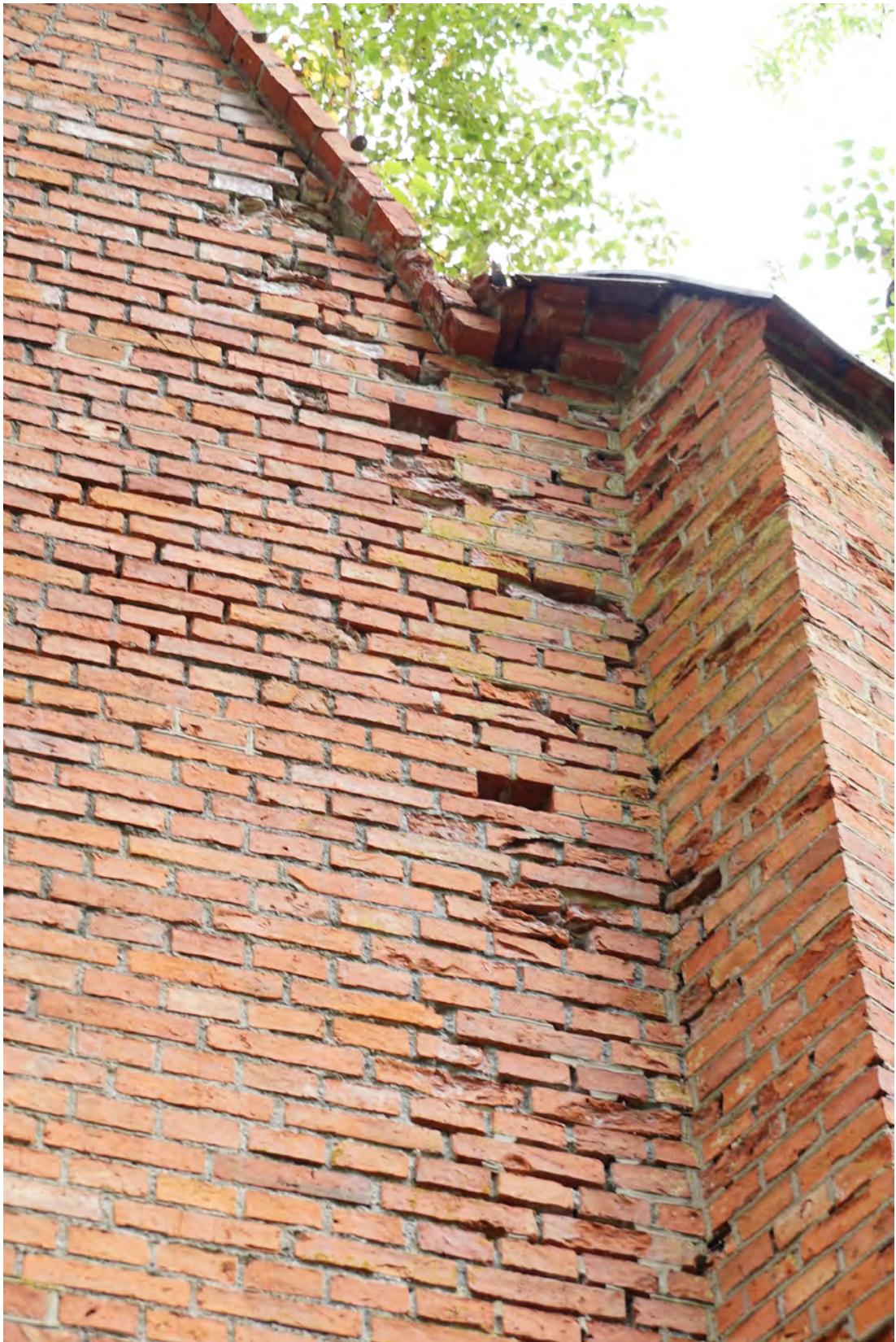
Abb. 181 Der Dachanschluss der Achse 07 c.
