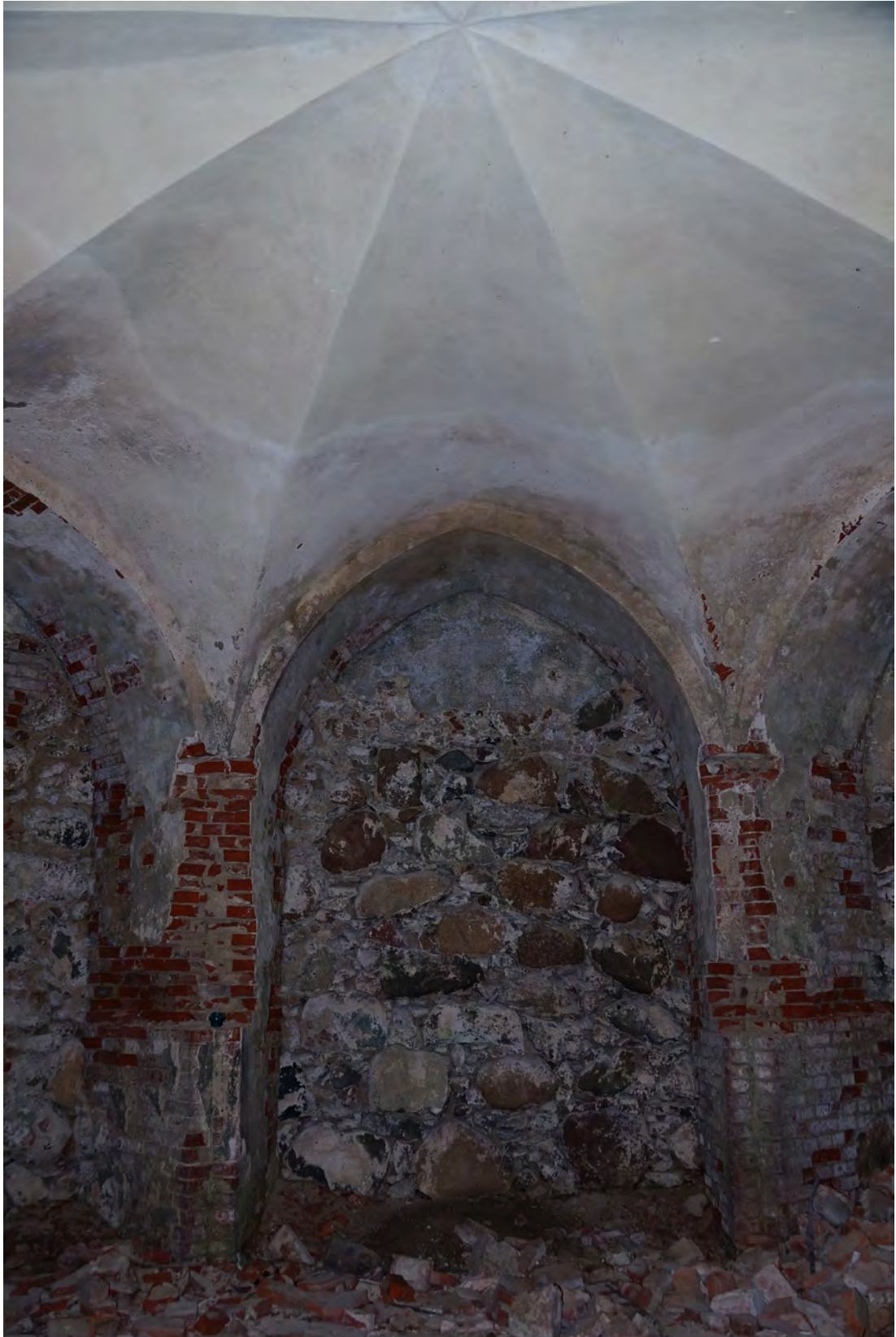
Abb. 246 Übersichtsfoto der Innenwandfläche C mit Gewölbe.
