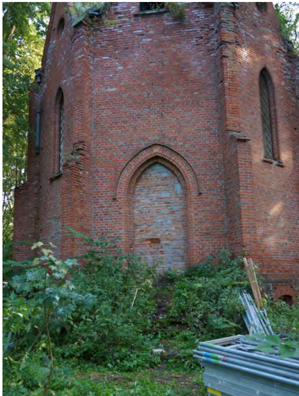
Abb. 16 Ausgangszustand zum Eingang.
