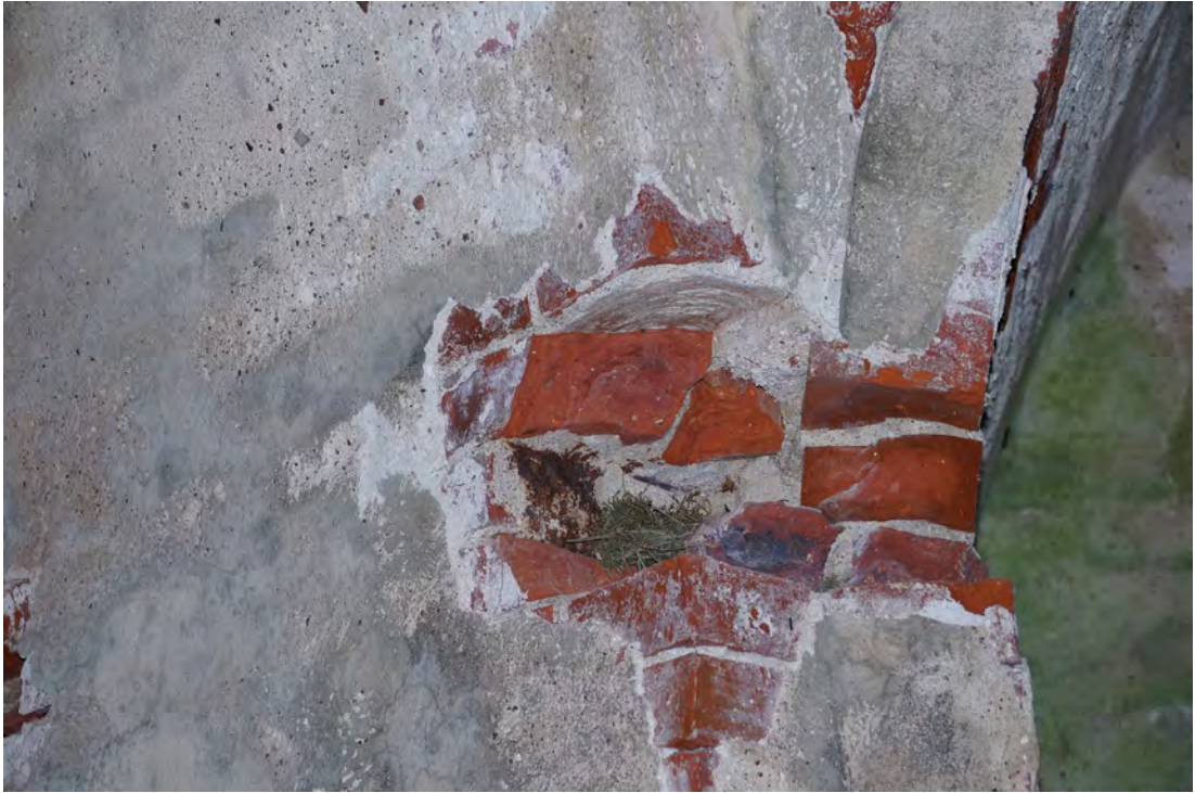
Abb. 267 Schäden am Mauerwerk des Widerlagers der Achse 05 a/b.
