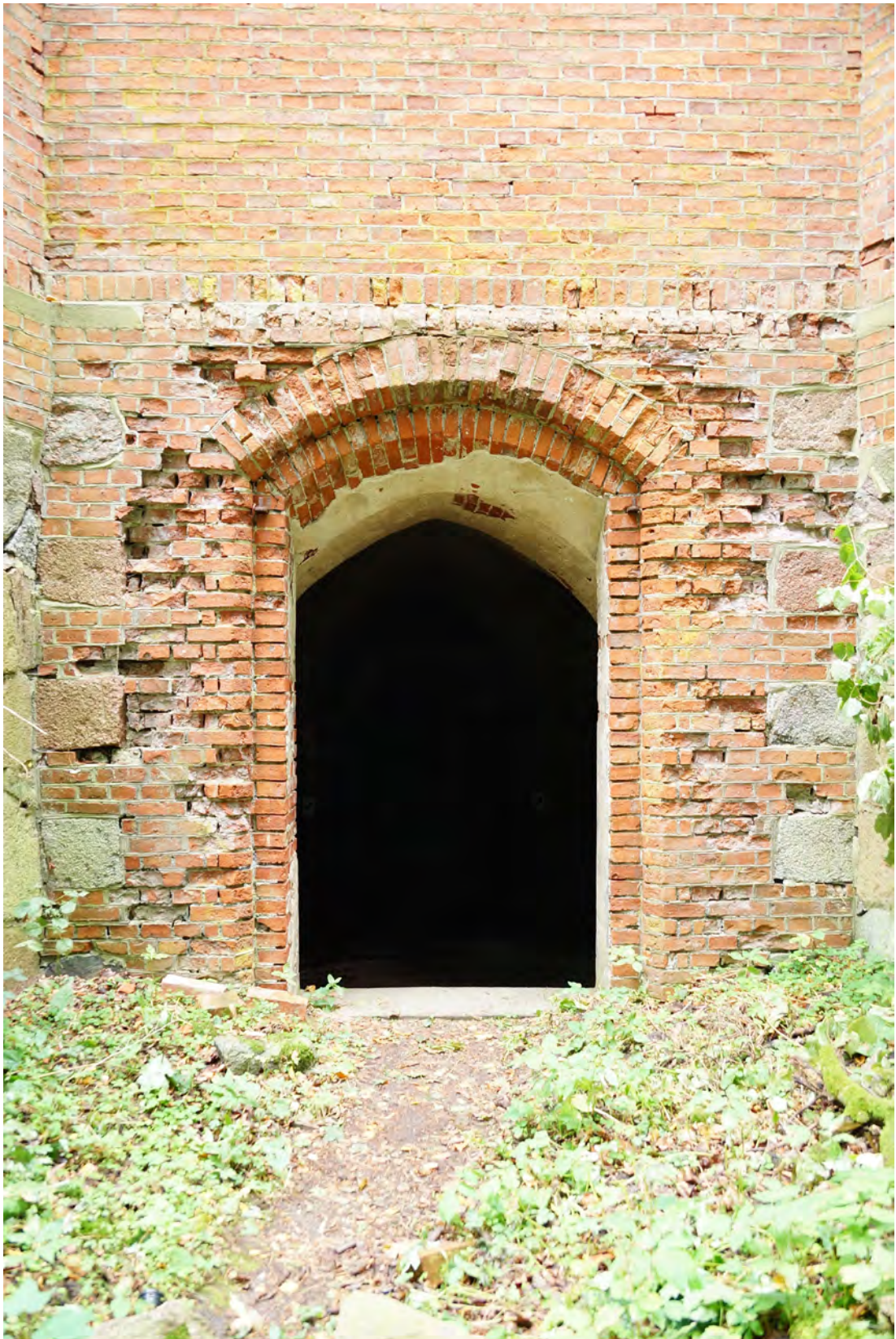
Abb. 134 Übersichtsfoto der Tür in der Außenwandfläche E.
