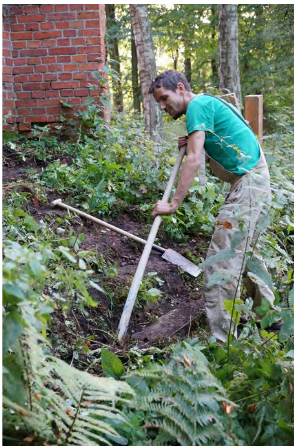
Abb. 17 Beseitigung von Unkraut und provisorische Wiederherstellung der Eingangstreppe.
