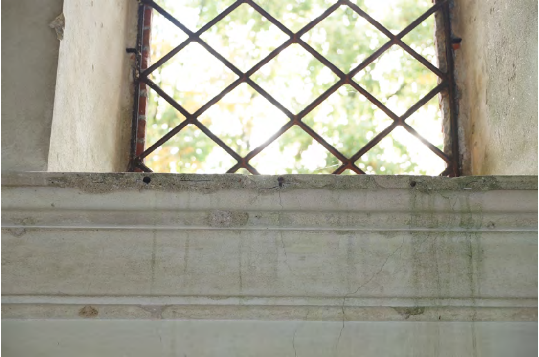
Abb. 361 Das Fensterbrett des Fensters der Innenwandfläche F.
