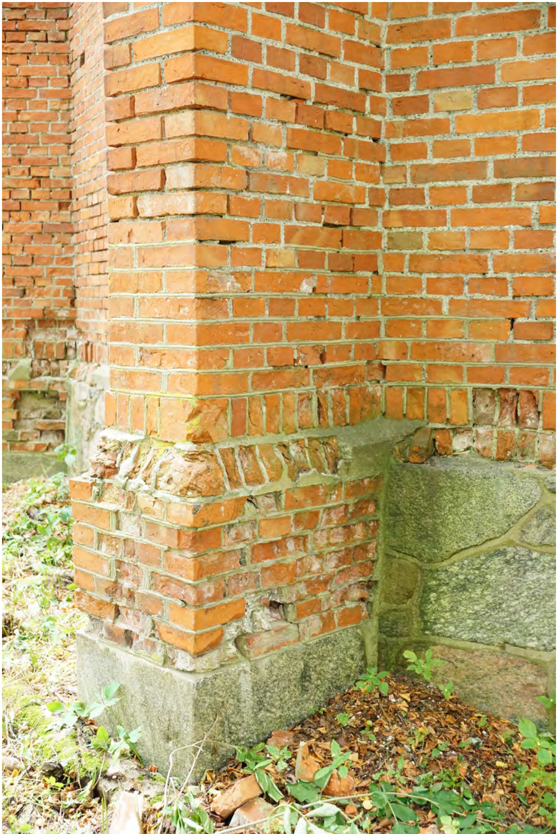
Abb. 108 Der Sockelbereich der Achse 04 a.
