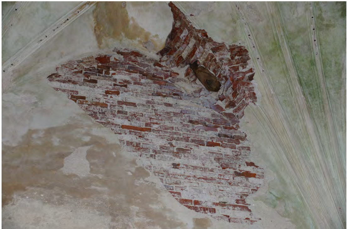
Abb. 329 Die Schadstelle im Spitzbogen der Innenwandfläche A.
