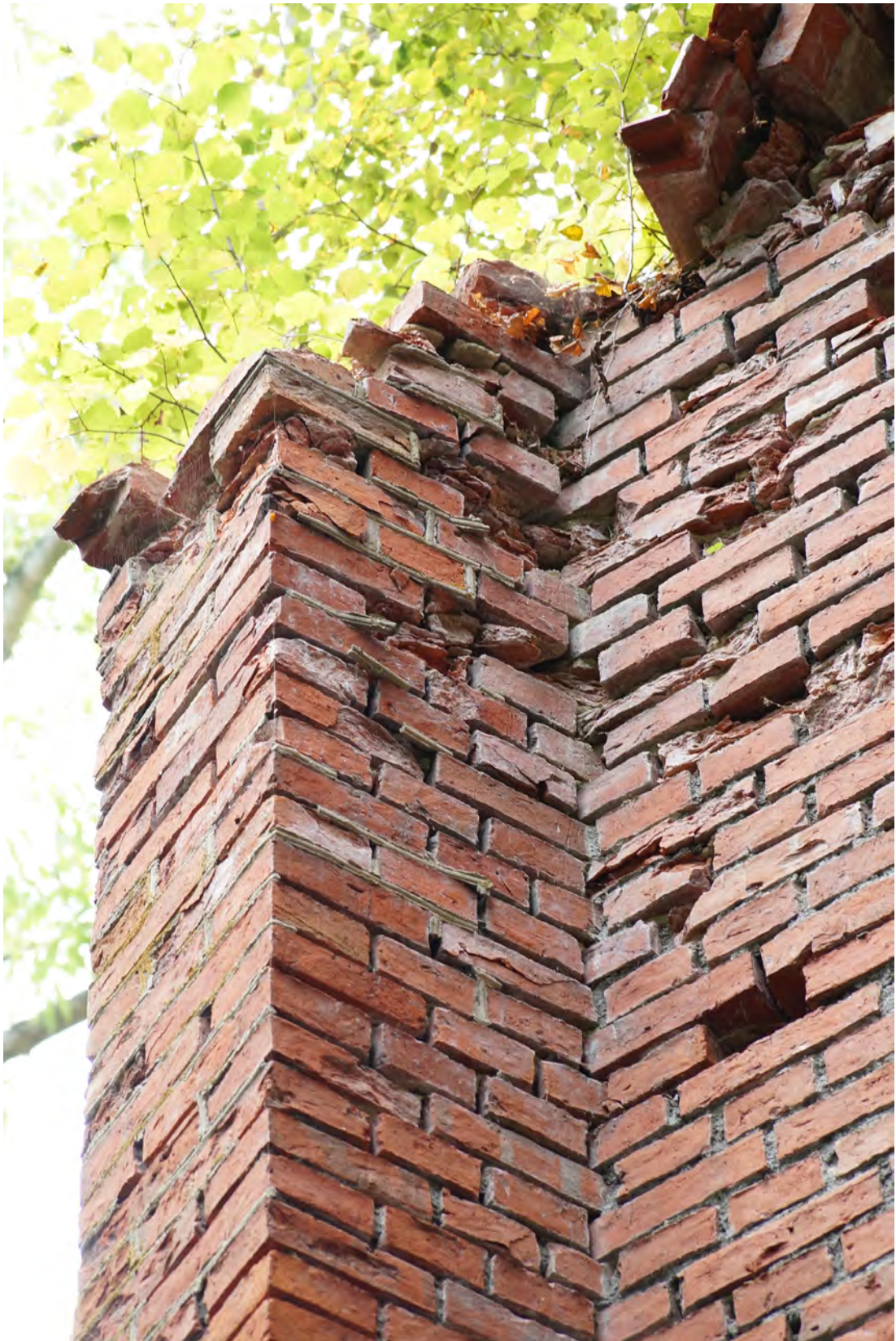
Abb. 130 Der Dachanschluss der Achse 05 a.
