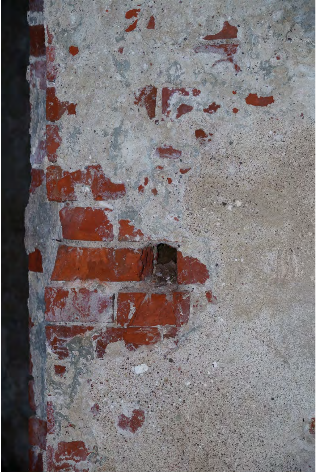
Abb. 300 Das durchgängige Loch im vorderen, mittleren Bereich der Achse 07 c.
