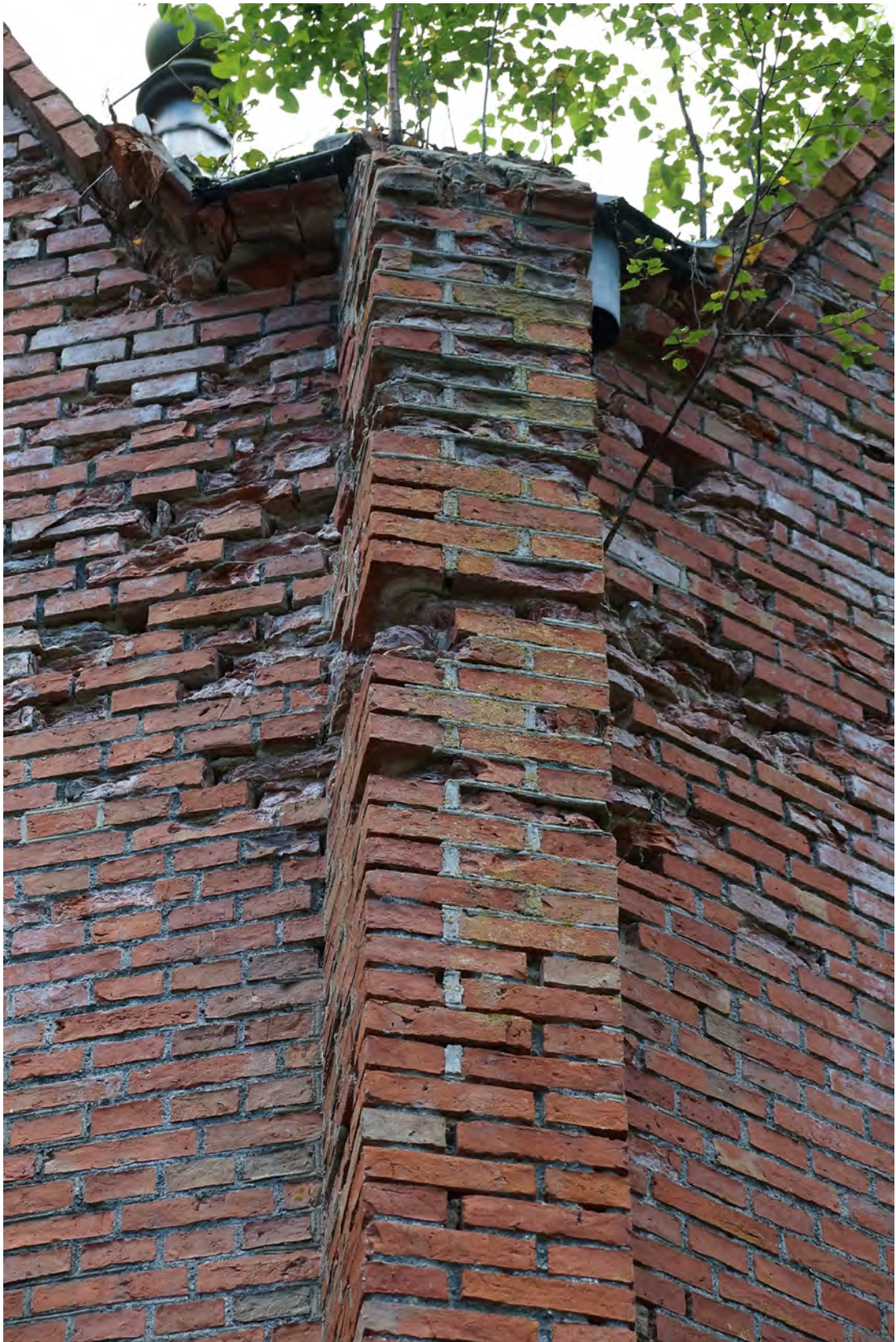
Abb. 38 Dachanschluss der Achse 01.
