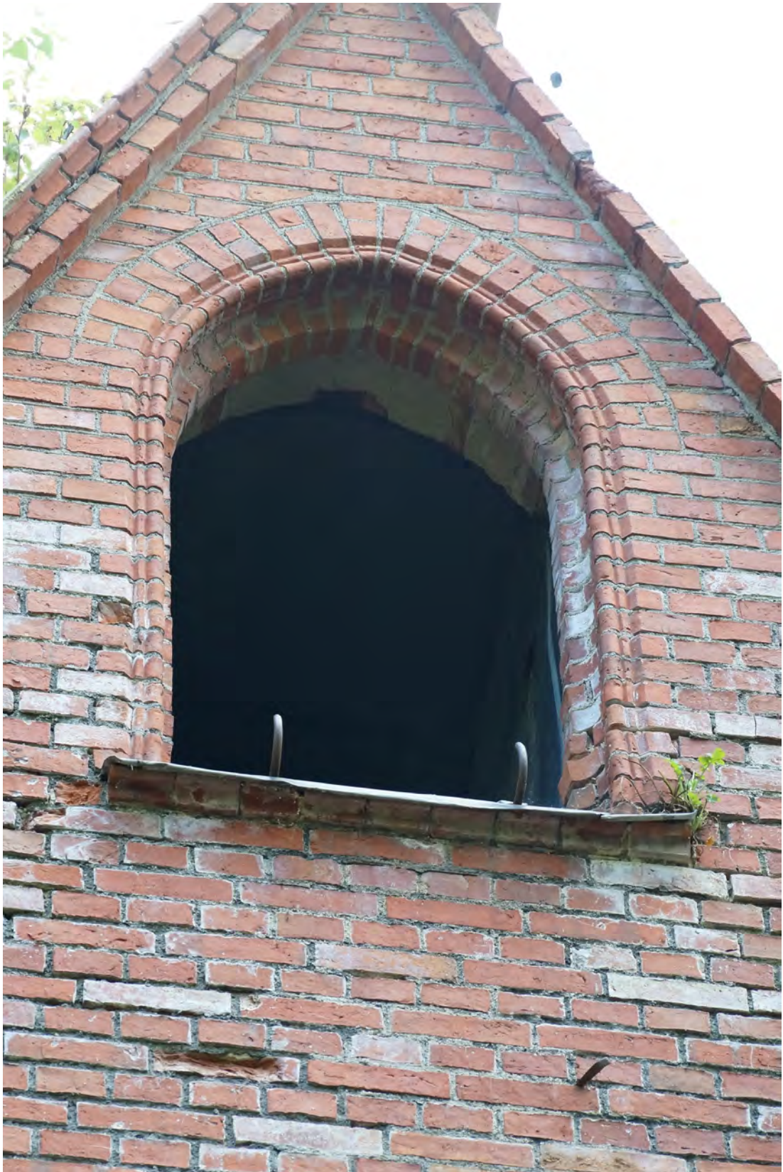
Abb. 51 Fensteröffnung der Außenwandfläche A.
