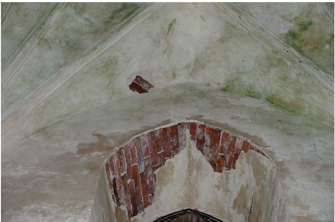
Abb. 342 Die Schäden am Spitzbogen des Fensters der Innenwandfläche C.
