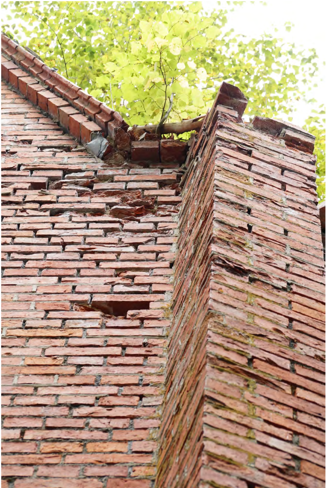
Abb. 131 Der Dachanschluss der Achse 05 b/c.
