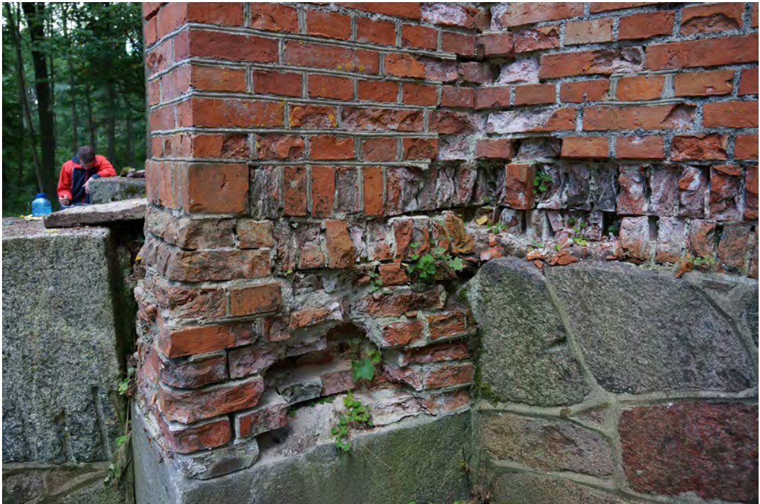
Abb. 32 Sockelbereich der Achse 01 a.
