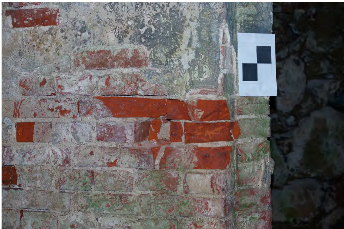
Abb. 209 Schäden am Mauerwerk in der Mitte der Achse 01 a.
