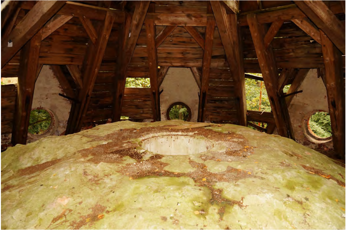
Abb. 398 Blick auf die Gewölbeoberseite.
