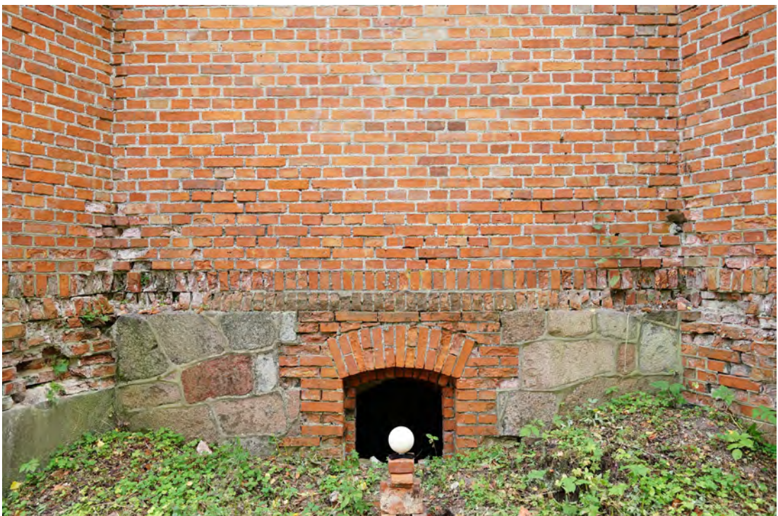
Abb. 201 Der Sockelbereich der Außenwandfläche H.
