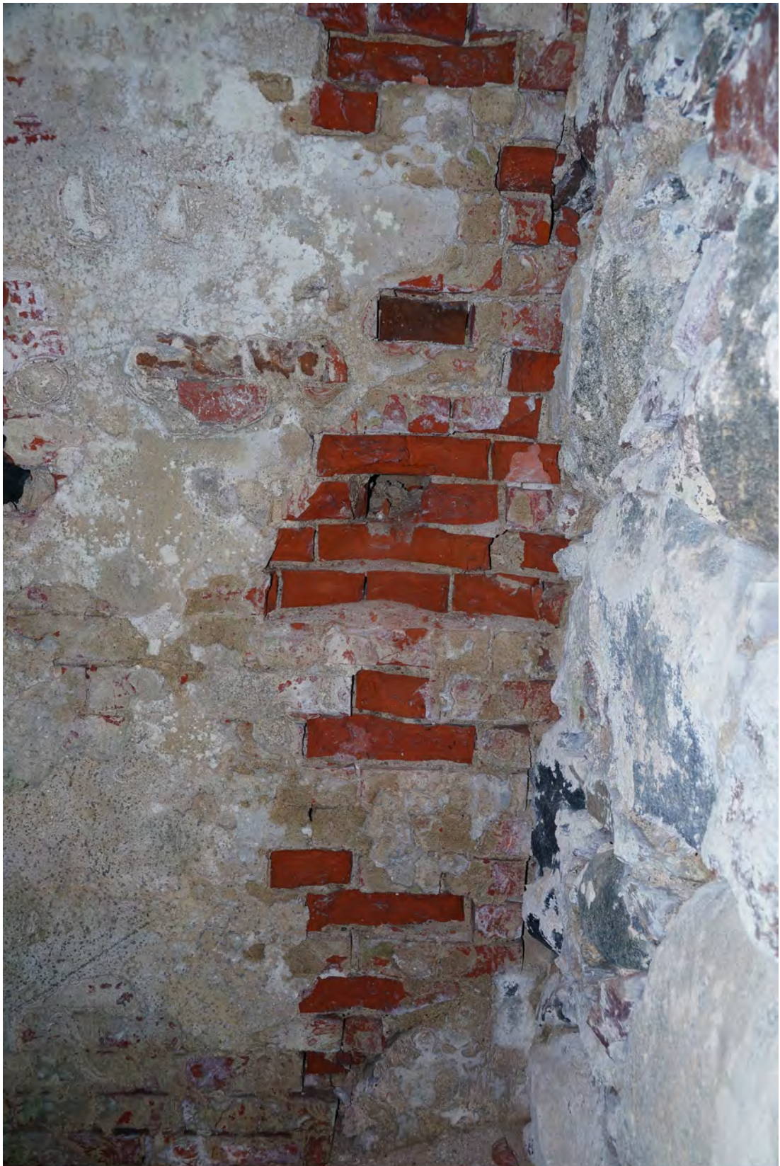
Abb. 242 Schäden am Mauerwerk im hinteren, unteren Bereich der Achse 03 c.
