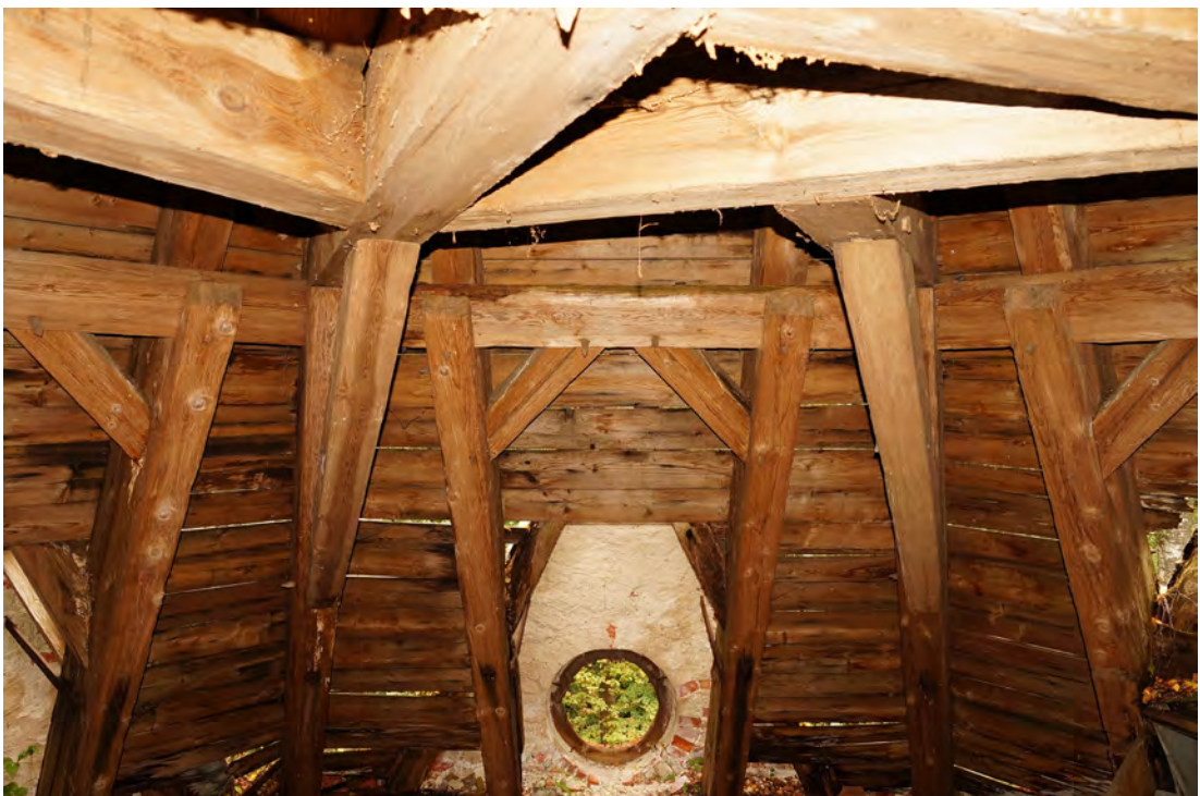
Abb. 397 Der obere Teil der Innenwandfläche H im Dachraum.
