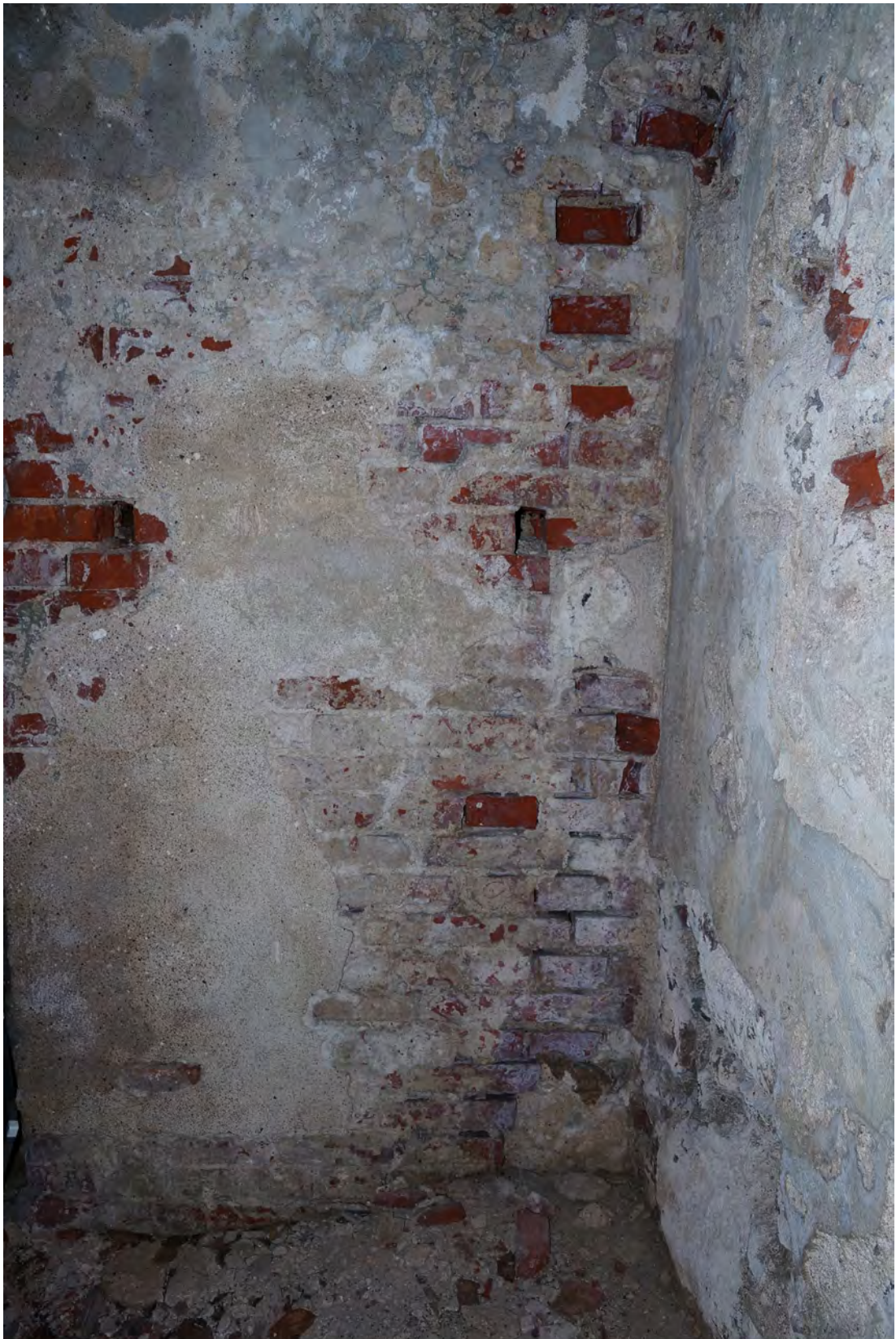
Abb. 298 Schäden im hinteren, unteren Bereich des Mauerwerks der Achse 07 c.
