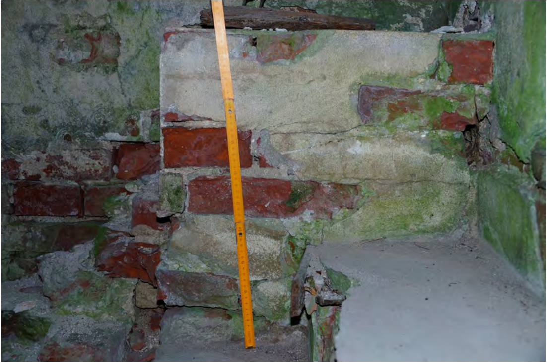
Abb. 280 Maximaler Abstand der gemauerten Seitenblöcke zum Auftritt der Stufen (hier: linke Treppenwange, oben).
