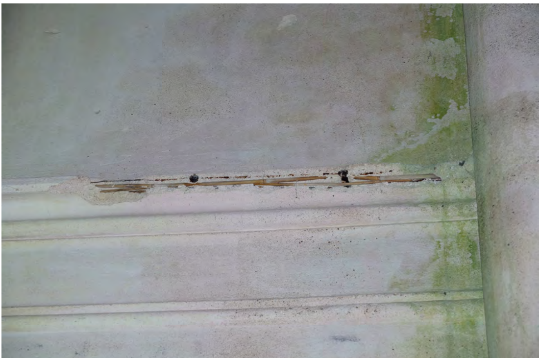
Abb. 333 Schadstelle am Gesims der Innenwandfläche B an der Achse 03.
