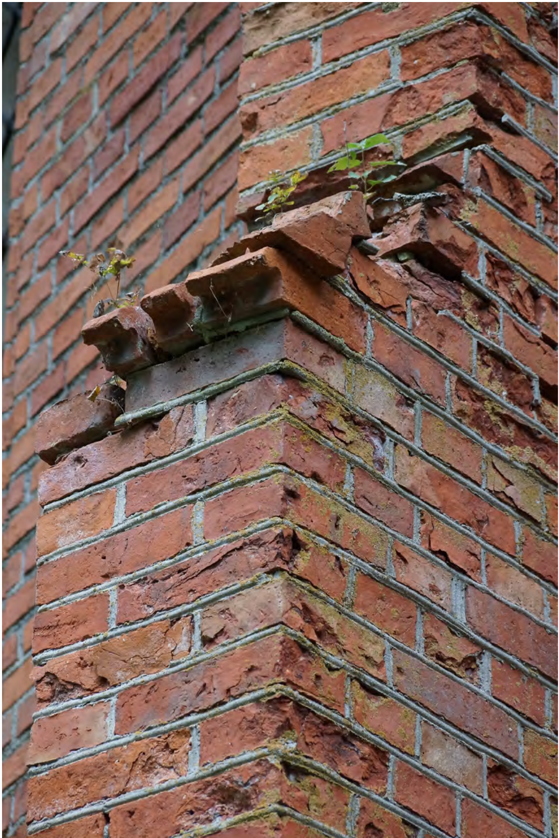
Abb. 178 Der Mauerwerksvorsprung der Achse 07 a.
