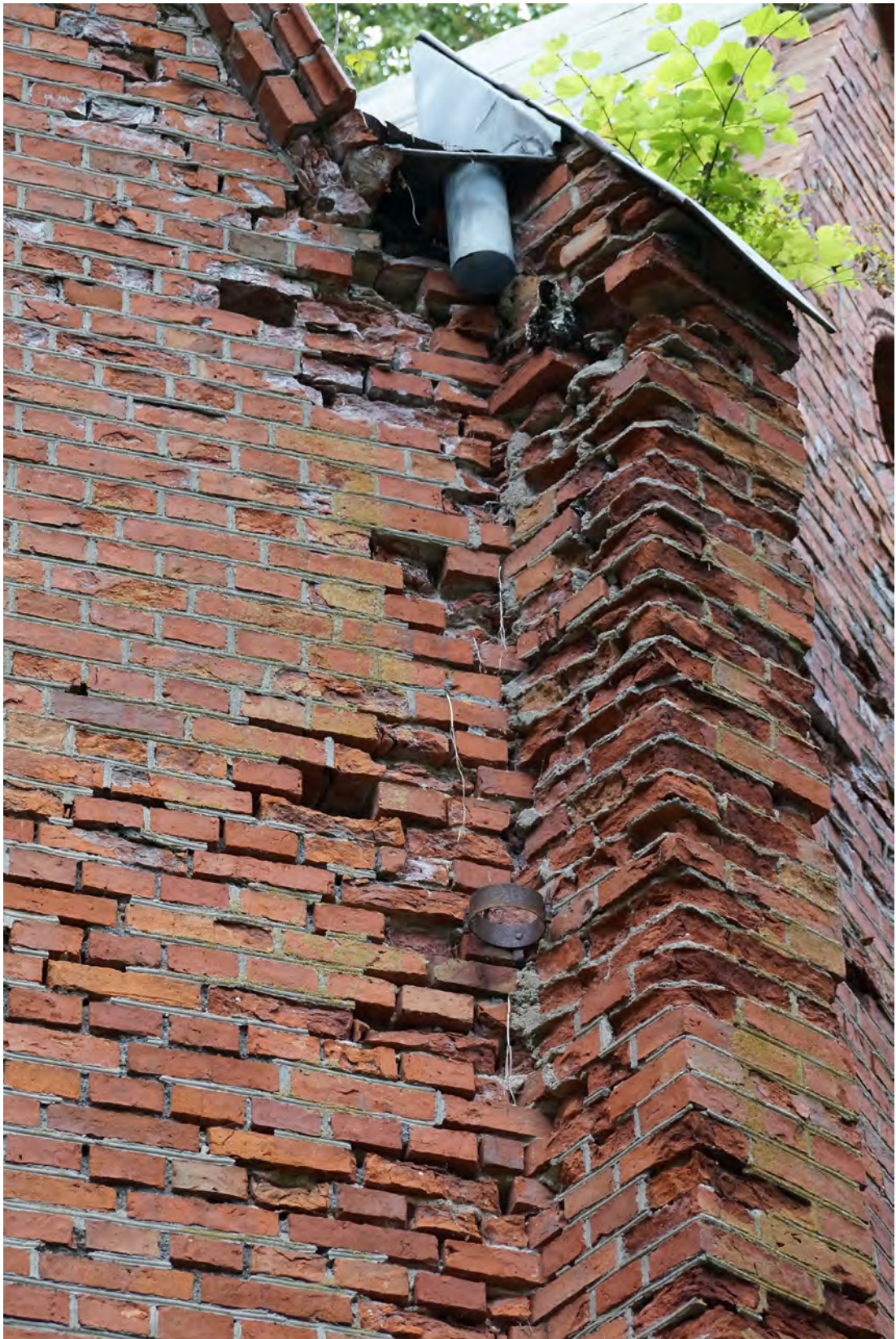
Abb. 161 Der Dachanschluss der Achse 06 c.
