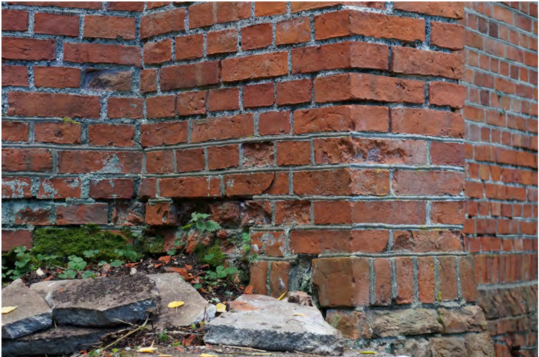
Abb. 34 Sockelbereich der Achse 01 c.
