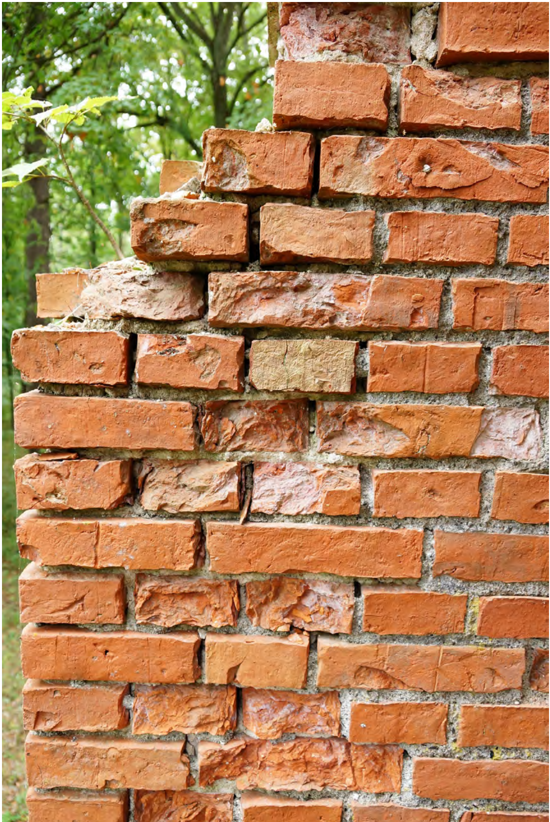
Abb. 73 Der Mauerwerksvorsprung an der Achse 02 a.
