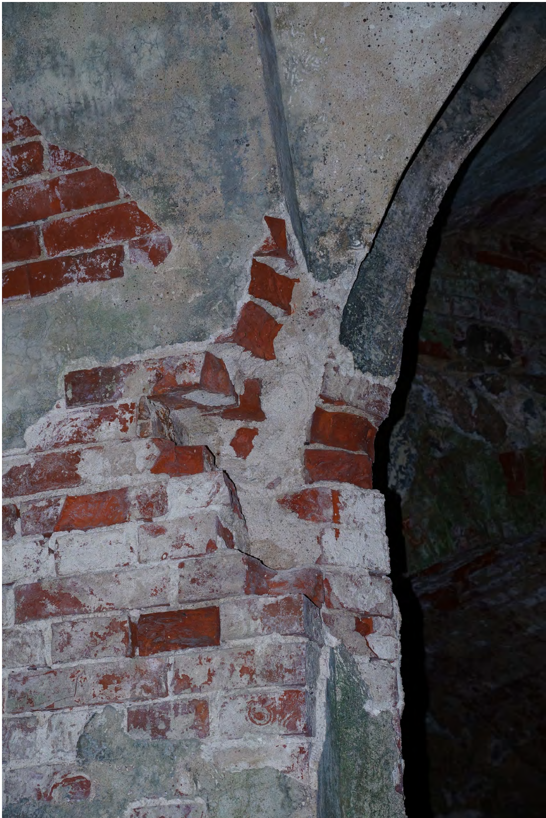
Abb. 212 Schäden am Mauerwerk des Widerlagers der Achse 01 a.
