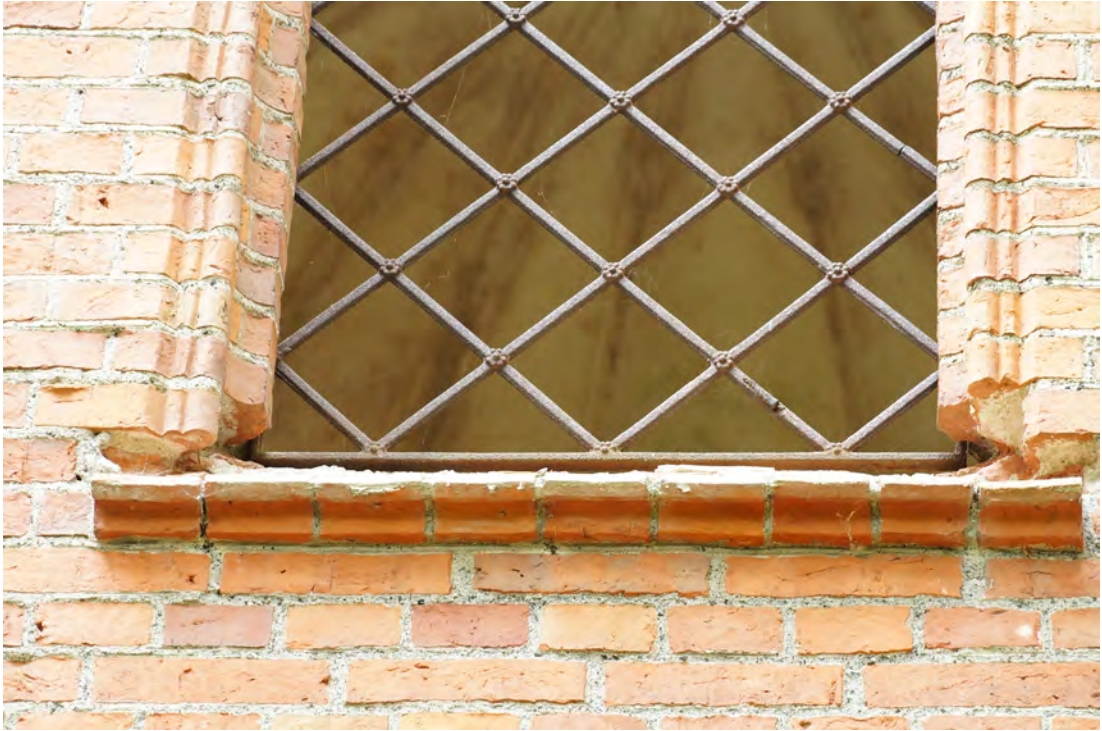
Abb. 119 Die Fensterbank des großen Fensters in der Mitte der Außenwandfläche D.
