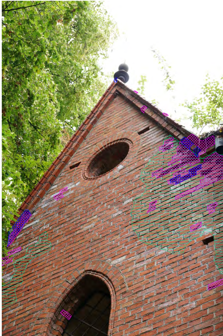
Abb. 447 Schadenskartierung der Außenwandfläche B (oberer Abschnitt).
