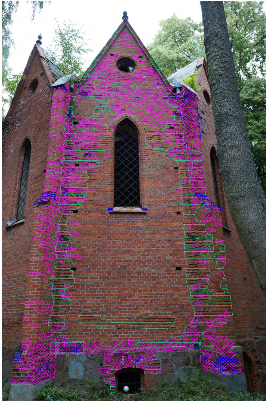
Abb. 451 Schadenskartierung der Außenwandfläche F.
