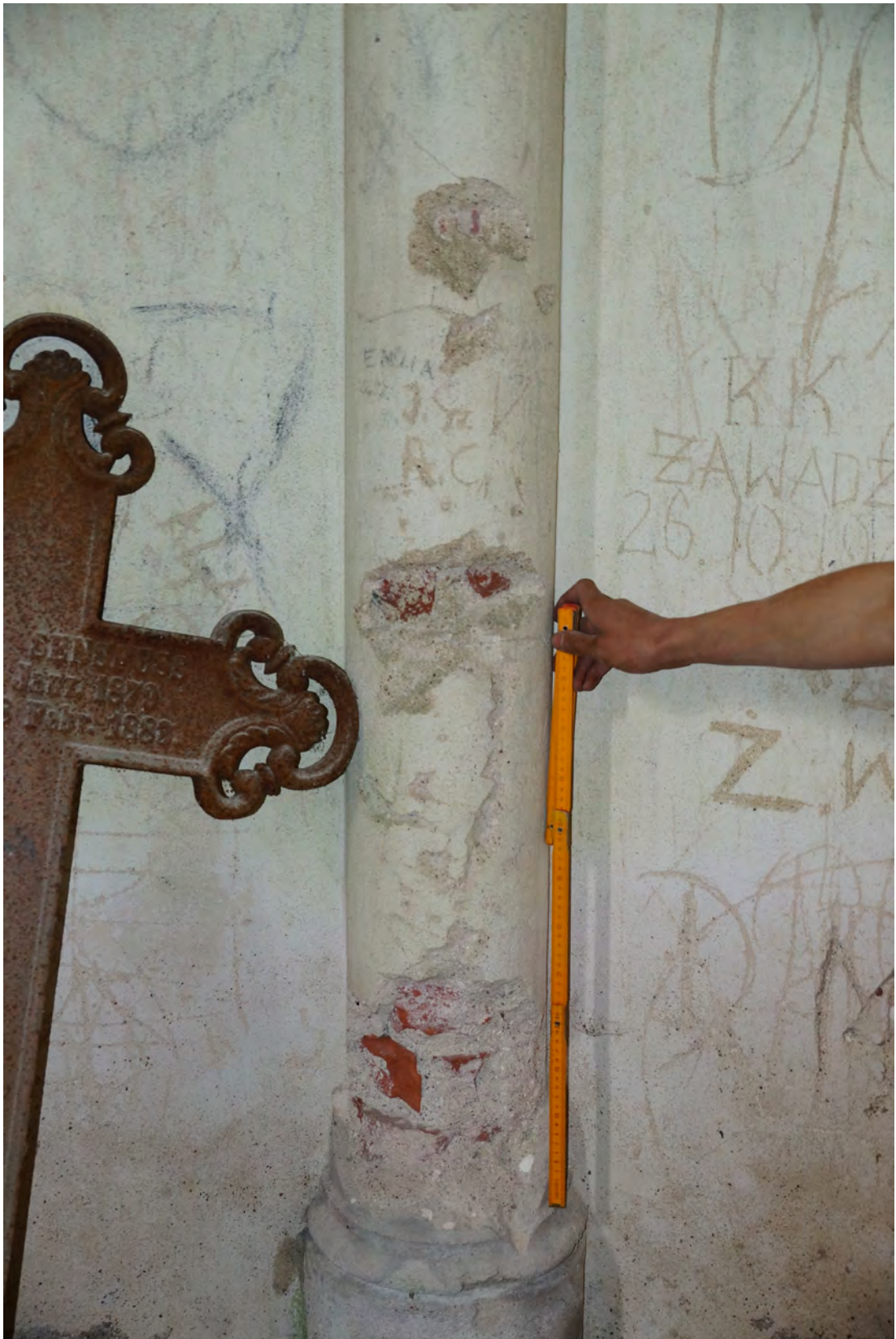
Abb. 326 Schäden im unteren Bereich des Pilasters der Achse 01.
