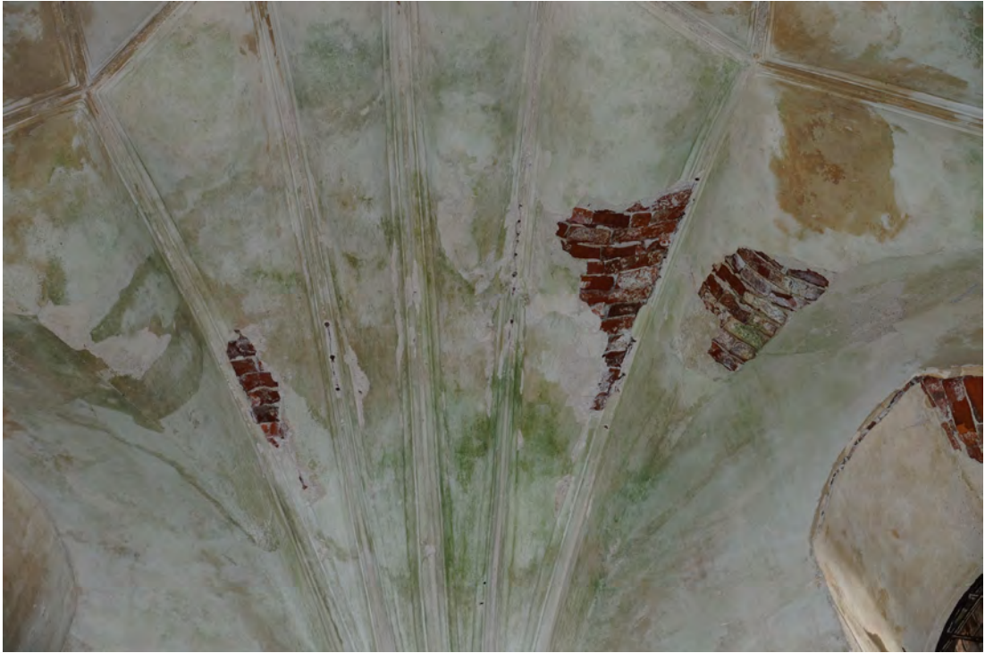
Abb. 352 Schäden an den unteren Gewölberippen der Achse 05..
