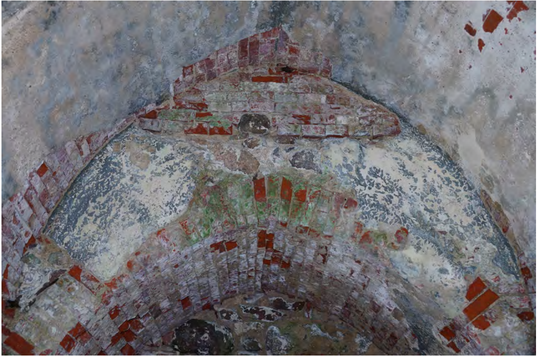
Abb. 218 Schäden an den Spitzbögen der Innenwandfläche A.
