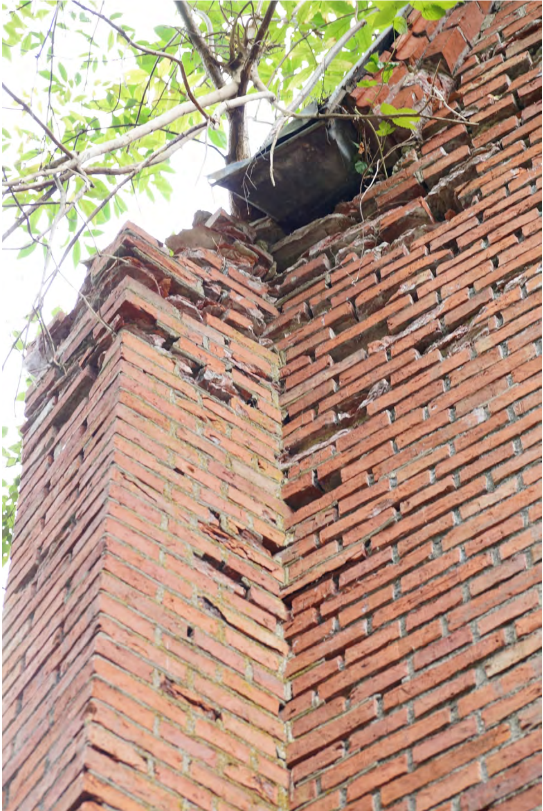
Abb. 197 Der Dachanschluss der Achse 08 a.
