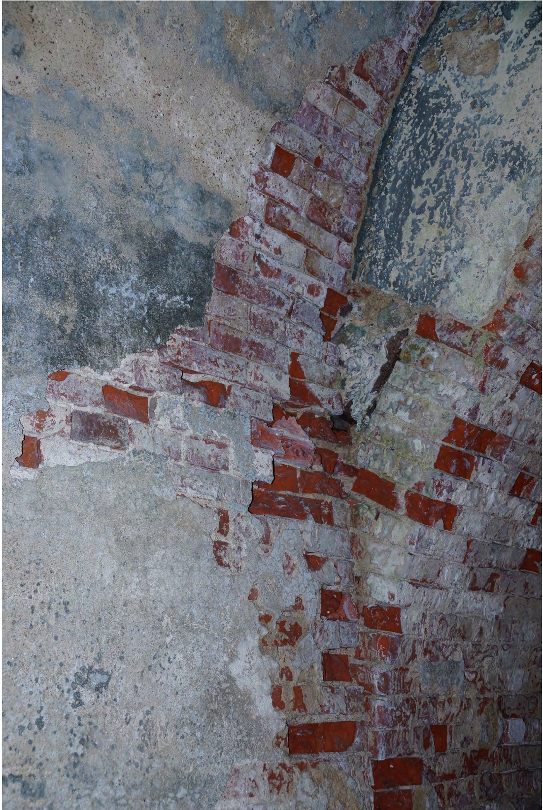
Abb. 214 Schäden am Übergang zu den Bögen der Innenwandfläche A.
