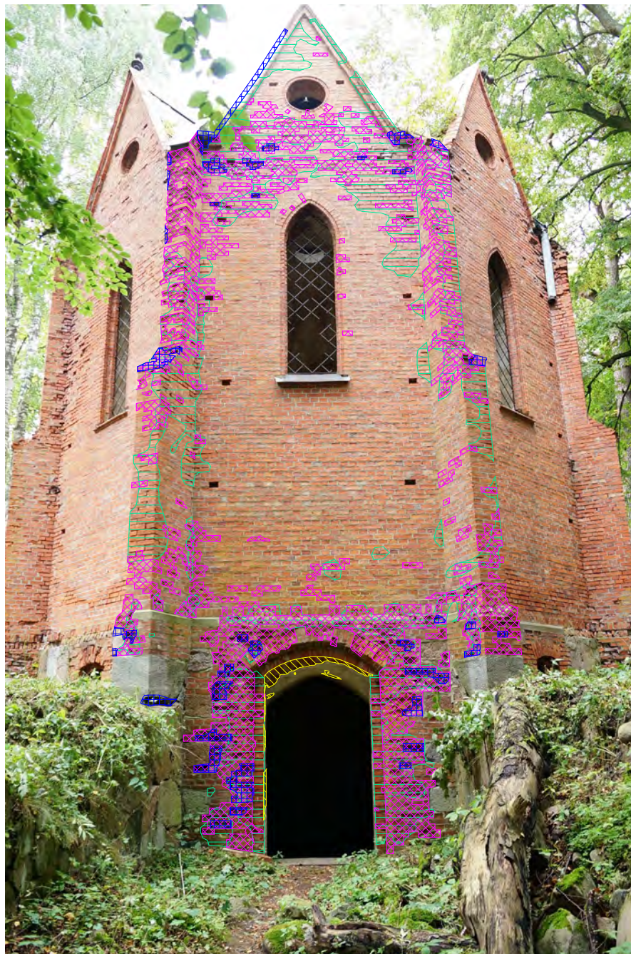
Abb. 450 Schadenskartierung der Außenwandfläche E.
