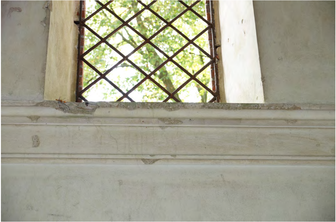
Abb. 370 Das Fensterbrett des Fensters der Innenwandfläche G.
