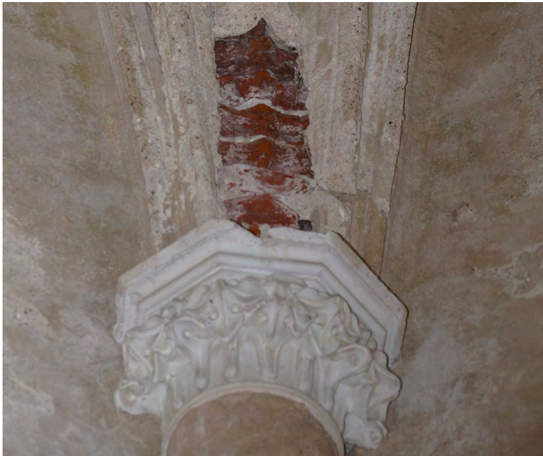
Abb. 456 Erneueres Kapitell am Pilaster der Achse 07 im Innenraum des EG.
