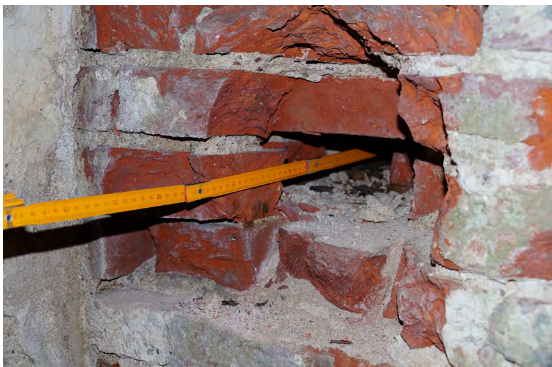
Abb. 317 Die Tiefe des Loches im hinteren, mittleren Bereich der Achse 08 a.
