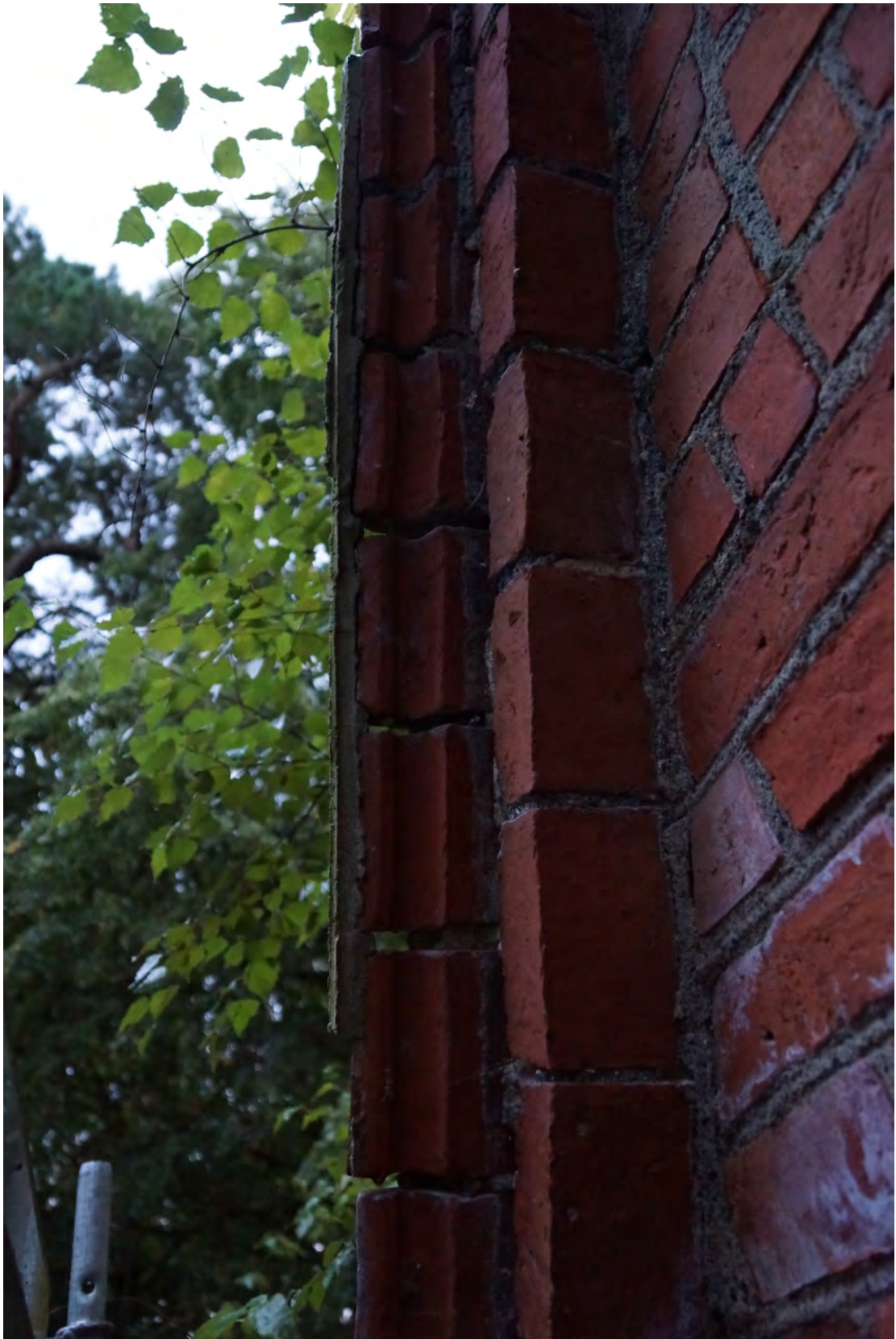
Abb. 50 Gestaltung der Dachkante mittels Formsteinen des Typs S1.
