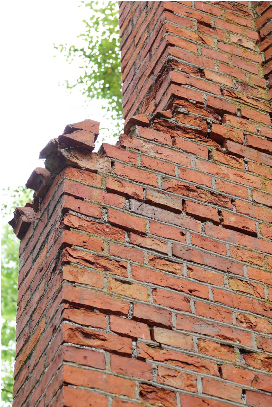
Abb. 195 Der Mauerwerksvorsprung der Achse 08 a.
