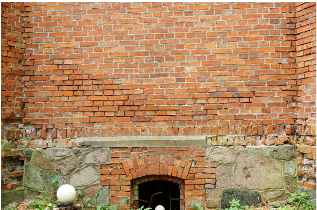
Abb. 117 Der Sockelbereich und Fugenauswaschungen darüber.
