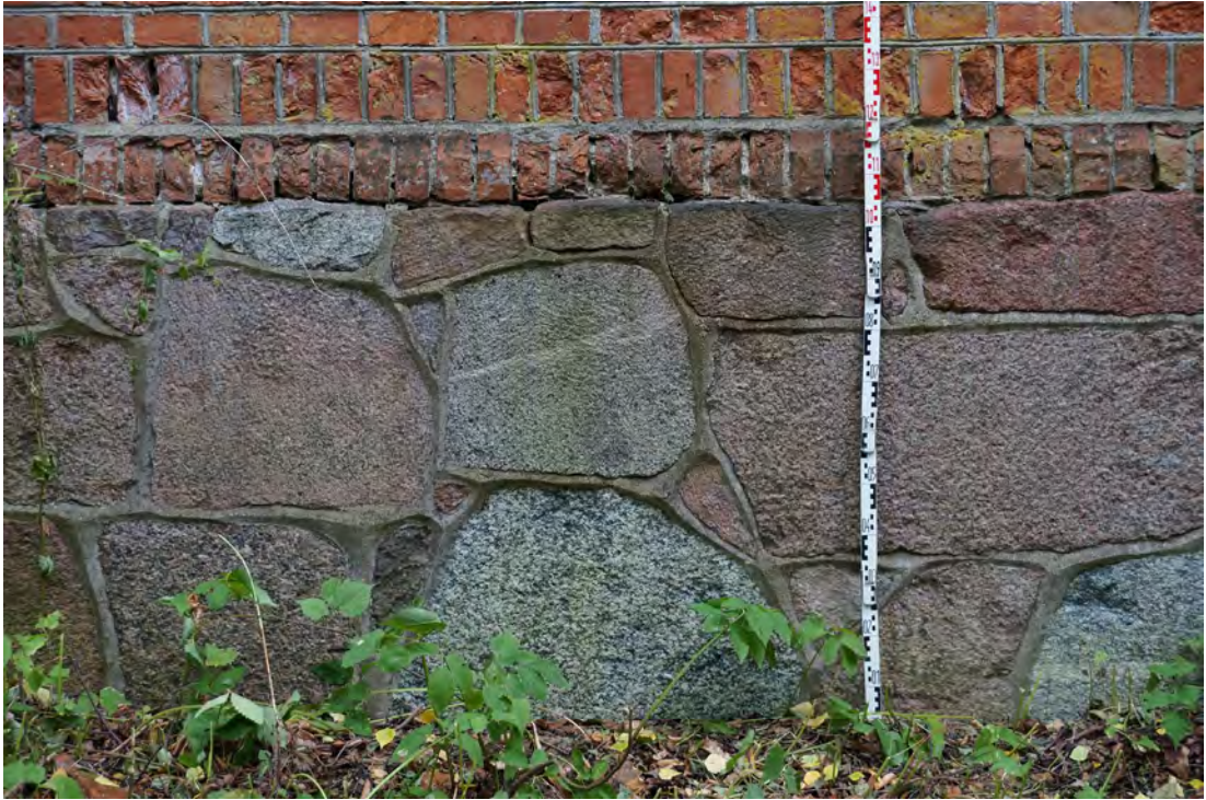
Abb. 183 Der Sockelbereich der Außenwandfläche G.
