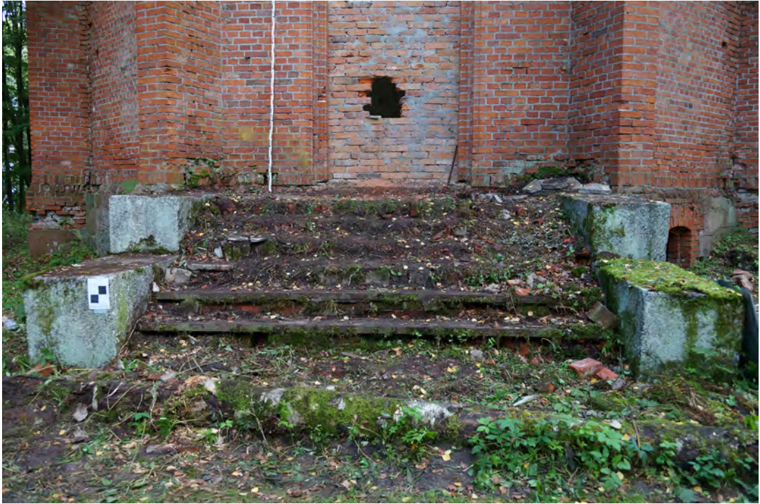
Abb. 53 Übersichtsfoto der Treppe auf der Außenwandfläche A.
