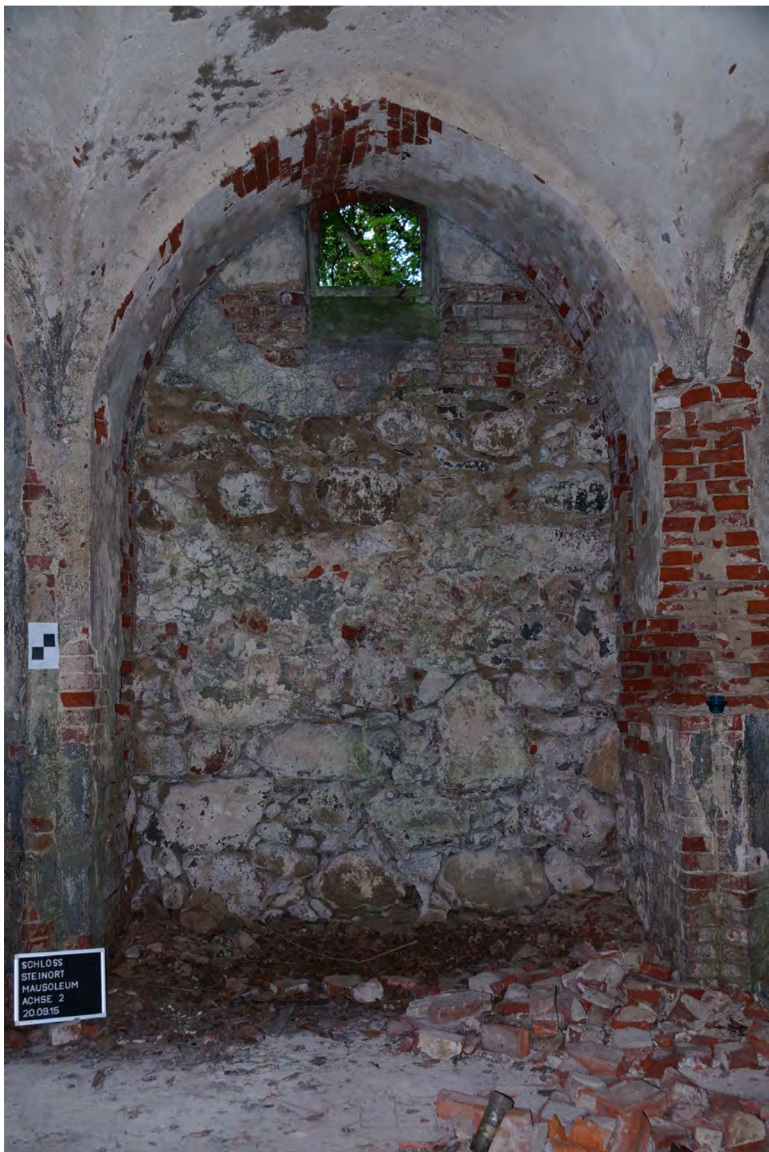
Abb. 230 Übersichtsfoto der Innenwandfläche B.
