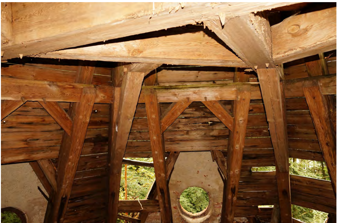
Abb. 391 Der obere Teil der Innenwandfläche E im Dachraum.
