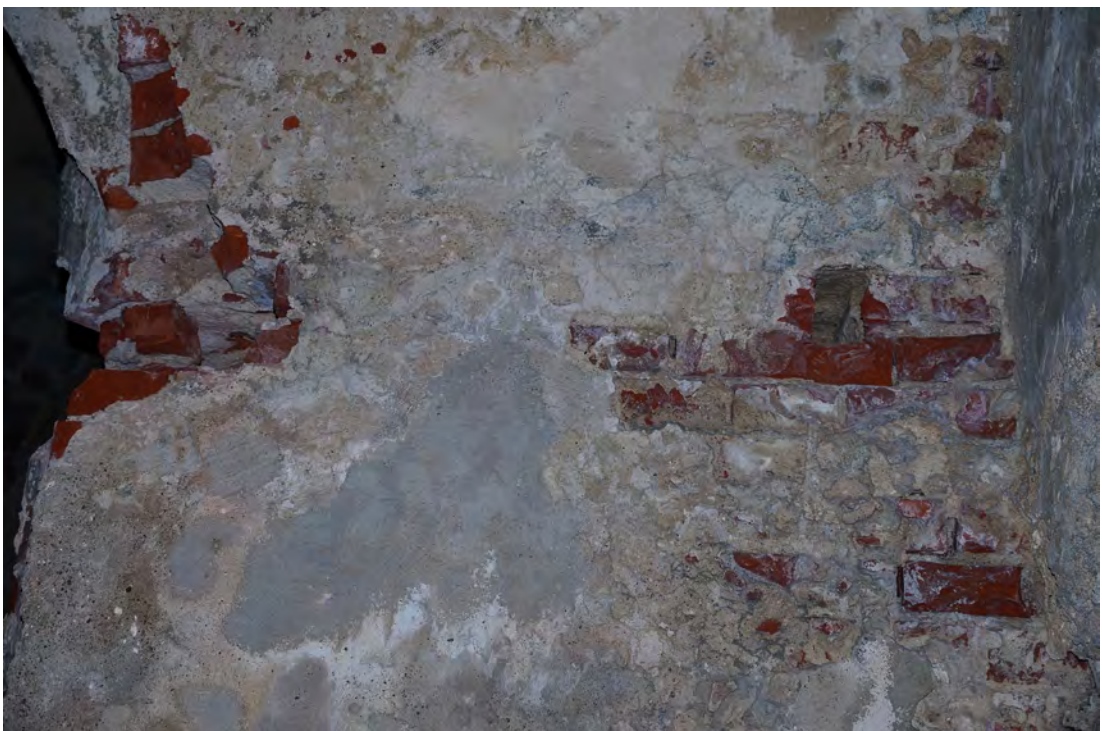
Abb. 301 Schäden am Mauerwerk im oberen Bereich der Achse 07 c.
