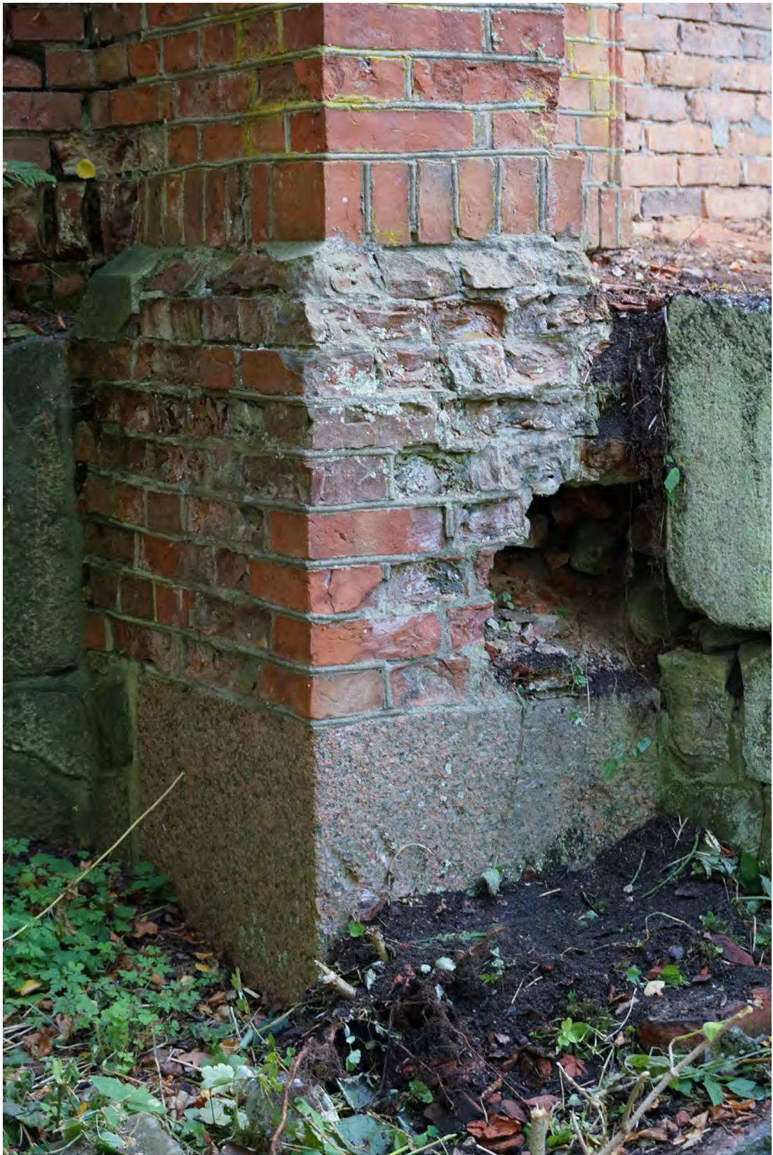
Abb. 70 Der Sockelbereich der Achse 02 c/b.
