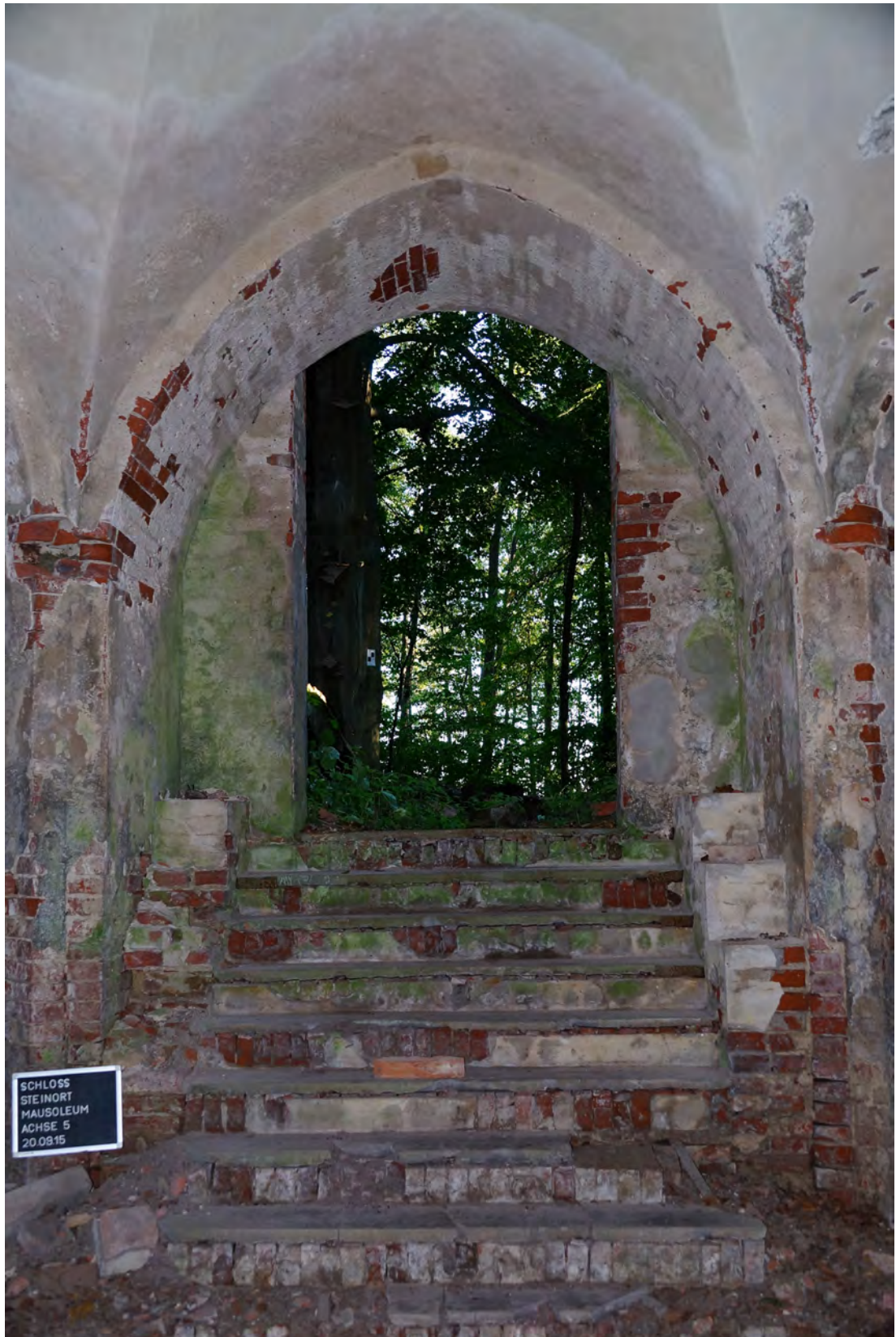
Abb. 271 Übersichtsfoto der Innenwandfläche E.
