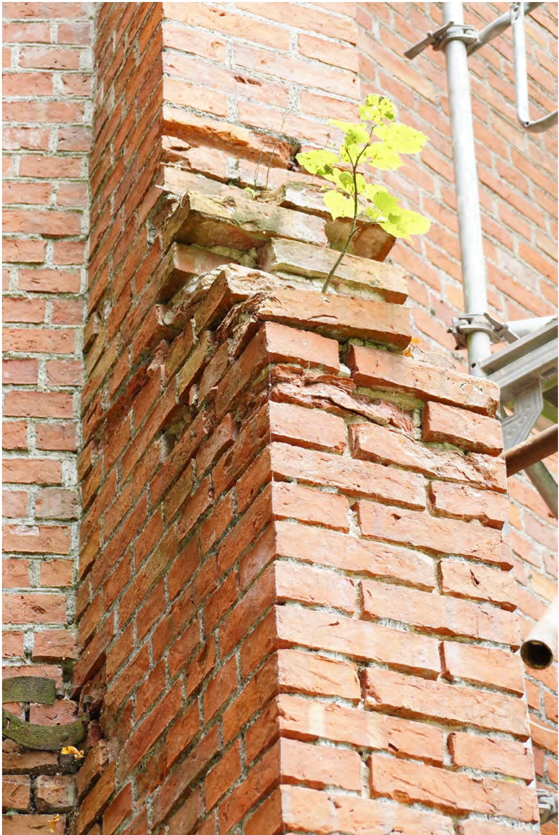
Abb. 74 Der Mauerwerksvorsprung an der Achse 02 c/b.
