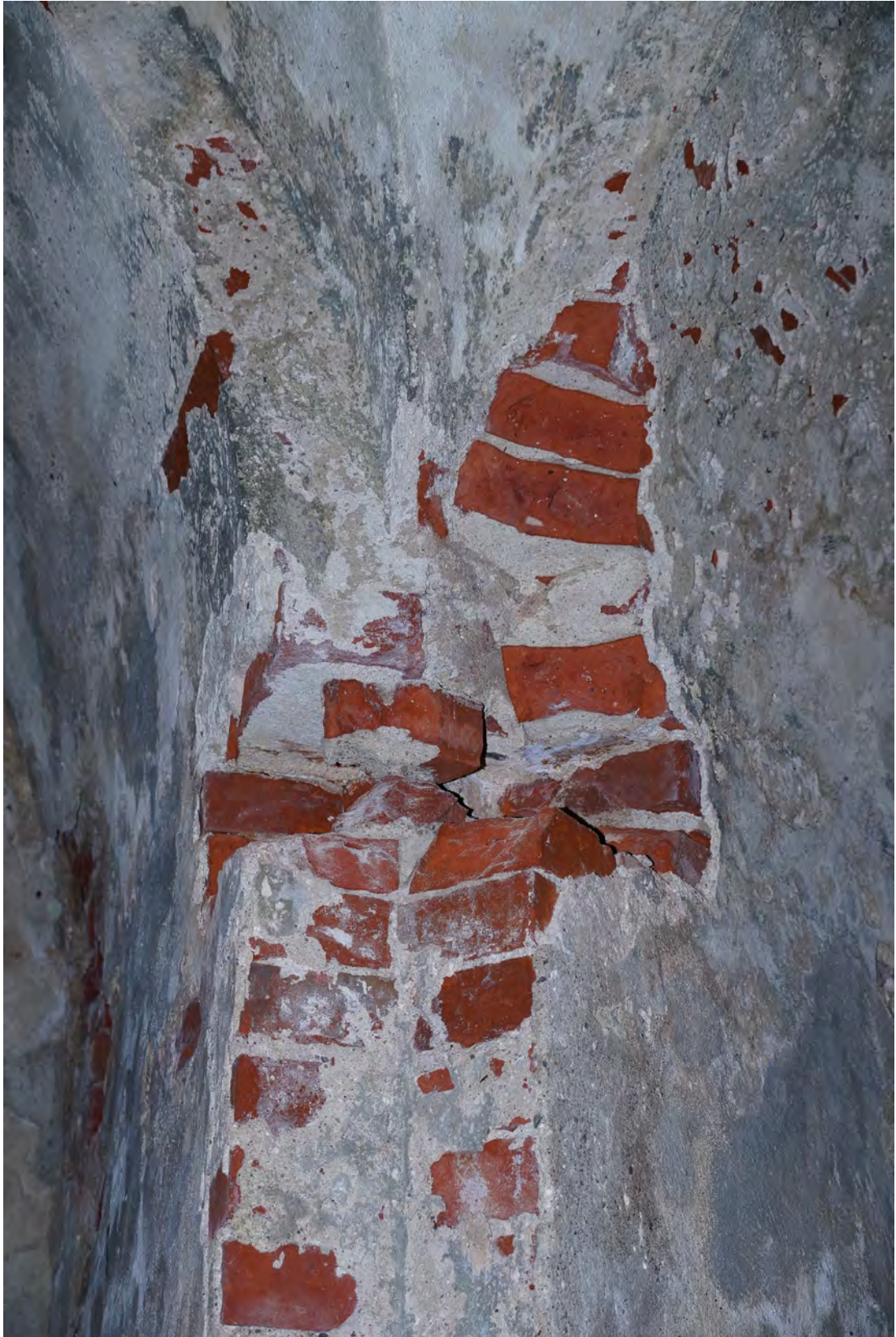
Abb. 297 Schäden am Mauerwerk des Widerlagers der Achse 07 b.
