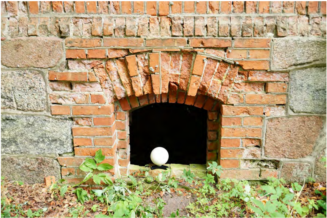
Abb. 81 Das untere Fenster im Sockelbereich der Außenwandfläche B.
