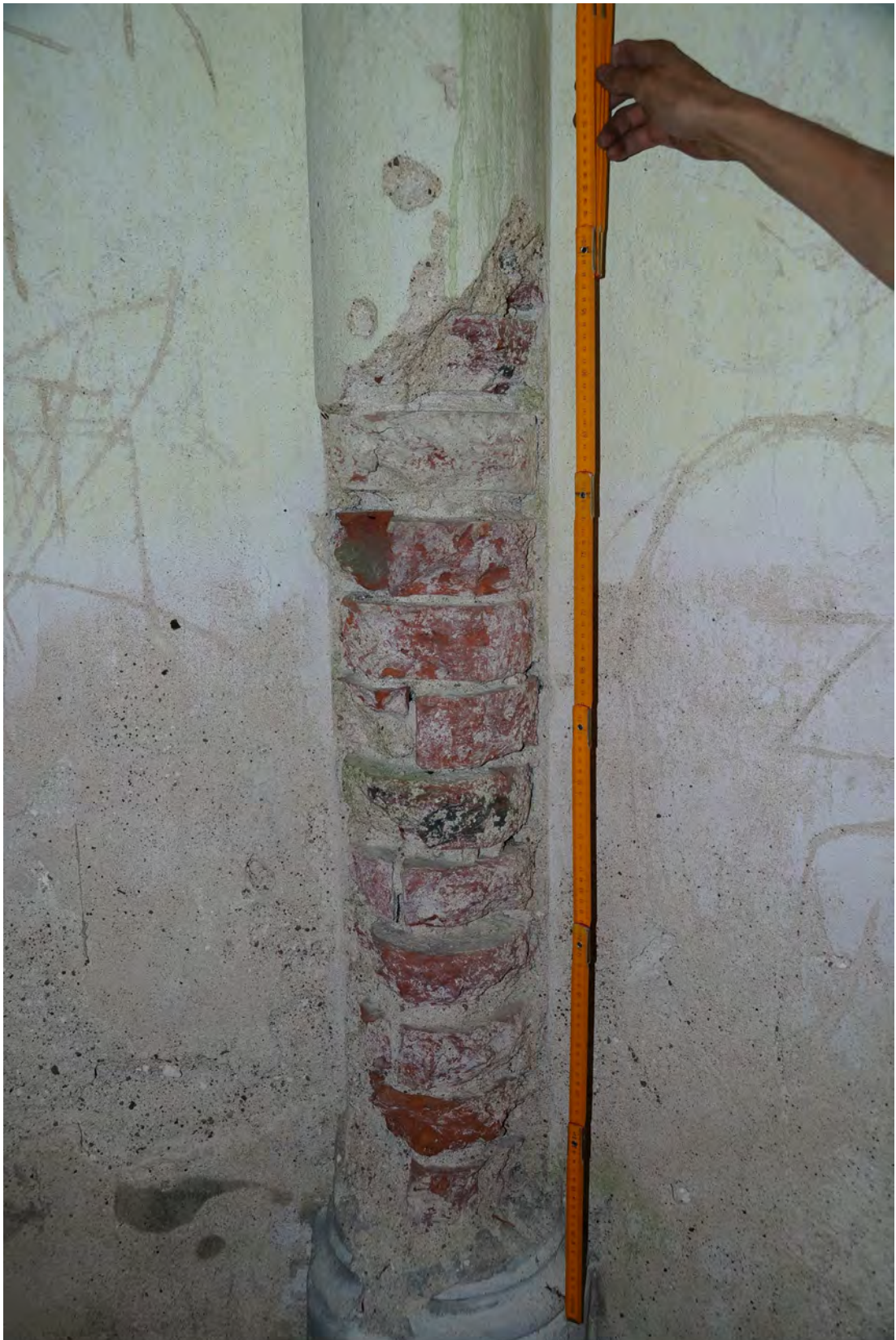
Abb. 358 Schäden im unteren Bereich des Pilasters der Achse 06.
