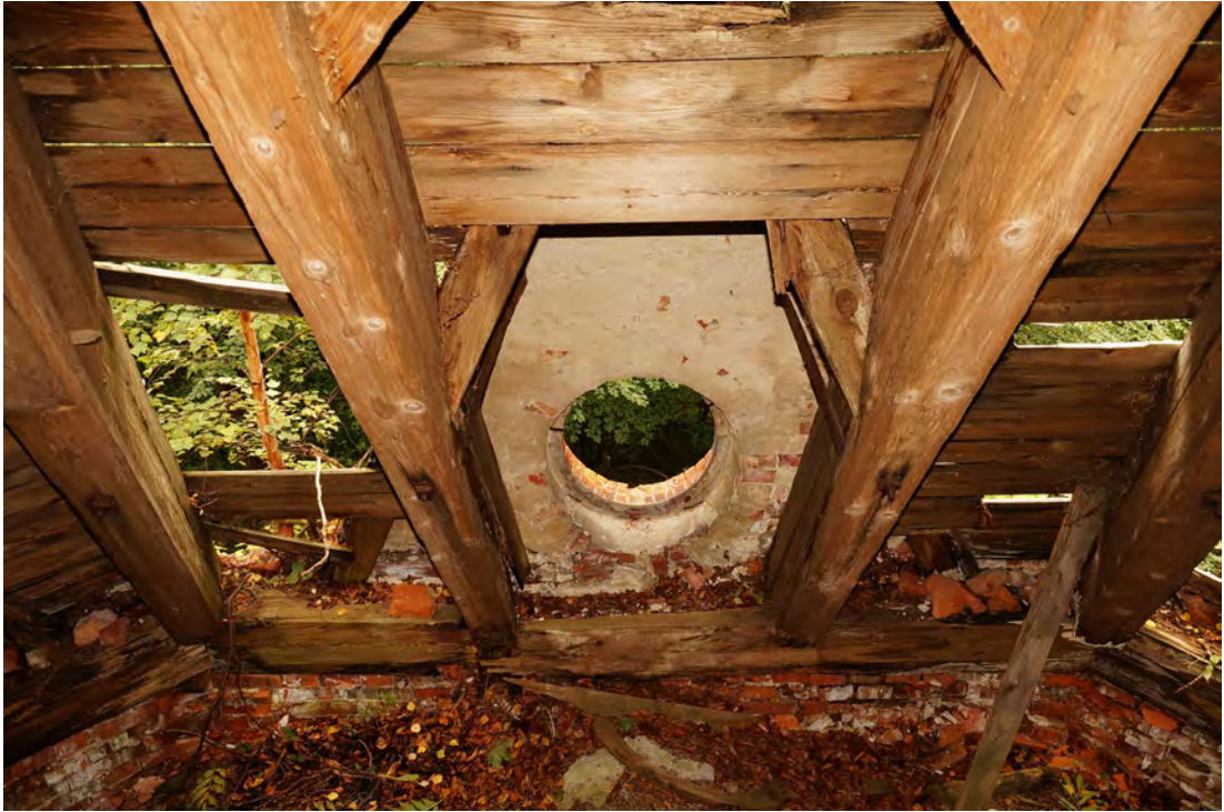
Abb. 390 Der untere Teil der Innenwandfläche E im Dachraum.
