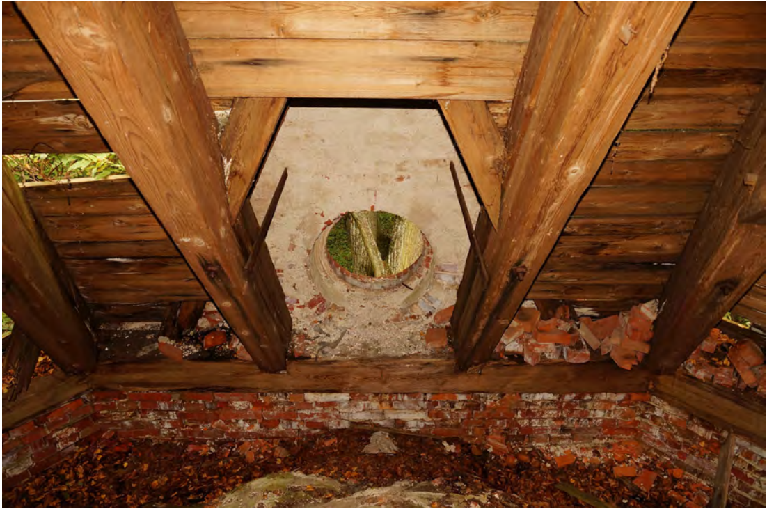
Abb. 386 Der untere Teil der Innenwandfläche C im Dachraum.
