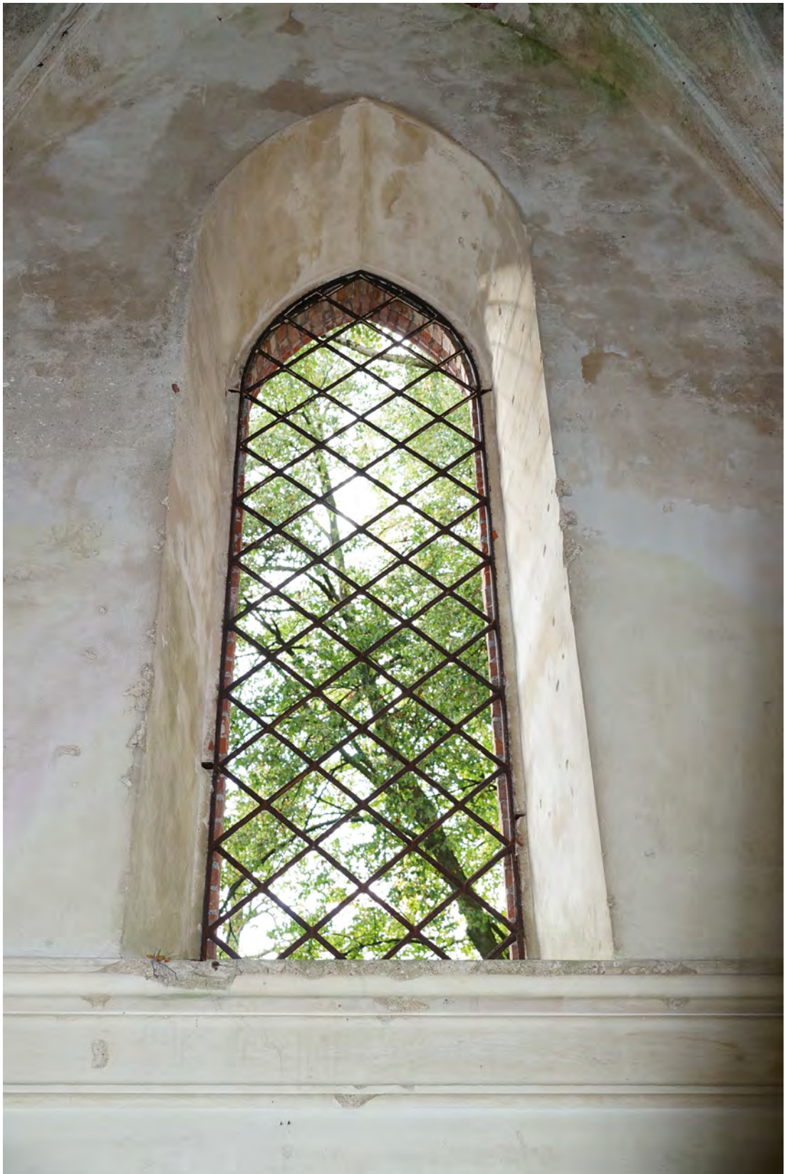
Abb. 369 Das Fenster der Innenwandfläche G.
