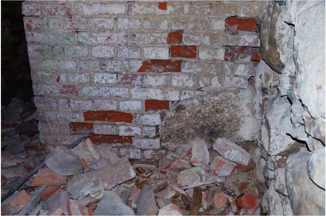
Abb. 258 Schäden am unteren Mauerwerk der Achse 04 c.
