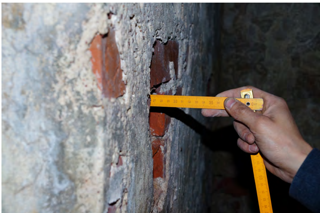
Abb. 287 Tiefe des unteren Loches an der Achse 06 c.
