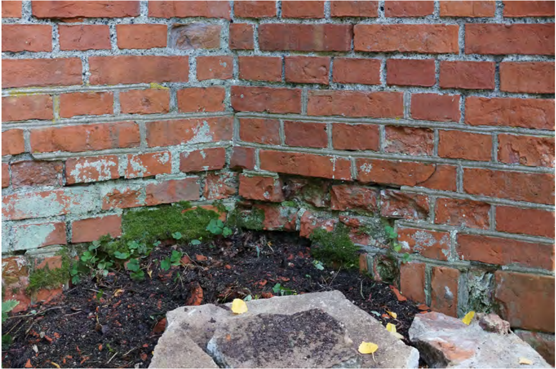
Abb. 48 Sockelbereich der Außenwandfläche A (rechts neben der Türöffnung).
