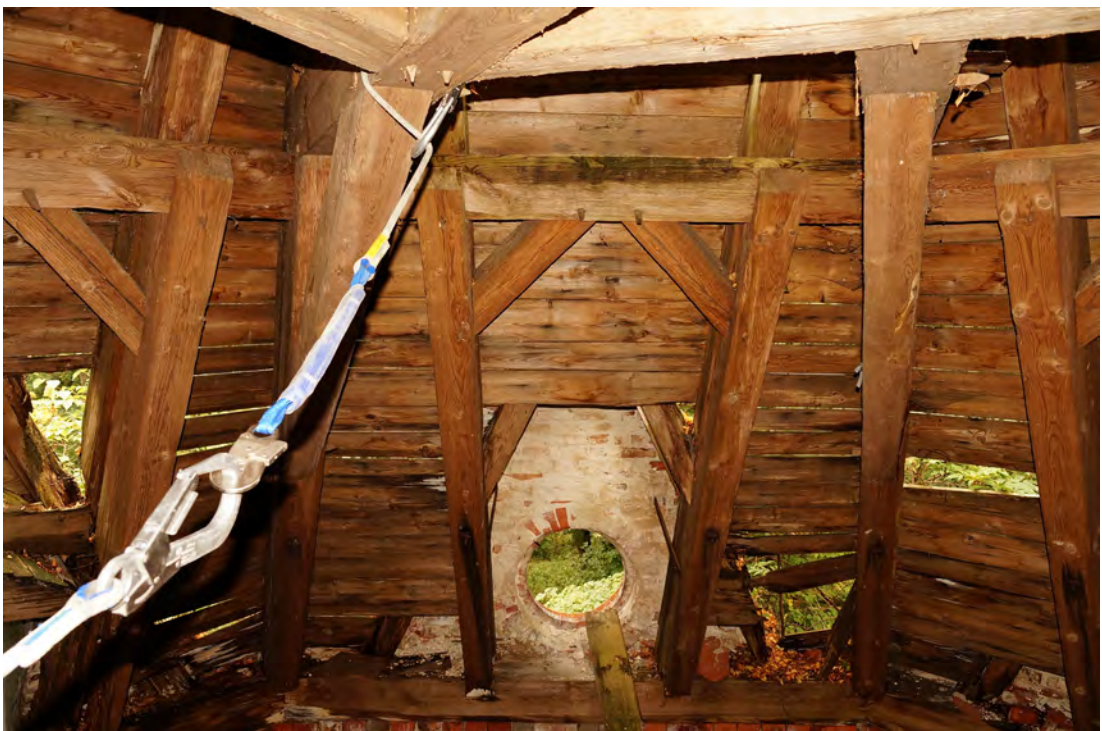
Abb. 385 Der obere Teil der Innenwandfläche B im Dachraum.
