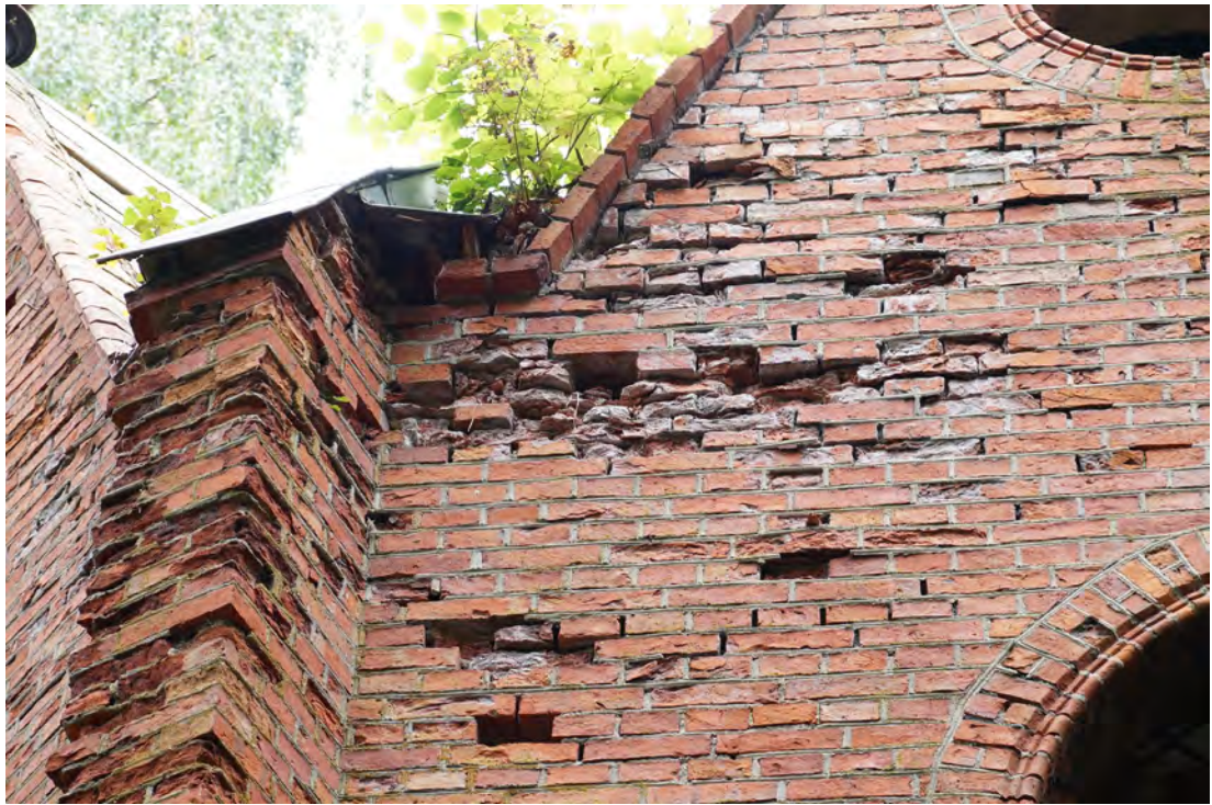
Abb. 160 Der Dachanschluss der Achse 06 a.
