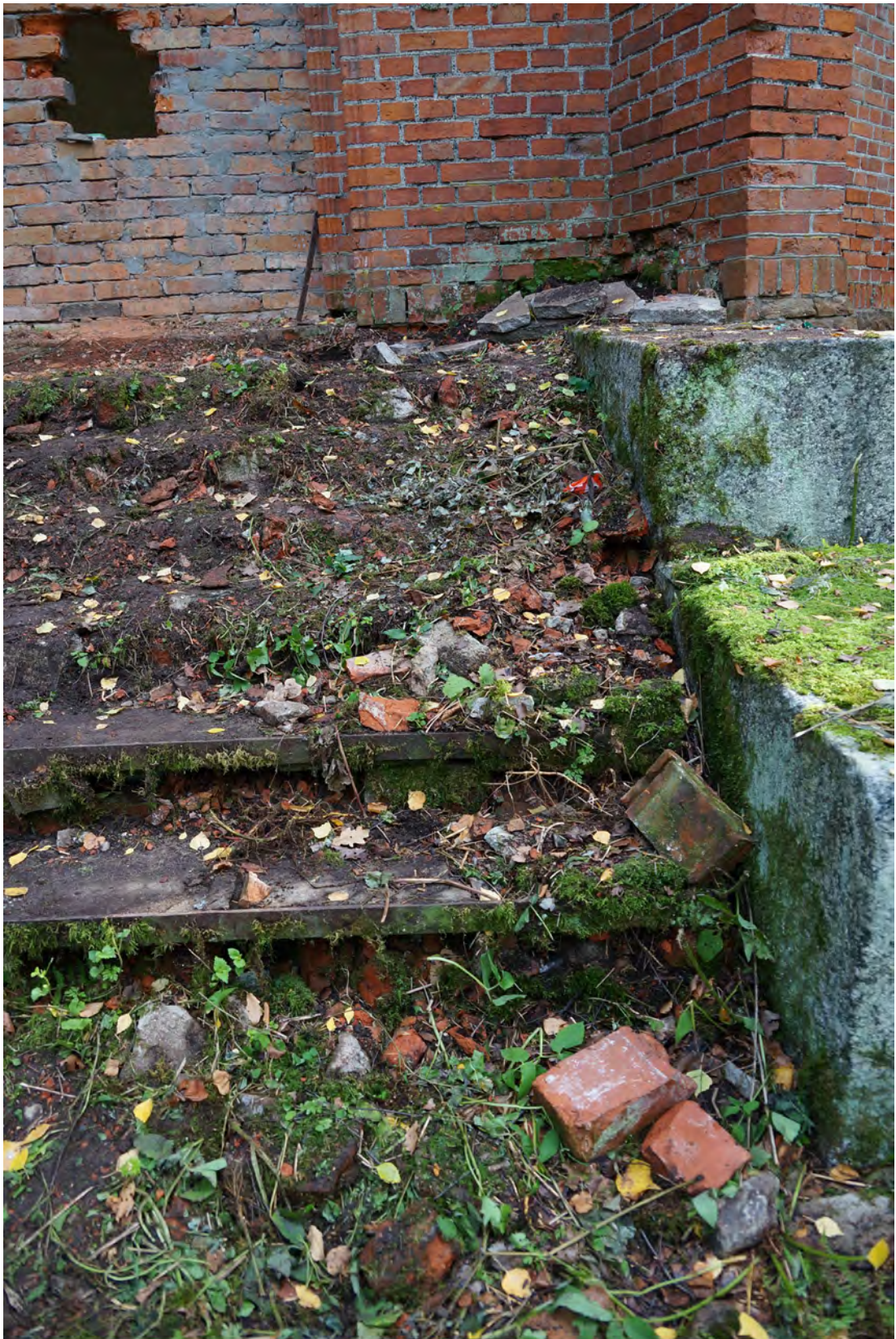
Abb. 57 Anschluss der Treppe der Seite A an die rechte Treppenwange.
