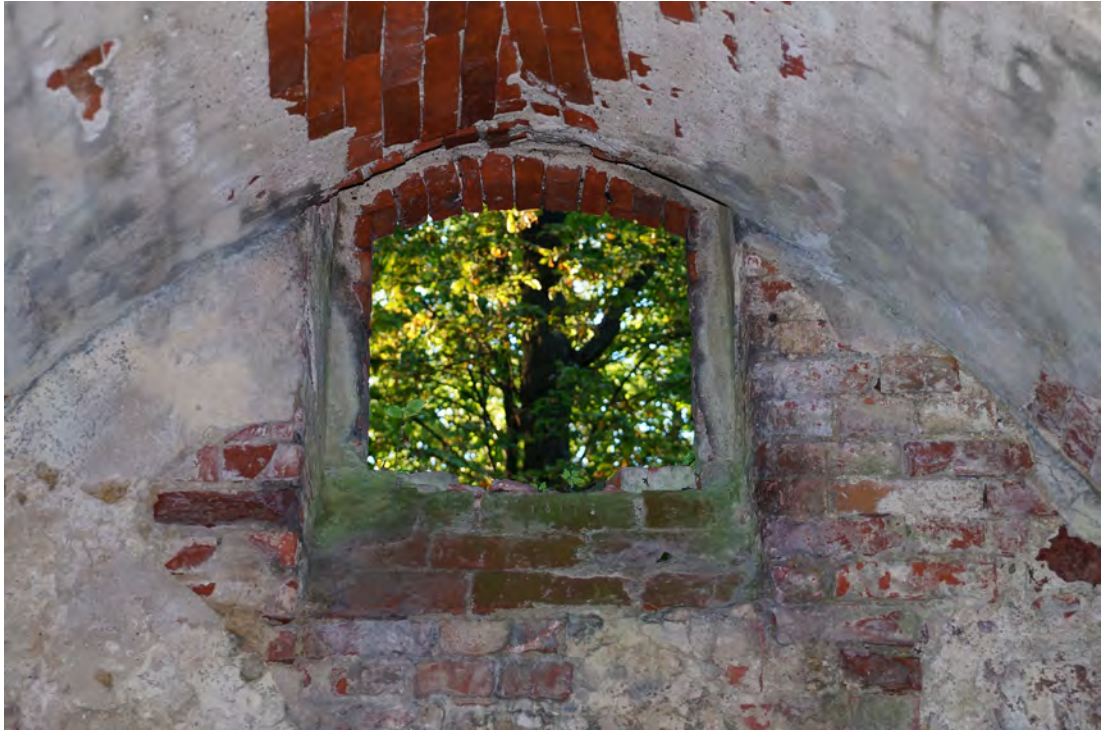
Abb. 321 Das Fenster der Innenwandfläche H.
