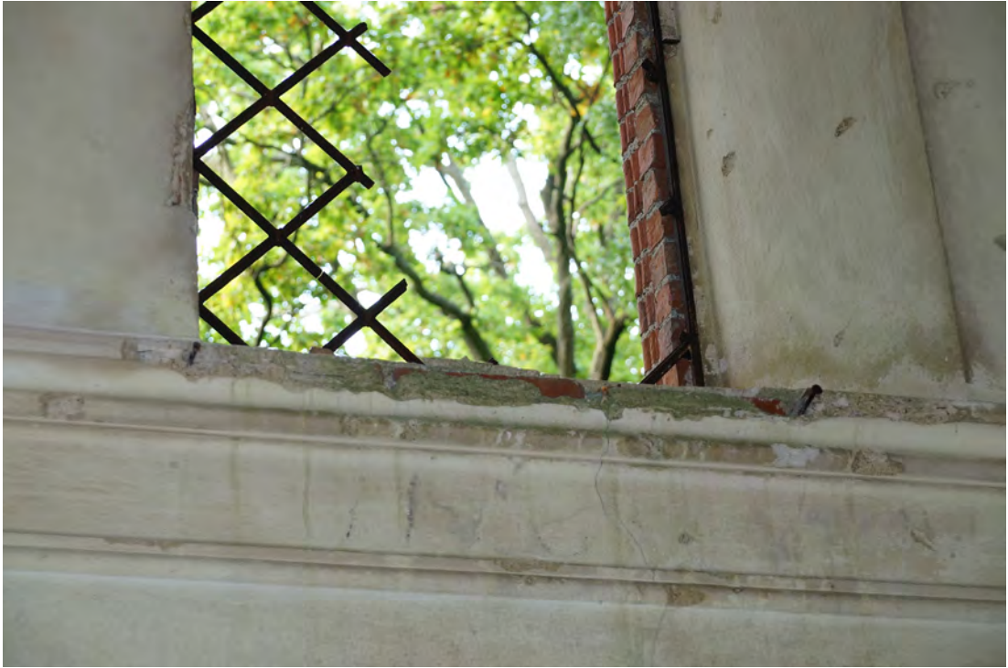
Abb. 375 Das Fensterbrett des Fensters der Innenwandfläche H.
