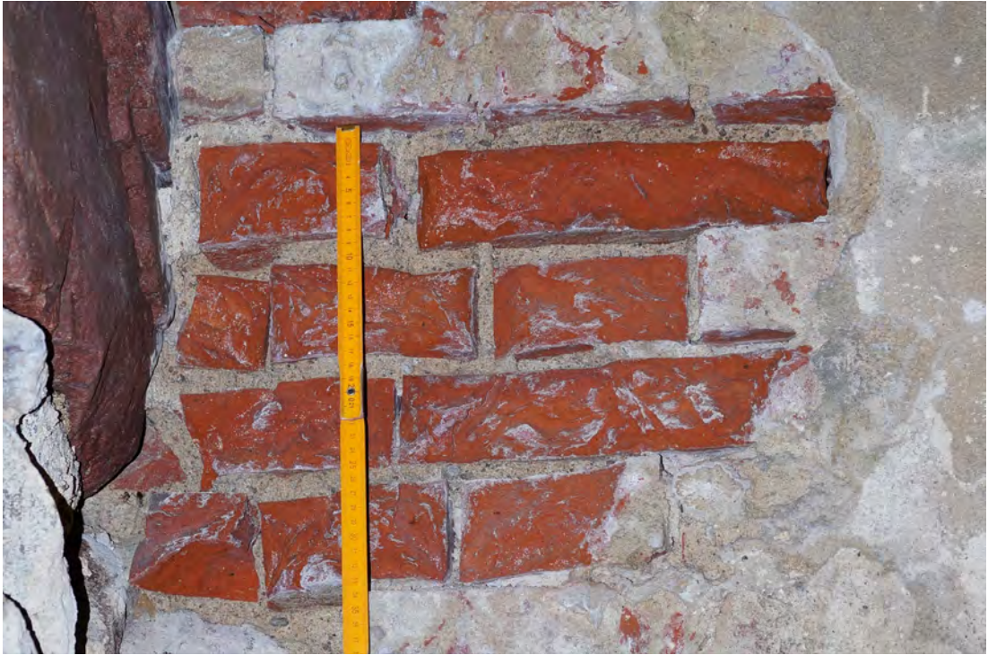
Abb. 253 Maße der Ziegel und Höhe der Schadstelle im hinteren, mittleren Bereich der Achse 04 a.
