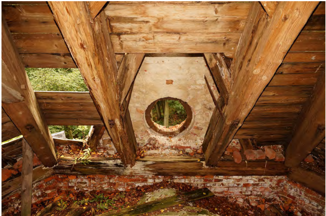
Abb. 392 Der untere Teil der Innenwandfläche F im Dachraum.
