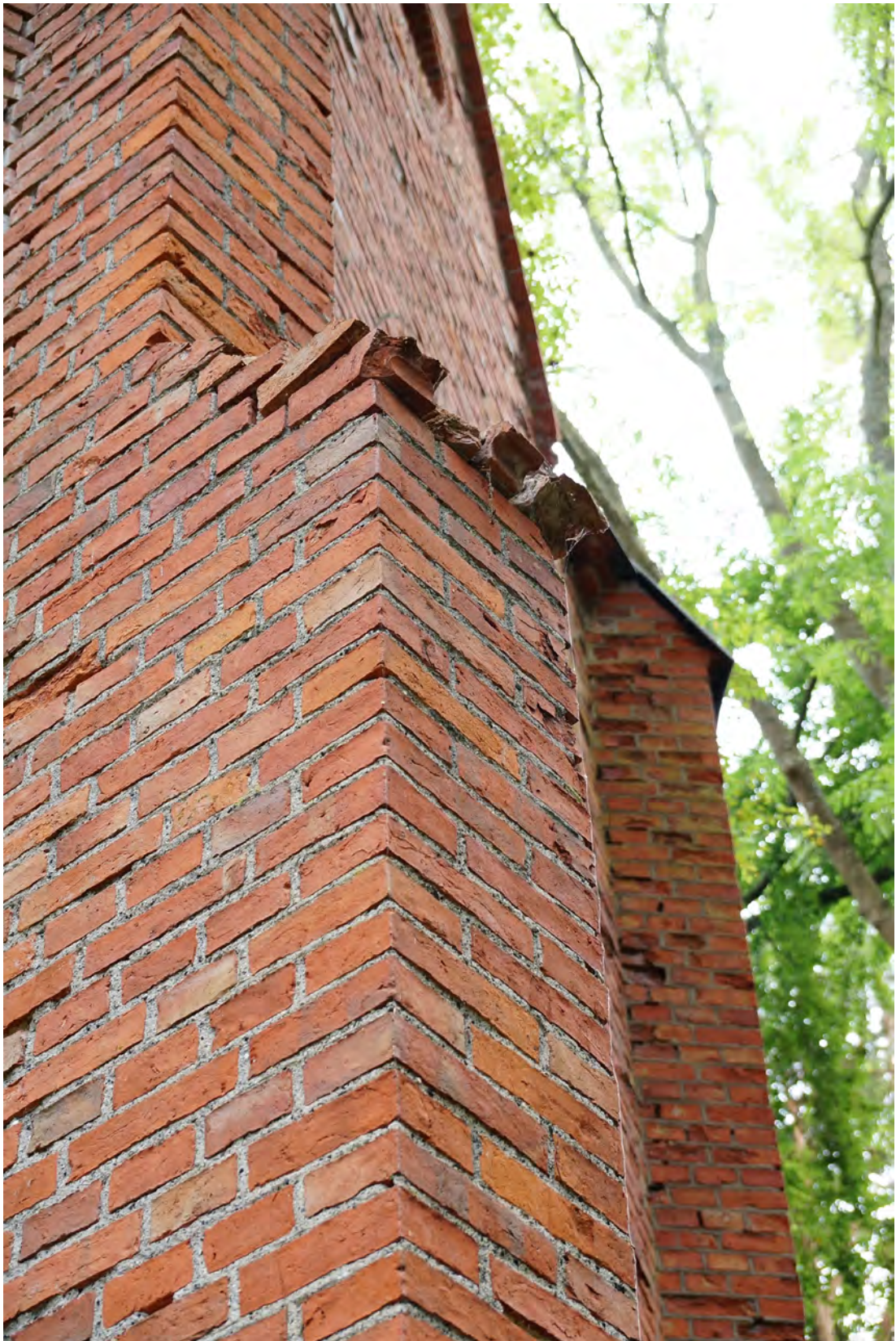
Abb. 196 Der Mauerwerksvorsprung an der Achse 08 c.
