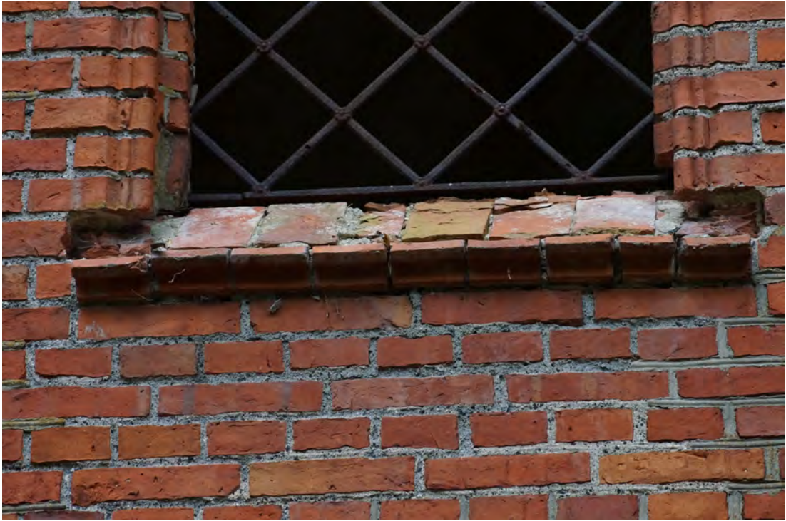
Abb. 166 Die Fensterbank des großen Fensters in der Mitte der Außenwandfläche F.
