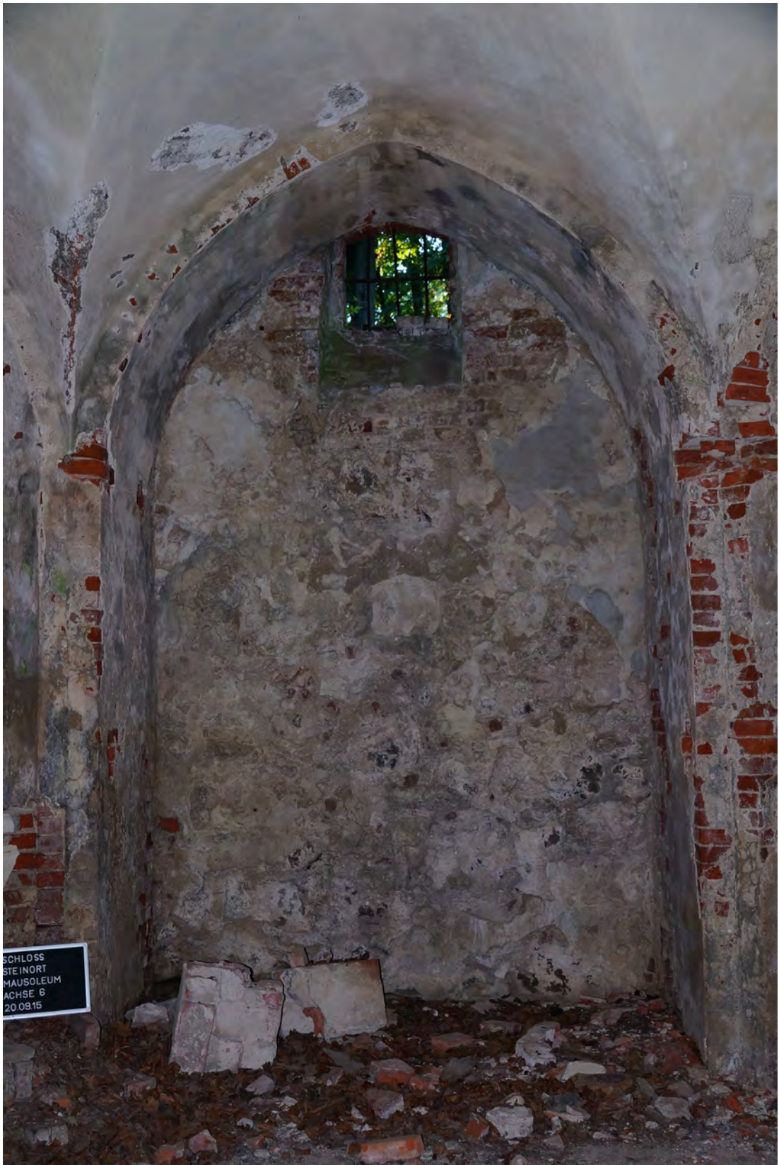
Abb. 290 Übersichtsfoto der Innenwandfläche F.
