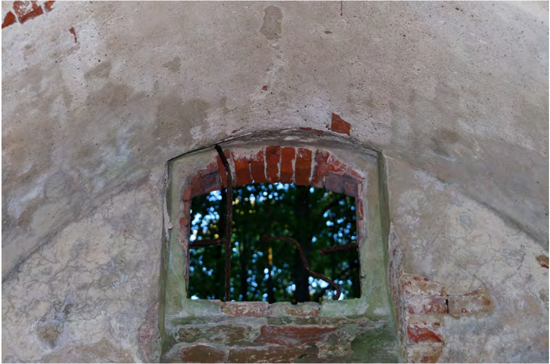
Abb. 262 Das Fenster der Innenwandfläche D.
