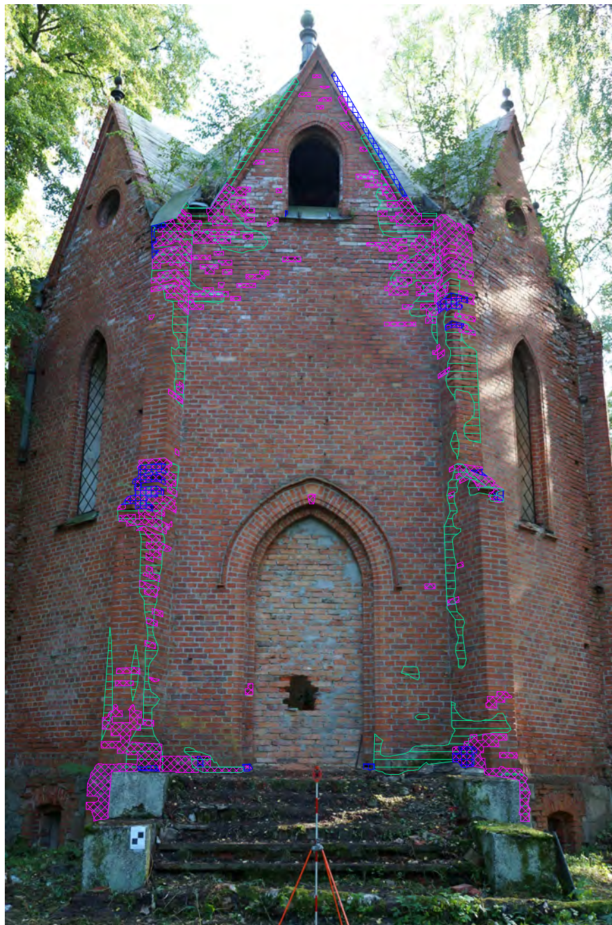
Abb. 445 Schadenskartierung der Außenwandfläche A.
