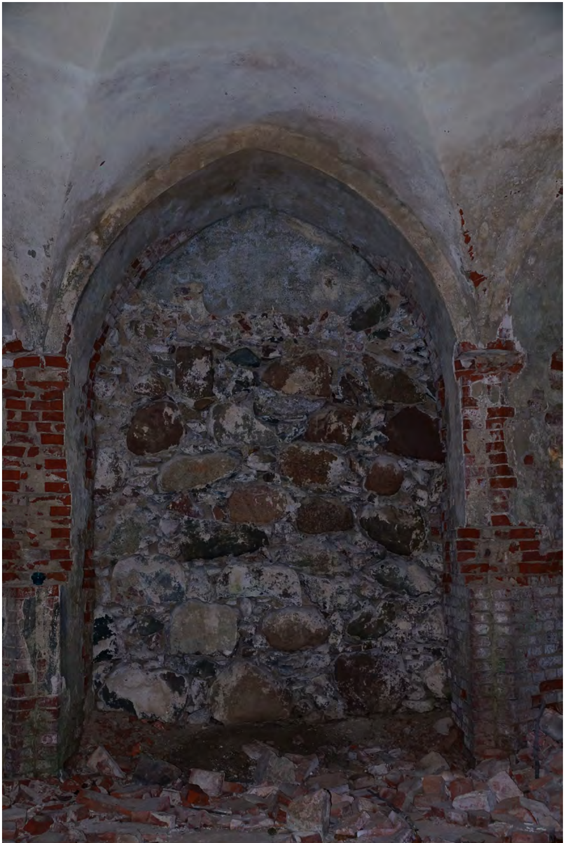
Abb. 247 Übersichtsfoto der Innenwandfläche C.
