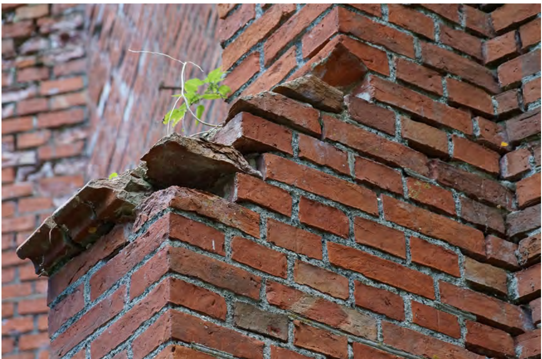
Abb. 35 Mauerwerksvorsprung der Achse 01 a.
