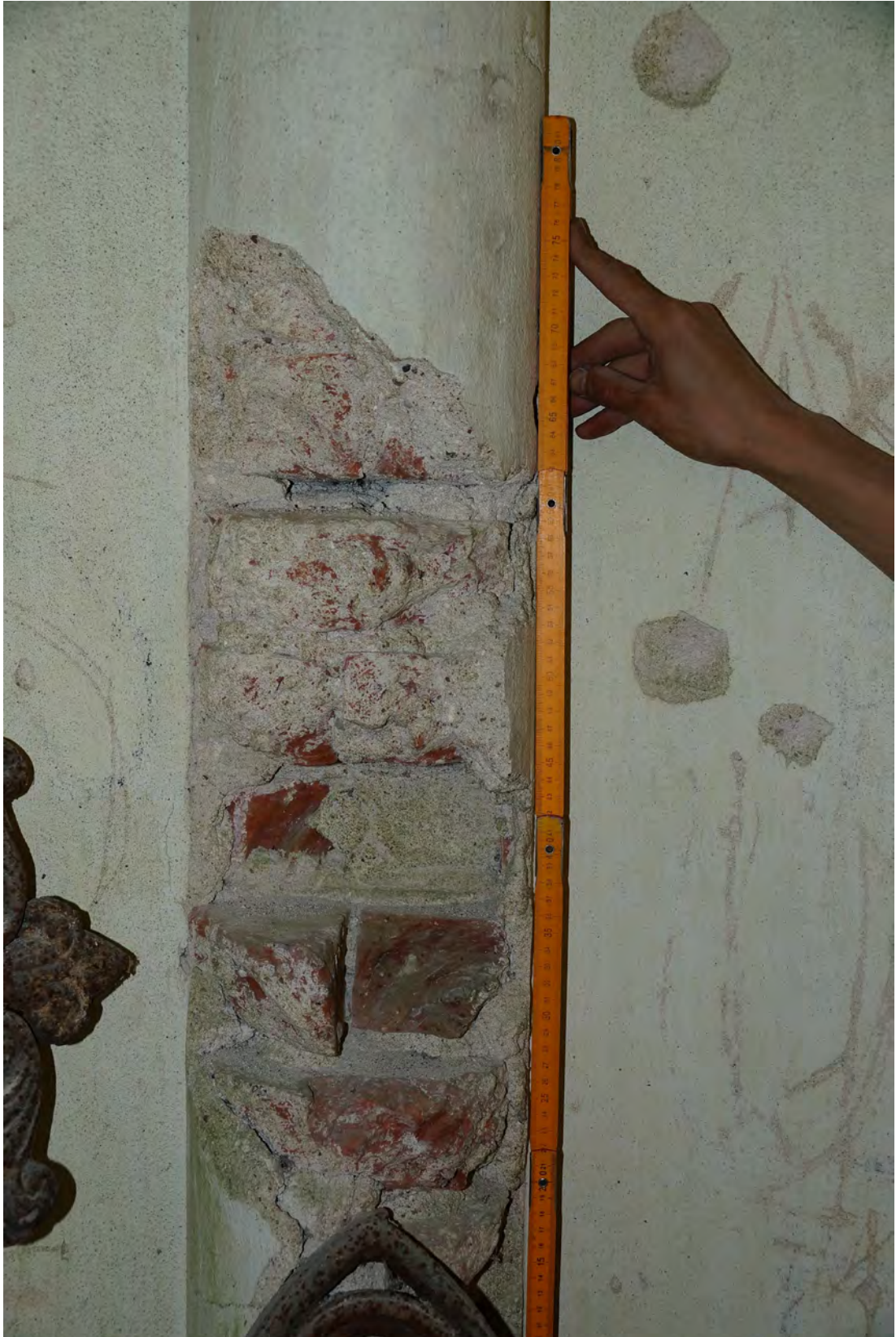
Abb. 374 Schäden im unteren Bereich des Pilasters der Achse 08.
