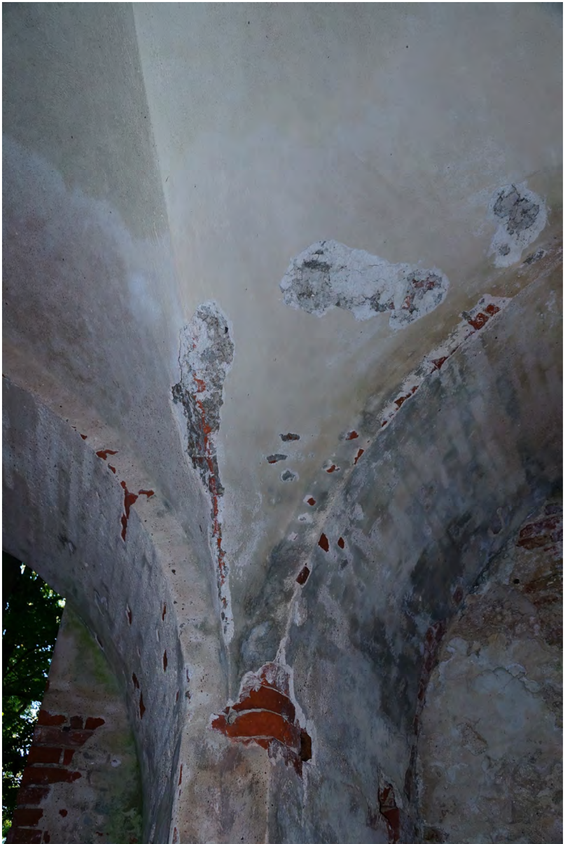
Abb. 284 Schäden am Widerlager der Achse 06 b und am Gewölbe darüber.
