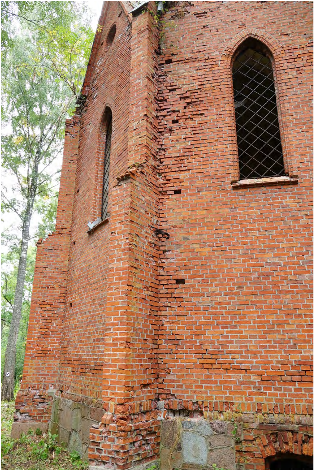
Abb. 173 Fugenauswaschungen und Schadstellen an der Achse 07 a.
