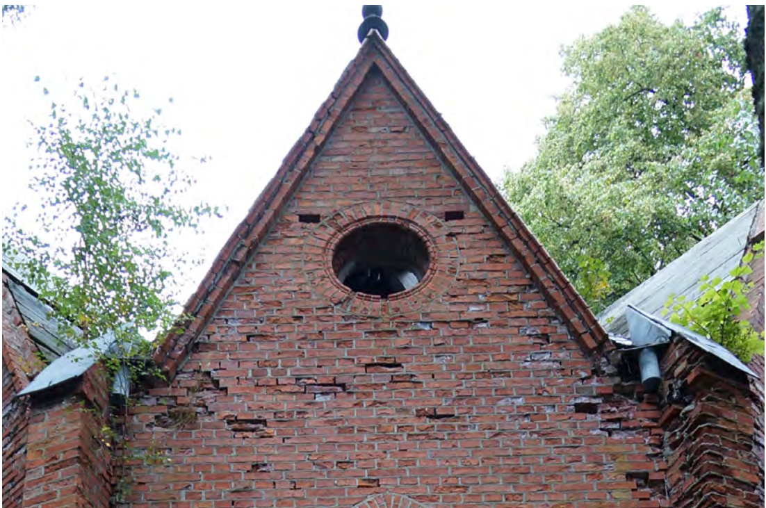
Abb. 169 Der Dachanschluss der Außenwandfläche F.
