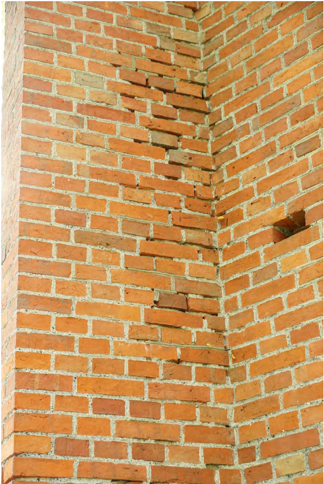
Abb. 114 Fugenauswaschungen im unteren Bereich der Achse 04 a.
