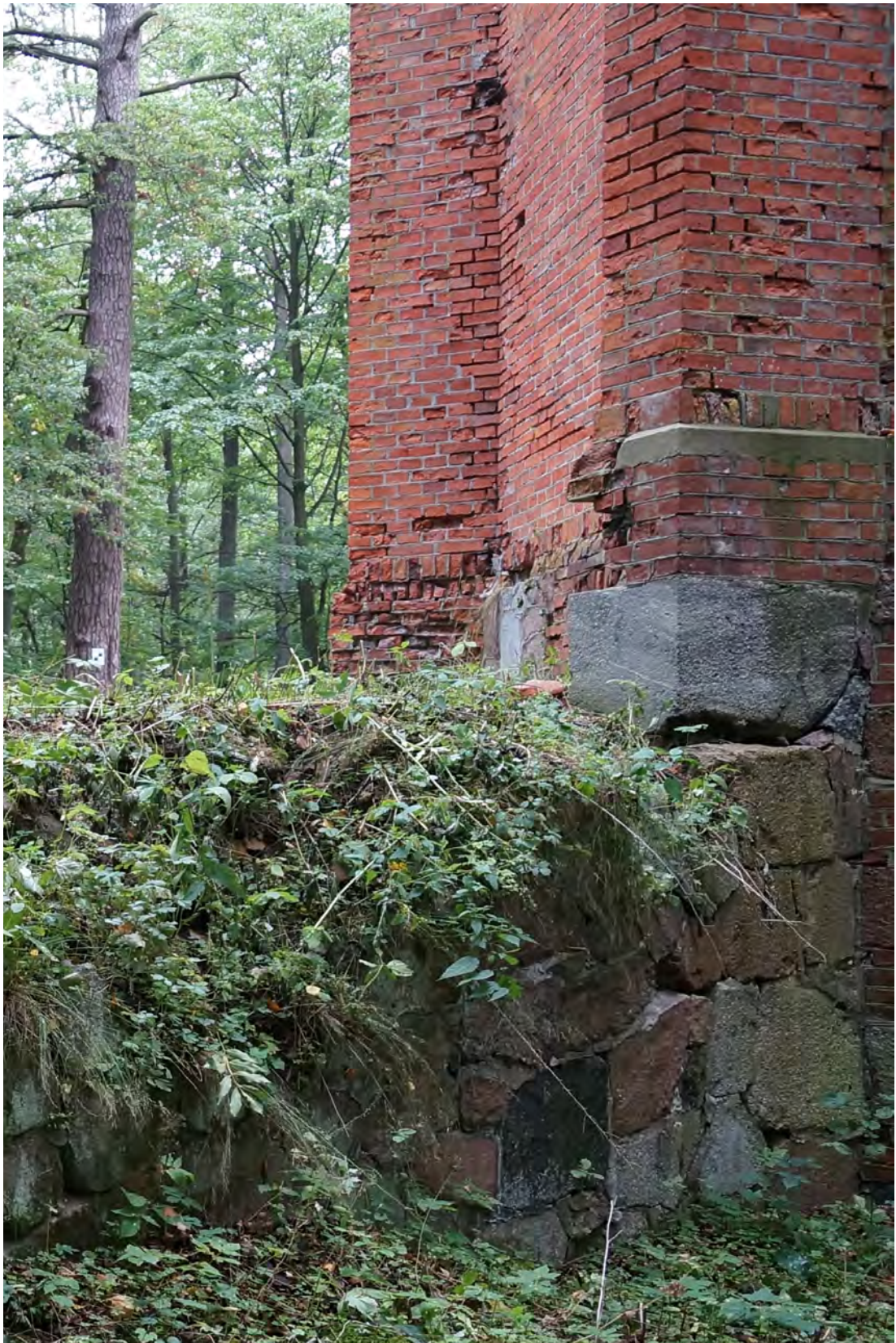
Abb. 154 Der Sockelbereich der Achse 06 a.
