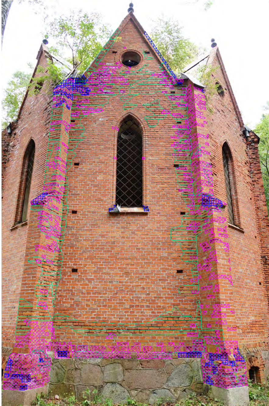
Abb. 452 Schadenskartierung der Außenwandfläche G.
