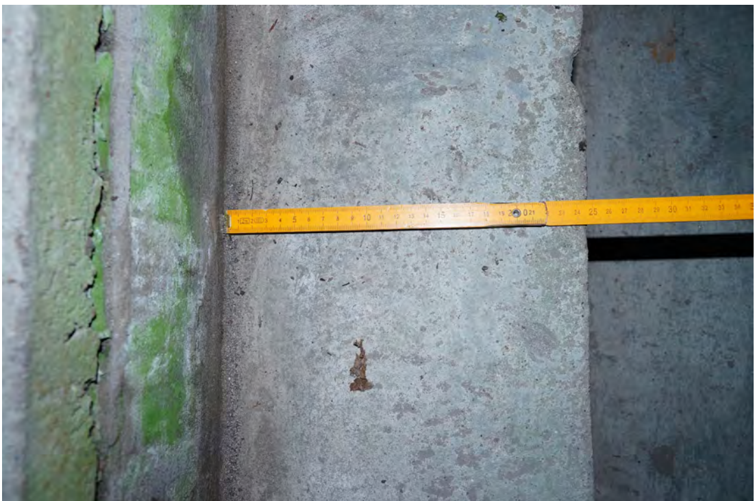
Abb. 273 Auftritt der Treppenstufen.
