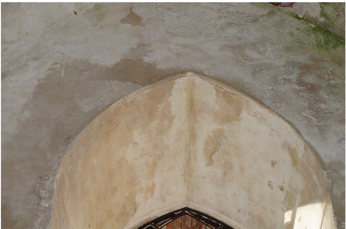
Abb. 371 Die Schäden am Spitzbogen des Fensters der Innenwandfläche G.
