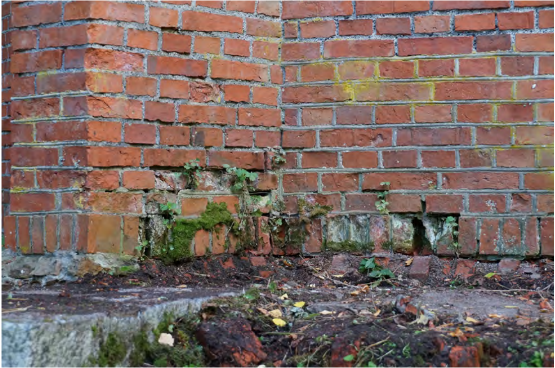
Abb. 46 Sockelbereich der Außenwandfläche A (links neben der Türöffnung).
