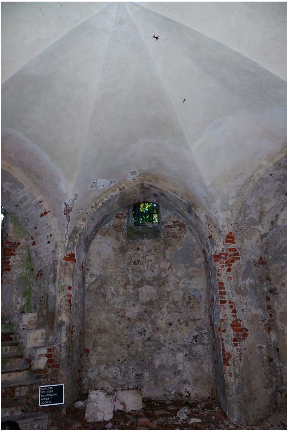
Abb. 289 Übersichtsfoto der Innenwandfläche F mit Gewölbe.
