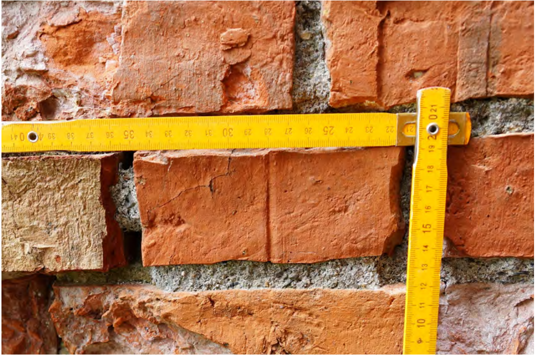
Abb. 410 Die Höhe und Tiefe des Formsteines des Typs S2 (in eingebauter Form).
