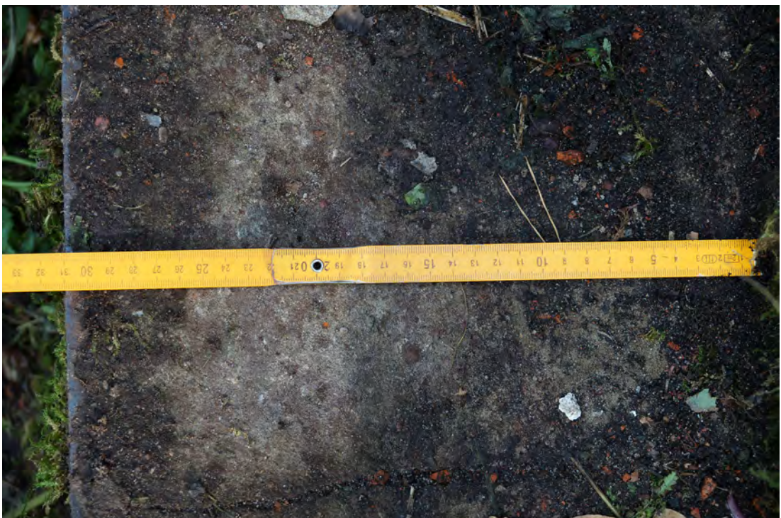
Abb. 54 Auftritt der Treppenstufe.
