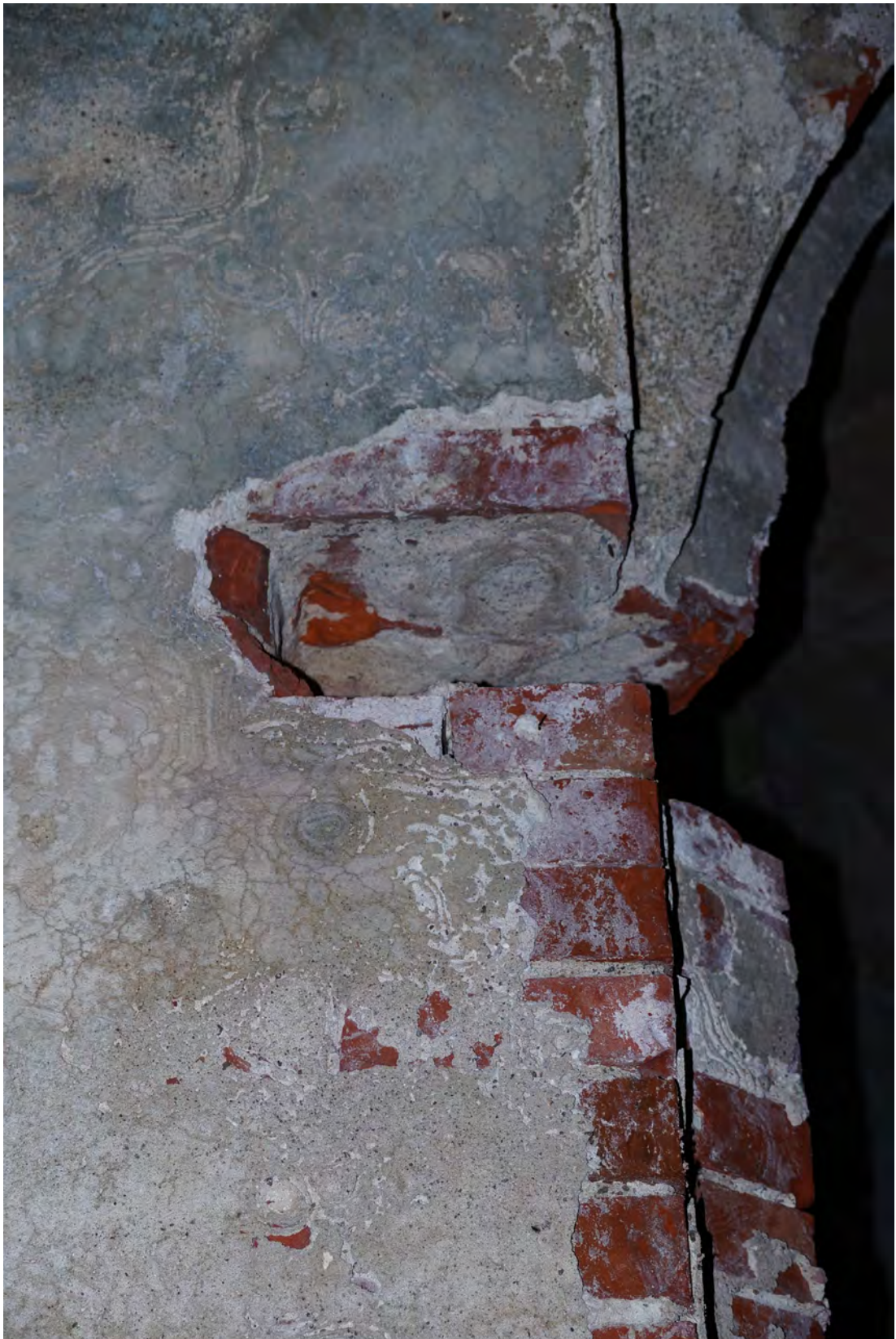
Abb. 255 Schäden am Mauerwerk des Widerlagers der Achse 04 a.
