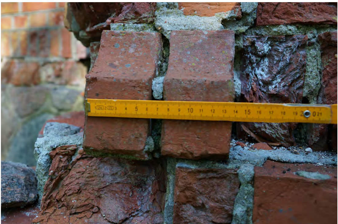
Abb. 416 Die Tiefe des Formsteines des Typs S4 (I).
