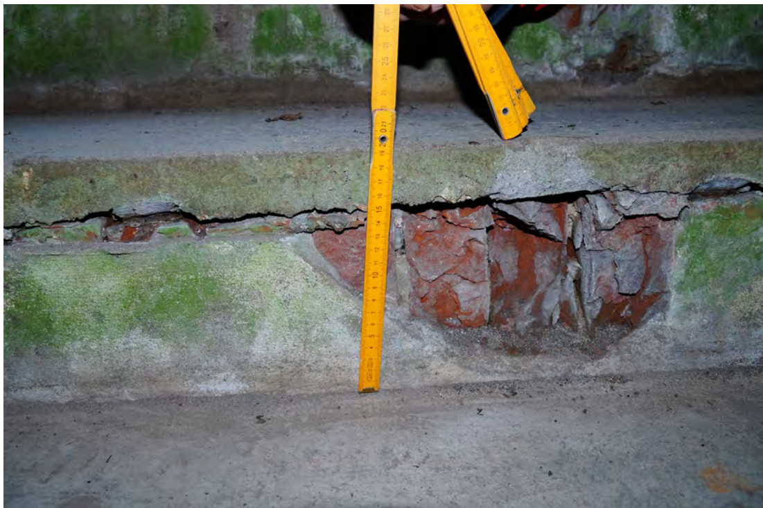
Abb. 274 Steigung der Treppenstufen.
