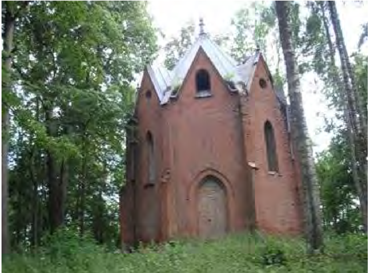
Abb. 7 Eingang der Kapelle, Bedachung vorhanden, Eingang verschlossen, links und rechts des Dacheinstiegs bereits Pflanzenbewuchs, Christuskreuz scheint zu fehlen.
