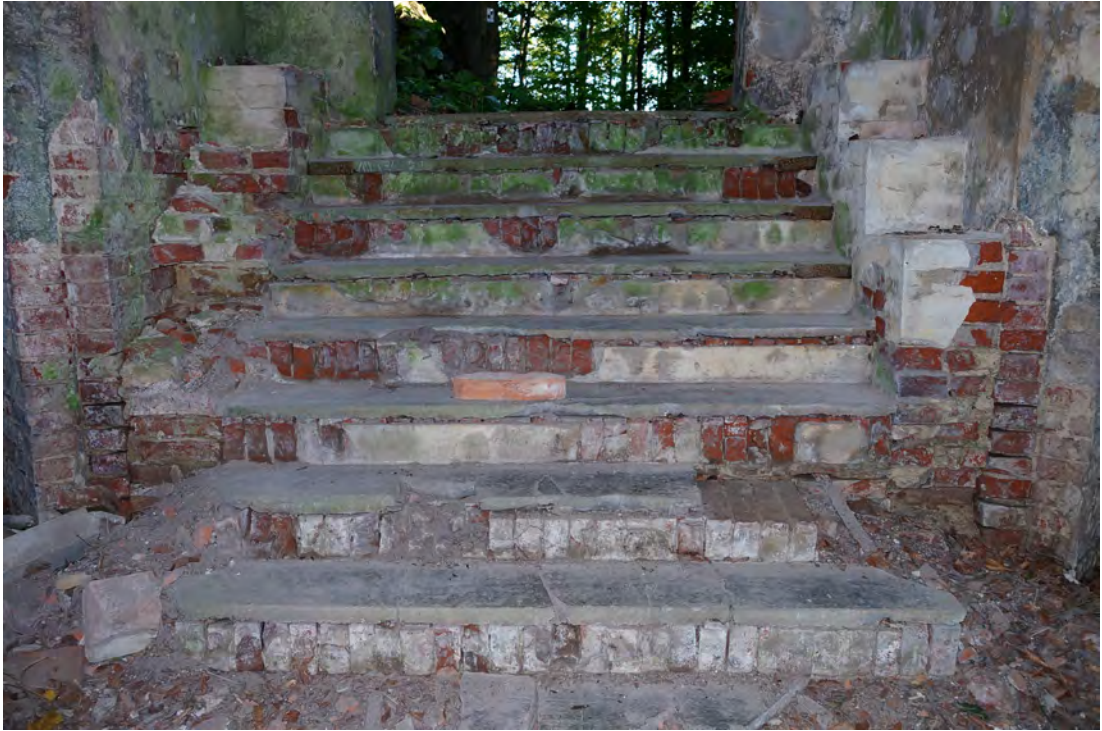
Abb. 291 Das Fenster der Innenwandfläche F.
