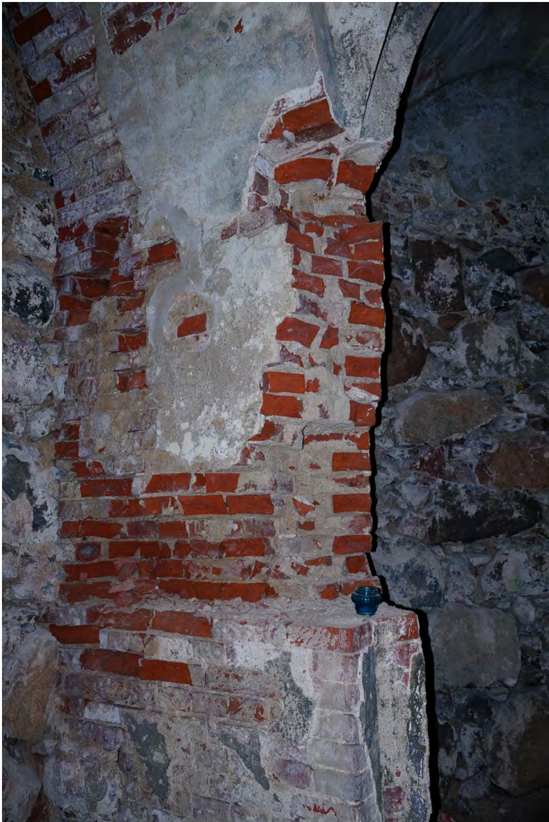
Abb. 239 Schäden im mittleren, oberen Bereich der Achse 03 a/b.
