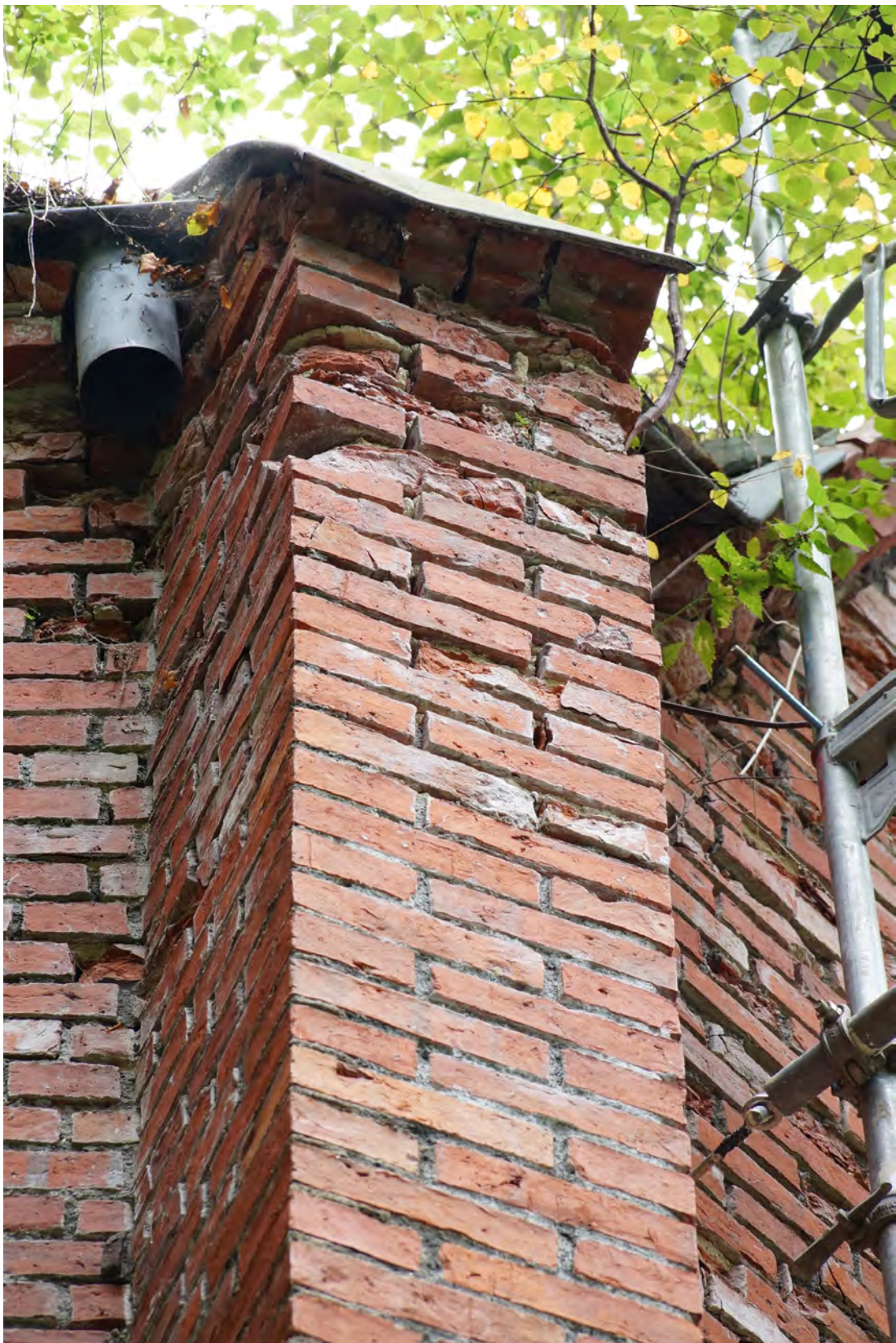
Abb. 78 Der Dachanschluss der Achse 02 b.
