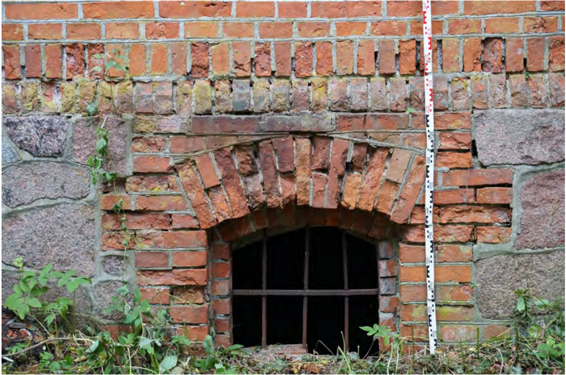
Abb. 163 Das untere Fenster im Sockelbereich der Außenwandfläche F.
