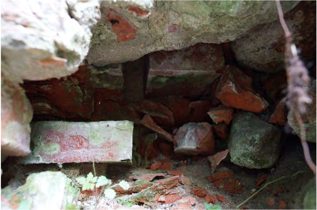
Abb. 65 Loch im Strebepfeiler der Achse 02 a am Übergang zur linken Treppenwange
