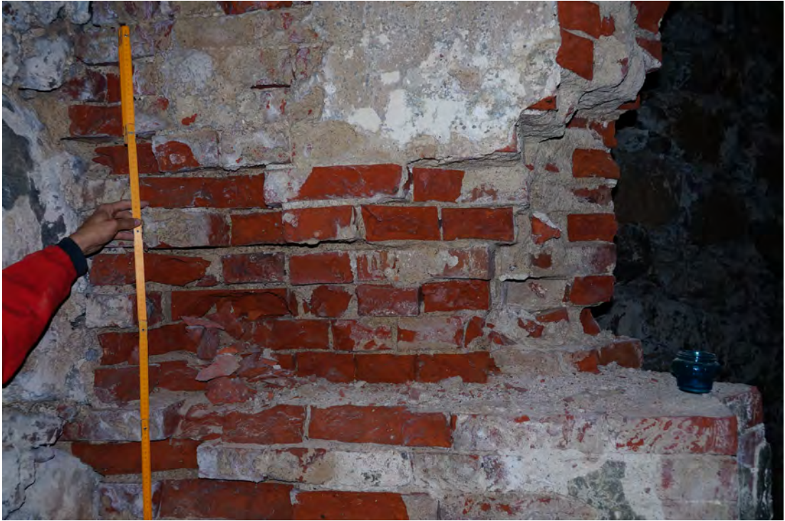
Abb. 238 Schäden im mittleren Bereich der Achse 03 a.
