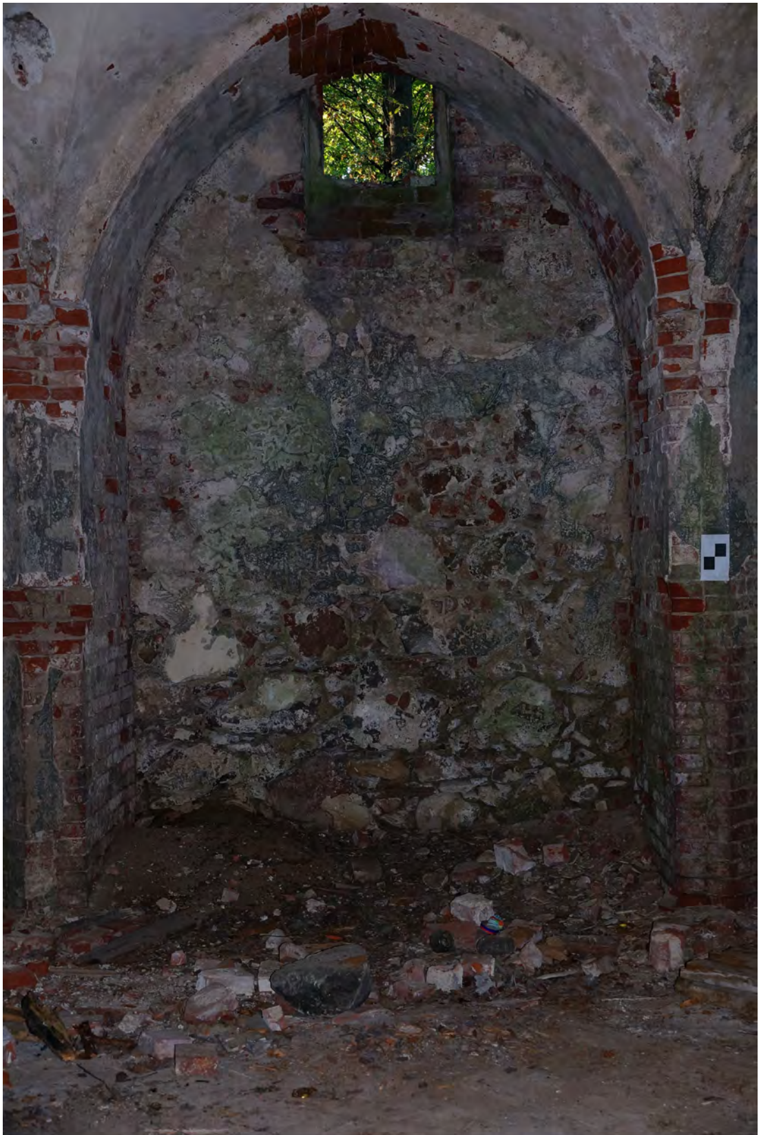
Abb. 320 Übersichtsfoto der Innenwandfläche H.
