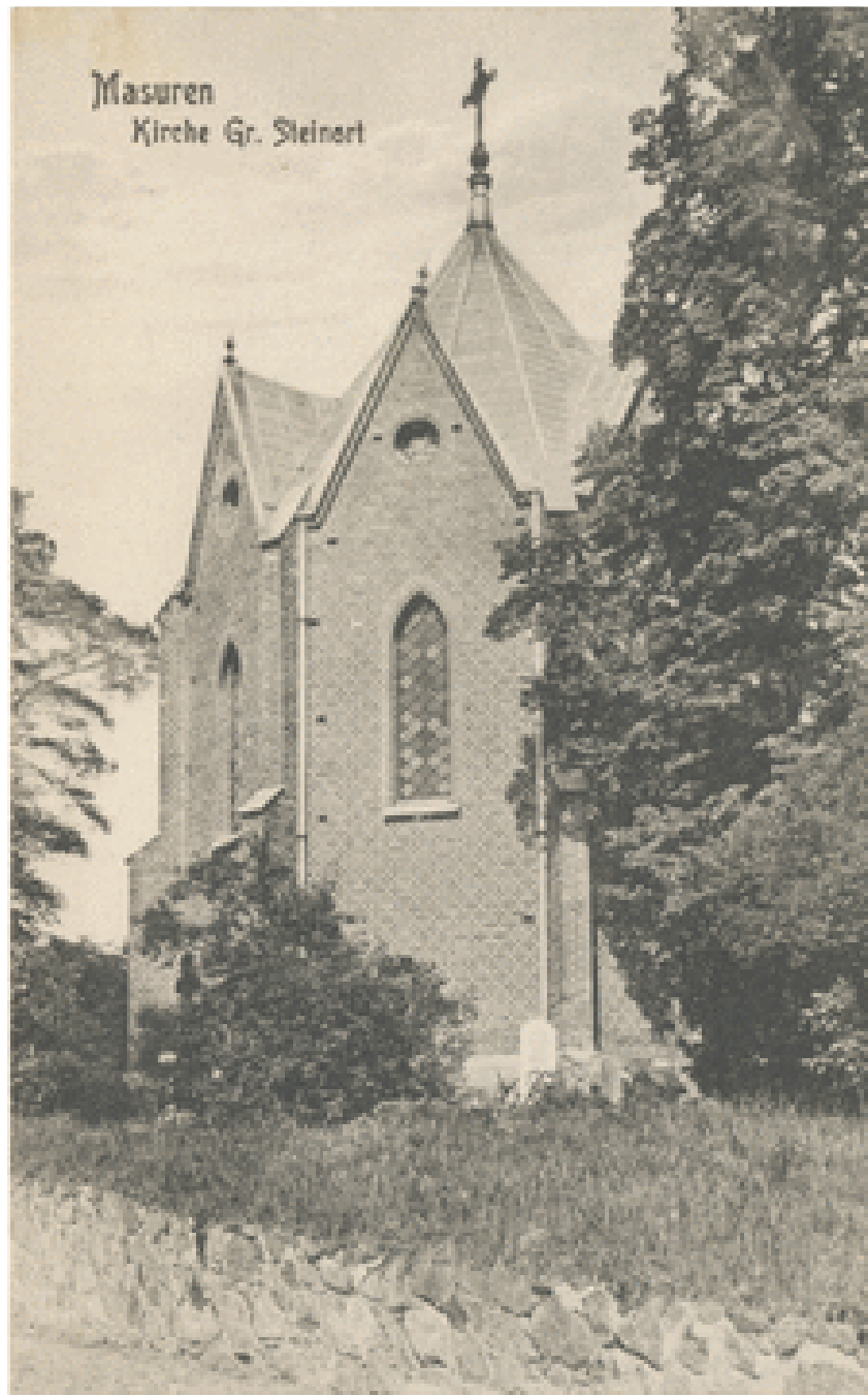
Abb. 5 Blick auf Kapelle, Natursteinmauerwerk im Vordergrund, Christuskreuz auf Dachspitze, vermutlich Aufnahme von Rückseite.
