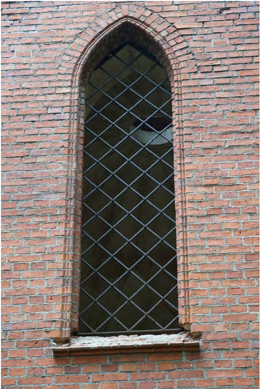
Abb. 118 Das große Fenster in der Mitte der Außenwandfläche D.
