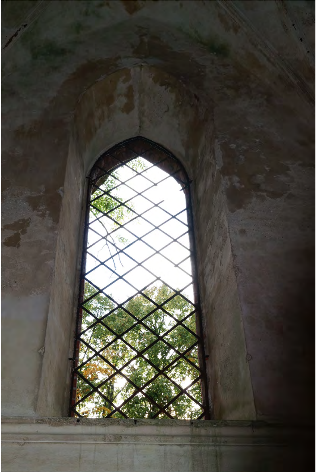
Abb. 360 Das Fenster der Innenwandfläche F.
