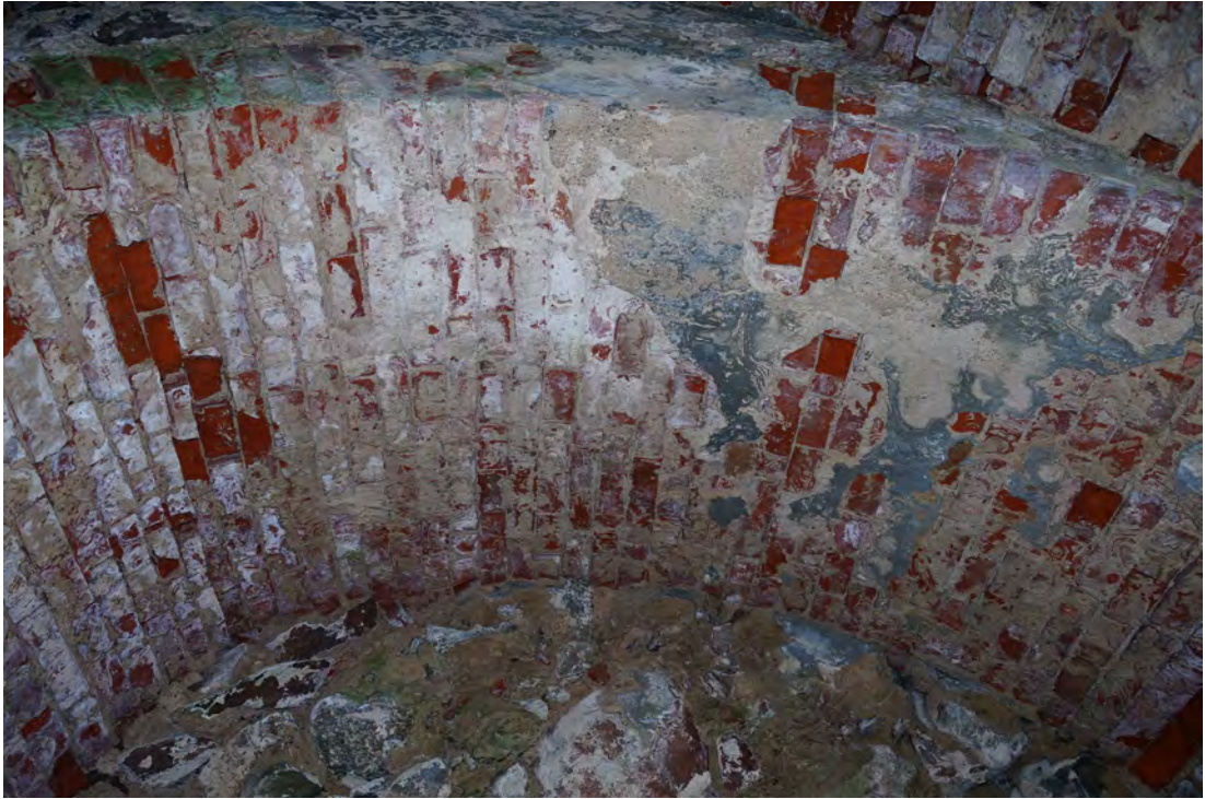
Abb. 220 Schäden am Mauerwerk des Scheitelpunktes des inneren Spitzbogens.
