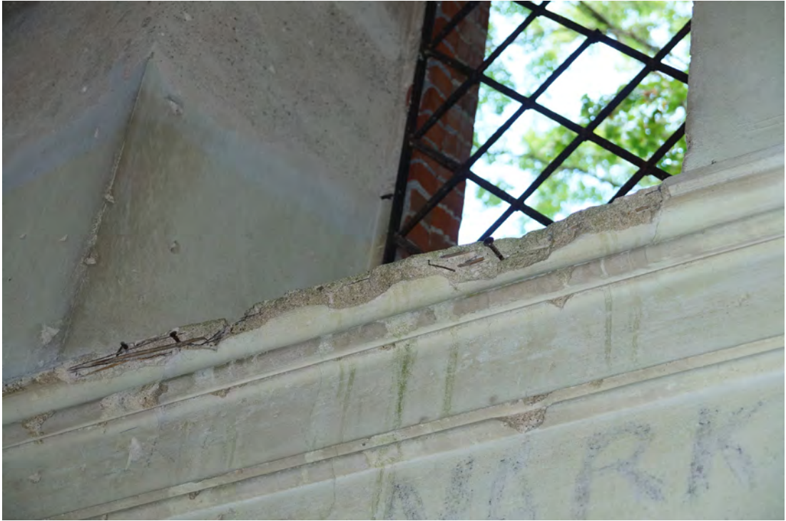
Abb. 335 Das Fensterbrett des Fensters der Innenwandfläche B.
