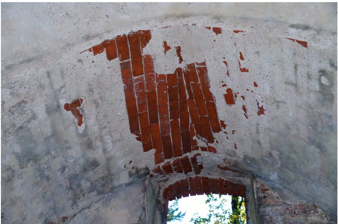
Abb. 322 Der Scheitelpunkt des Spitzbogens der Innenwandfläche H.
