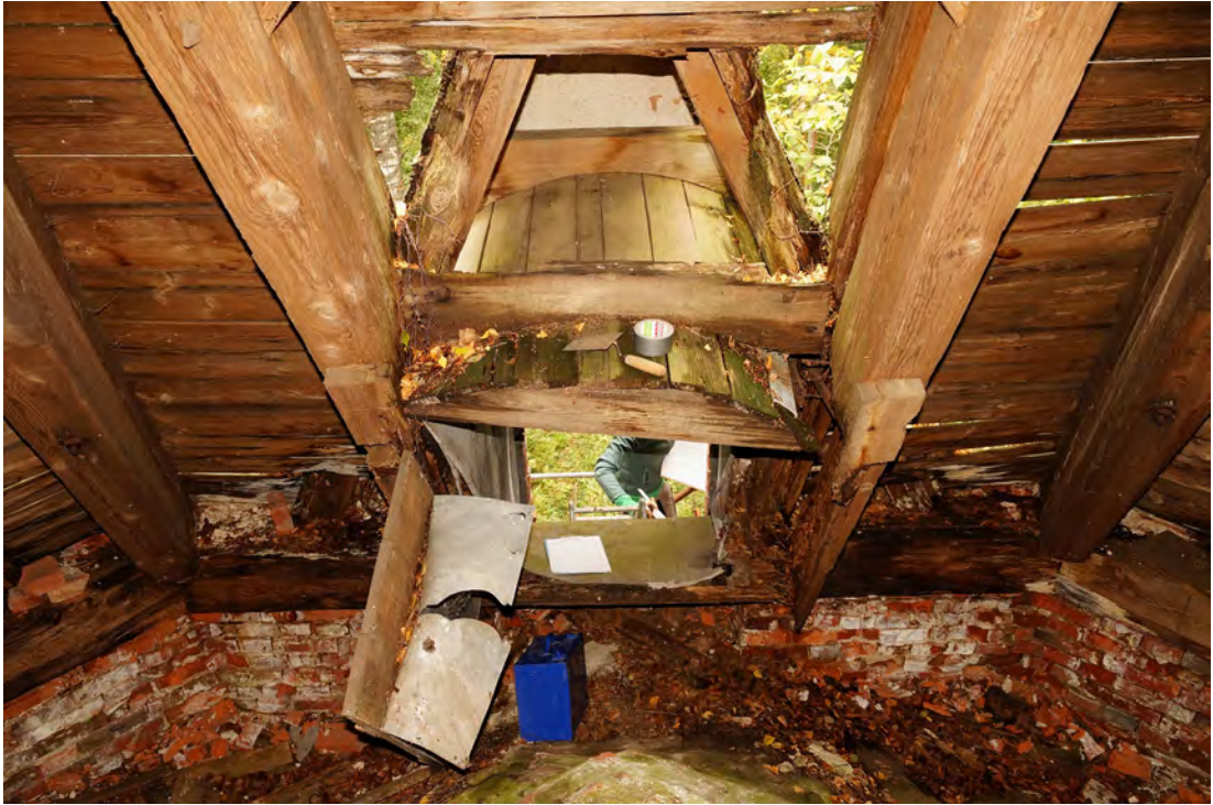
Abb. 382 Der untere Teil der Innenwandfläche A im Dachraum.
