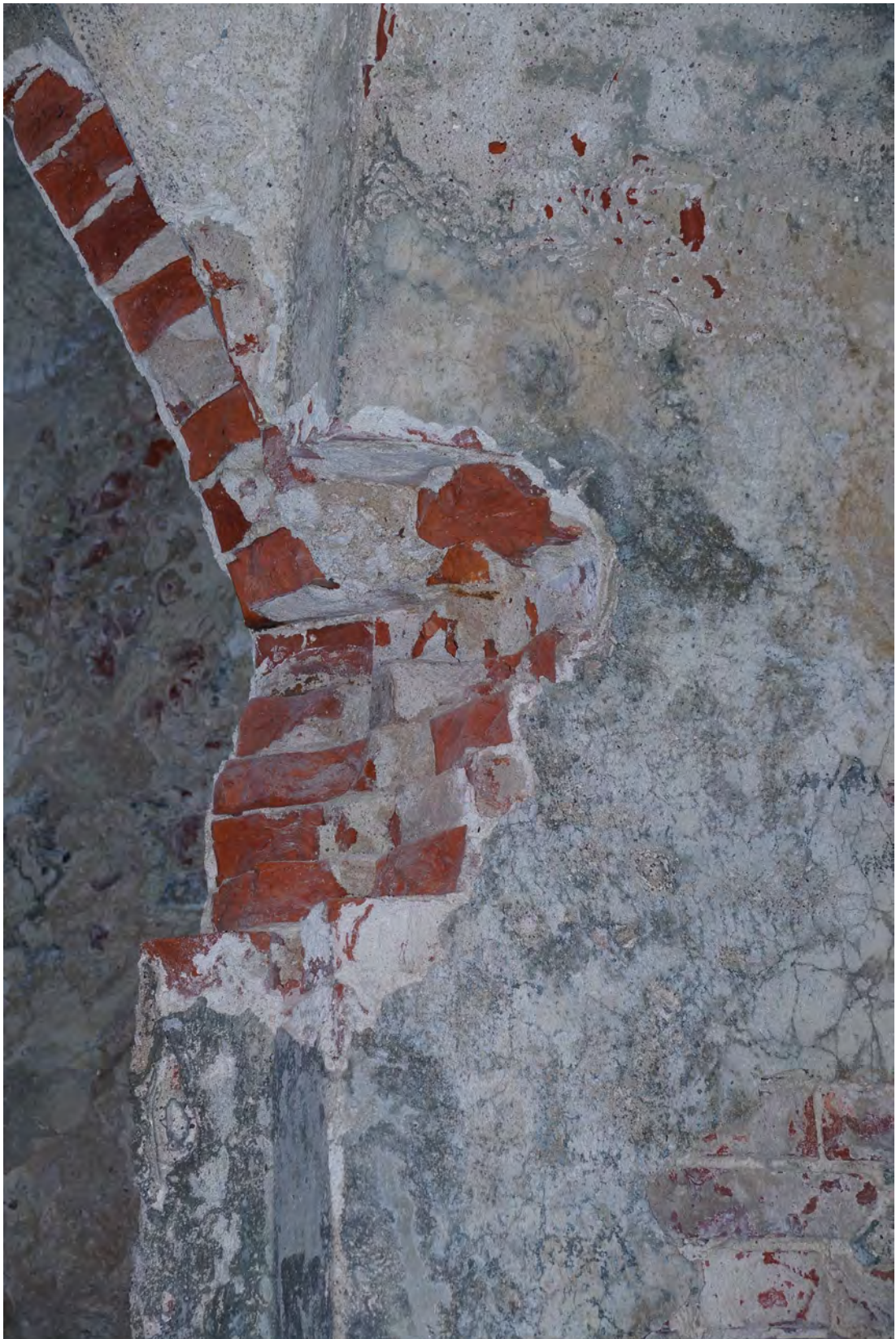
Abb. 316 Schäden am Mauerwerk des Widerlagers der Achse 08 c.
