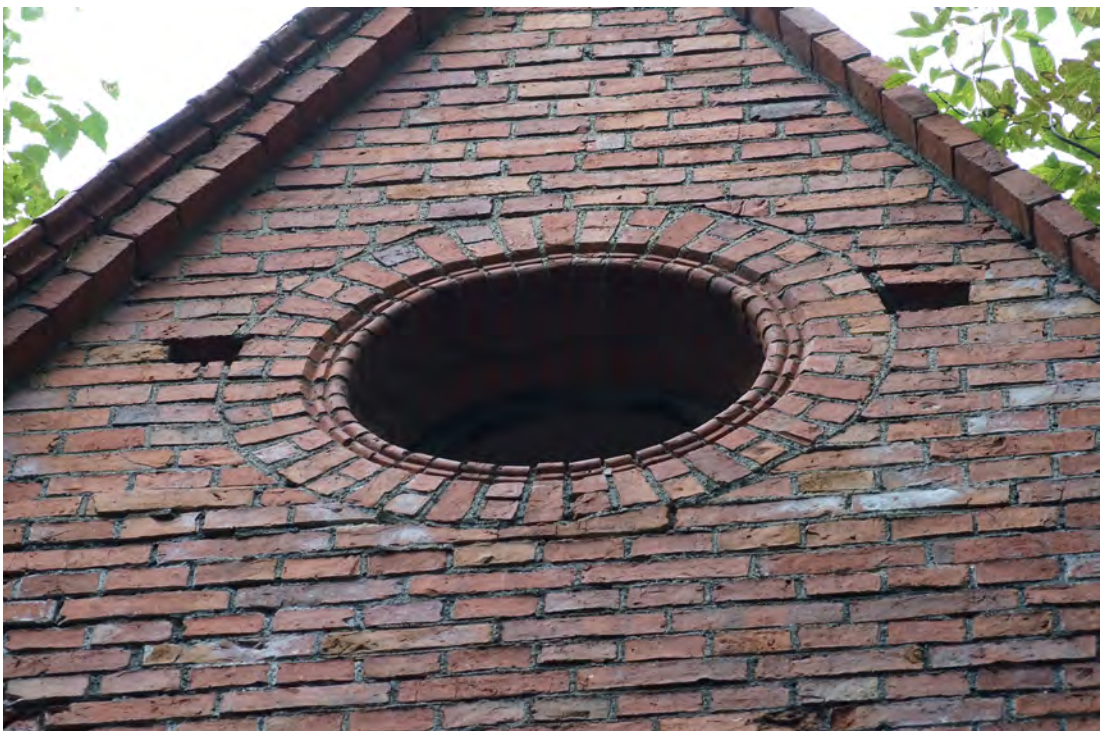
Abb. 120 Das Dachfenster der Außenwandfläche D.
