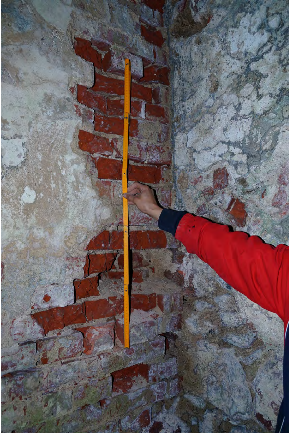
Abb. 227 Schäden am Mauerwerk im mittleren Bereich der Achse 02 c.
