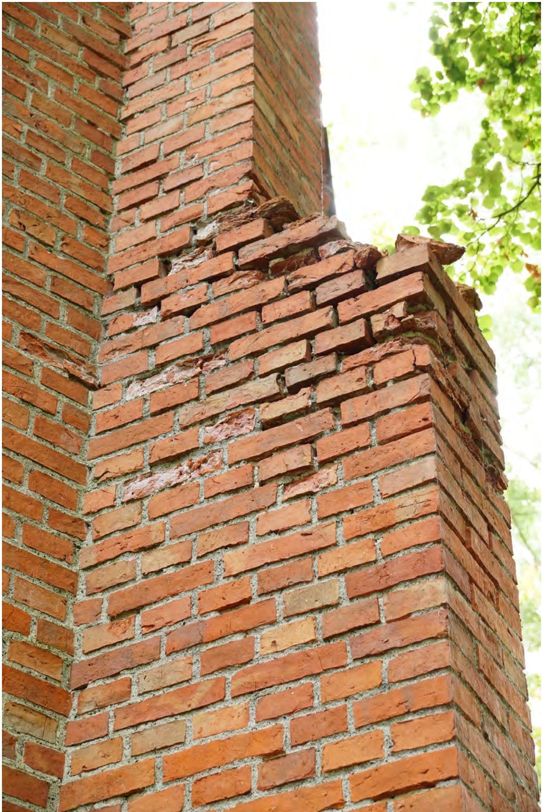
Abb. 95 Der Mauerwerksvorsprung der Achse 03 c.
