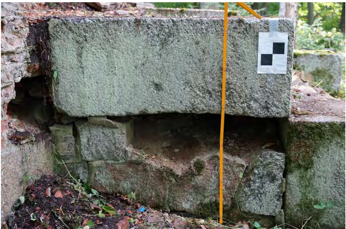
Abb. 60 Die Höhe der Treppenwangen (hier: linke Treppenwange).
