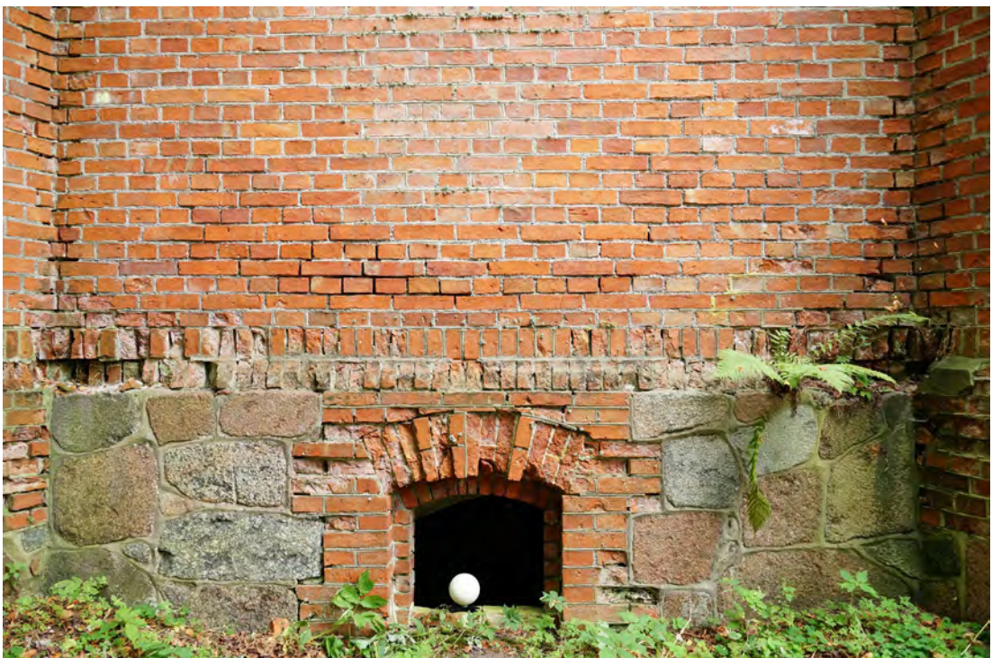
Abb. 82 Der Sockelbereich der Außenwandfläche B.
