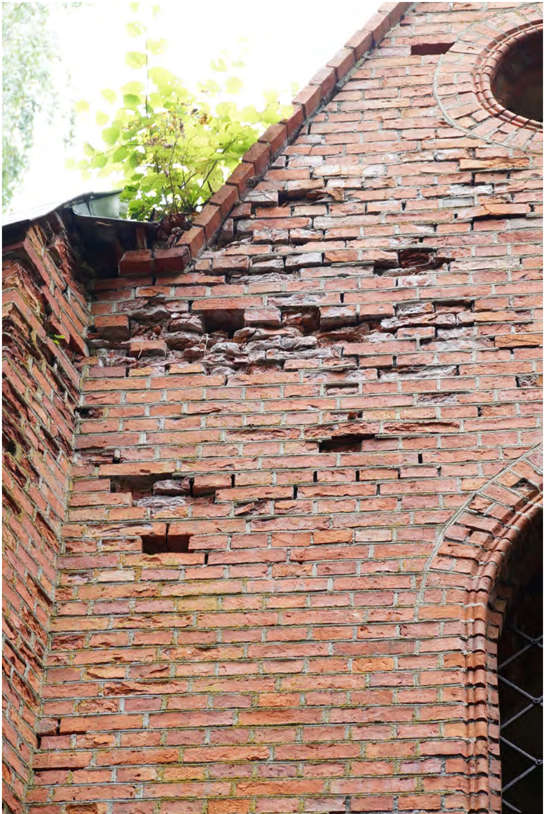
Abb. 145 Der Dachanschluss der Außenwandfläche E links des Dachfensters.
