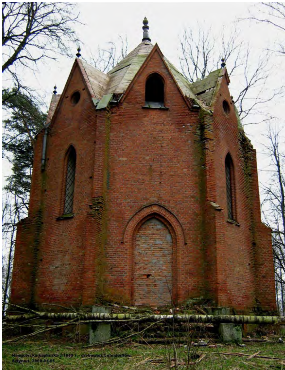
Abb. 9 Vermauerter Eingang zur Kapelle.
