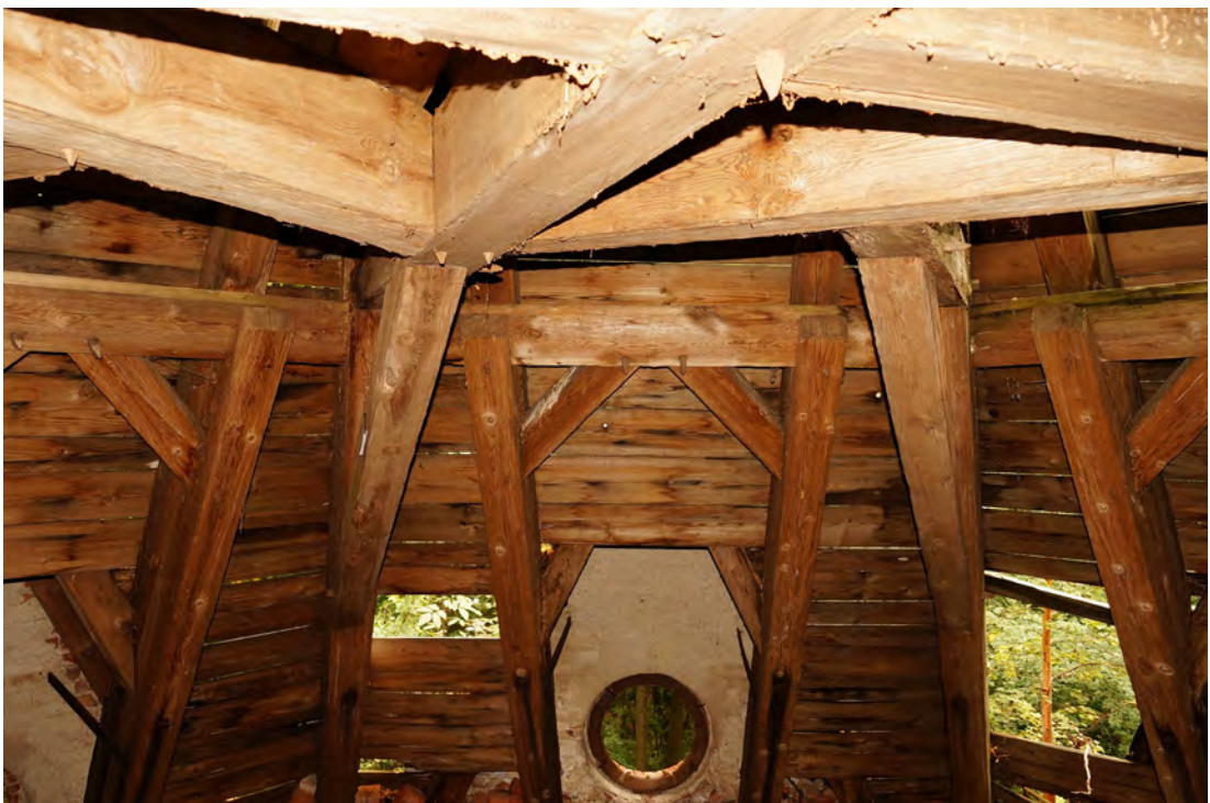
Abb. 389 Der obere Teil der Innenwandfläche D im Dachraum.
