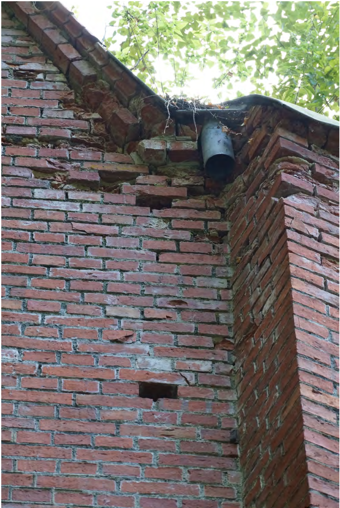
Abb. 79 Der Dachanschluss der Achse 02 c.
