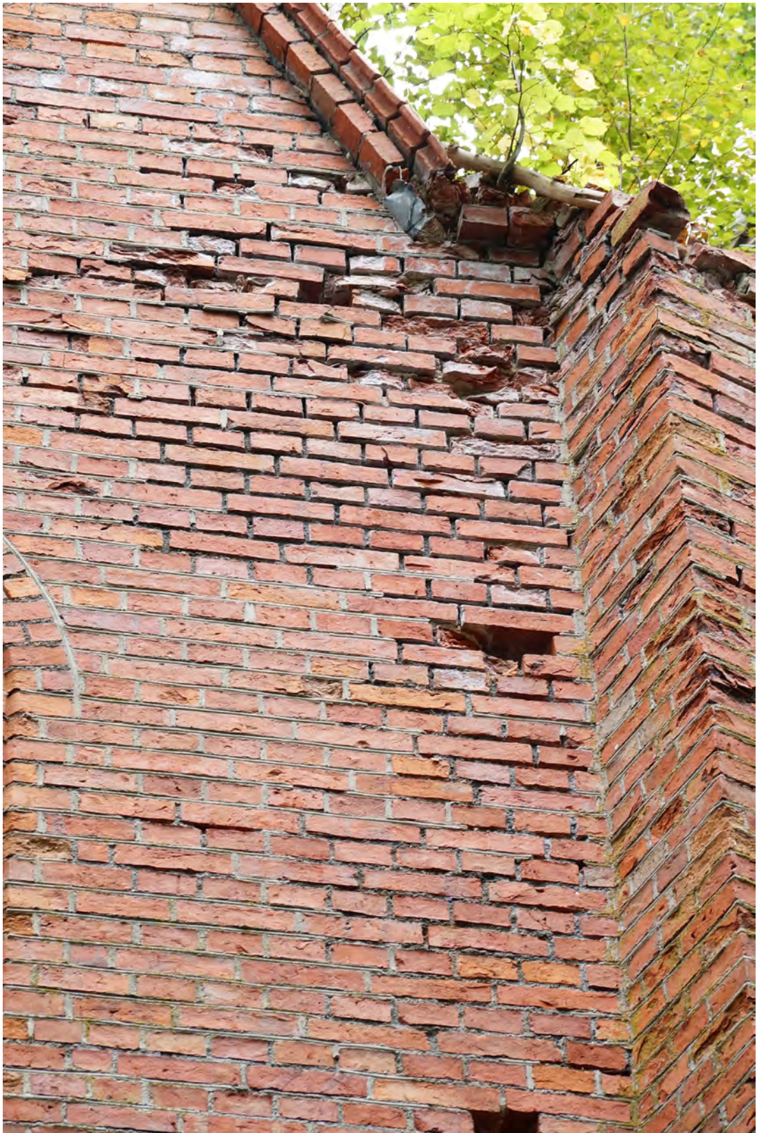
Abb. 132 Der Dachanschluss der Achse 05 c.
