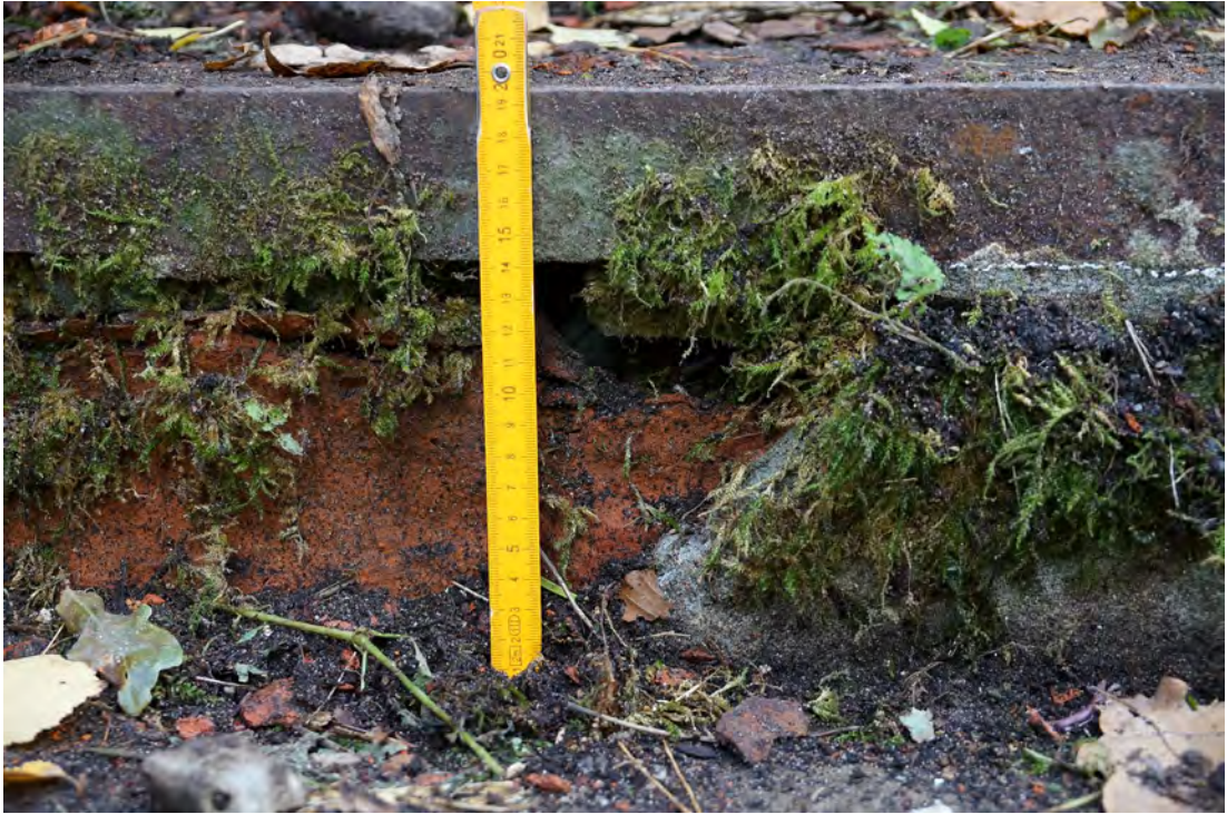
Abb. 55 Steigung der Treppenstufe.
