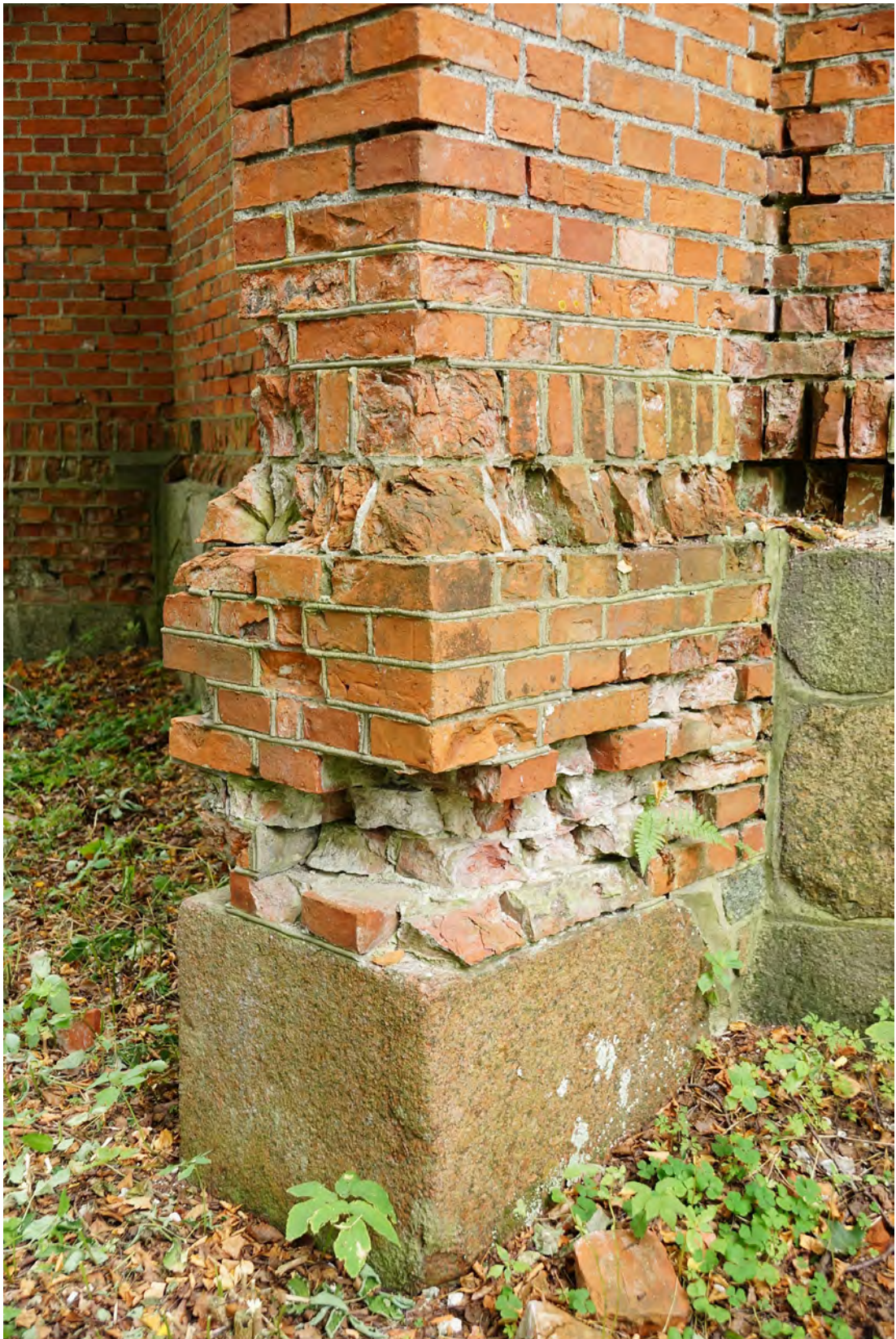
Abb. 91 Der Sockelbereich der Achse 03 a.
