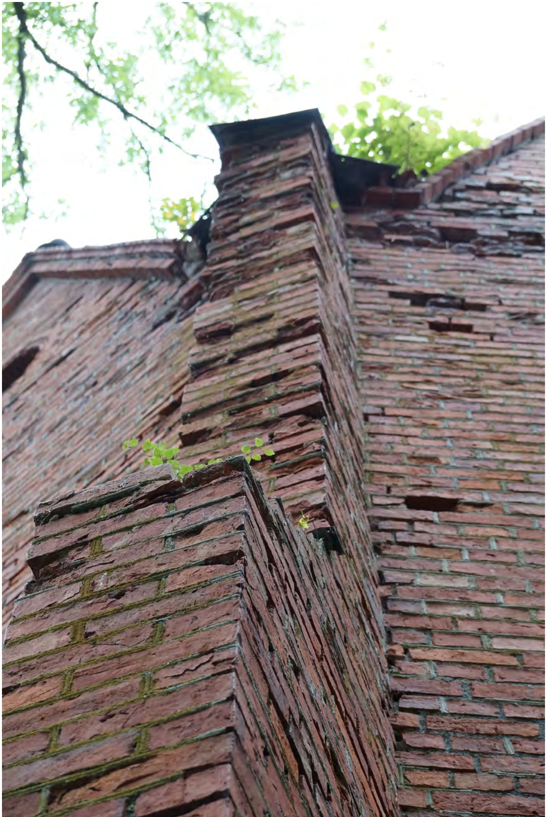
Abb. 158 Der Mauerwerksvorsprung der Achse 06 a/b.
