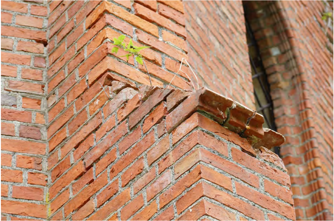
Abb. 36 Mauerwerksvorsprung der Achse 01 c.
