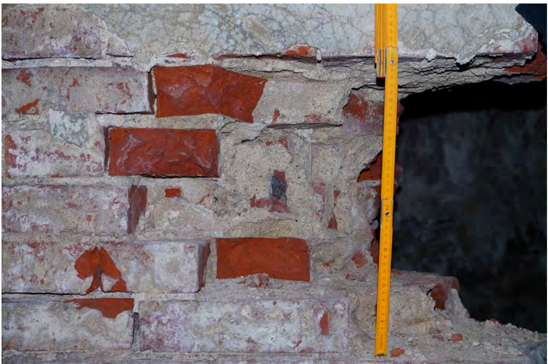
Abb. 254 Höhe der Schadstelle im vorderen, mittleren Bereich der Achse 04 a.
