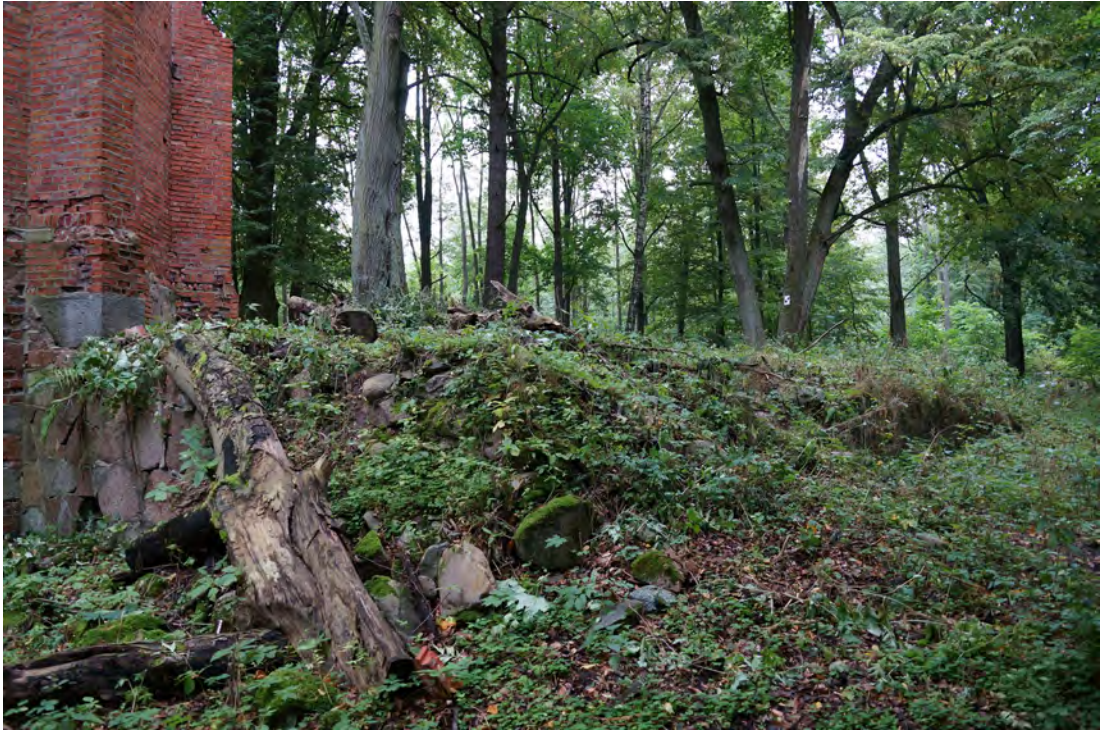
Abb. 149 Übersichtsfoto der Mauer rechts der Außenwandfläche E.
