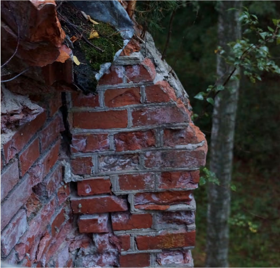
Abb. 454 Die Schäden durch das Wasser im oberen Bereich des Pfeilers der Achse 01 c sind deutlich erkennbar. Des Weiteren ist auch der besondere Fugenstrich gut sichtbar.
