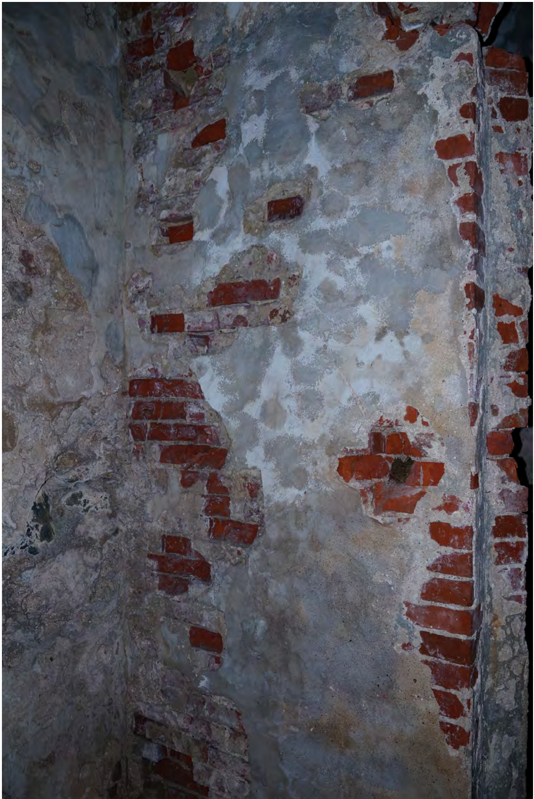
Abb. 295 Schäden am Mauerwerk der Achse 07 a.
