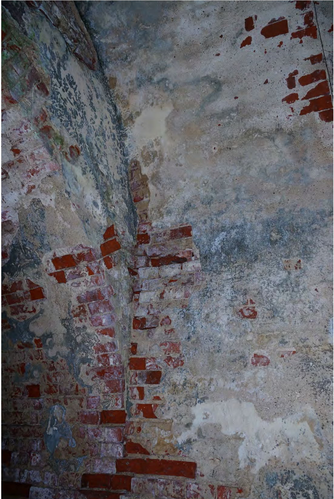
Abb. 224 Schäden am Übergang zu den Bögen der Innenwandfläche A.
