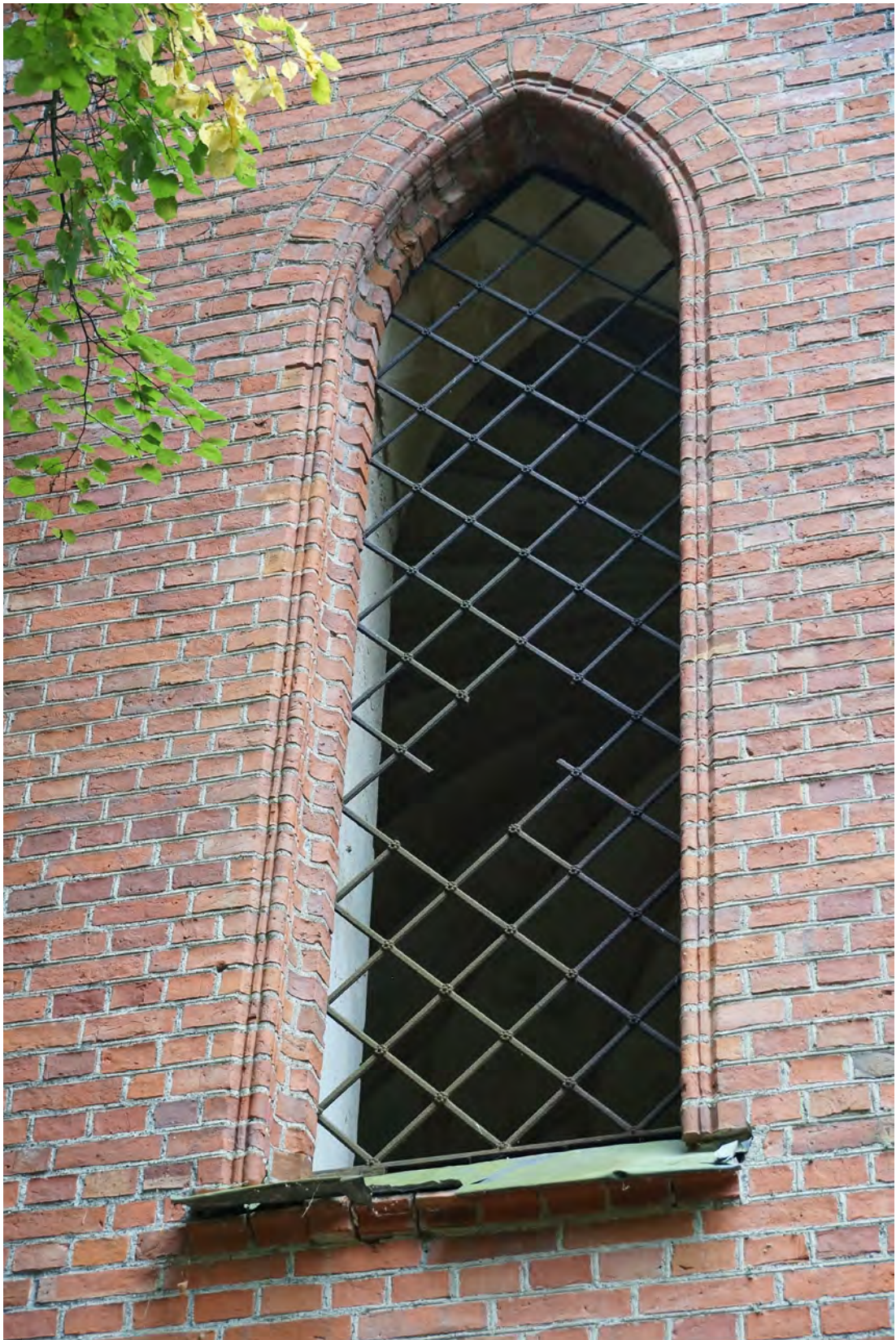
Abb. 83 Das große Fenster in der Mitte der Außenwandfläche B.
