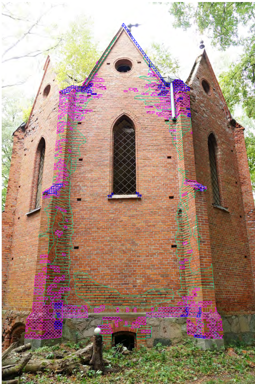
Abb. 449 Schadenskartierung der Außenwandfläche D.
