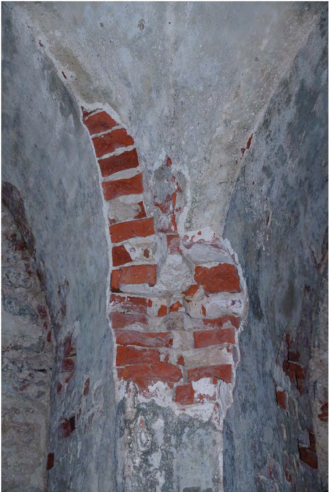
Abb. 315 Schäden am Mauerwerk des Widerlagers der Achse 08 b.
