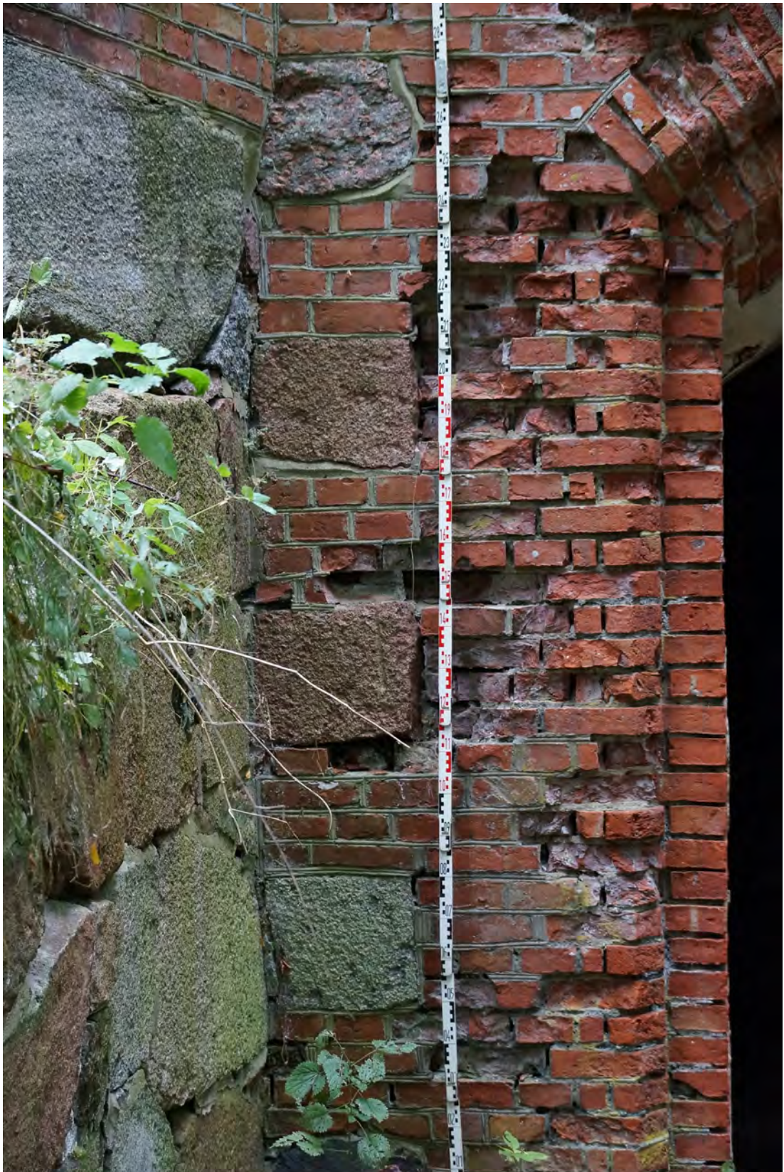
Abb. 139 Höhe der Gesteinsblöcke links der Tür in der Außenwandfläche E.
