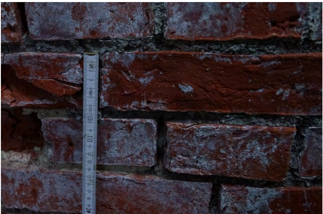
Abb. 409 Die Höhe Formsteines des Typs S2.
