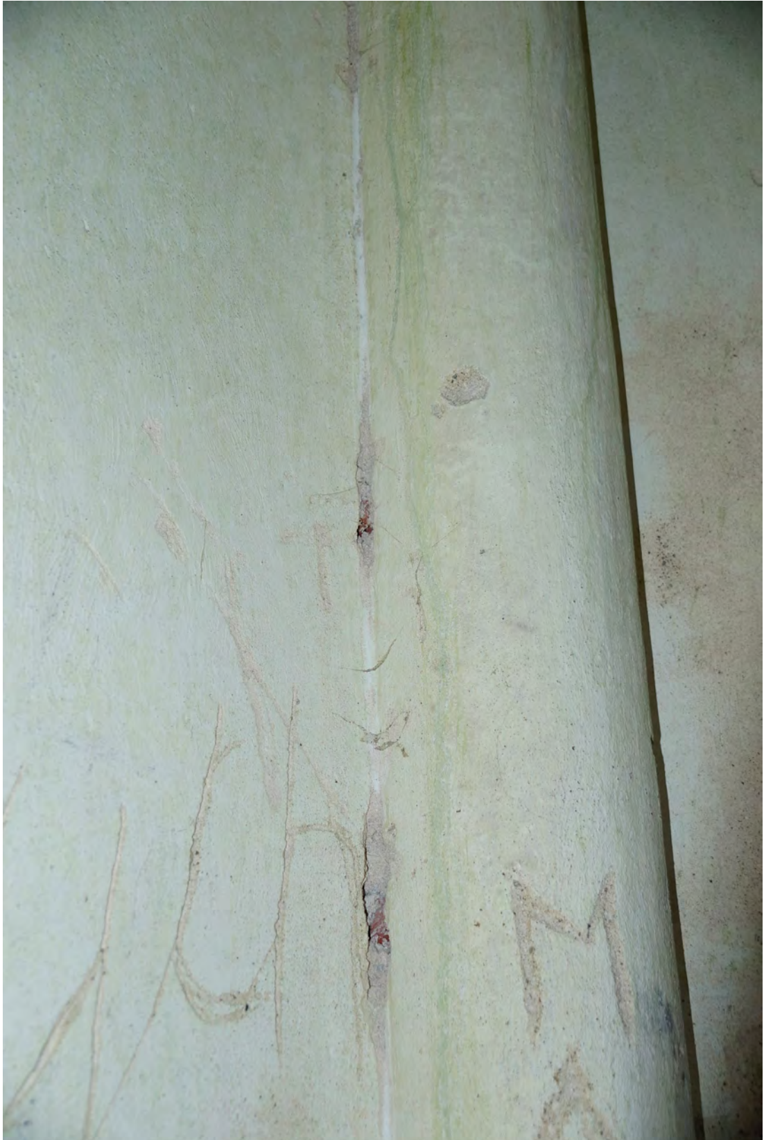
Abb. 346 Schäden im mittleren Bereich des Pilasters der Achse 04.
