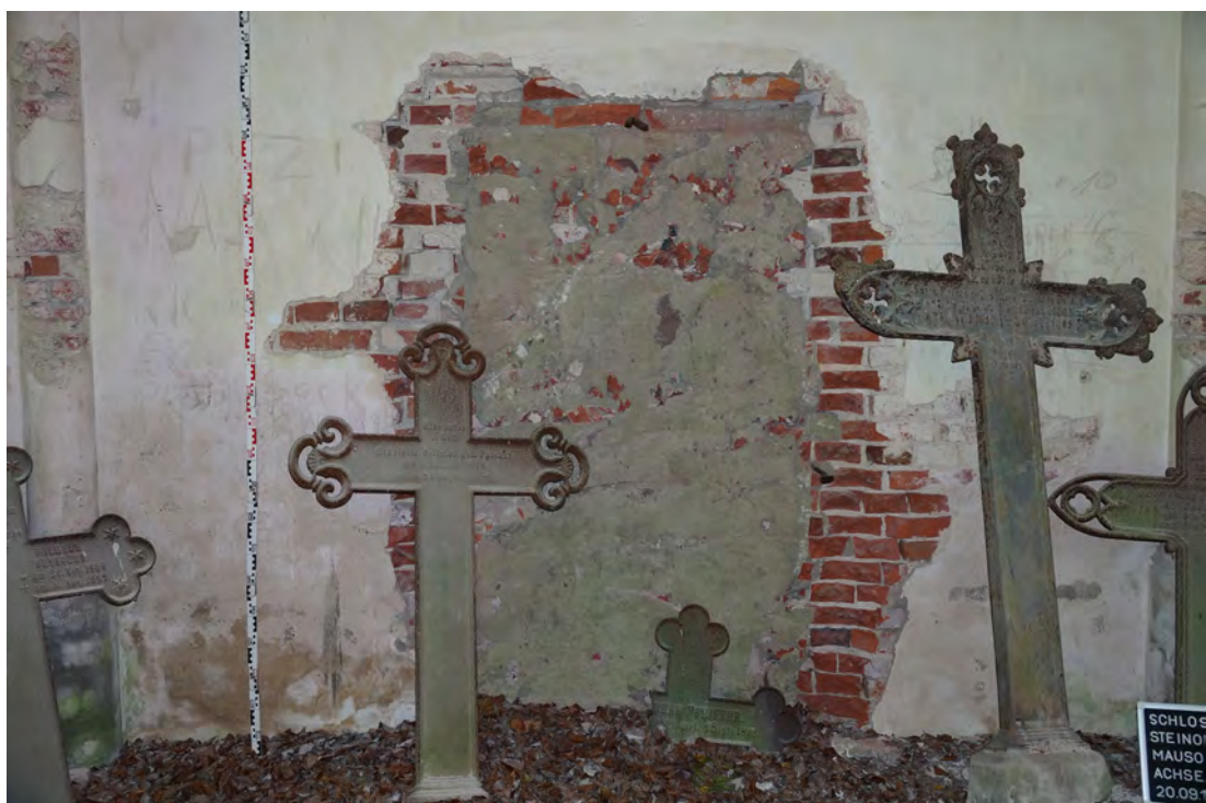
Abb. 455 Anzeichen von Vandalismus an der Innenwandfläche G.
