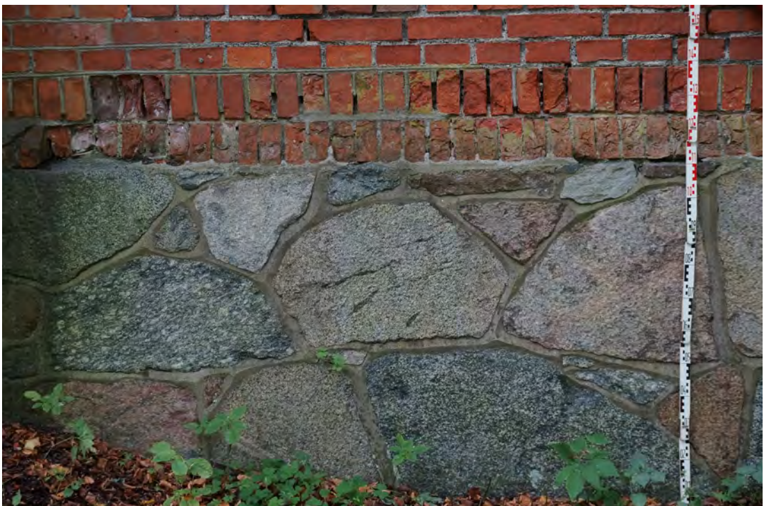
Abb. 100 Die Höhe des Sockelbereiches der Außenwandfläche C.
