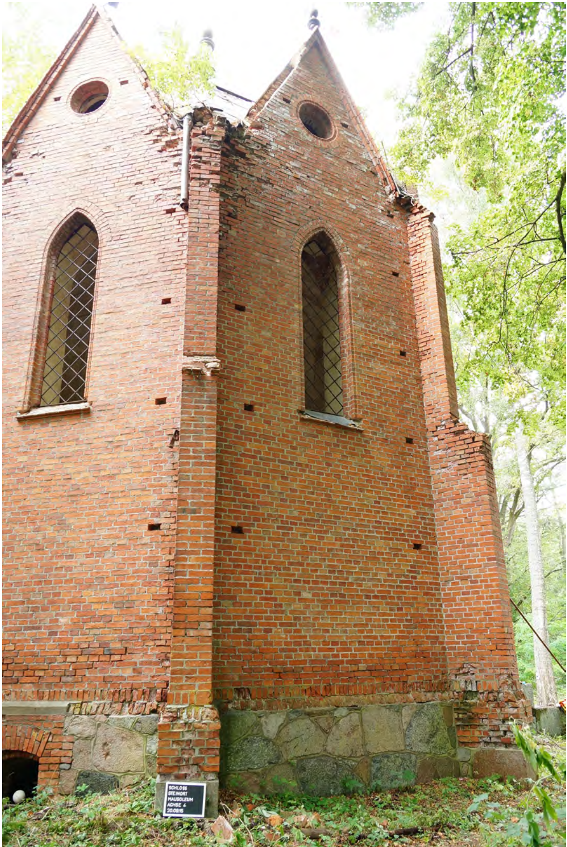
Abb. 98 Übersichtsfoto der Außenwandfläche C (aus Sicht von Achse 04).
