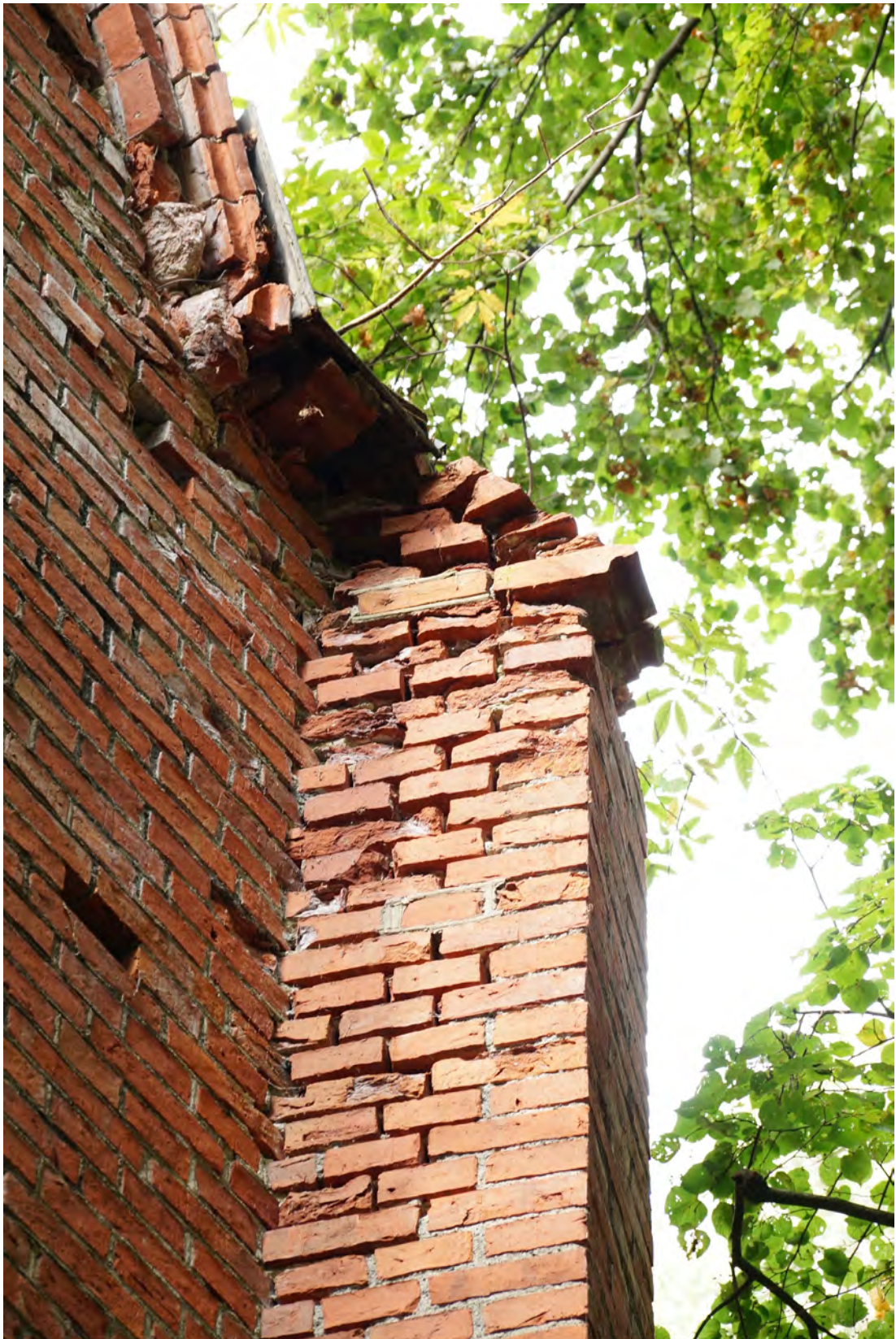
Abb. 97 Der Dachanschluss der Achse 03 c.
