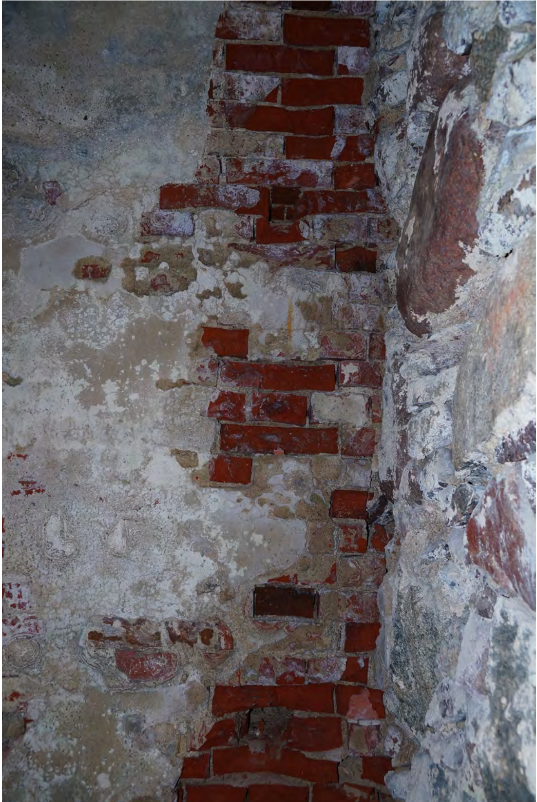
Abb. 243 Schäden am Mauerwerk im hinteren, mittleren Bereich der Achse 03 c.
