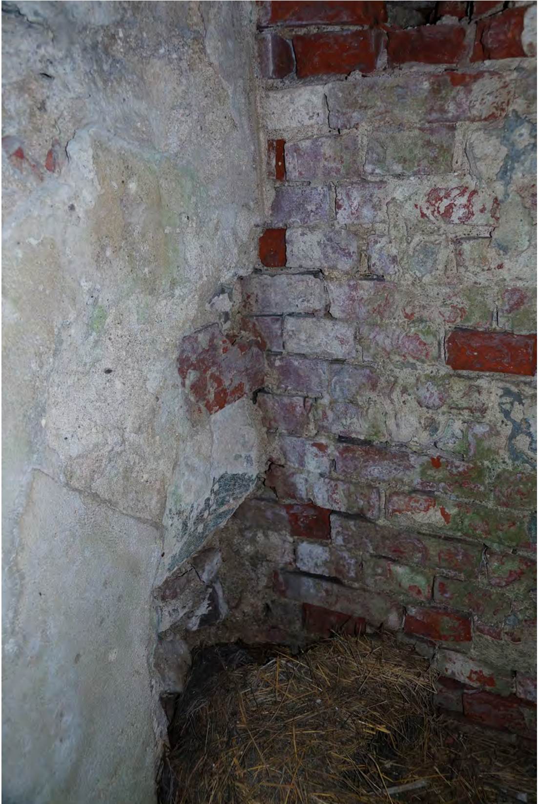
Abb. 308 Schäden am Mauerwerk im unteren, hinteren Bereich der Achse 08 a.
