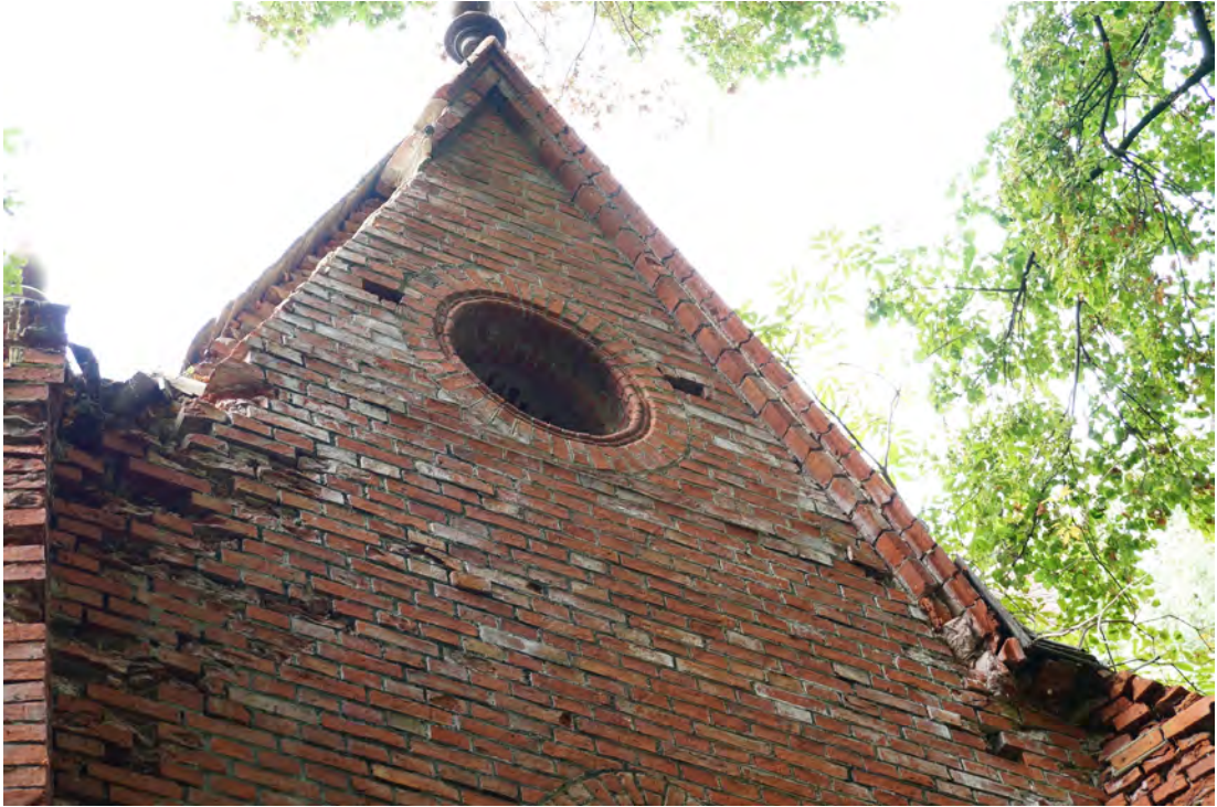
Abb. 104 Der Dachanschluss der Außenwandfläche C.
