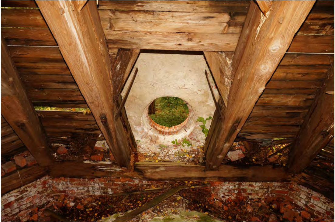
Abb. 394 Der untere Teil der Innenwandfläche G im Dachraum.
