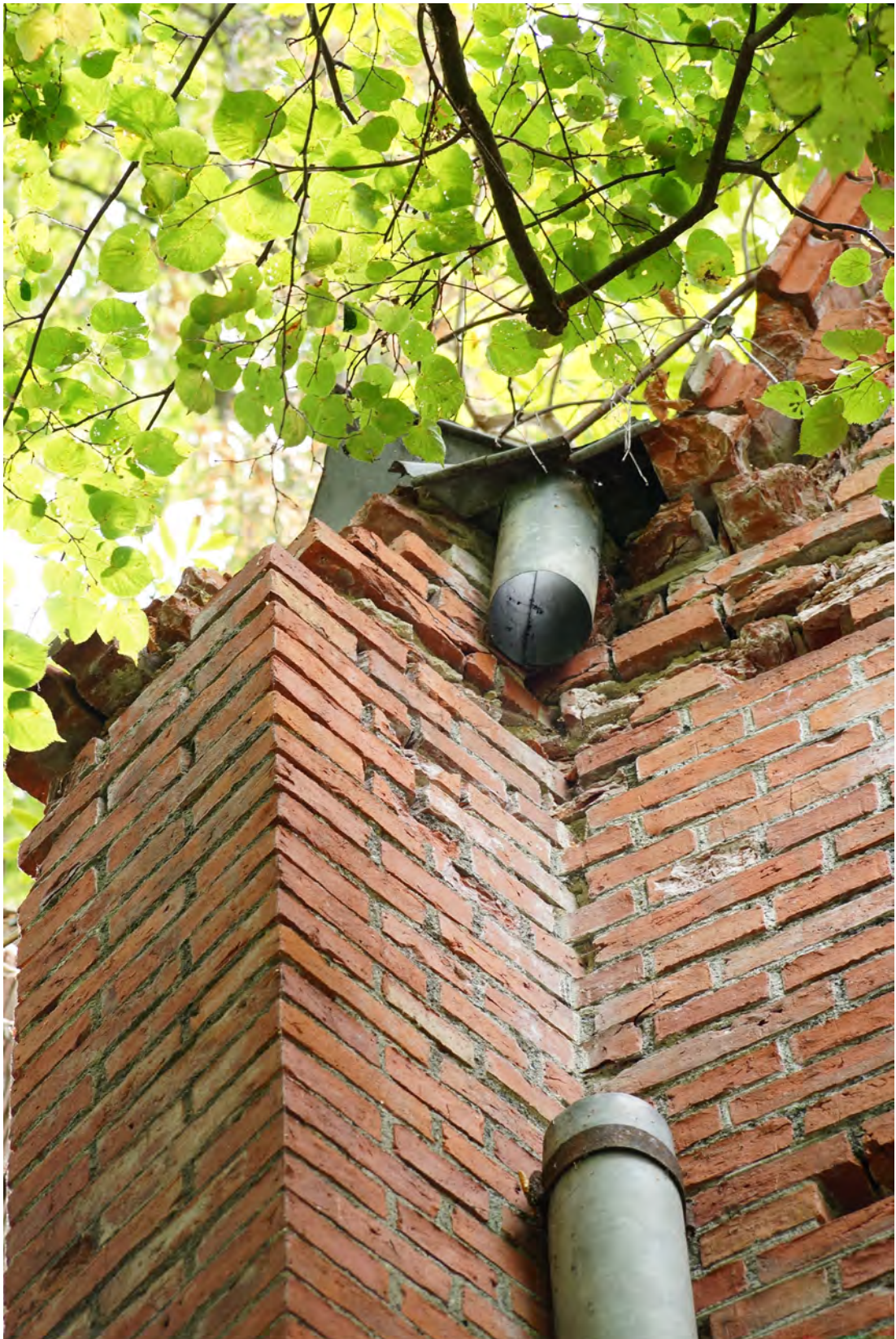
Abb. 96 Der Dachanschluss der Achse 03 a.
