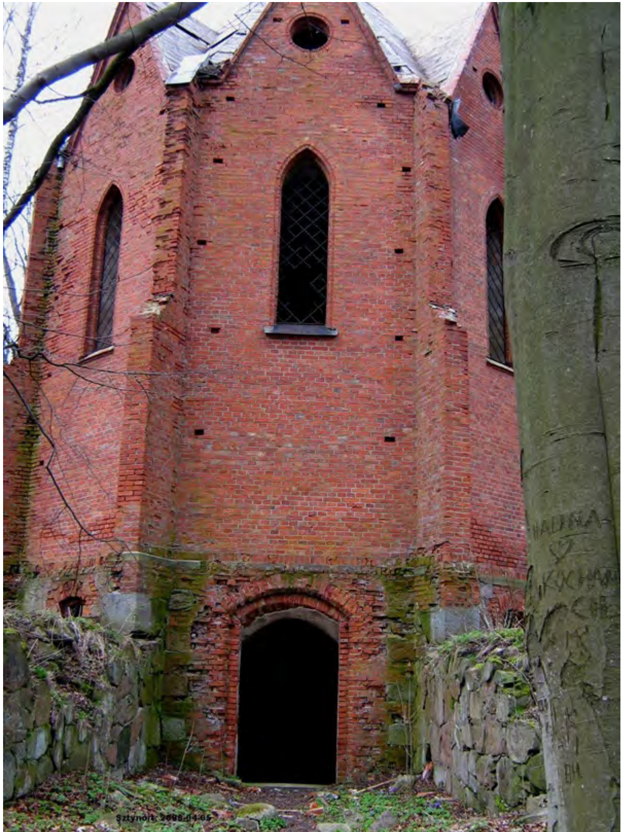
Abb. 8 Eingang zum Mausoleum, Bedachung entfernt.
