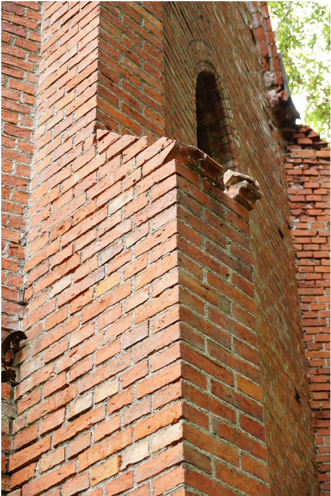
Abb. 111 Der Mauerwerksvorsprung der Achse 04 c.
