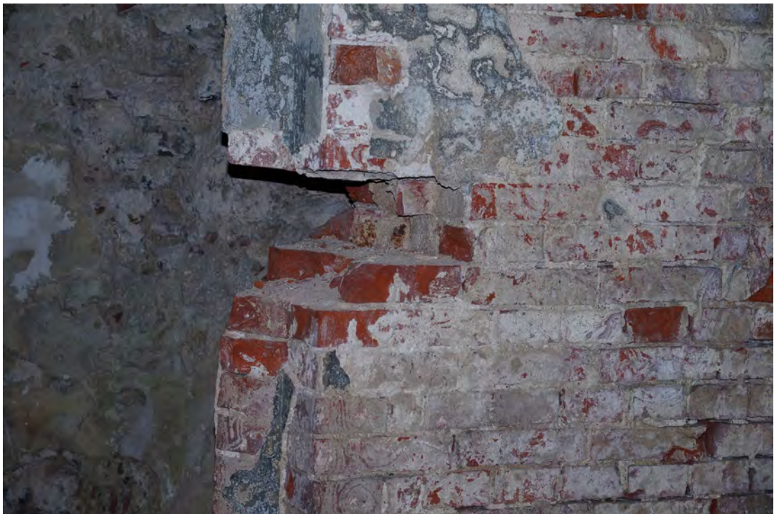
Abb. 313 Schäden am Mauerwerk im mittleren Bereich der Achse 08 c.
