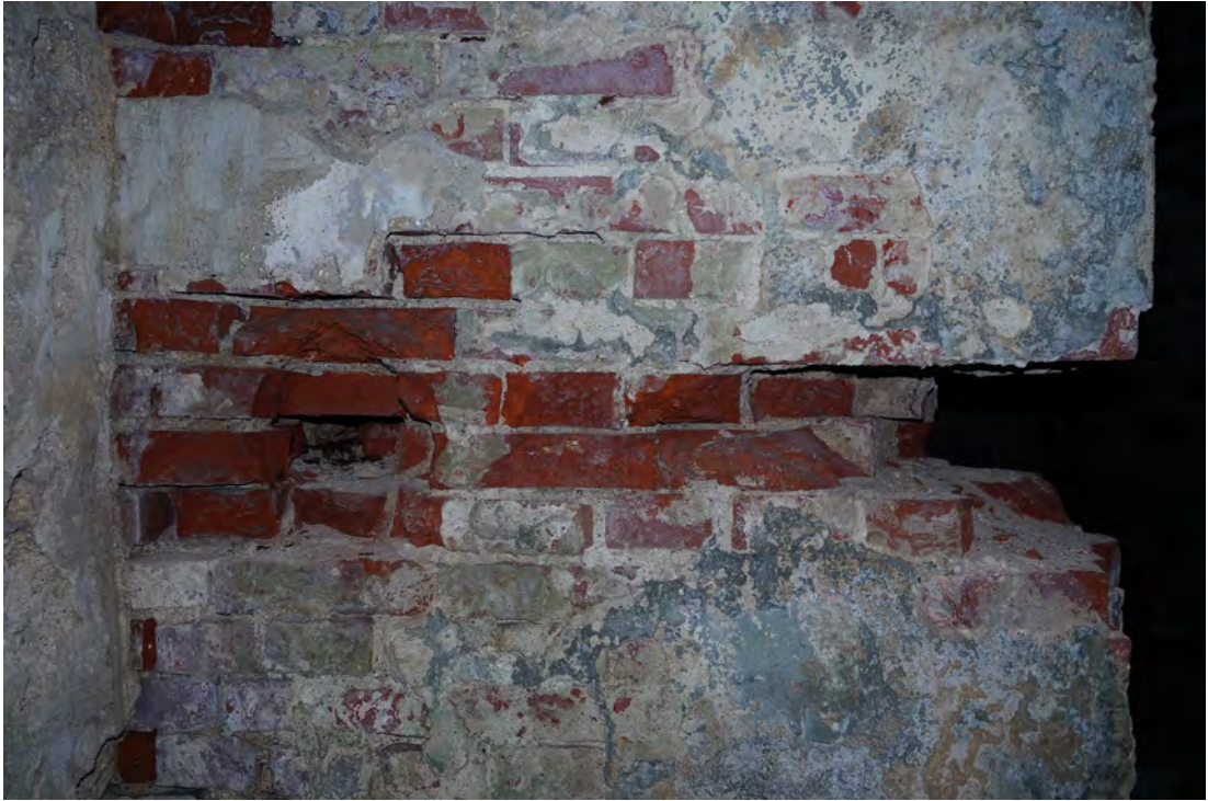
Abb. 311 Schäden am Mauerwerk im mittleren Bereich der Achse 08 a.
