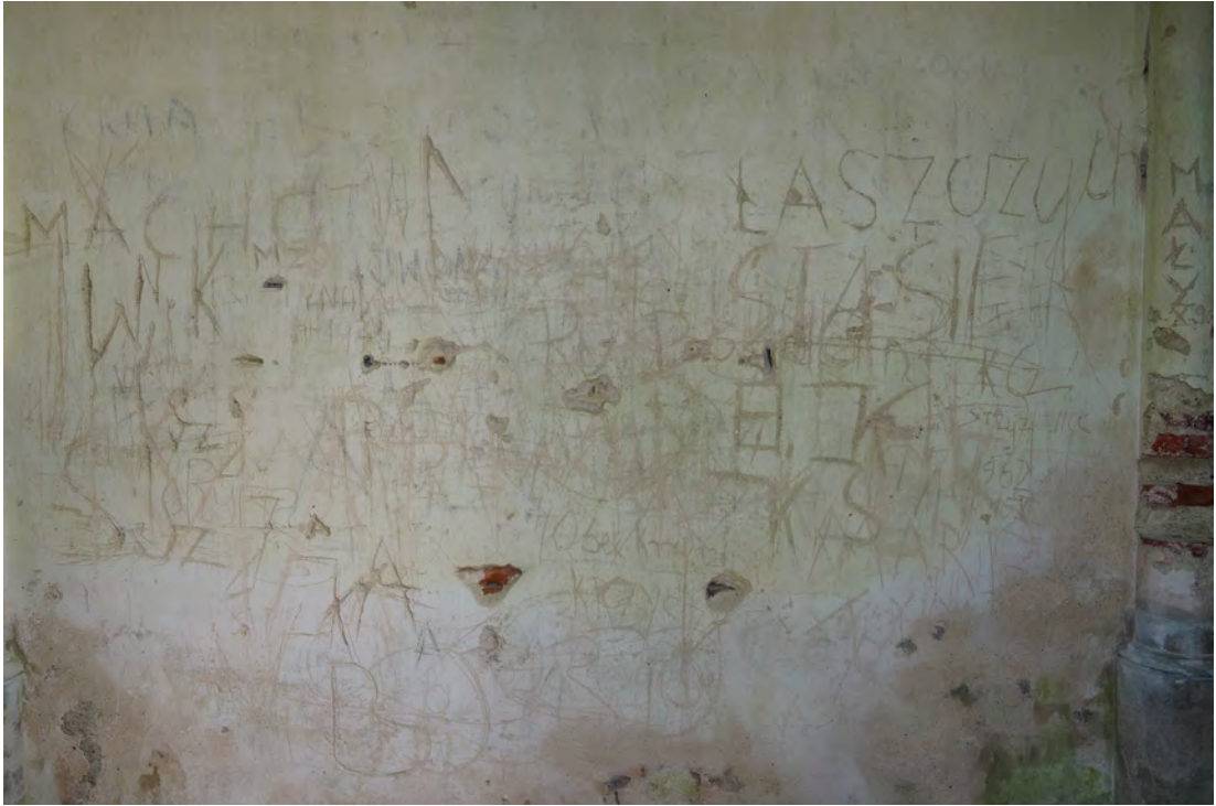
Abb. 343 Vandalismus im unteren Bereich der Innenwandfläche C.
