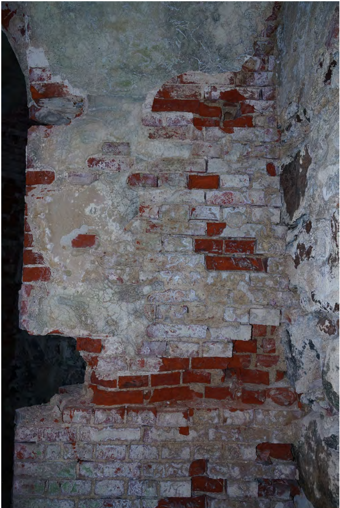
Abb. 257 Schäden am oberen Mauerwerk der Achse 04 c.
