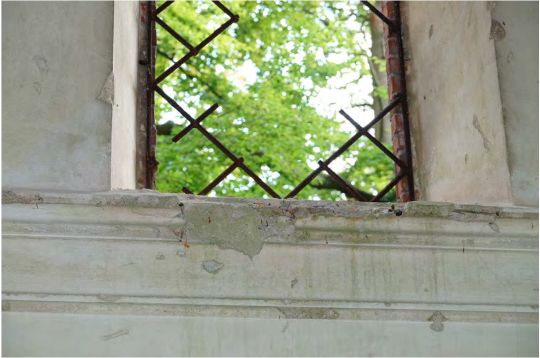
Abb. 355 Das Fensterbrett des Fensters der Innenwandfläche E.
