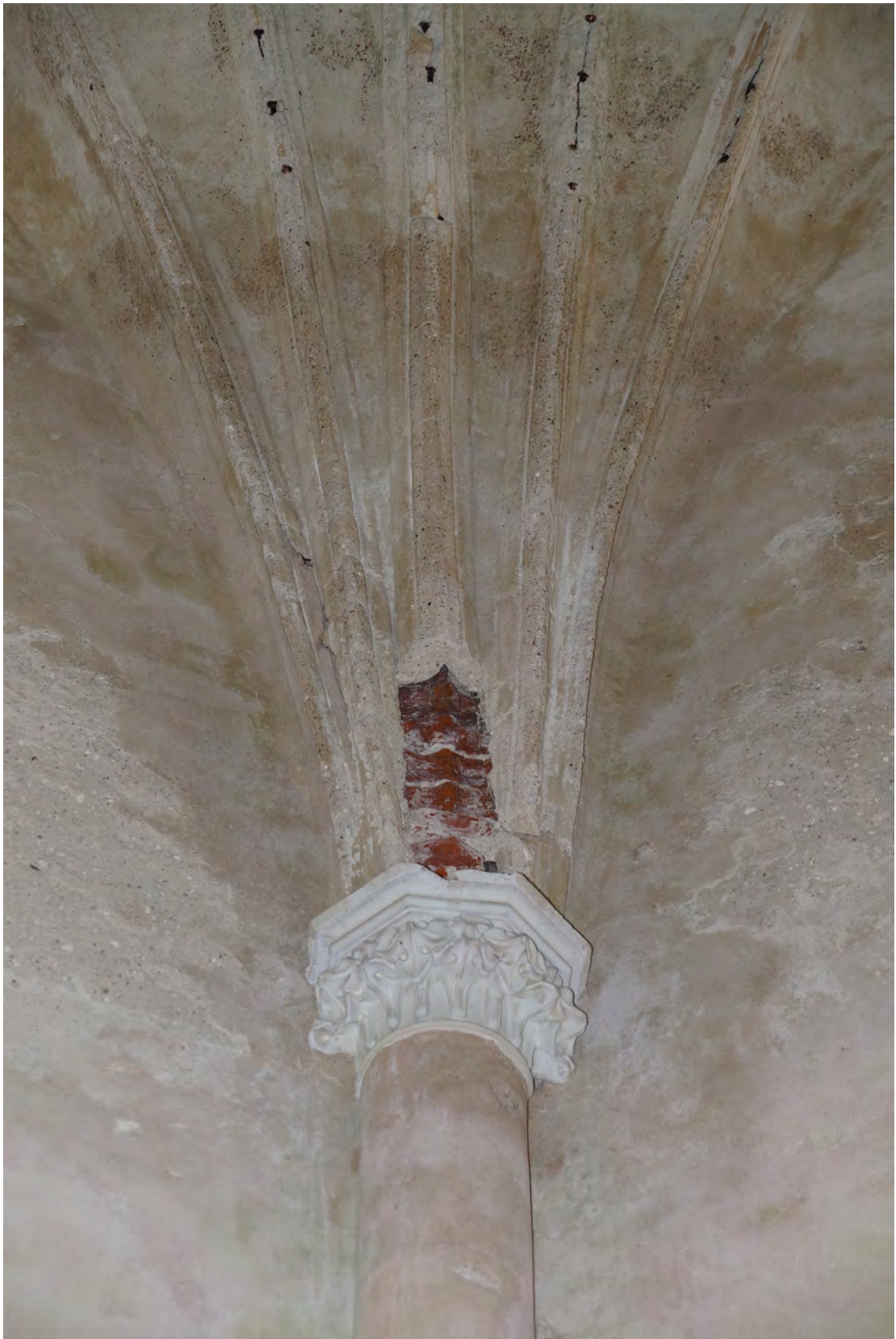
Abb. 366 Schäden am Kapitell der Achse 07 und an den Gewölberippen darüber.
