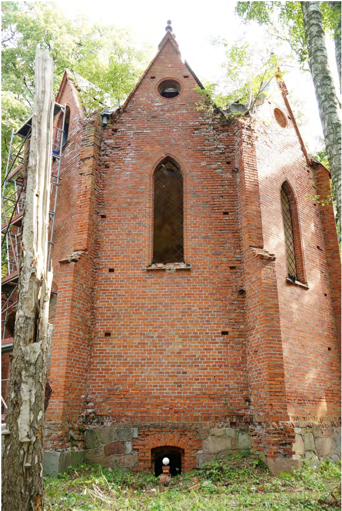
Abb. 199 Übersichtsfoto der Außenwandfläche H.
