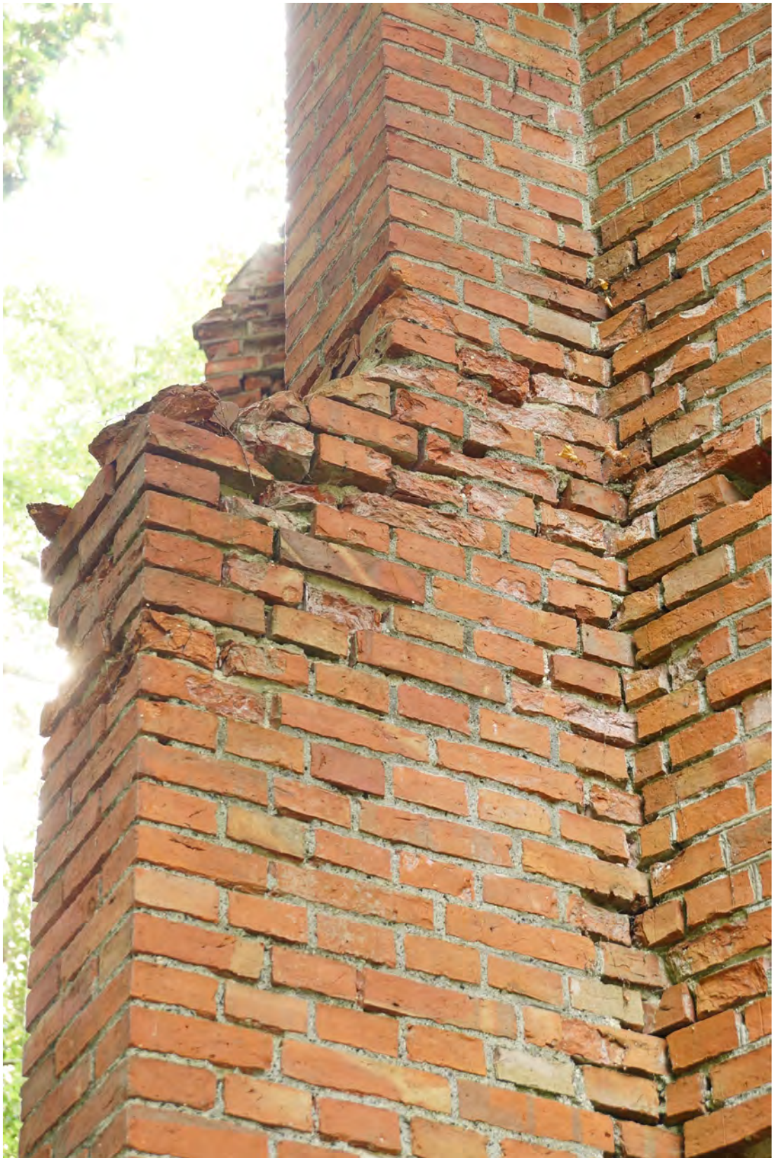
Abb. 94 Der Mauerwerksvorsprung der Achse 03 a.
