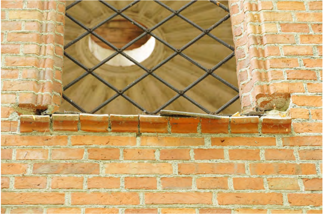
Abb. 102 Die Fensterbank des großen Fensters in der Mitte der Außenwandfläche C.
