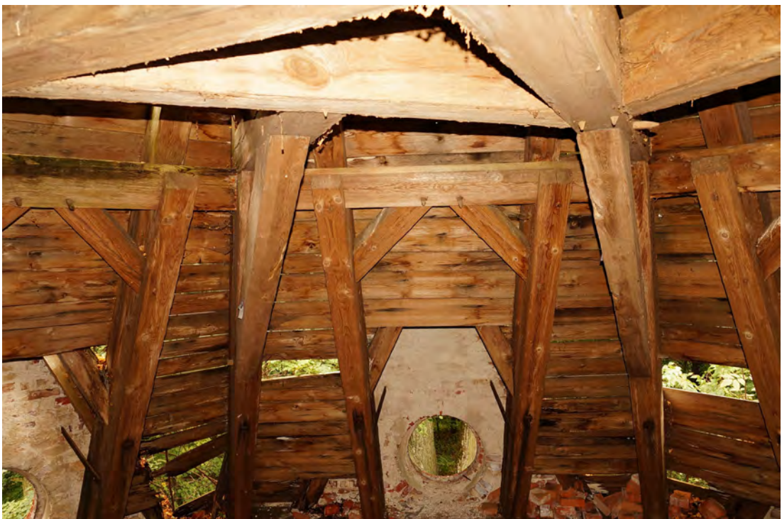
Abb. 387 Der obere Teil der Innenwandfläche C im Dachraum.
