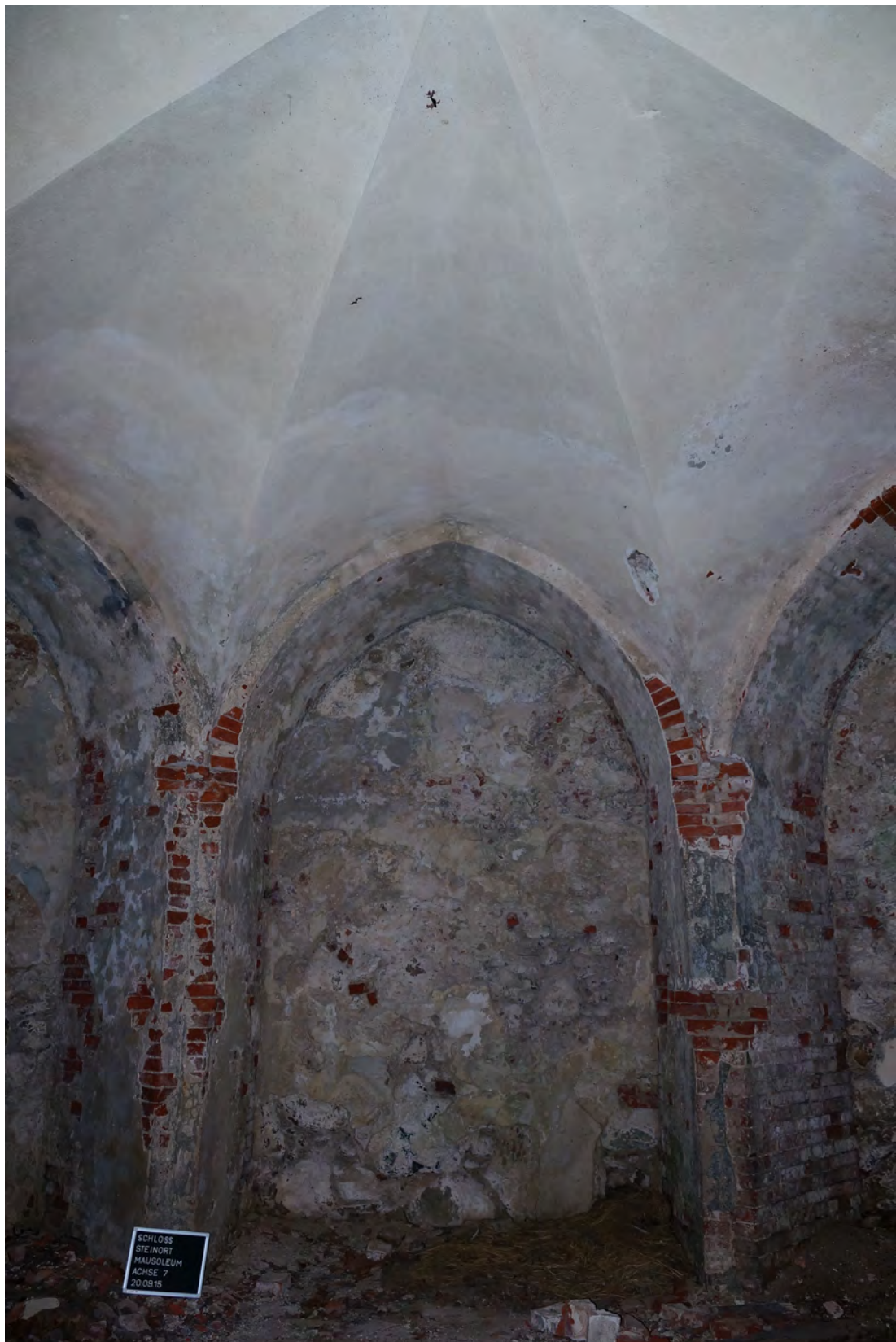
Abb. 303 Übersichtsfoto der Innenwandfläche G mit Gewölbe.
