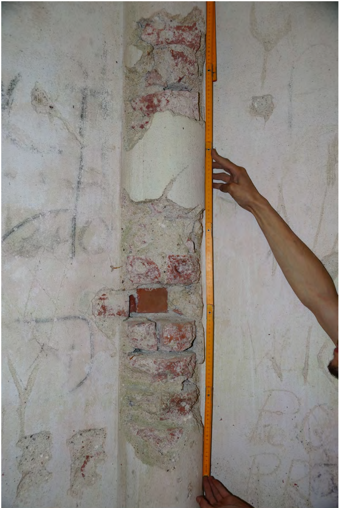
Abb. 365 Schäden im unteren Bereich des Pilasters der Achse 07.
