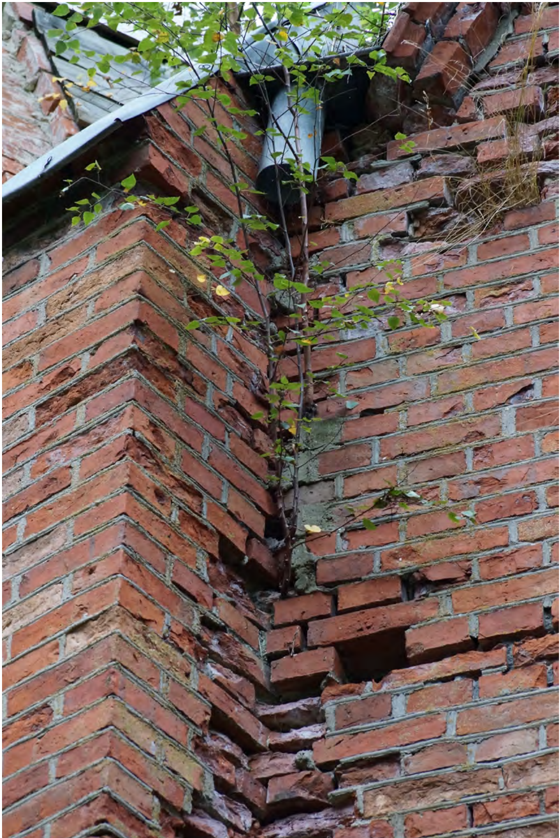
Abb. 180 Der Dachanschluss der Achse 07 a.
