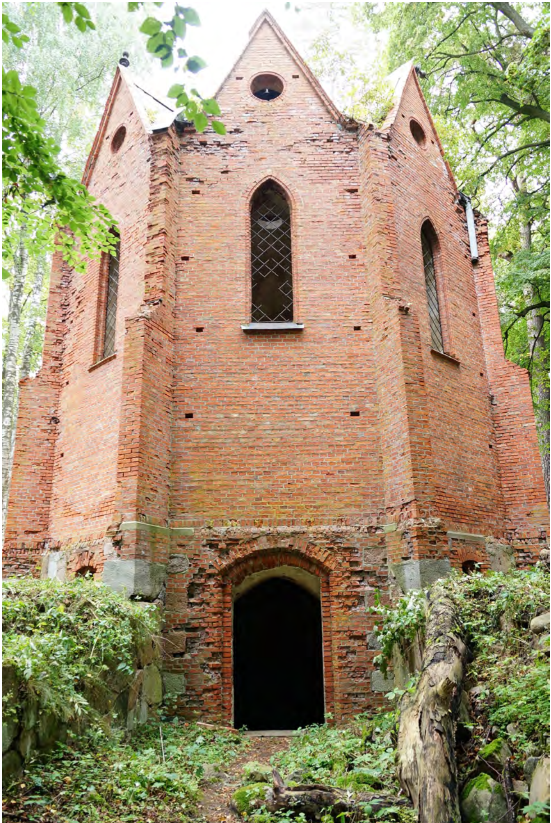
Abb. 133 Übersichtsfoto der Außenwandfläche E.
