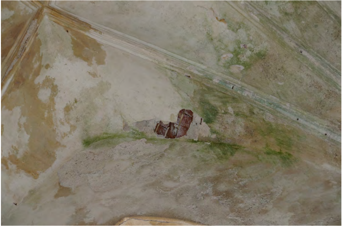
Abb. 372 Die Schäden am Gewölbe oberhalb des Spitzbogens des Fensters der Innenwandfläche G.
