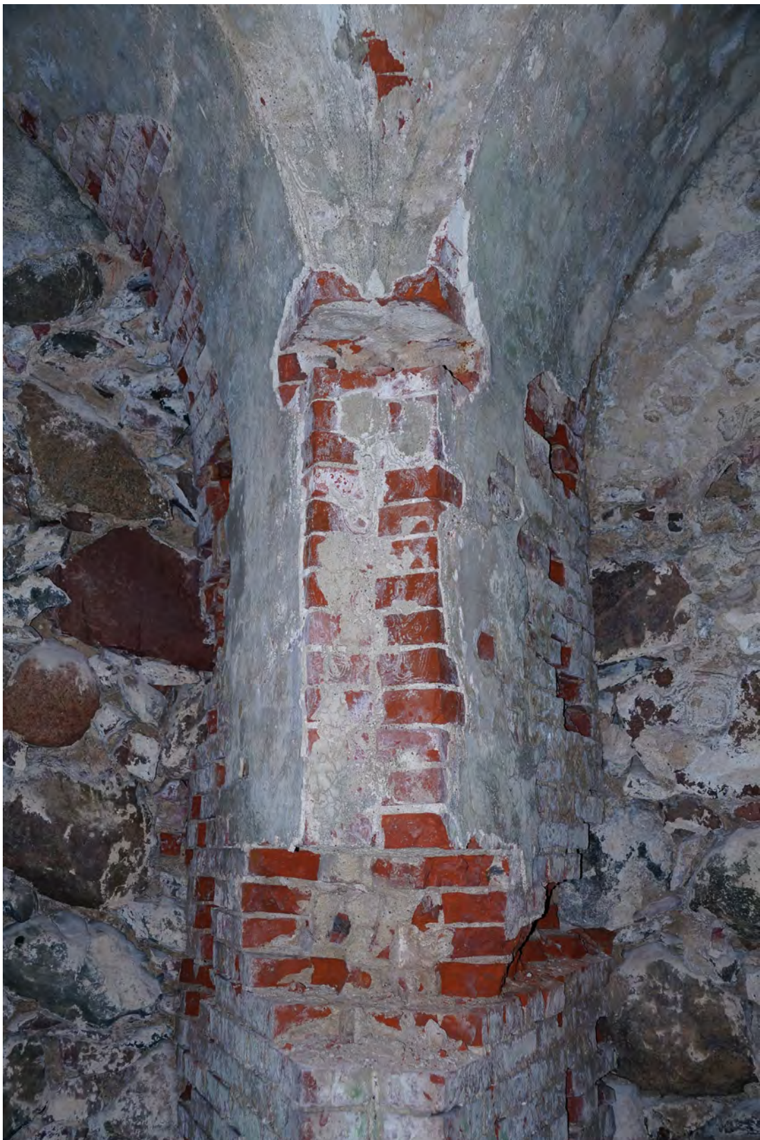
Abb. 256 Schäden am oberen Mauerwerk der Achse 04 b.
