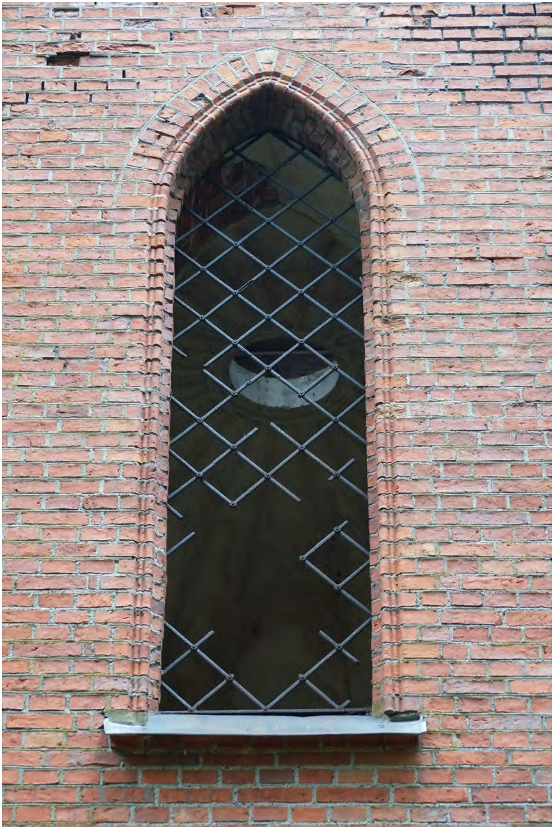
Abb. 142 Das große Fenster in der Mitte der Außenwandfläche E.
