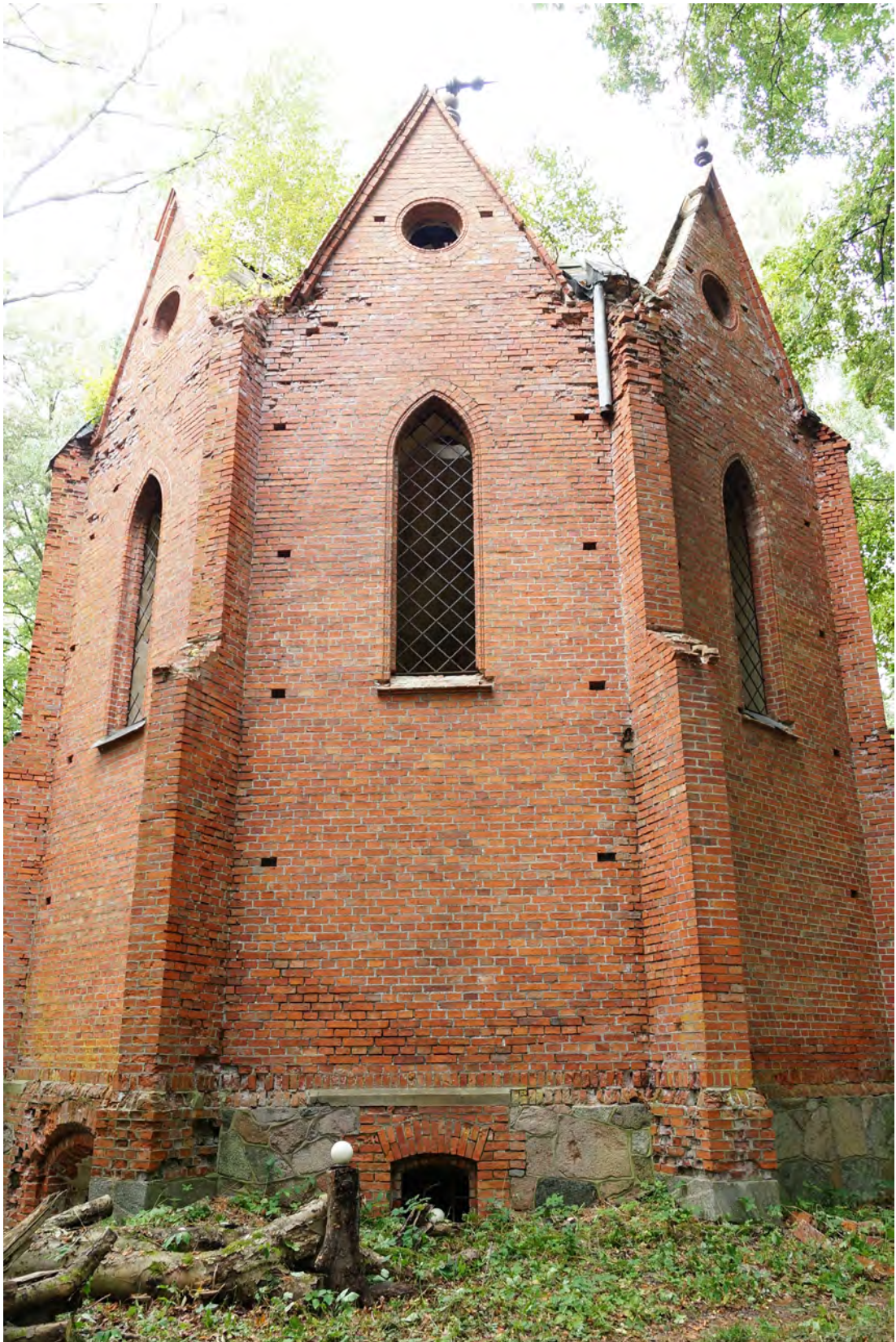
Abb. 115 Übersichtsfoto der Außenwandfläche D.
