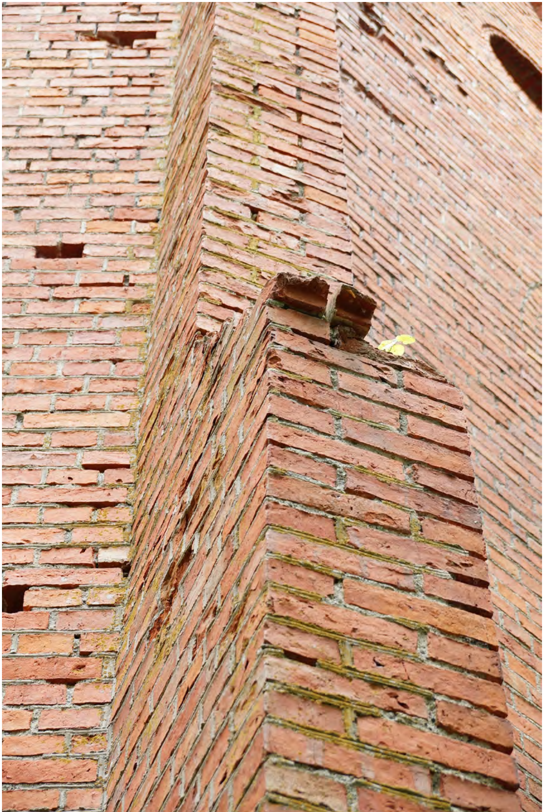
Abb. 129 Der Mauerwerksvorsprung der Achse 05 b/c.
