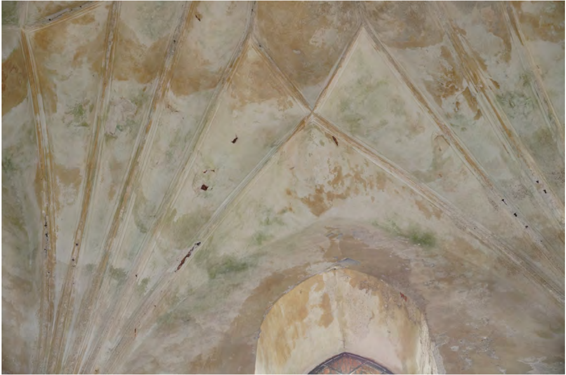
Abb. 363 Die Schäden am Gewölbe oberhalb des Spitzbogens des Fensters der Innenwandfläche F.
