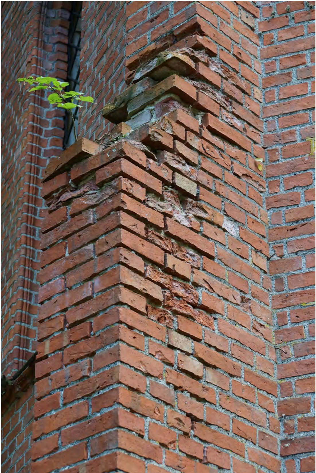
Abb. 72 Der Mauerwerksvorsprung an der Achse 02 a.
