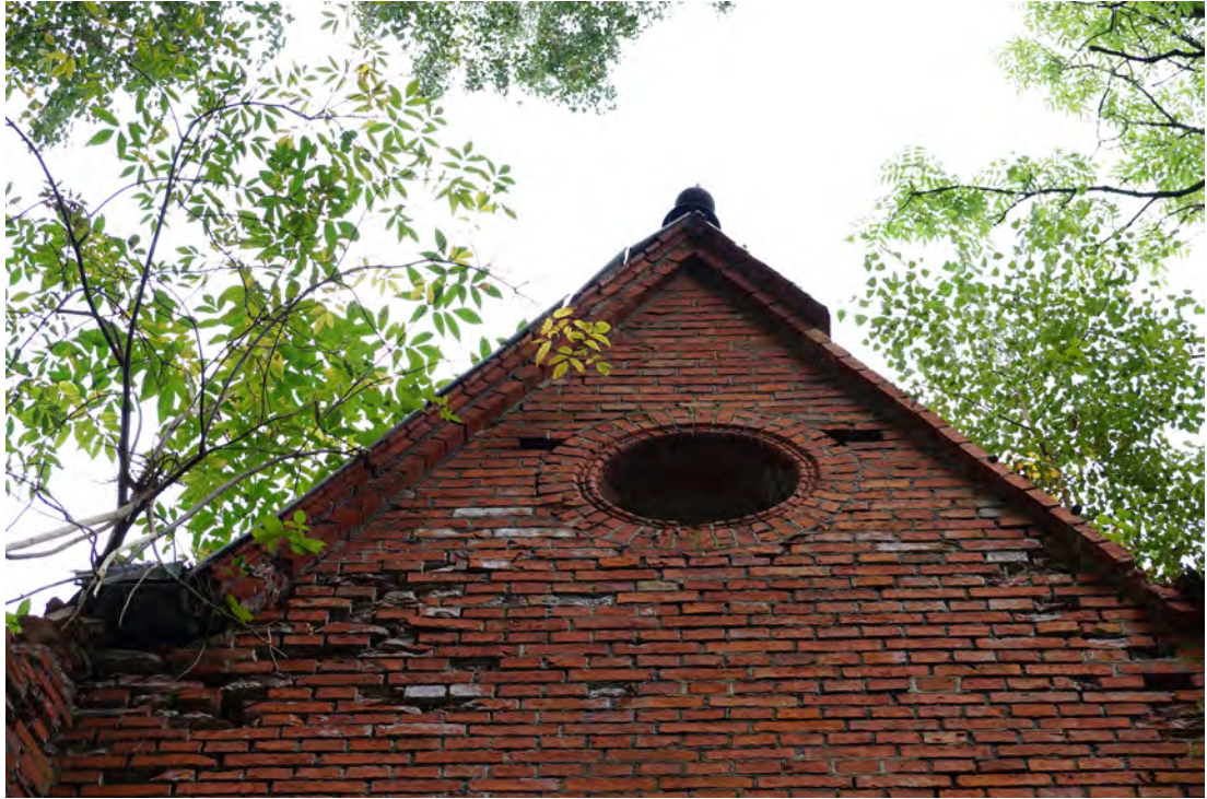
Abb. 188 Der Dachanschluss der Außenwandseite G.
