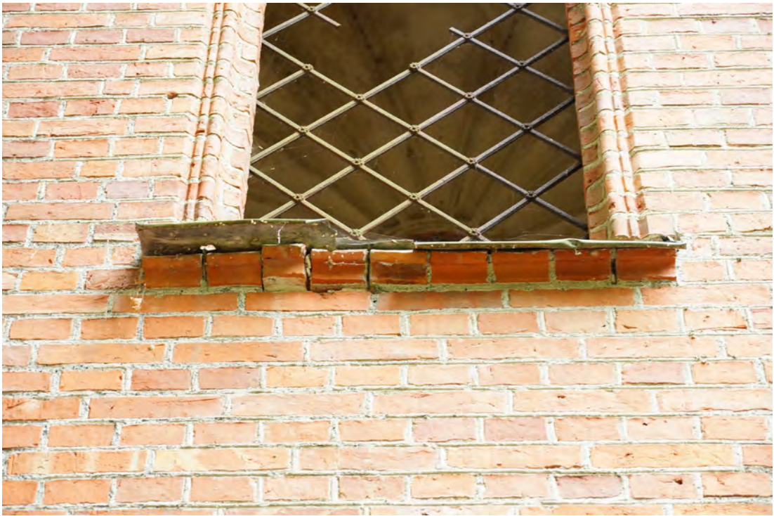
Abb. 84 Fensterbank des großen Fensters der Außenwandfläche B.
