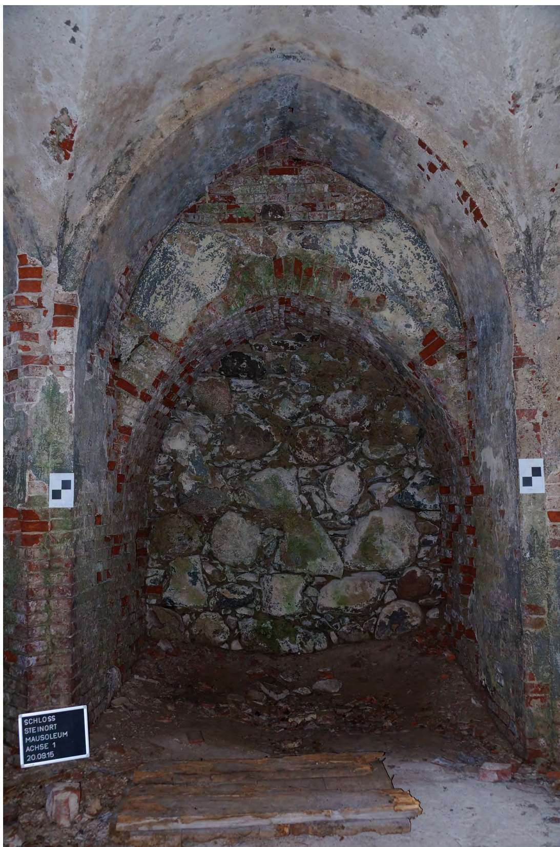
Abb. 217 Übersichtsfoto der Innenwandfläche A.
