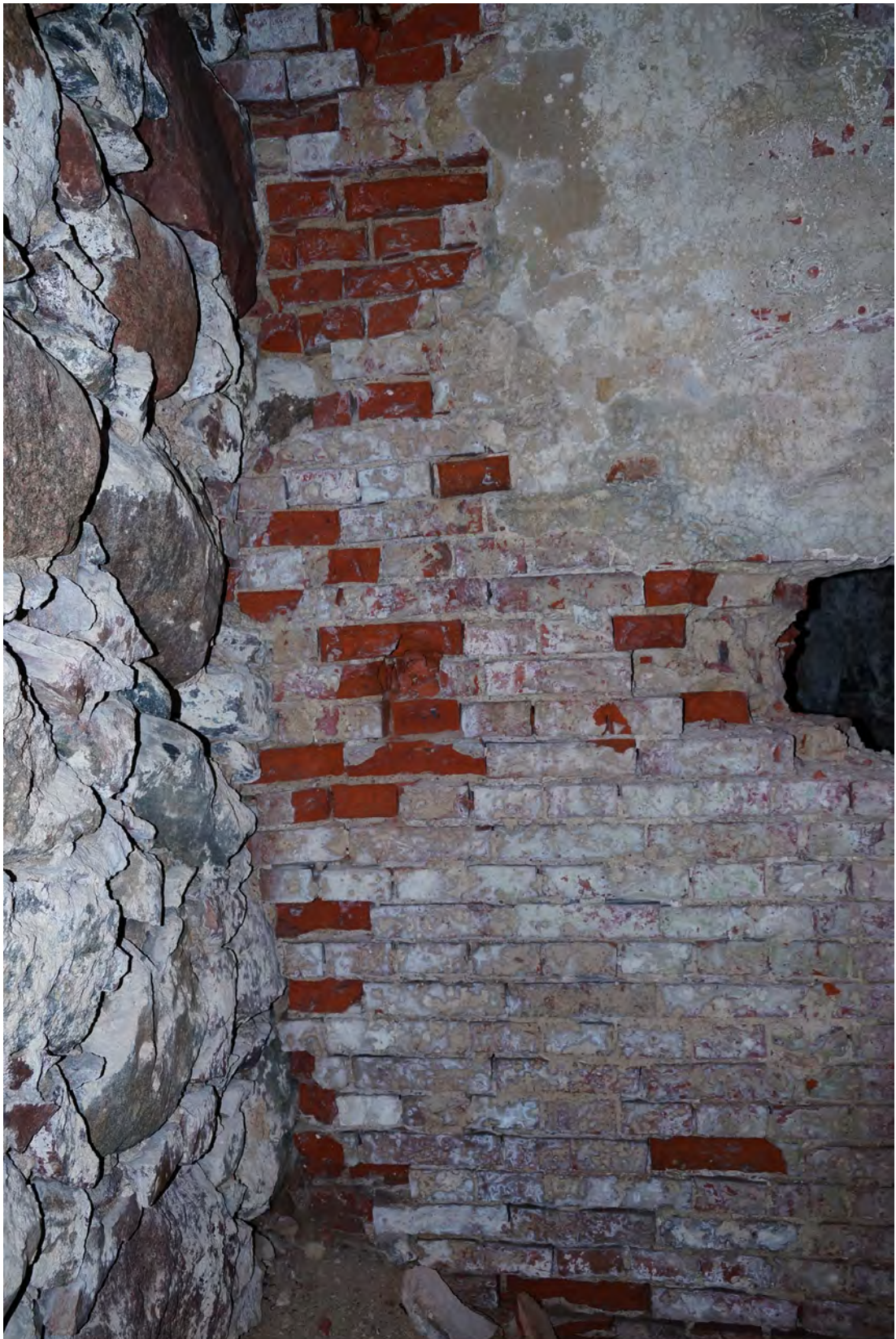
Abb. 251 Schäden im hinteren Bereich der Achse 04 a.
