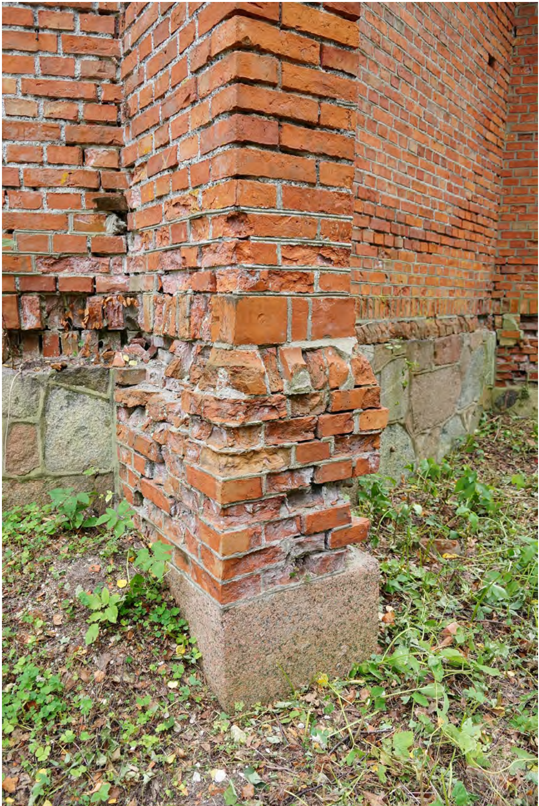
Abb. 193 Der Sockelbereich der Achse 08 b/c.
