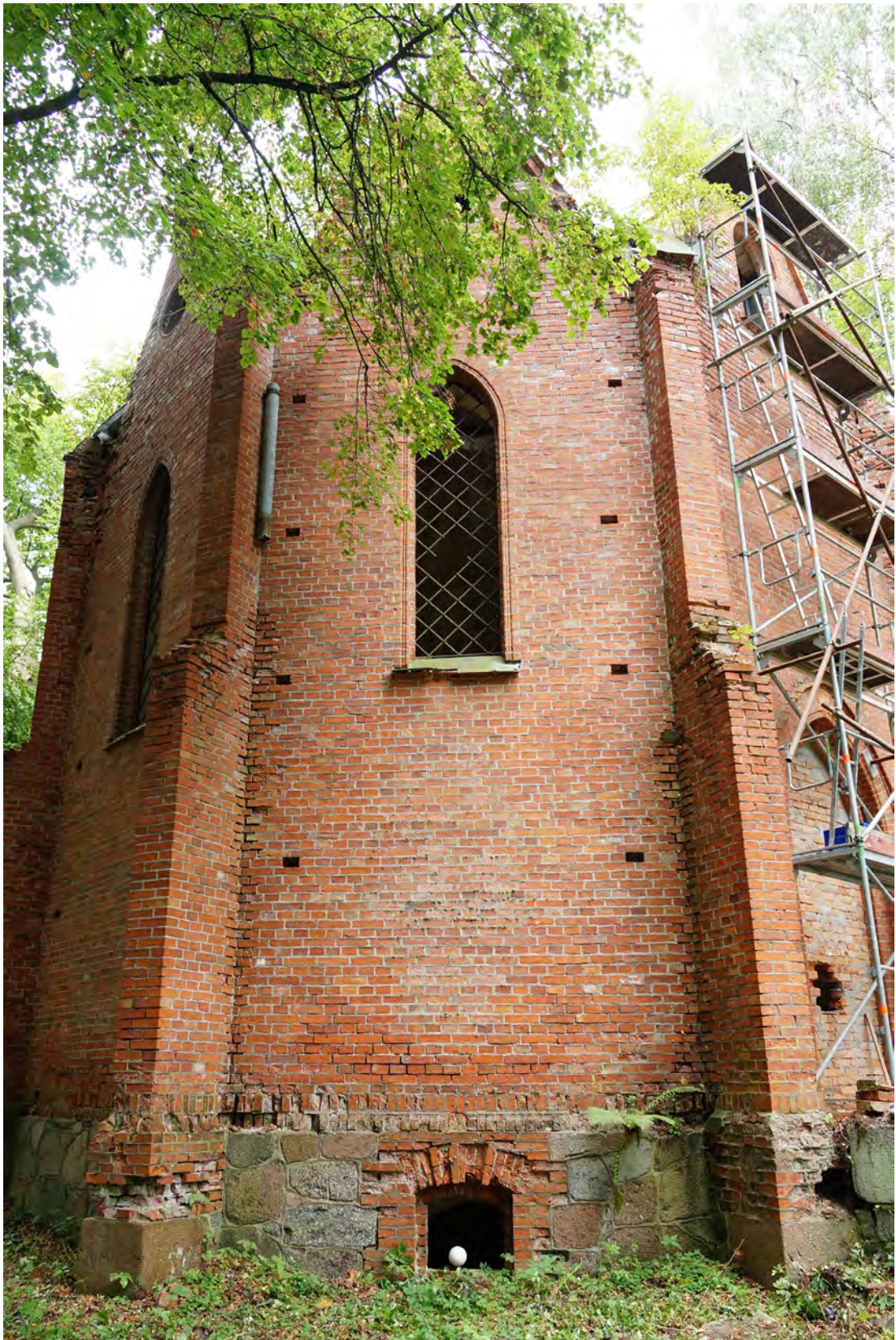
Abb. 80 Übersichtsfoto der Außenwandfläche B.
