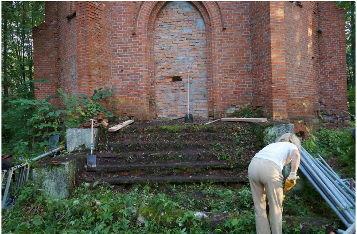
Abb. 18 Eingangsbereich nach Fertigstellung der Arbeiten.
