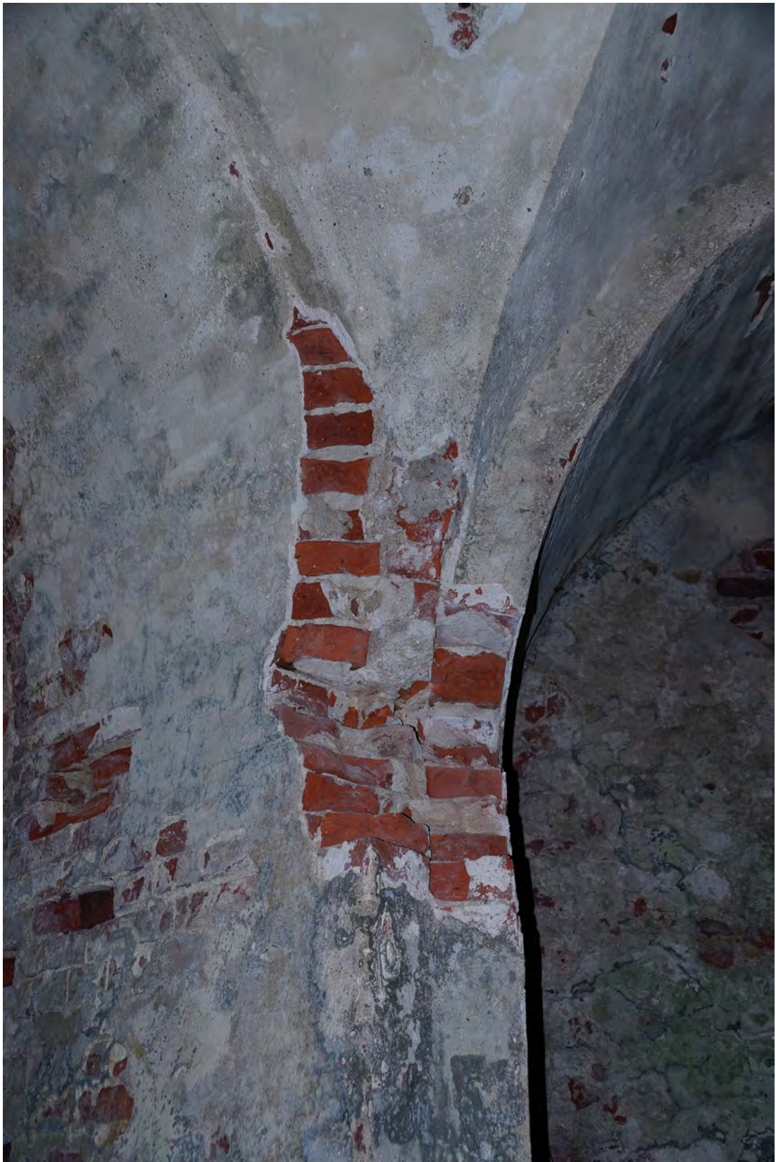
Abb. 314 Schäden am Mauerwerk des Widerlagers der Achse 08 a/b.
