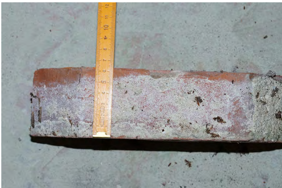
Abb. 429 Die Höhe des Formsteines des Typs S5.
