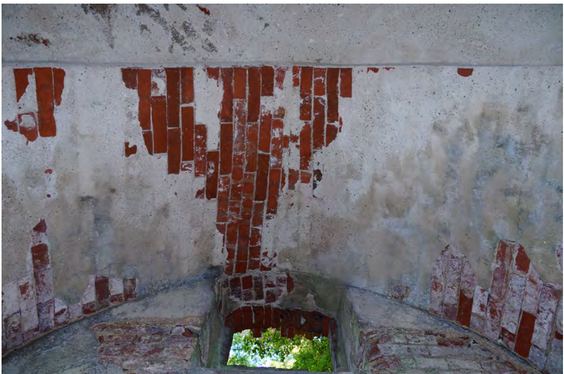
Abb. 232 Schäden am Scheitelpunkt des Bogens der Innenwandfläche B.
