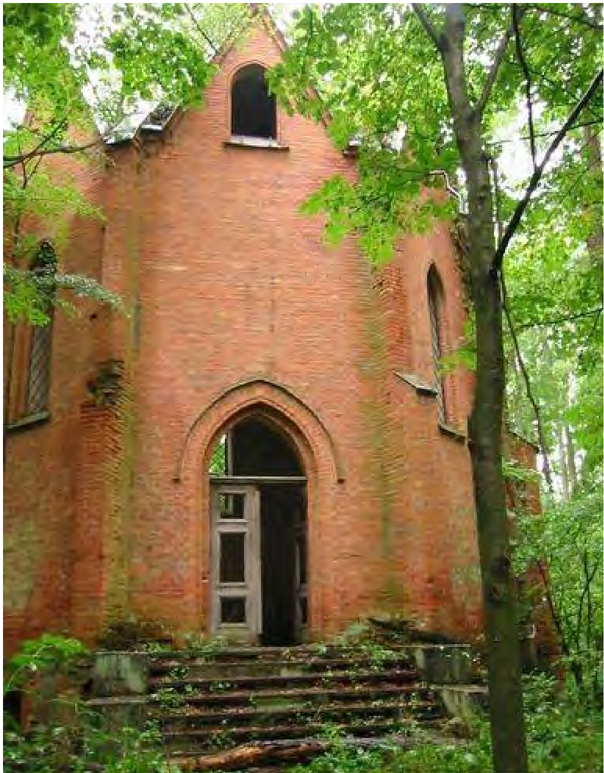
Abb. 6 Eingang der Kapelle, Bedachung vorhanden, Eingang nicht verschlossen, Türen sowie Sturz am Haupteingang erhalten.
