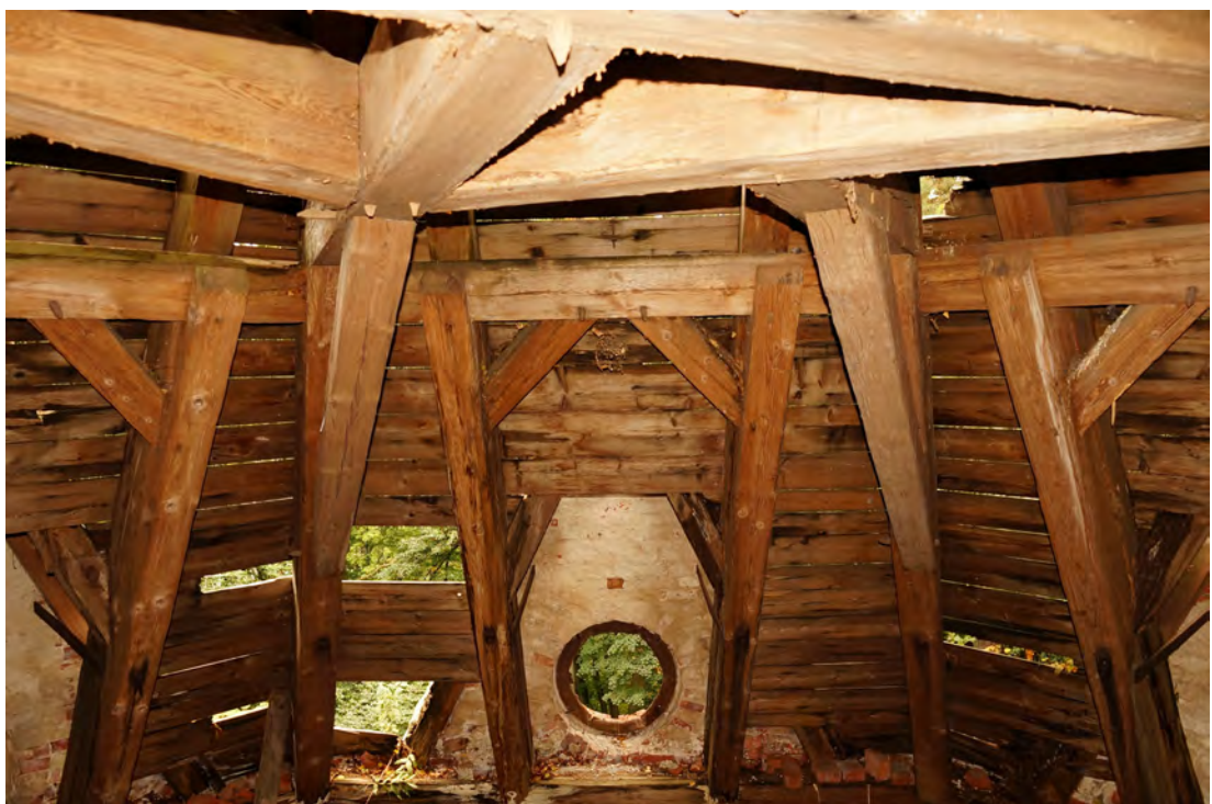
Abb. 393 Der obere Teil der Innenwandfläche F im Dachraum.
