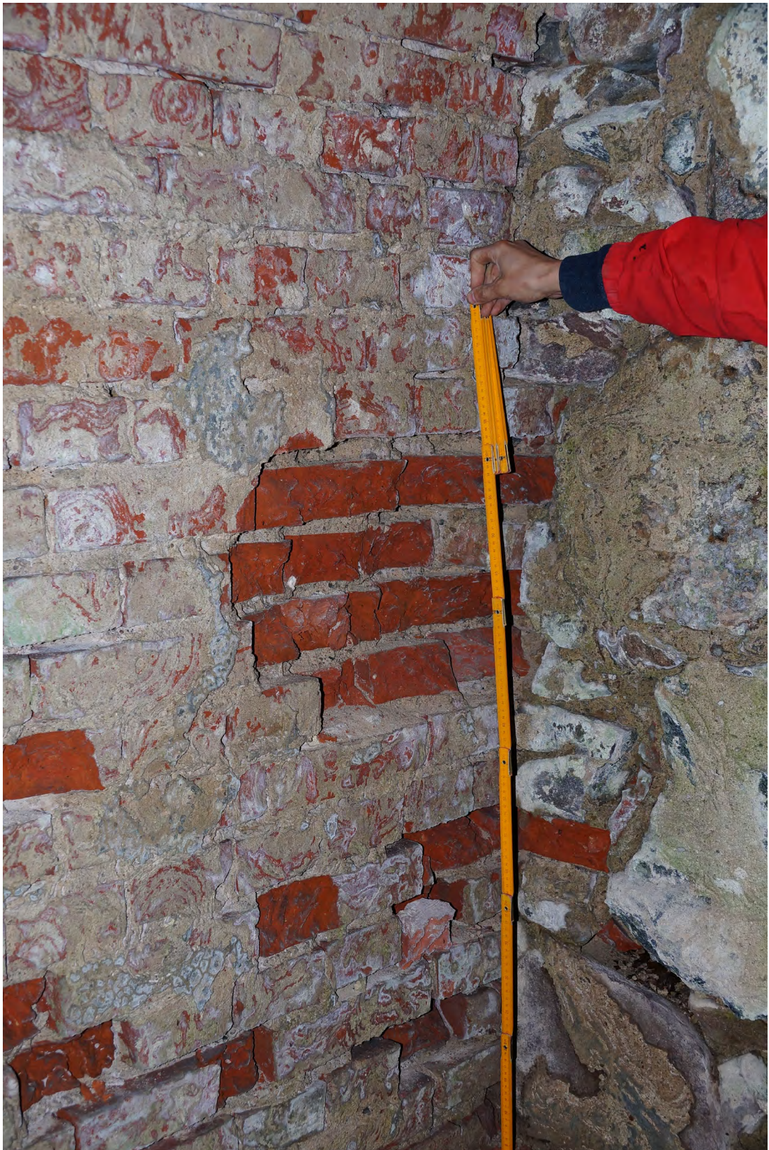
Abb. 211 Schäden am Mauerwerk im unteren Bereich der Achse 01 c.
