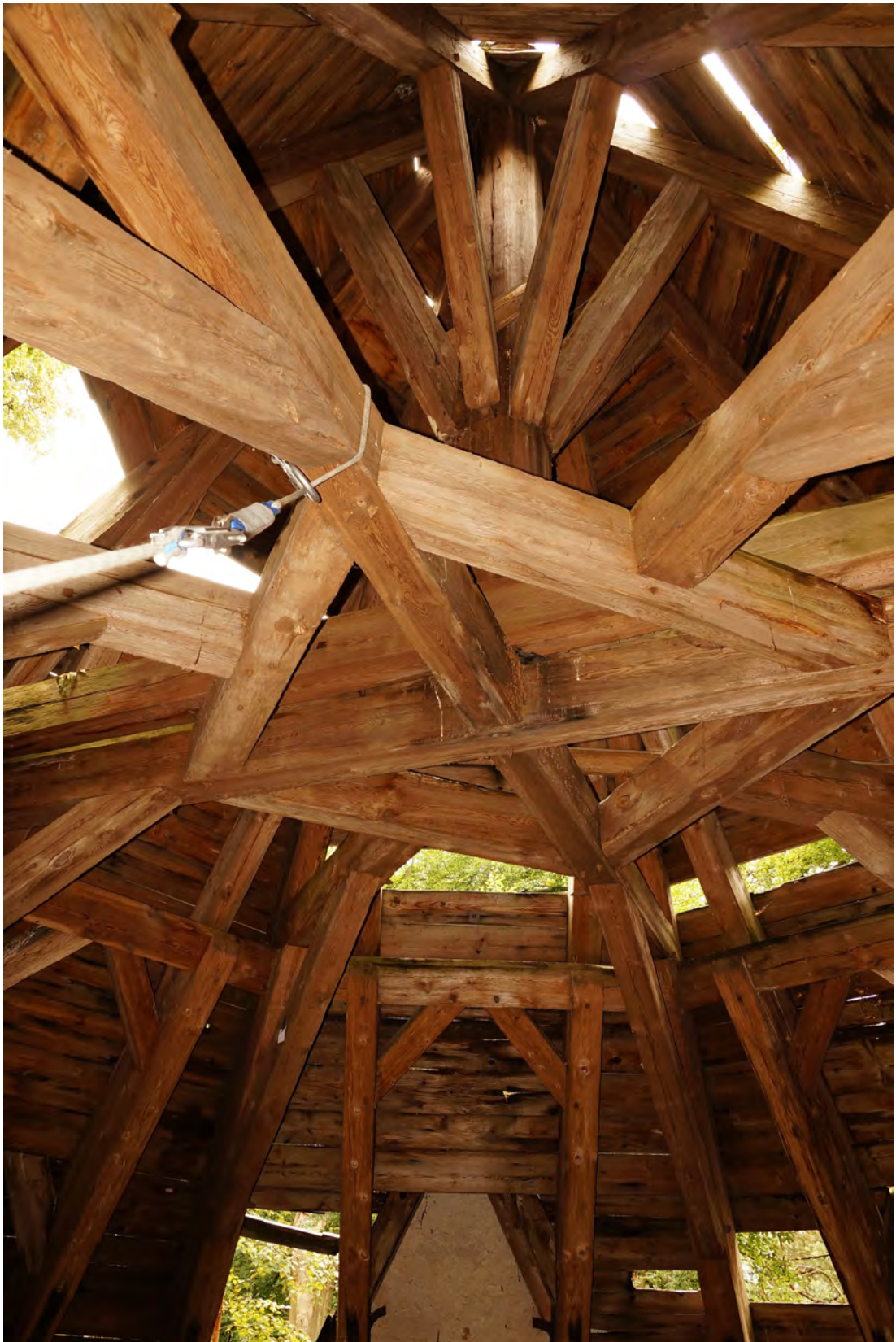
Abb. 400 Blick in das Dachgebälk.
