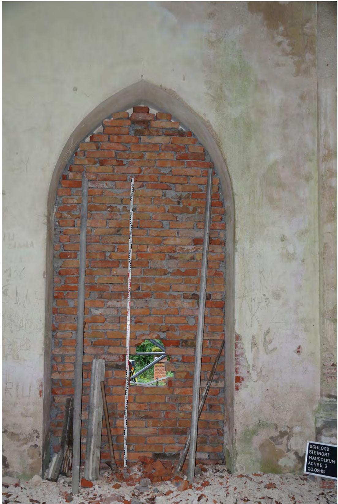
Abb. 328 Die Tür der Innenwandfläche A.
