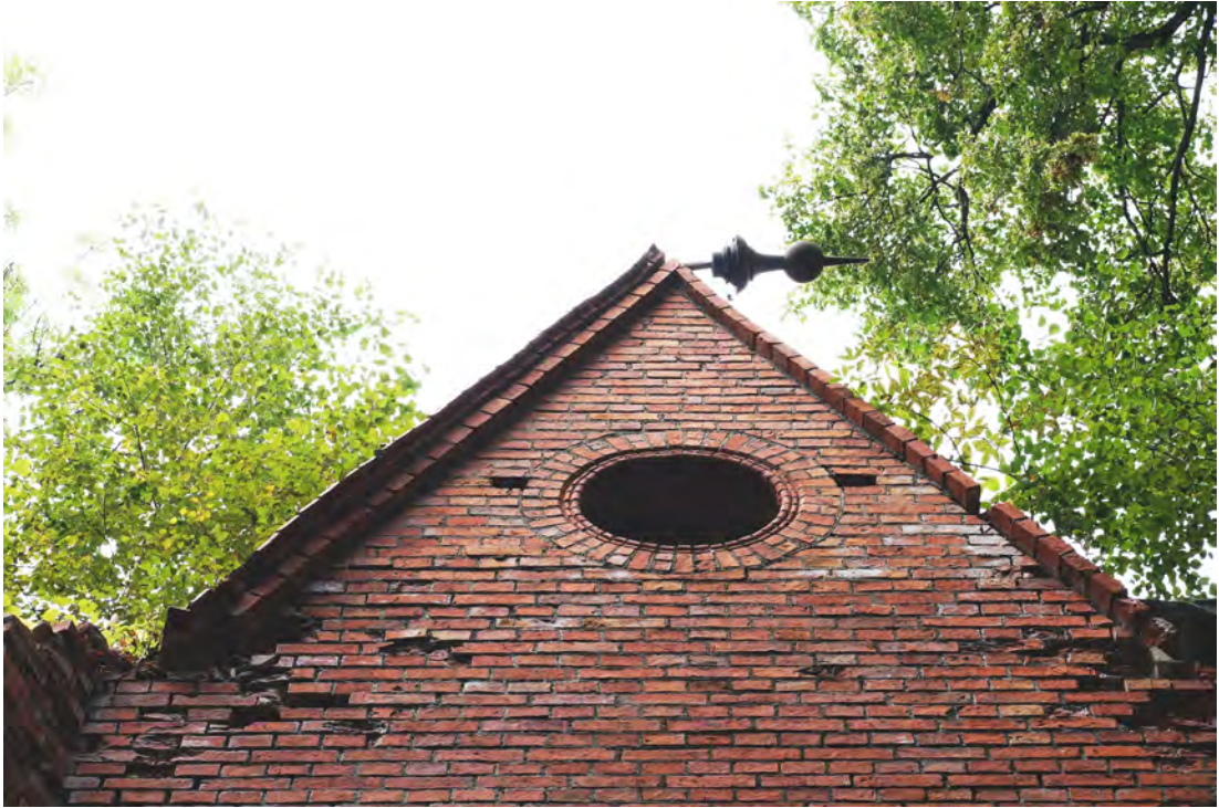
Abb. 121 Der Dachanschluss der Außenwandfläche D.
