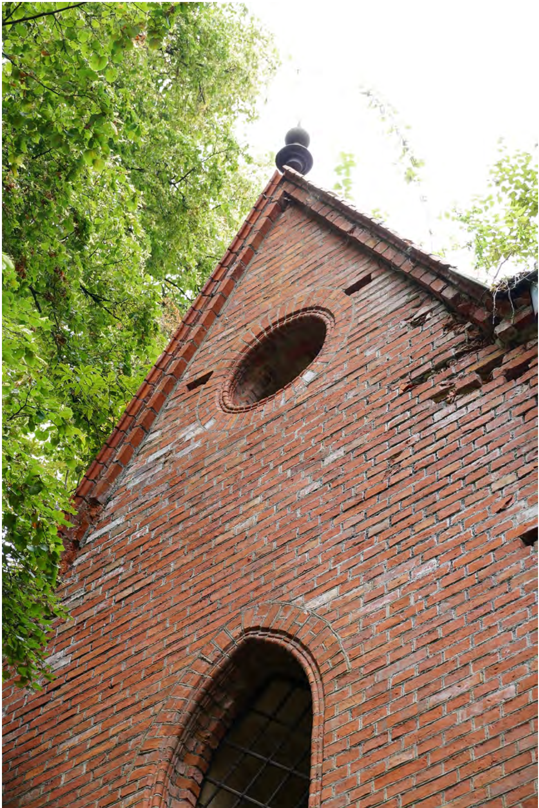
Abb. 86 Der Dachanschluss der Außenwandfläche B.
