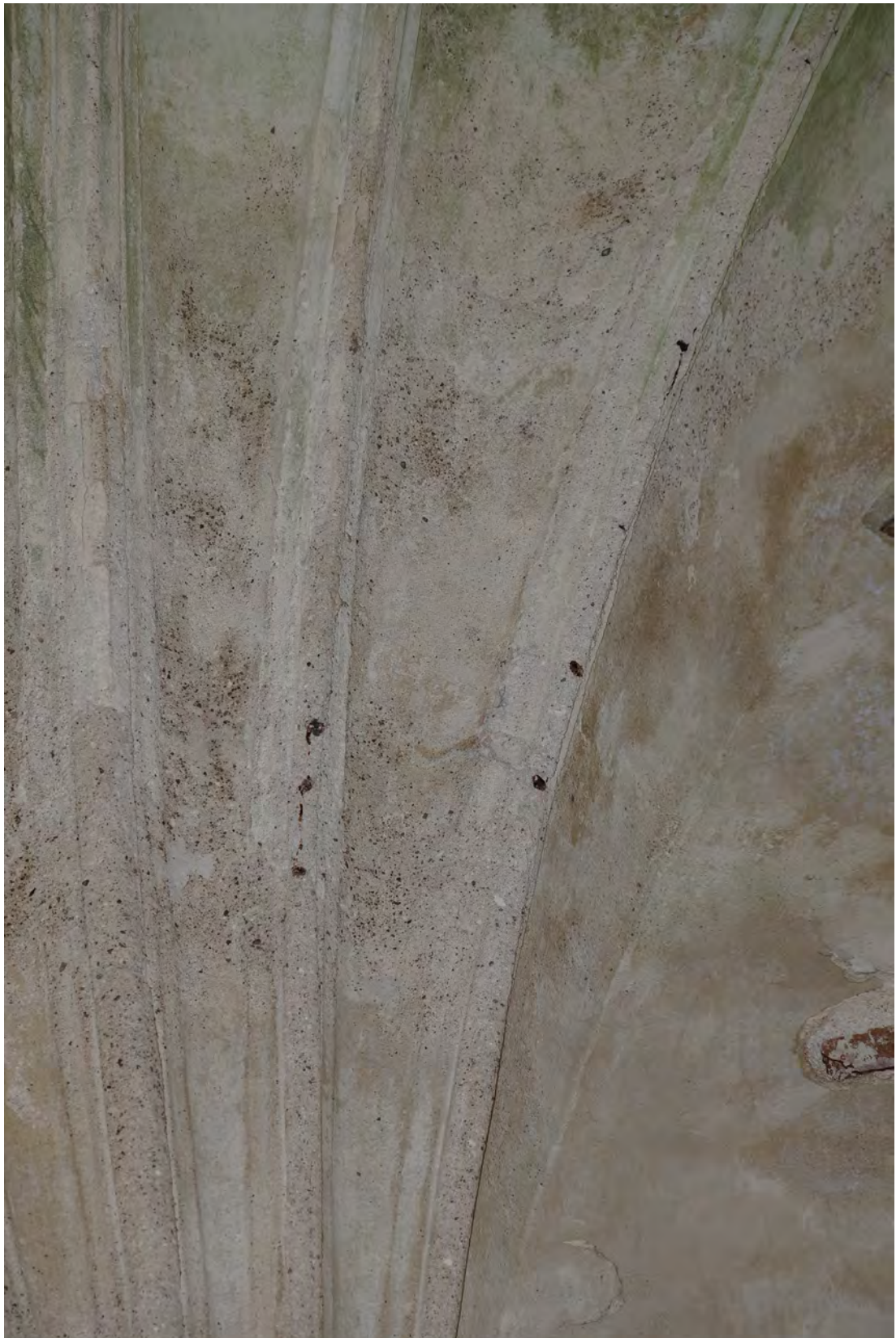
Abb. 327 Schadstellen im unteren Bereich der Gewölberippen der Achse 01.
