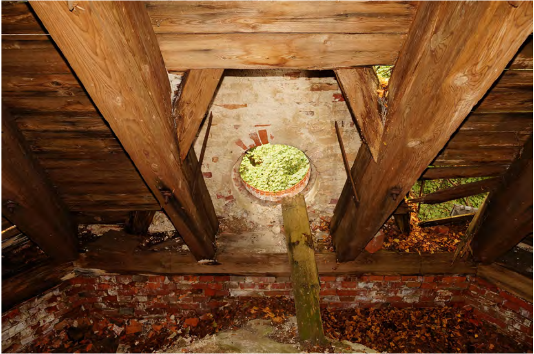
Abb. 384 Der untere Teil der Innenwandfläche B im Dachraum.
