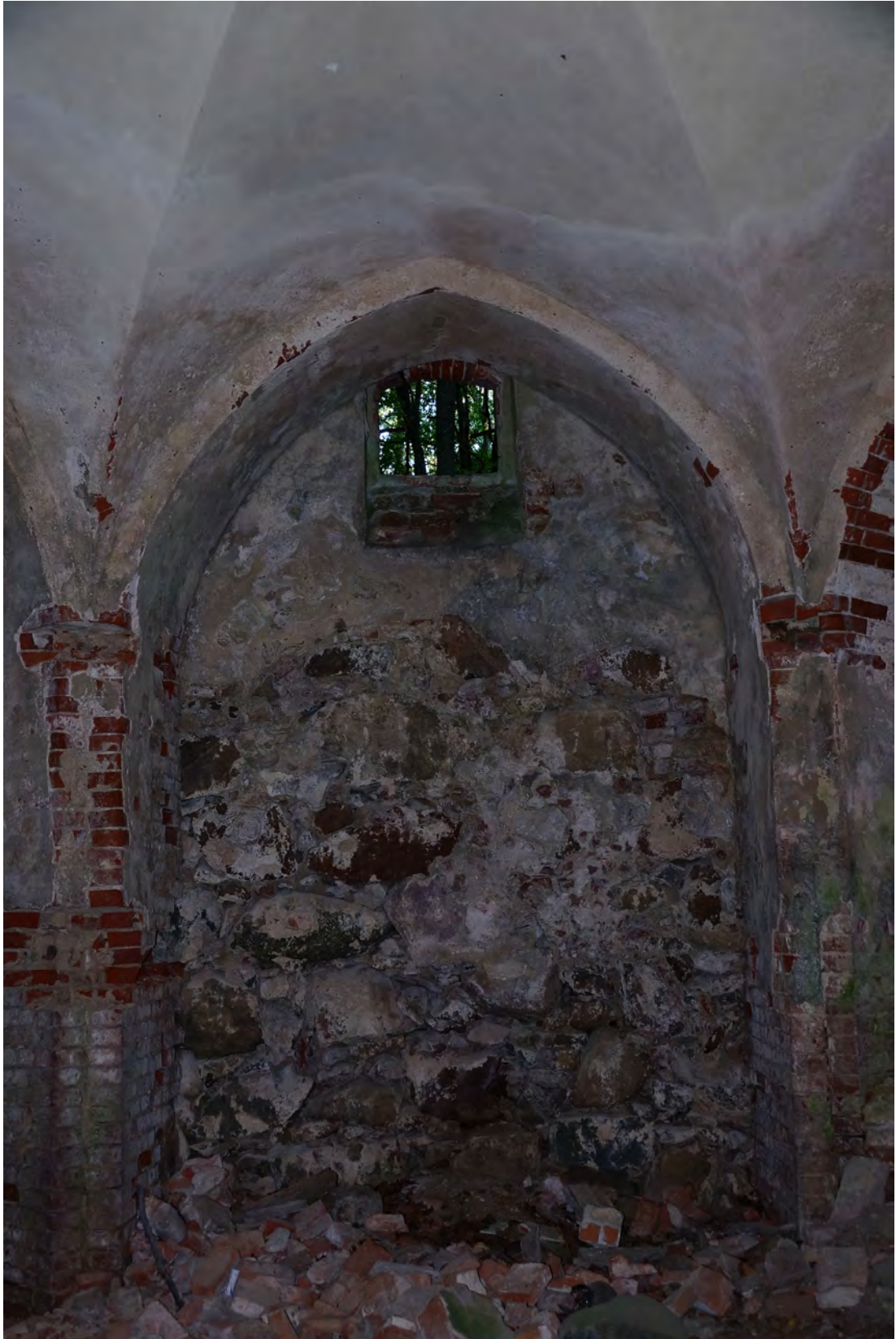
Abb. 261 Übersichtsfoto der Innenwandfläche D.
