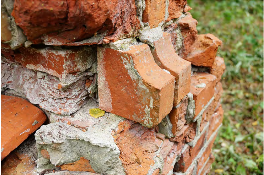
Abb. 176 Zwei Formsteine des Typs S4 in gut erhaltenem Zustand.
