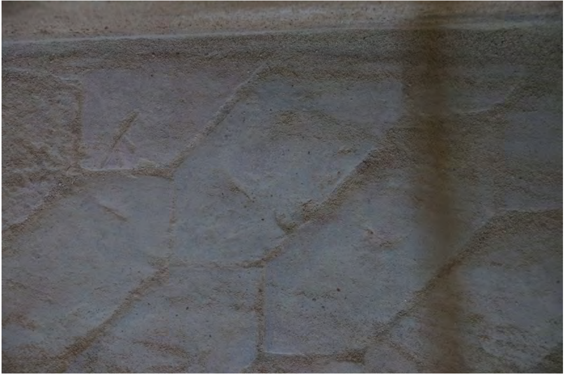
Abb. 380 Verlegemuster des Fußbodens an der Achse 04 mit den Formsteinen des Typs S5.
