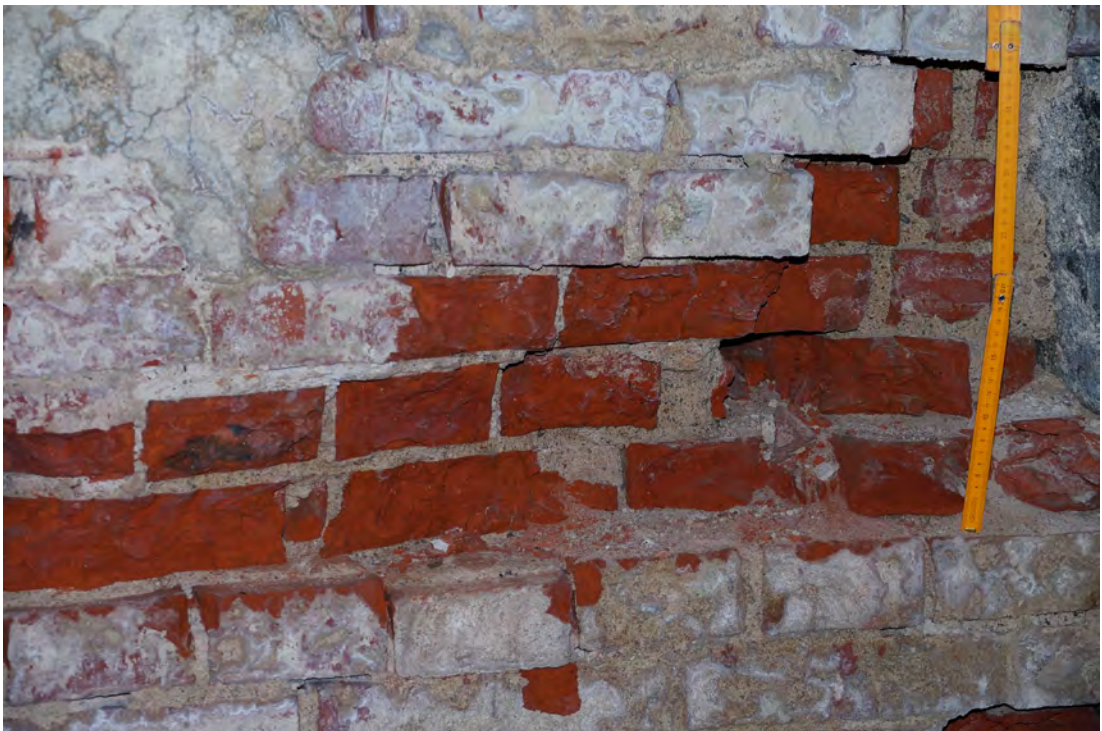
Abb. 259 Maße der Ziegel und Höhe der Schadstelle in der Mitte der Achse 04 c.
