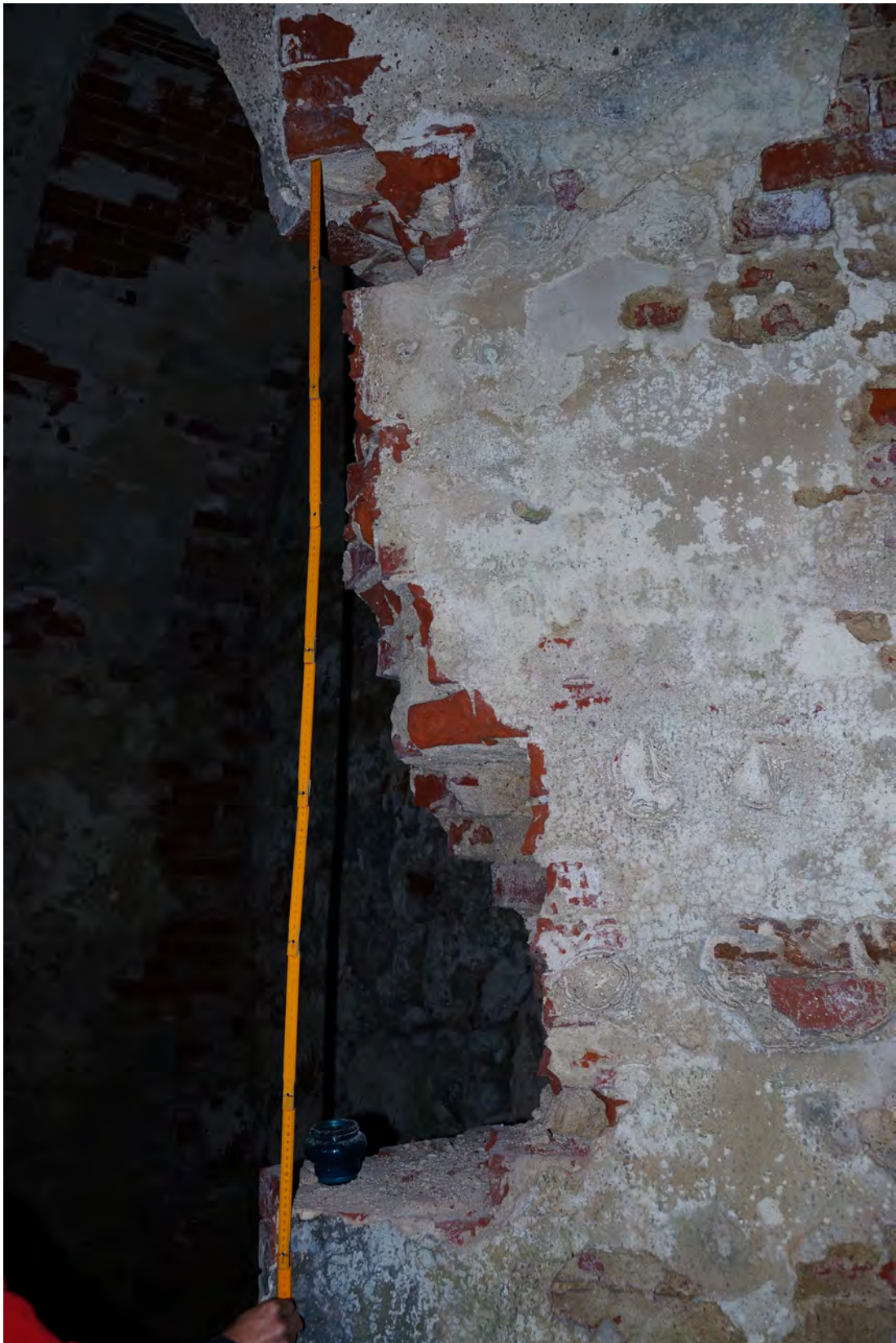
Abb. 241 Schäden im mittleren, oberen Bereich der Achse 03 c.
