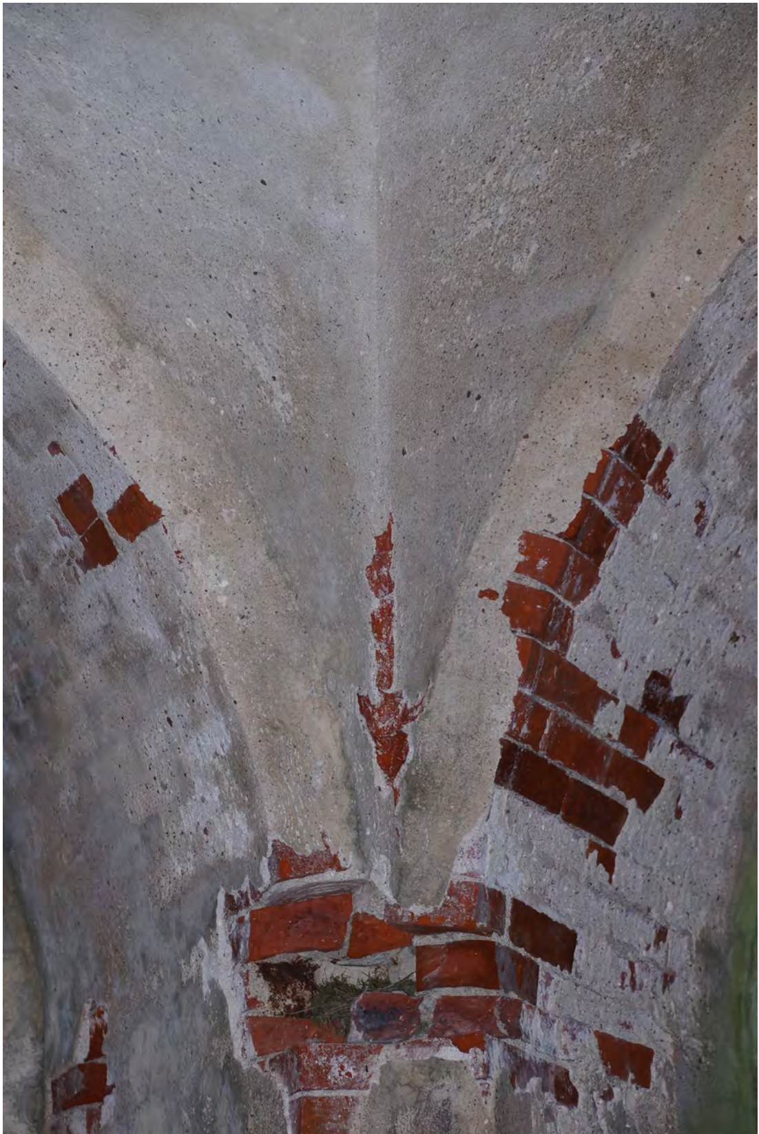
Abb. 268 Schäden am Mauerwerk des Widerlagers der Achse 05 b.
