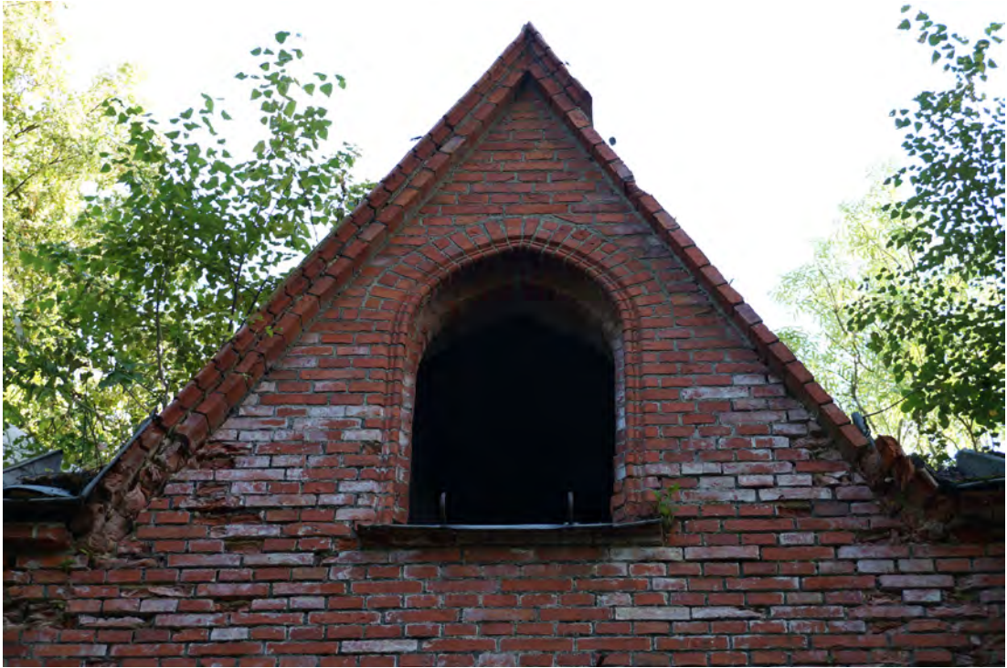
Abb. 52 Fensteröffnung und Dachanschluss der Außenwandfläche A.
