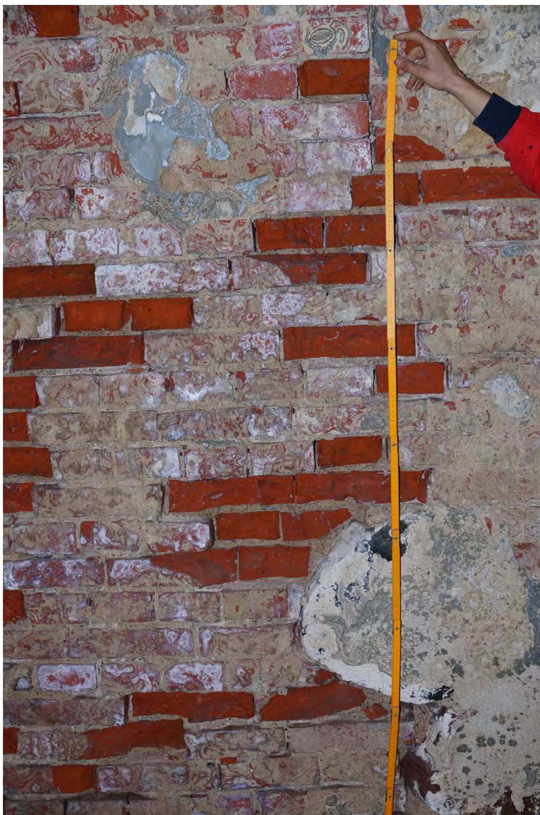
Abb. 226 Schäden am Mauerwerk im vorderen, unteren Bereich der Achse 02 a.
