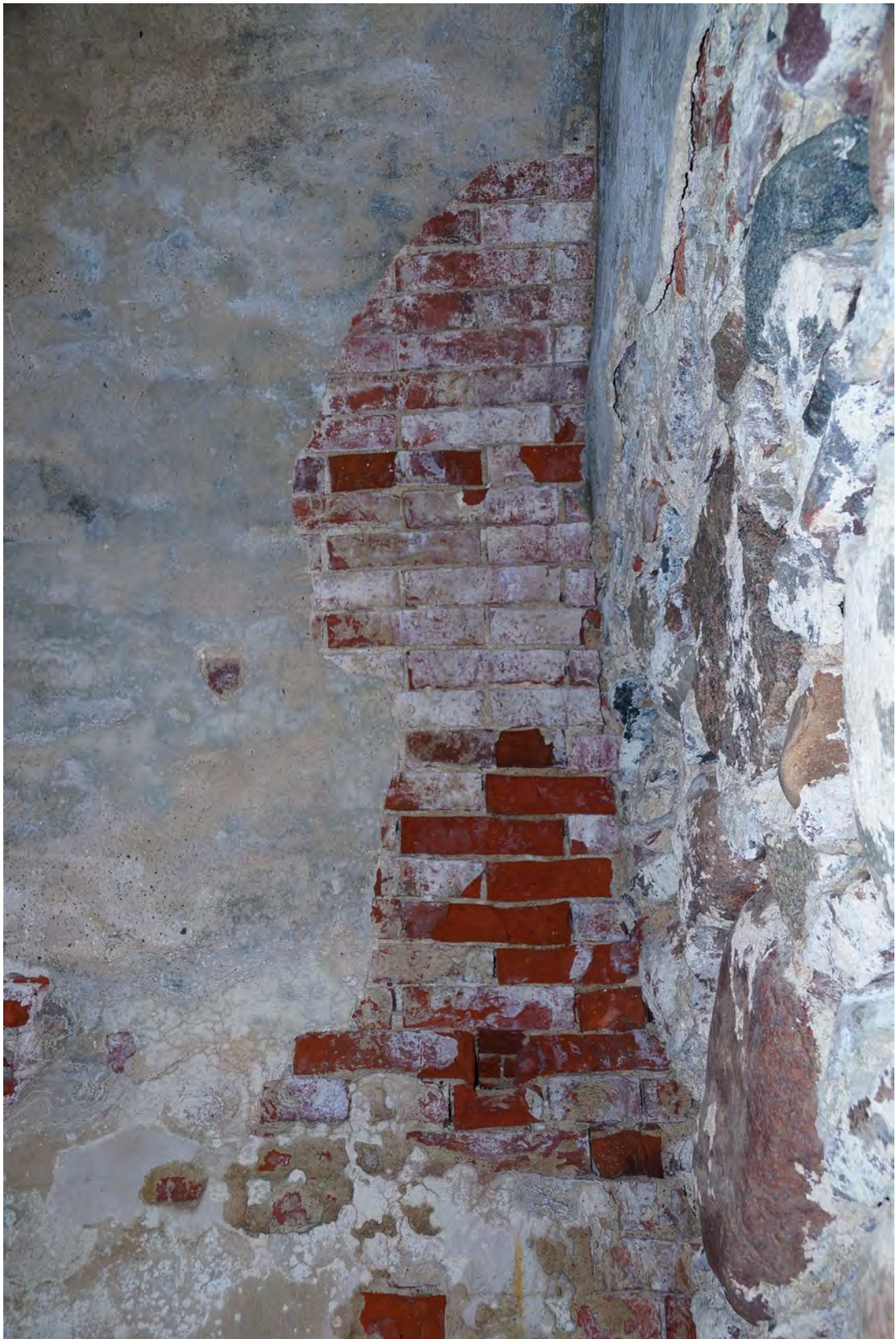
Abb. 244 Schäden am Mauerwerk im hinteren, oberen Bereich der Achse 03 c.
