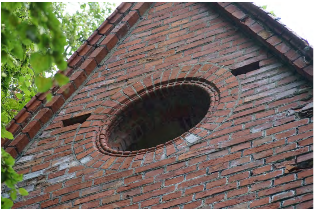
Abb. 85 Das Dachfenster der Außenwandfläche B.
