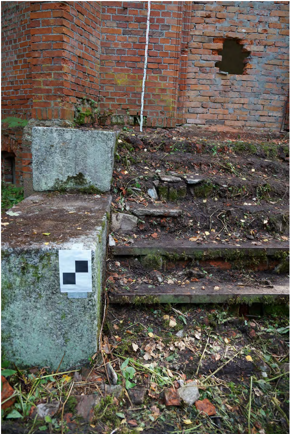
Abb. 58 Anschluss der Treppe der Seite A an die linke Seitenwange.
