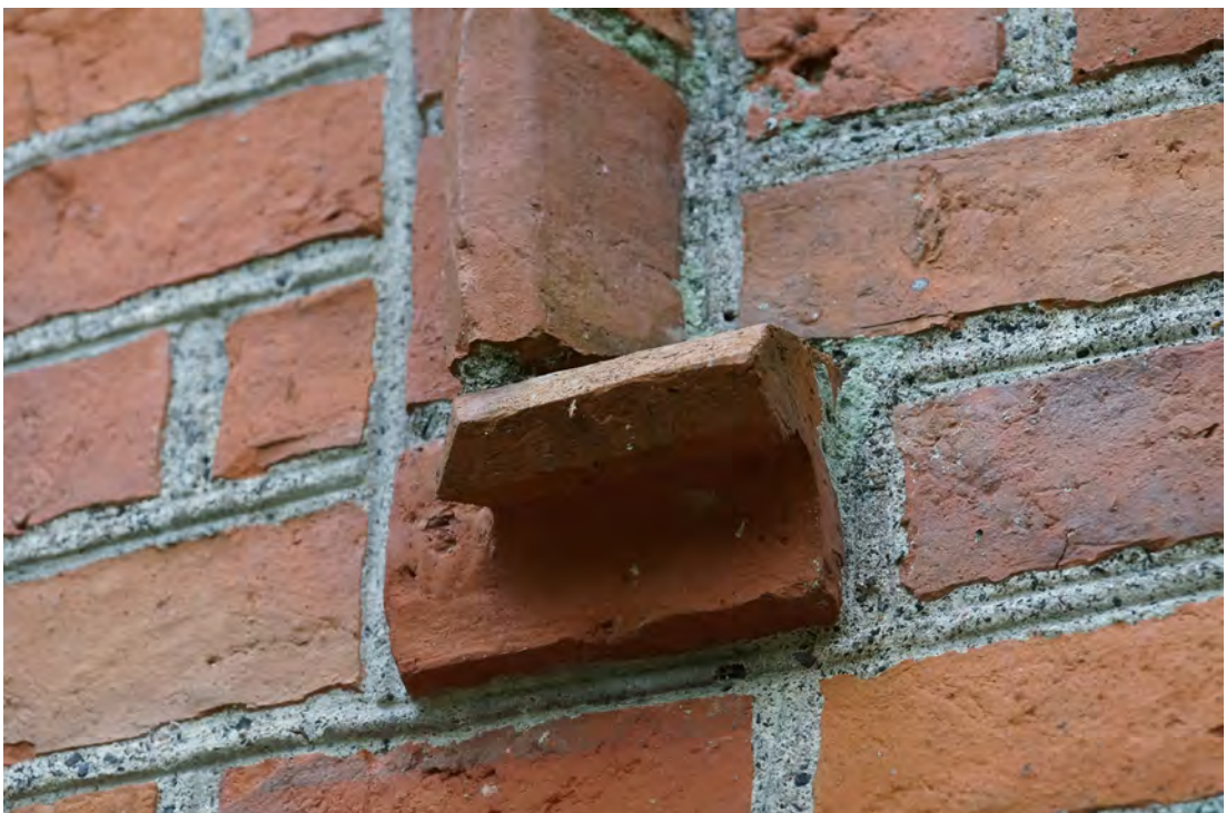
Abb. 44 Der untere Abschluss des Bogens oberhalb der Türöffnung.
