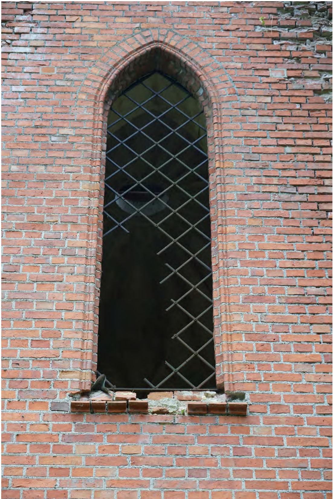
Abb. 202 Das große Fenster in der Mitte der Außenwandfläche H.
