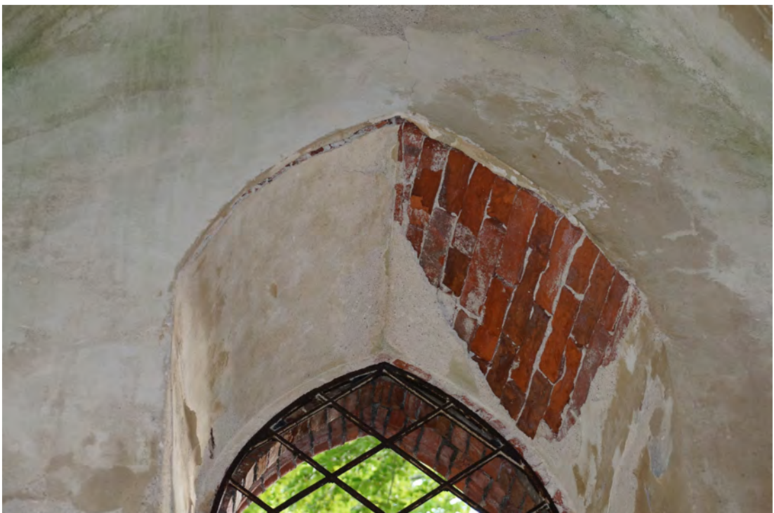
Abb. 356 Die Schäden am Spitzbogen des Fensters der Innenwandfläche E.
