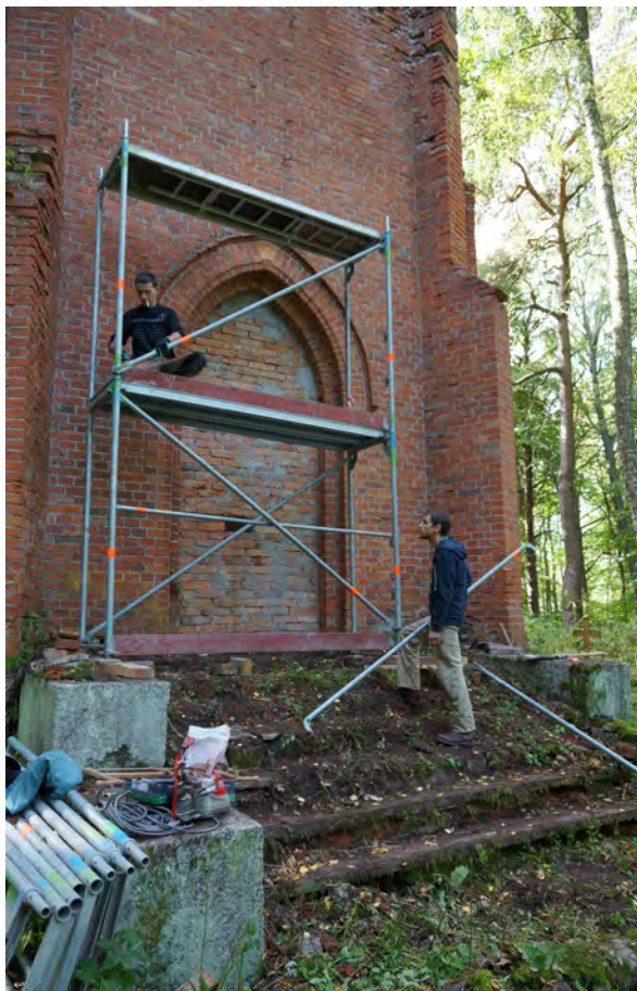
Abb. 19 Stellen des Gerüsts.
