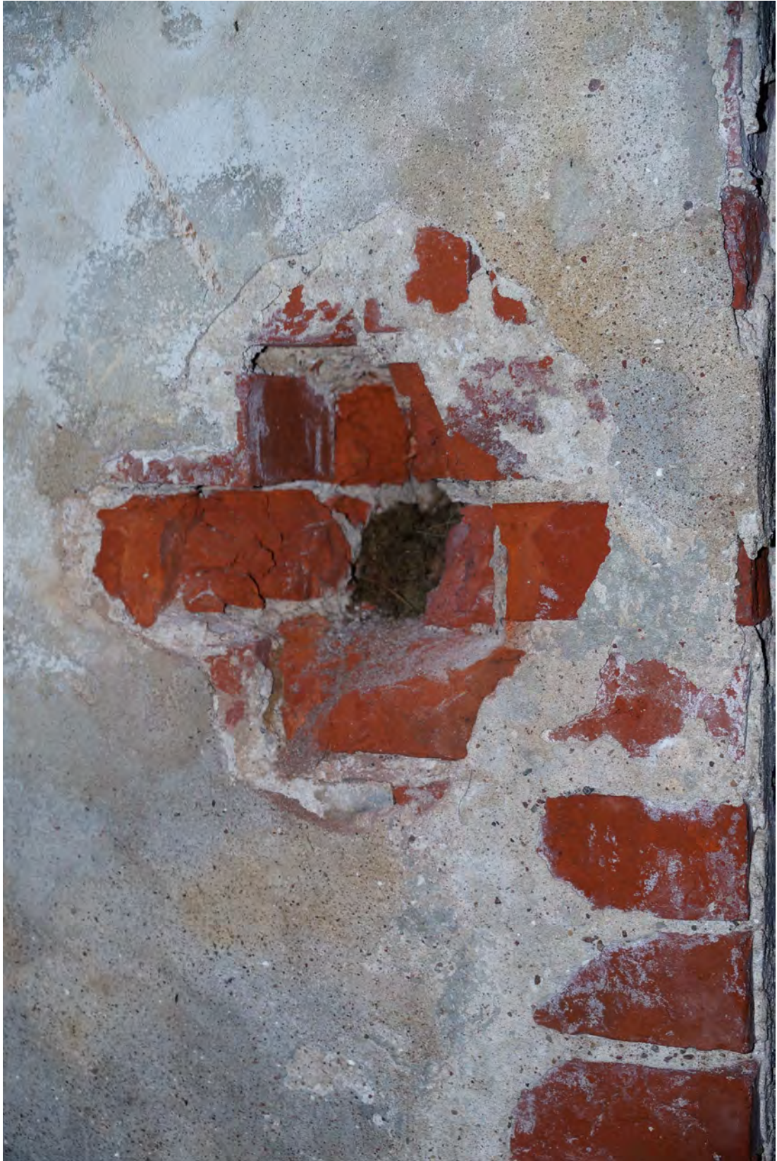
Abb. 299 Das durchgängige Loch im vorderen, mittleren Bereich der Achse 07 a.
