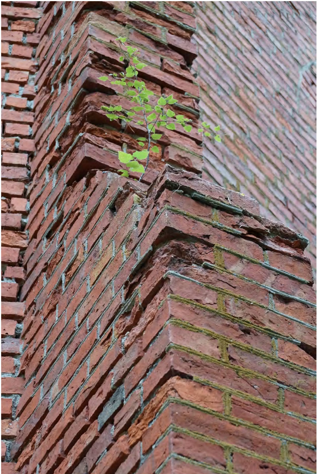
Abb. 159 Der Mauerwerksvorsprung der Achse 06 b/c.
