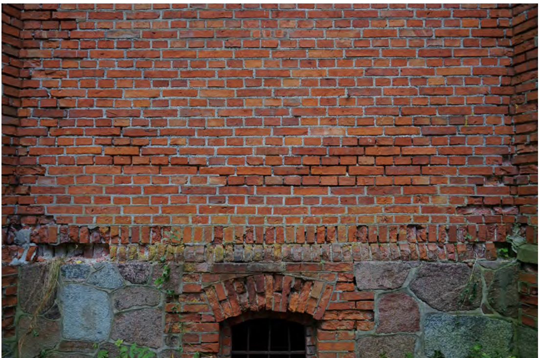
Abb. 164 Der Sockelbereich und die Fugenauswaschungen darüber.
