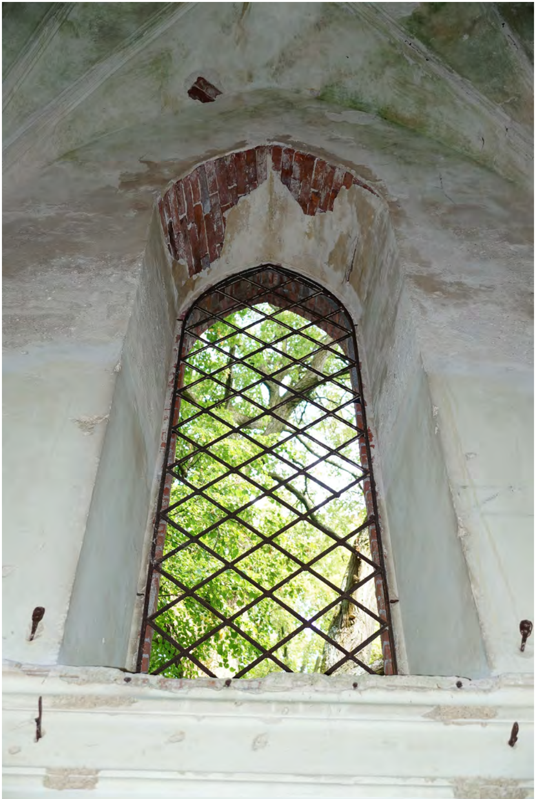
Abb. 340 Das Fenster der Innenwandfläche C.
