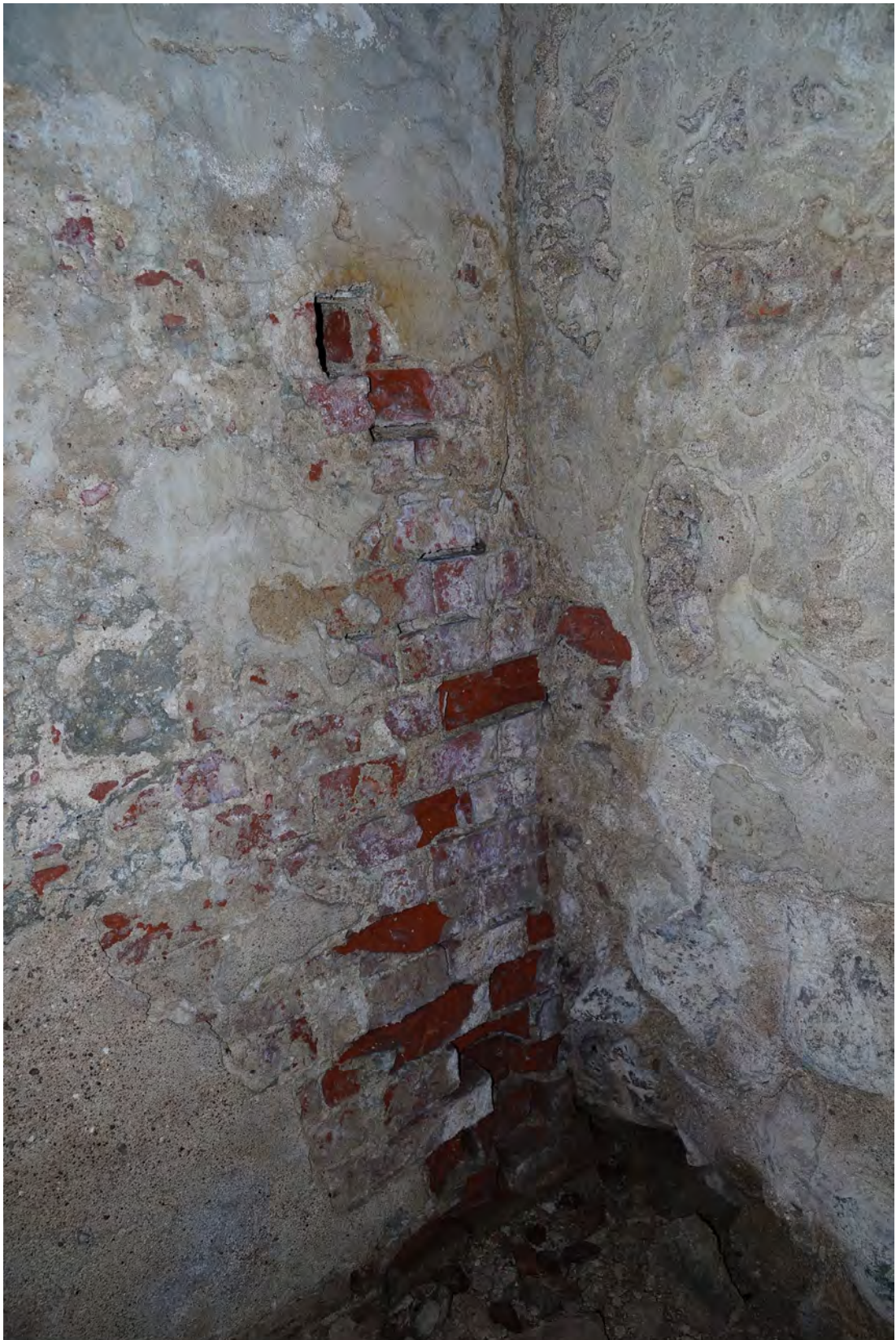
Abb. 285 Schäden am unteren, hinteren Mauerwerk der Achse 06 c.
