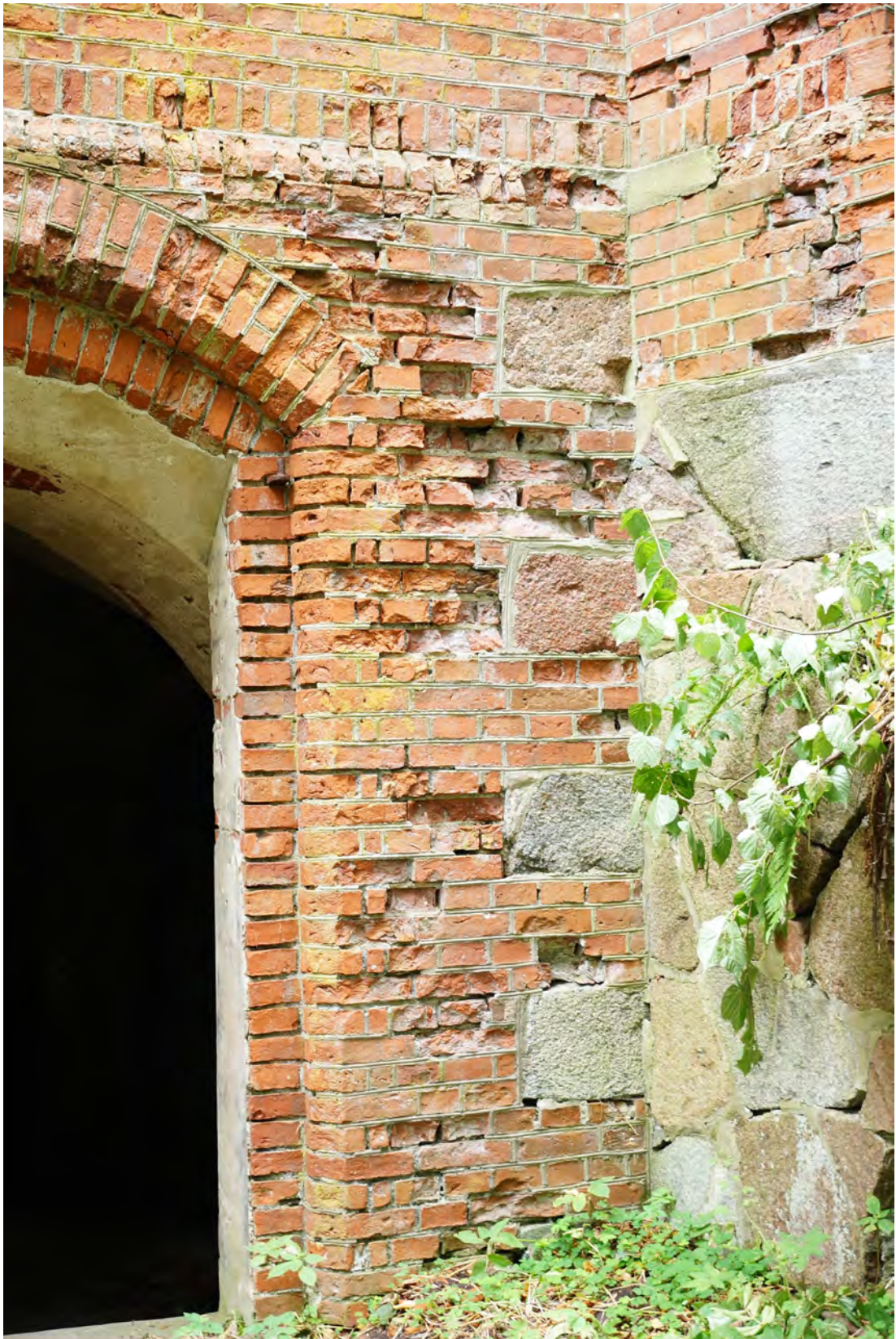
Abb. 140 Bereich rechts neben der Tür in der Außenwandfläche E.
