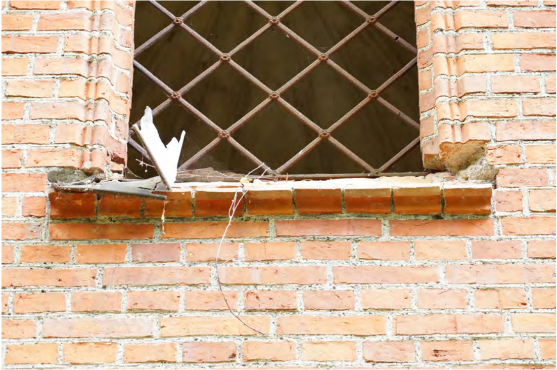
Abb. 186 Das Fensterbrett des großen Fensters in der Mitte der Außenwandfläche G.
