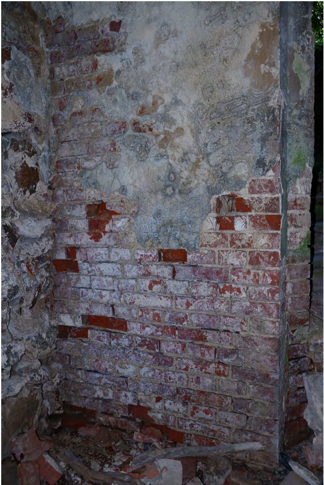
Abb. 266 Schäden am unteren Mauerwerk der Achse 05 a.
