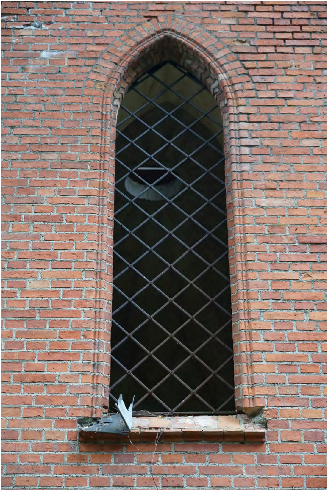
Abb. 185 Das große Fenster in der Mitte der Außenwandfläche G.
