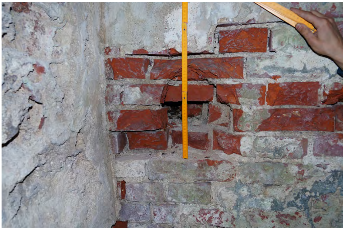
Abb. 318 Die Höhe des Loches im hinteren, mittleren Bereich der Achse 08 a.
