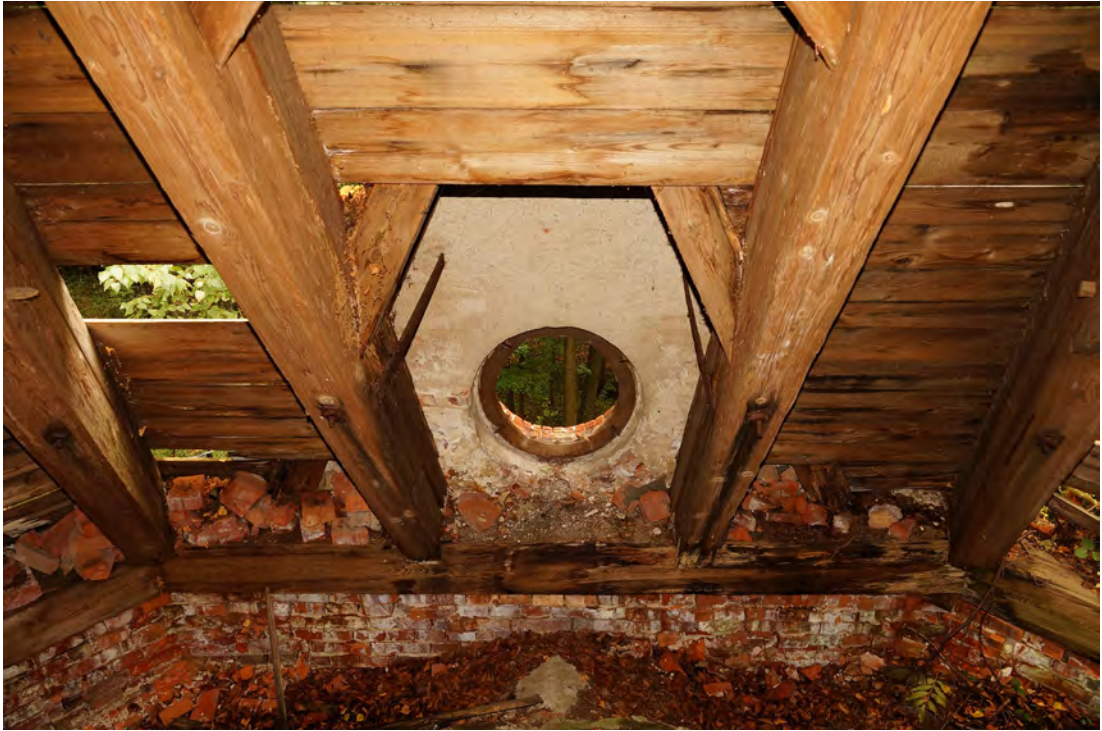
Abb. 388 Der untere Teil der Innenwandfläche D im Dachraum.
