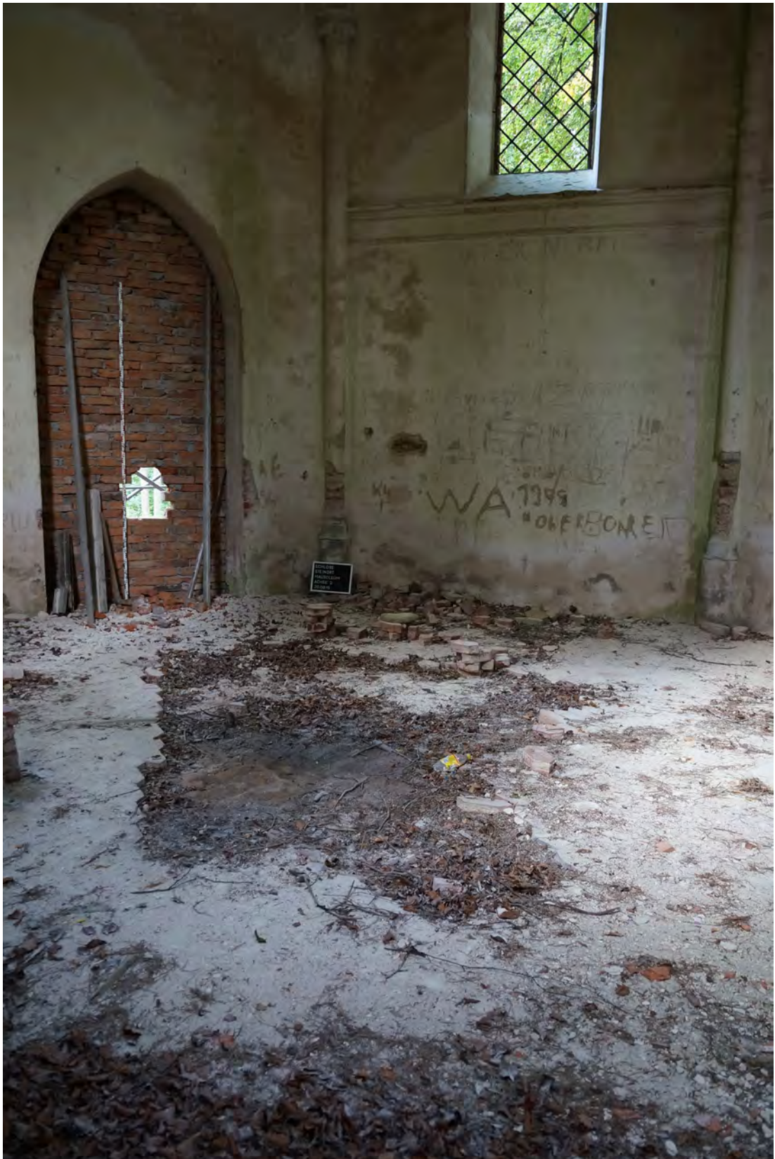
Abb. 377 Übersichtsfoto des derzeitigen Zustandes des Fußbodens.
