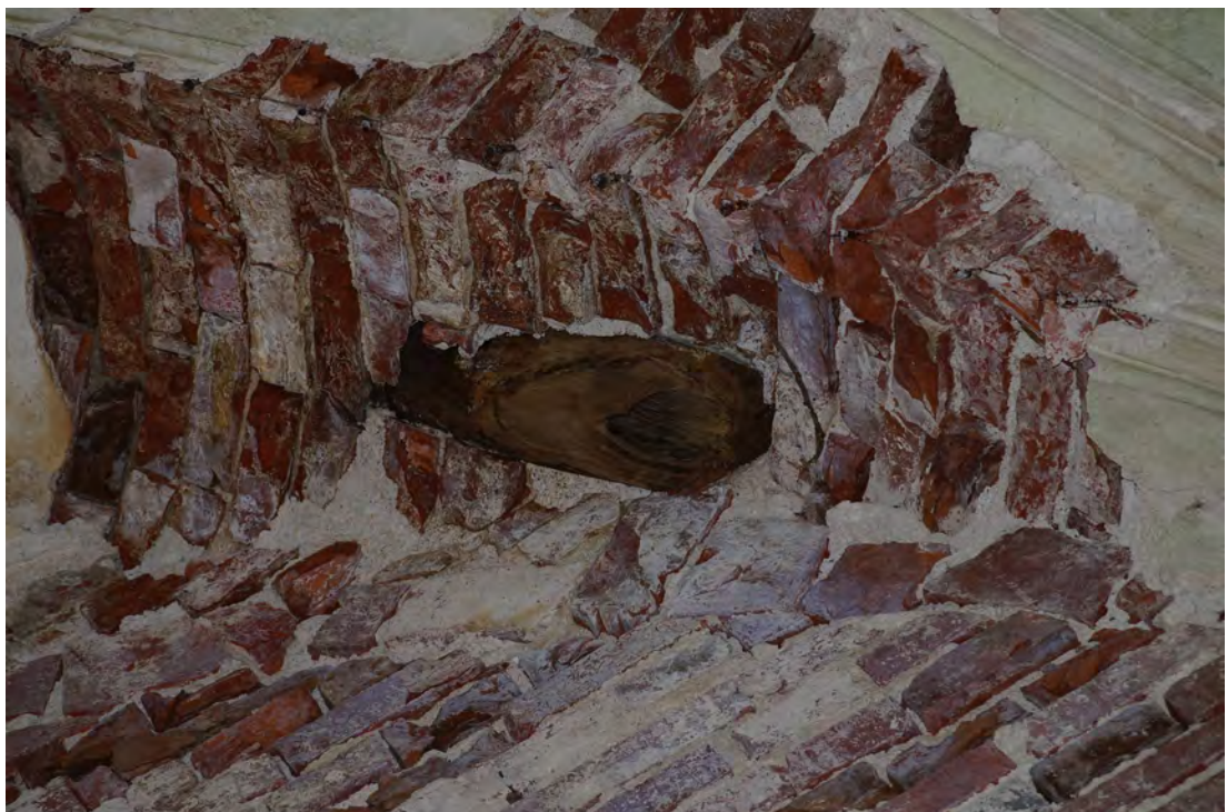
Abb. 330 Das Holzbauteil in der Schadstelle der Innenwandfläche A.
