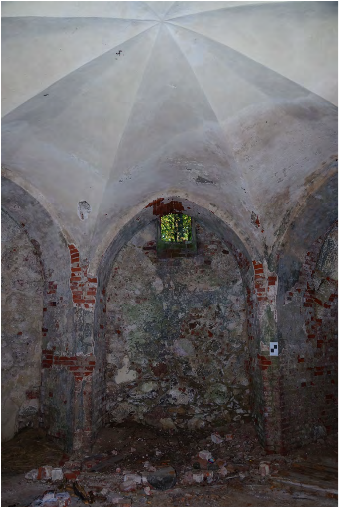
Abb. 319 Übersichtsfoto der Innenwandfläche H mit Gewölbe.
