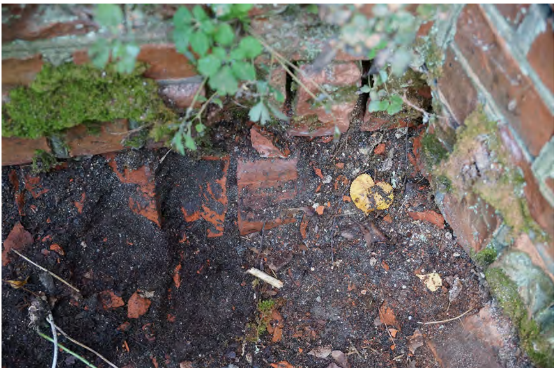
Abb. 49 Sockelbereich der Außenwandfläche A (rechts neben der Türöffnung).
