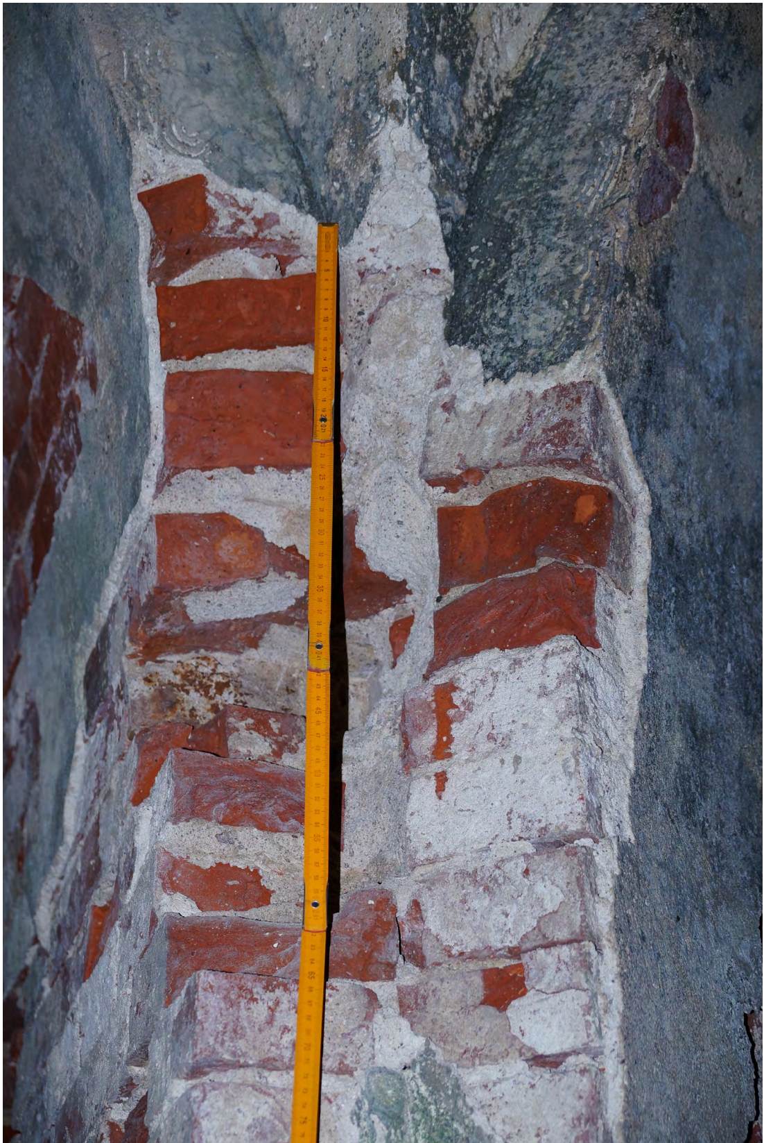
Abb. 213 Schäden am Mauerwerk des Widerlagers der Achse 01 b.
