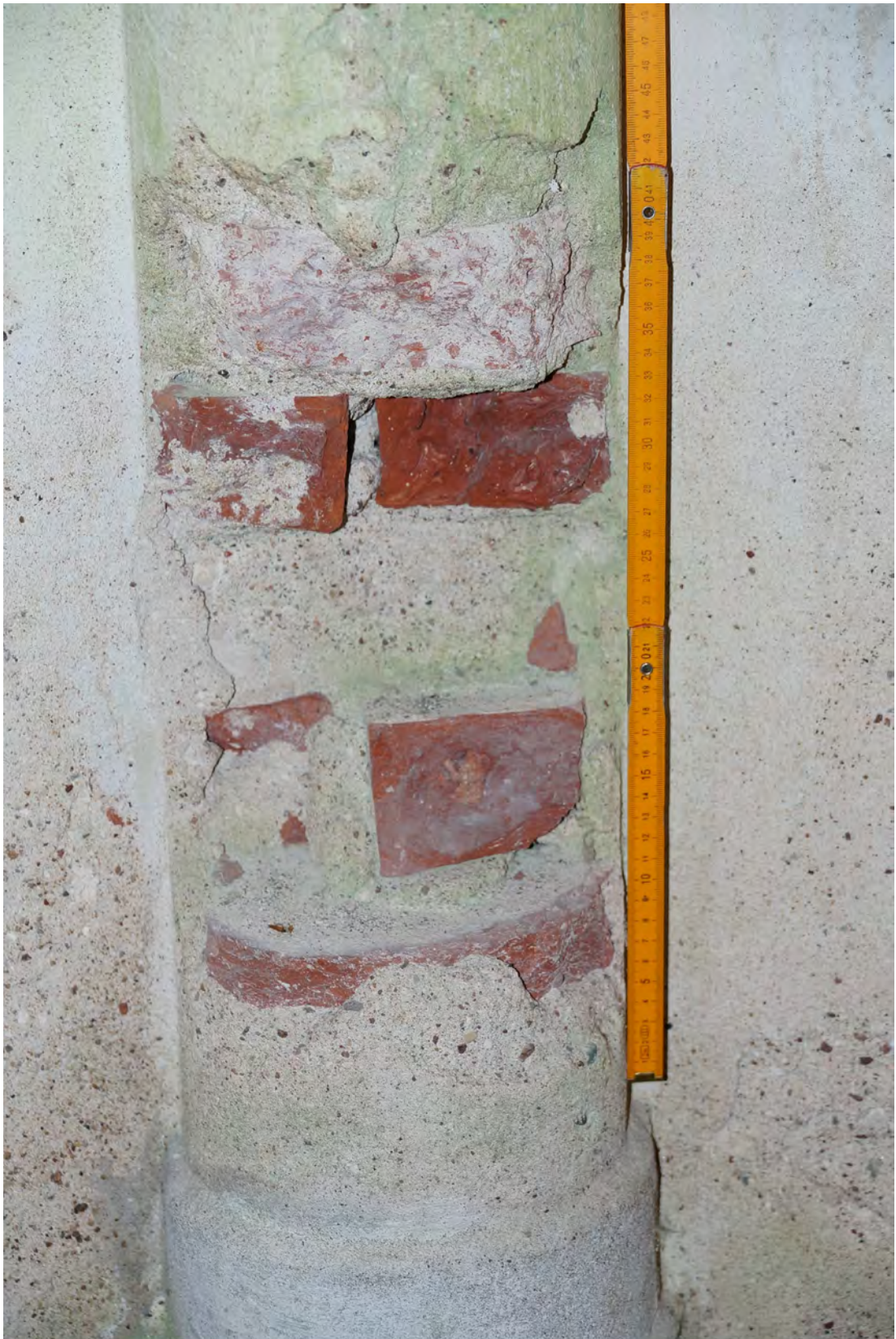
Abb. 351 Schäden im unteren Bereich des Pilasters der Achse 05.
