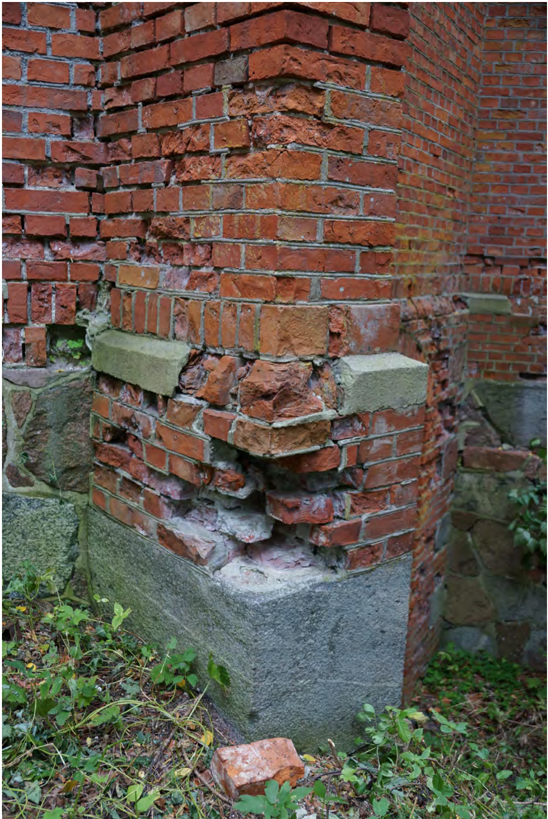
Abb. 155 Der Sockelbereich der Achse 06 b/c.
