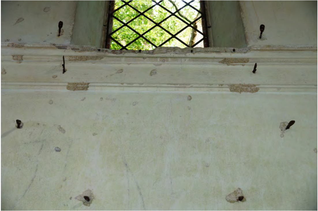
Abb. 341 Das Fensterbrett des Fensters der Innenwandfläche C und die Bauteile aus Metall darunter.
