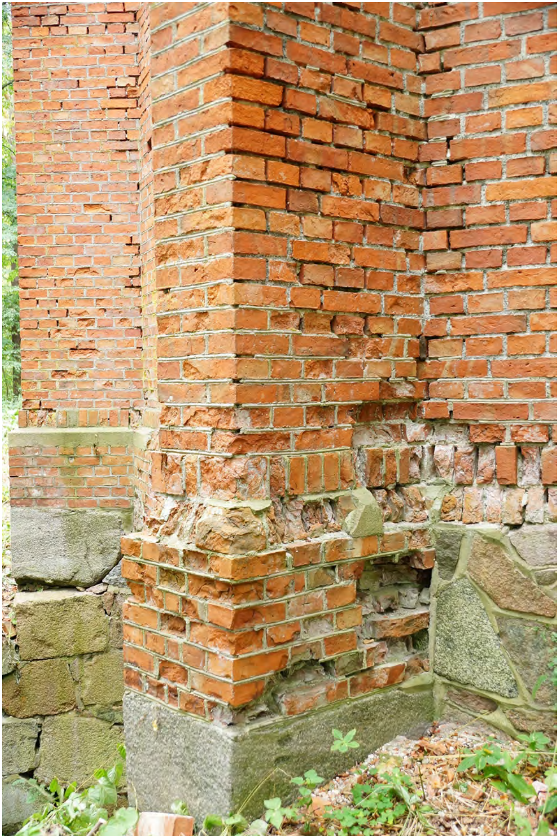
Abb. 125 Der Sockelbereich der Achse 05 a.
