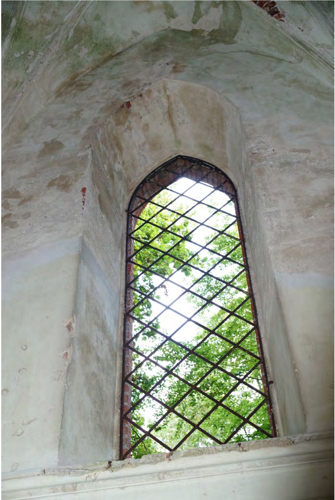
Abb. 347 Das Fenster der Innenwandfläche D.
