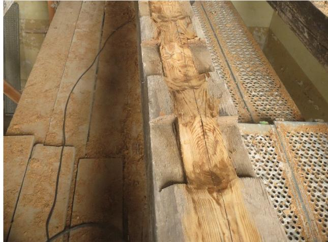
Abbildung 13 Modellversuch für das Vorbereiten der Balkenoberfläche zum Verleimen, Foto: W. Jäger
