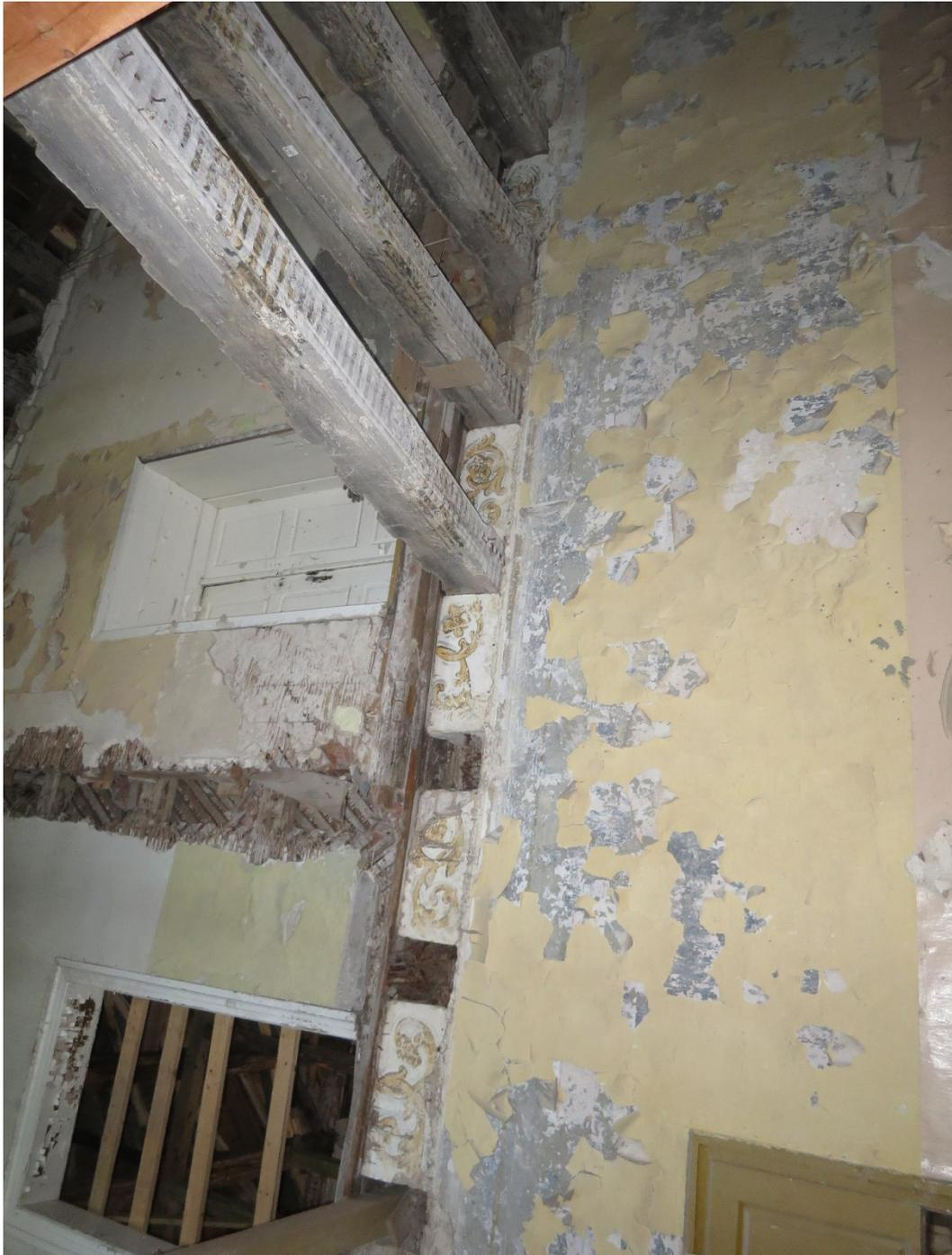
Abbildung 32 Raum 0.09, Zustand Deckenbalken, Foto: W.Jäger, Aufnahme gedreht
