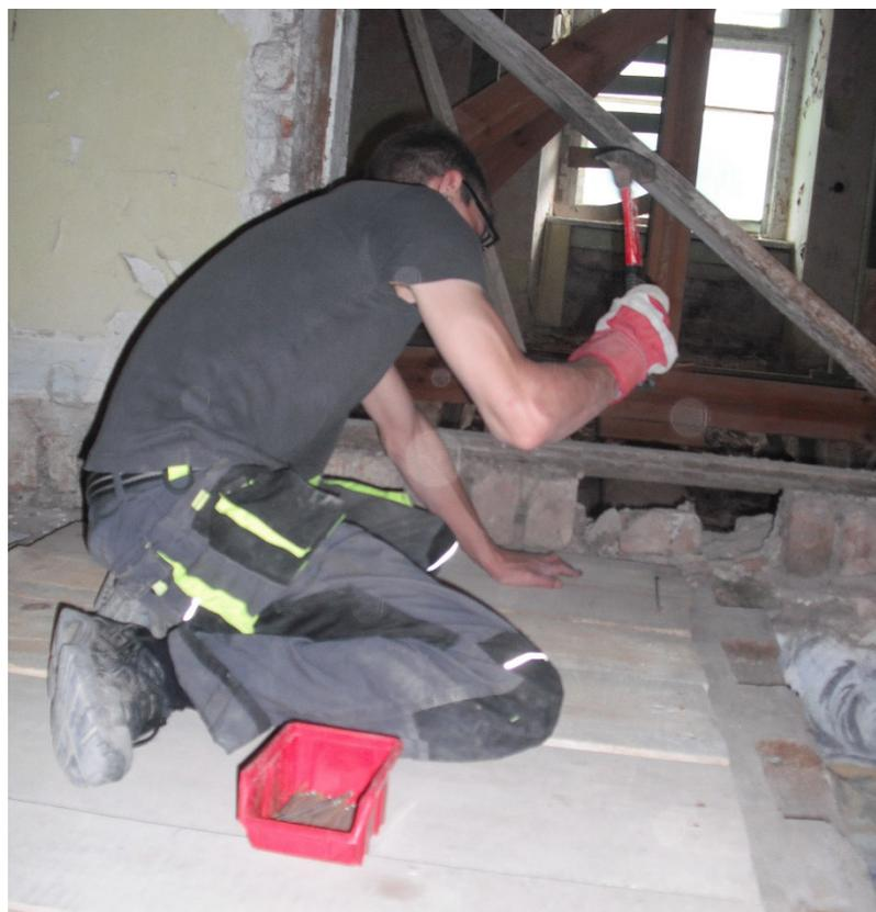
Abbildung 78 Aufbringen des zuvor entfernten Laufstegs, Foto: Lina Merck
