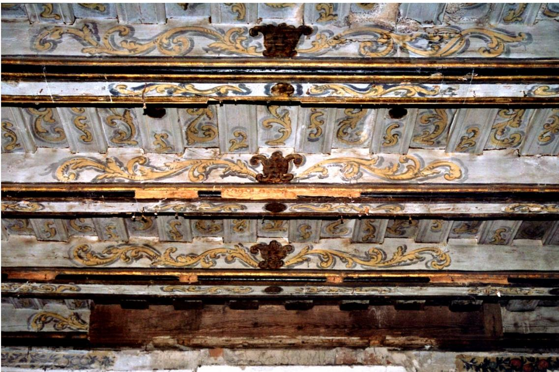
Abbildung 90 Unterischt der Holzbalkendecke vor Ausbau der Deckenbretter,
