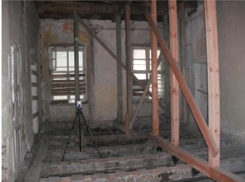
Abbildung 79 Positionierung des Scanners oberhalb der Balken, Foto: Kay-M. Müller
